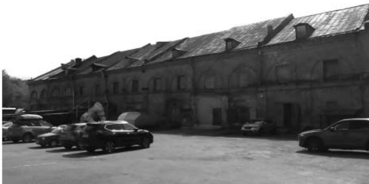
Фото 8. Дворовый фасад восточного корпуса. В настоящее время выполнены демонтажные работы гаражей и наклонных входов – навесов в подвальные помещения, в соответствии с согласованной документацией.
