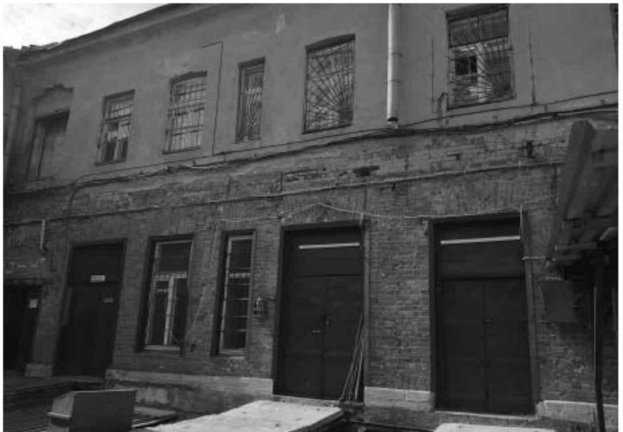
Фото 14. Фрагмент дворового фасада западного корпуса. После демонтажа поздних платформ раскрыт исторический покров из известняка.
