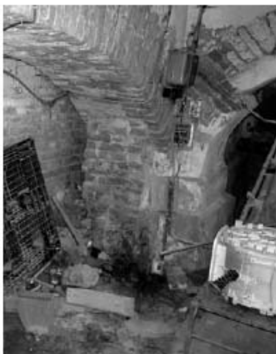
Фото 17. Подвальное помещение 20-Н (6) восточного корпуса. Кирпичные крестовые своды.
