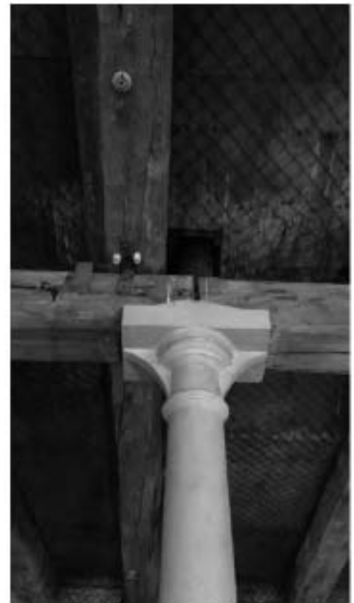
Фото 22. Помещение 34-Н (4) западного корпуса. Металлическая историческая колонна.
