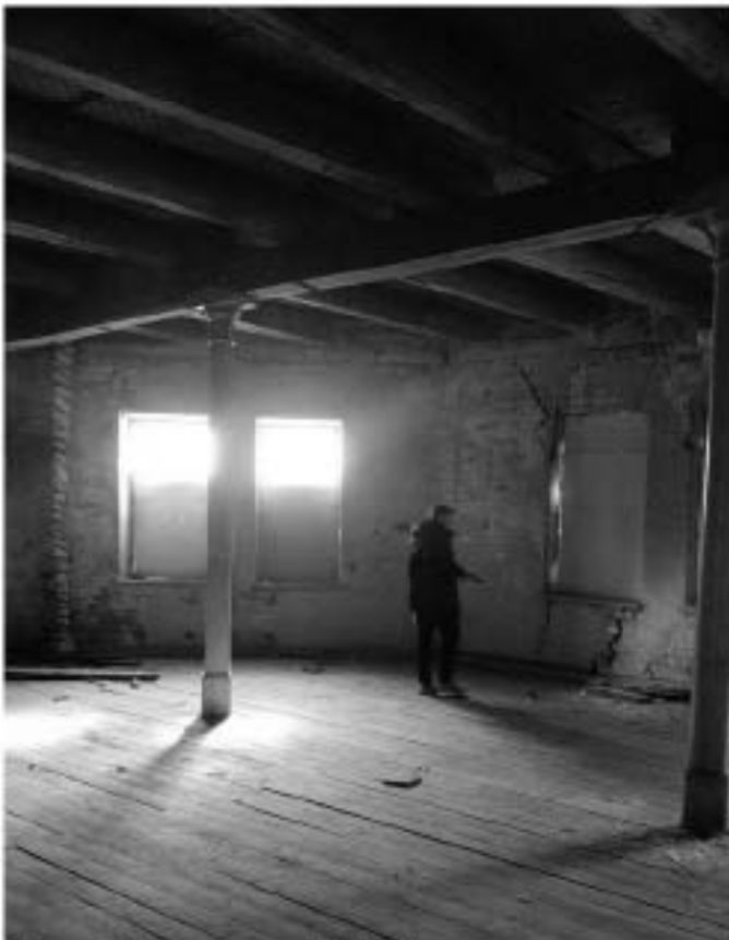
Фото 21. Помещение 34-Н (4) западного корпуса. Металлические исторические колонны.
