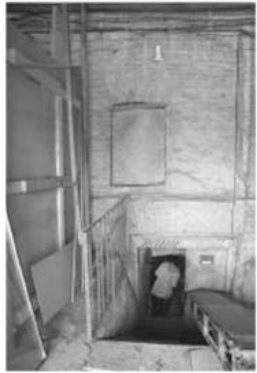
Фото 20. Междуэтажное перекрытие 2-го этажа западного корпуса.
