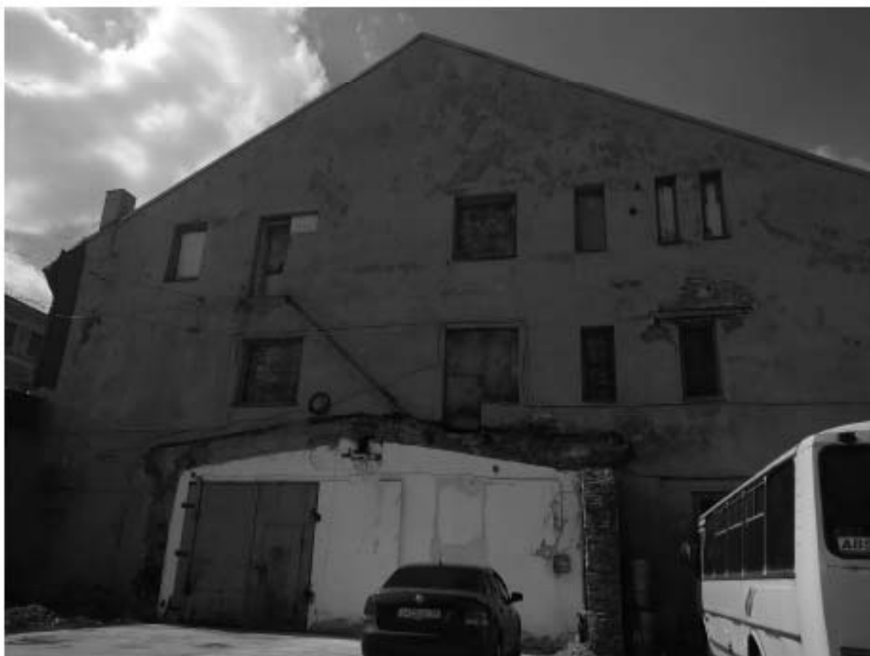
Фото 10. Торцевой фасад восточного корпуса. Поздняя пристройка в уровне 1-го этажа демонтирована в соответствии с согласованной документацией.
