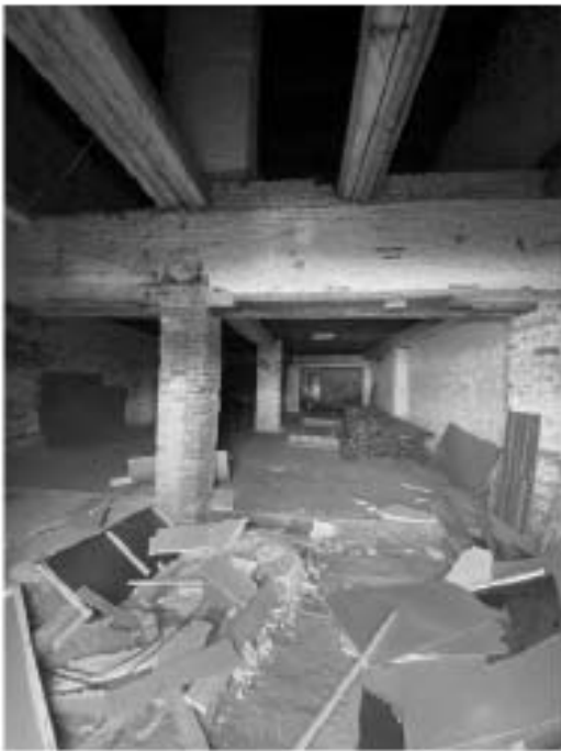
Фото 23. Помещение 23-Н (7) восточного корпуса. Балки междуэтажного перекрытия.
