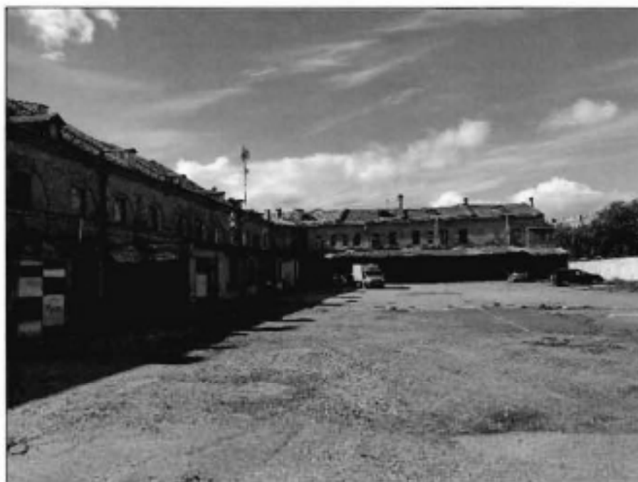
1. Вид на объект культурного наследия с северной стороны
