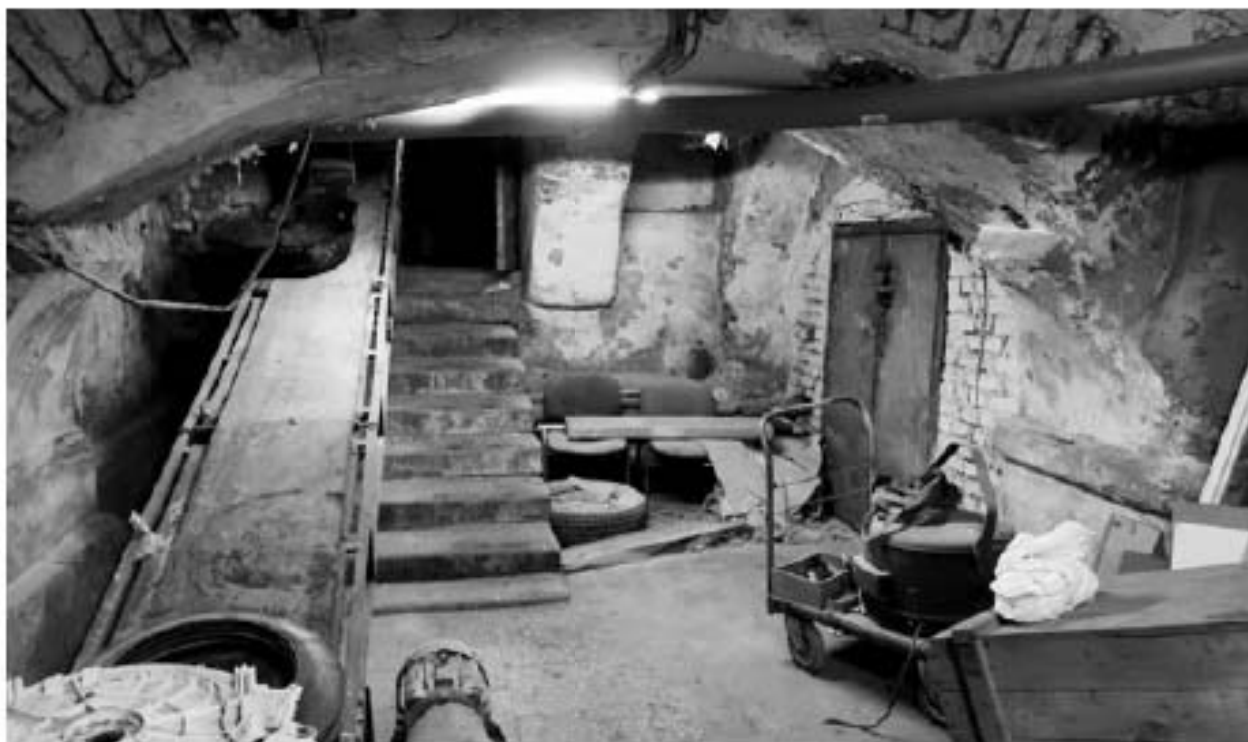
Фото 16. Подвальное помещение 20-Н (6) восточного корпуса. Кирпичные крестовые и цилиндрические с распалубками на подпружных арках.
