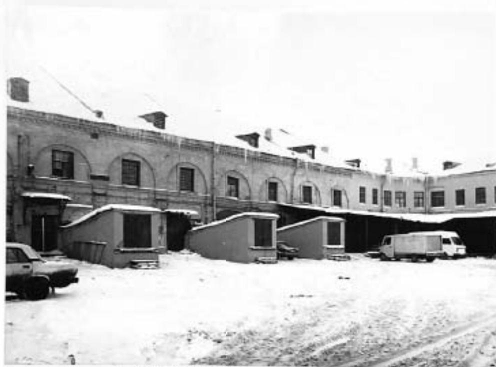
6. Б. Мыльный двор. Главный корпус. Вид со двора. Февраль 1996 г. Фотограф Гринев И.Е.
