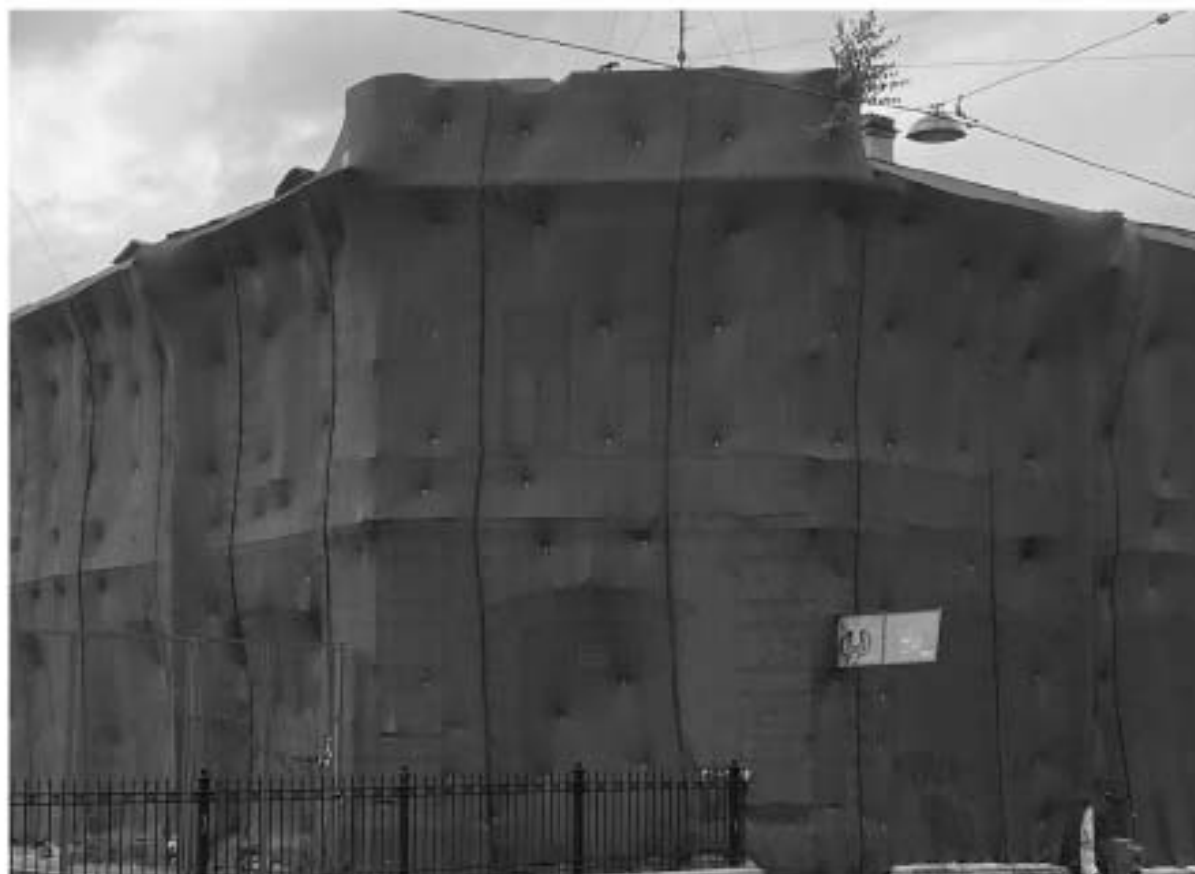
Фото 7. Фрагмент фасада западного корпуса. Угловой срез между фасадом по пр. Бакунина и фасадом со стороны Овсянниковского сквера.
