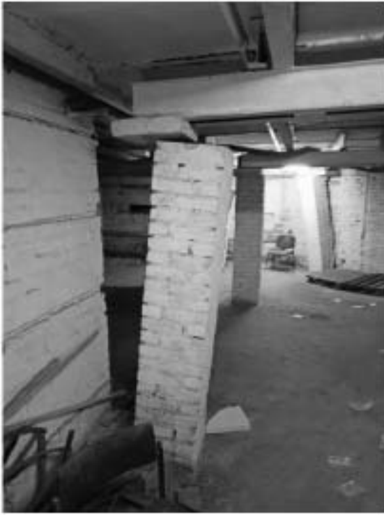
Фото 19. Подвальное помещение 35-Н (1) западного корпуса. Кирпичные стойки перекрытия.
