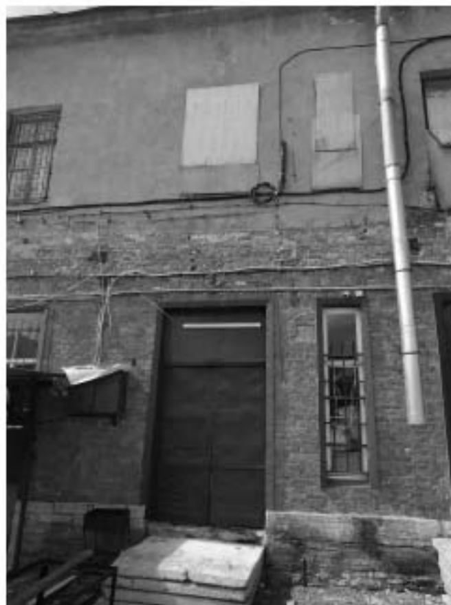
Фото 15. Фрагмент дворового фасада западного корпуса.
