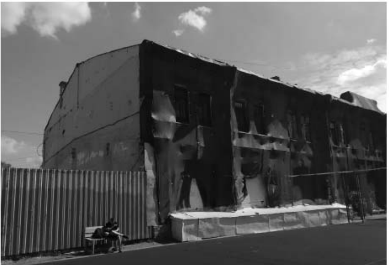
Фото 6. Фрагмент лицевого фасада западного корпуса со стороны Овсянниковского сквера. В настоящее время, на основании разрешения КГИОП от 17.01.2023 № 01-26-2697/22-0-1, на лицевой фасад со Овсянниковского сквера установлена защитная сетка.
