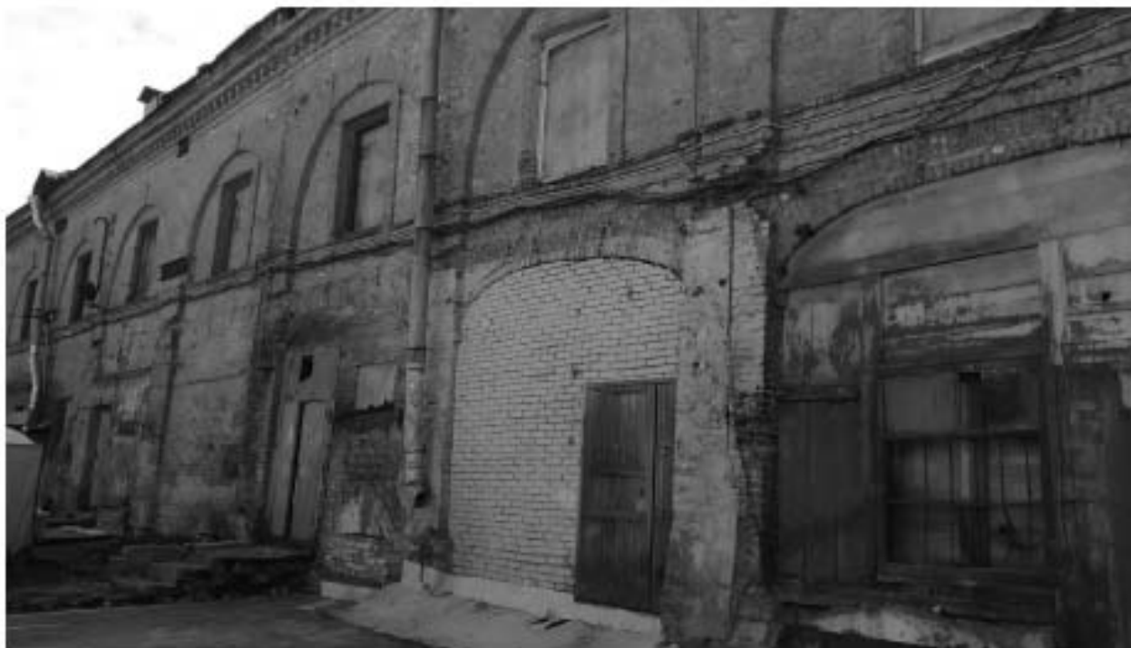
Фото 9. Фрагмент дворового фасада восточного корпуса. В настоящее время выполнены демонтажные работы гаражей и наклонных входов – навесов в подвальные помещения, в соответствии с согласованной документацией.
