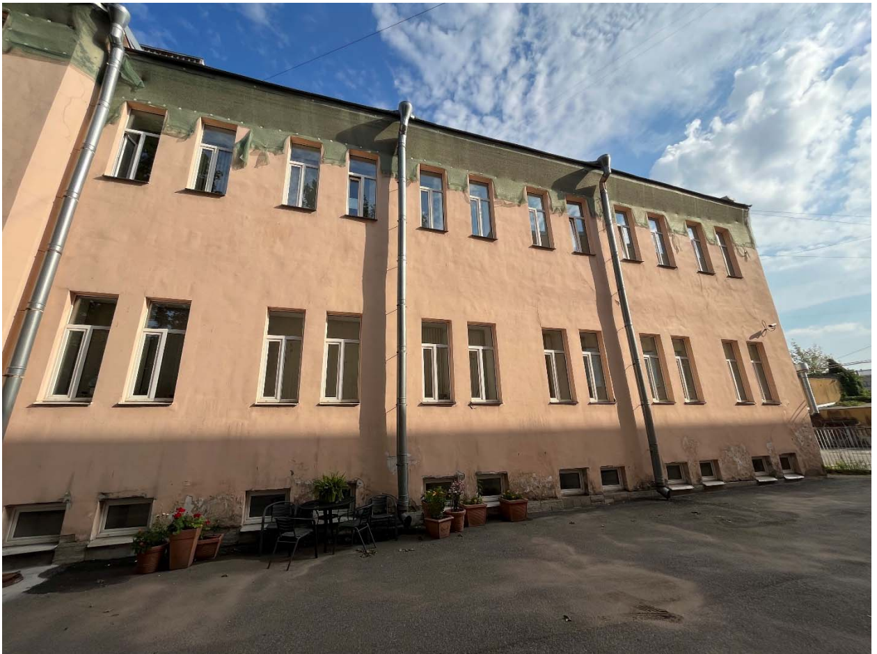
Фото №12. Фрагмент южного дворового фасада, вход здание.
