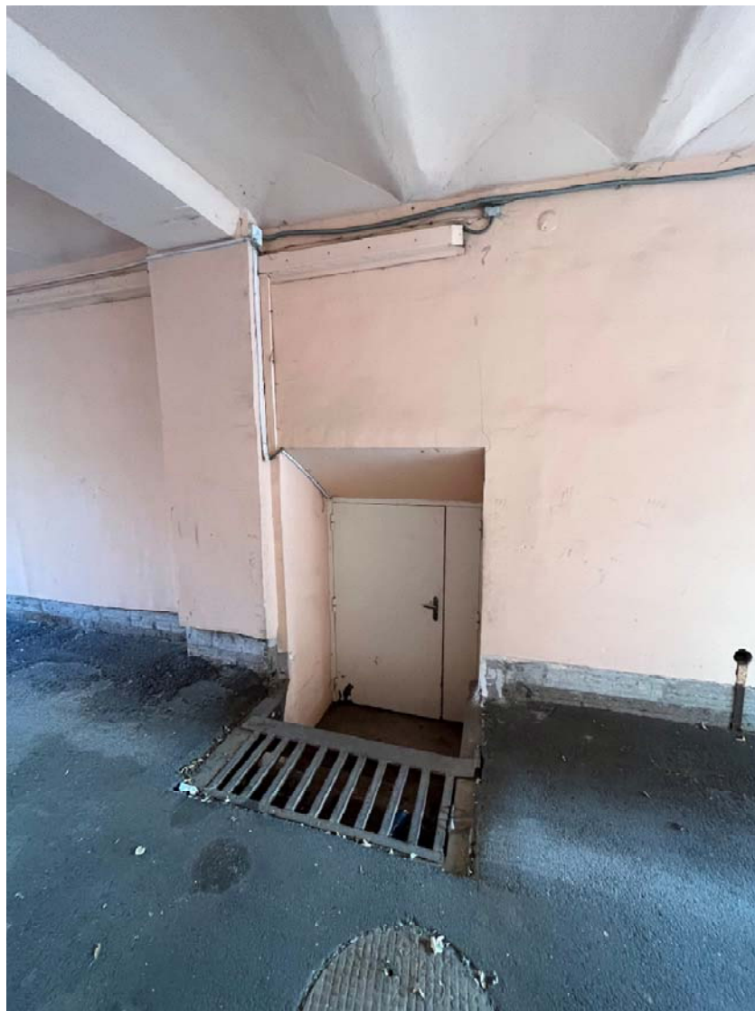
Фото №5. Воротный проезд, приямок, вход в подвал.
