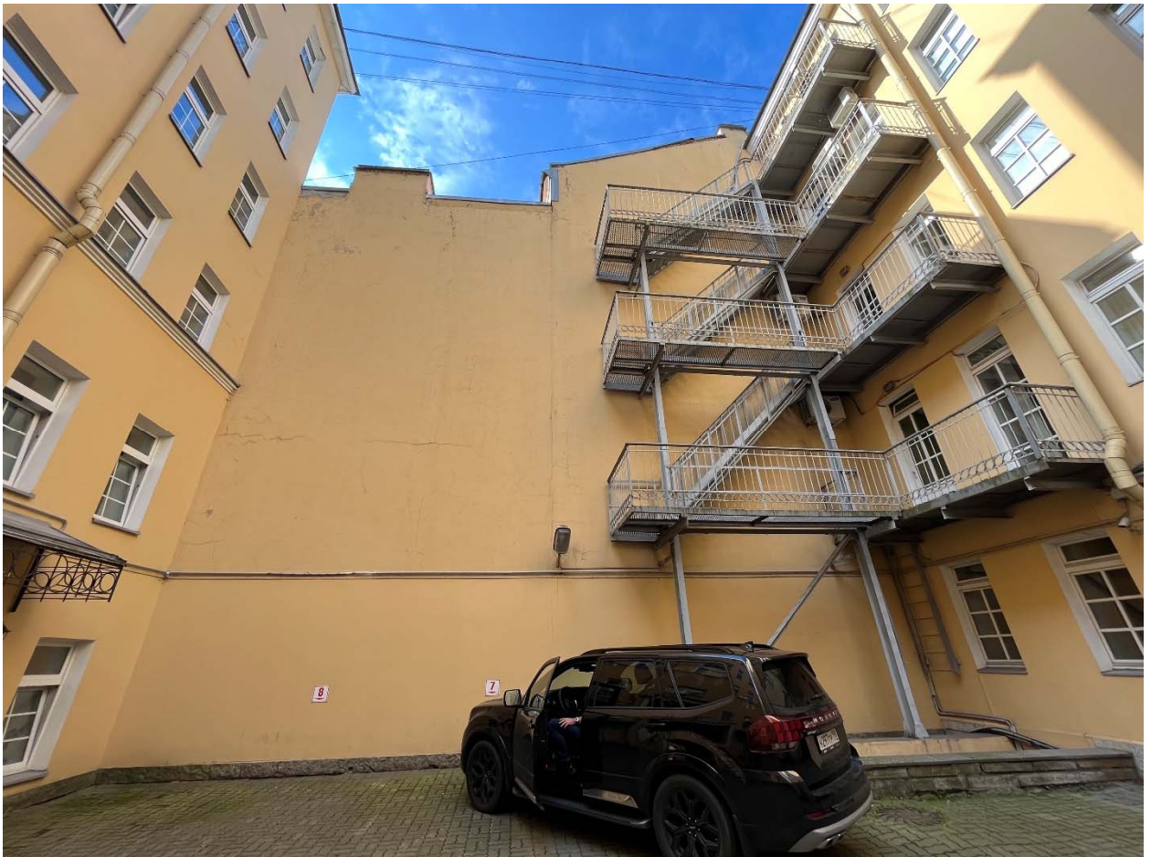
Фото №15. Фрагмент северного дворового фасада.
