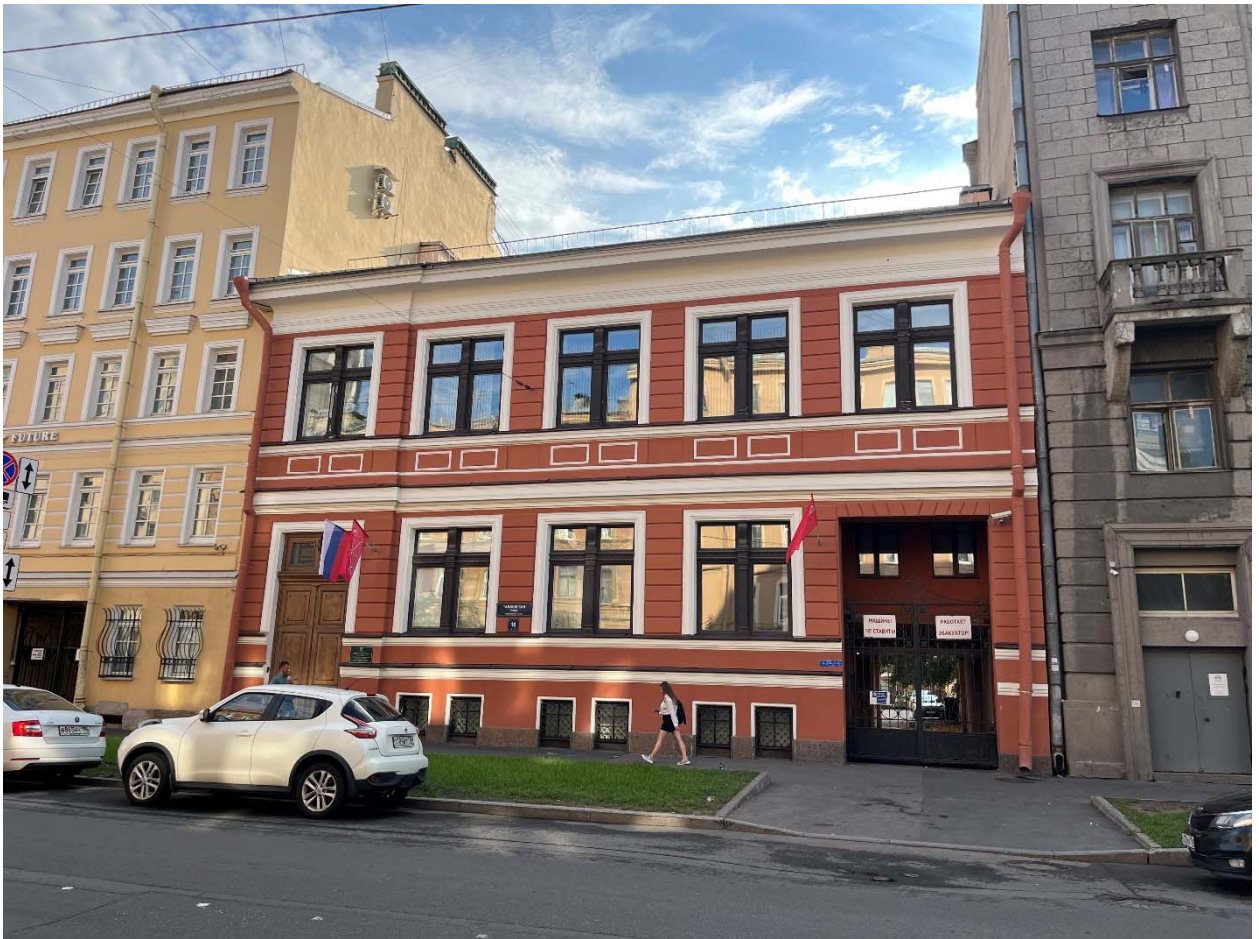
Фото №1. Лицевой западный фасад, общий вид.
