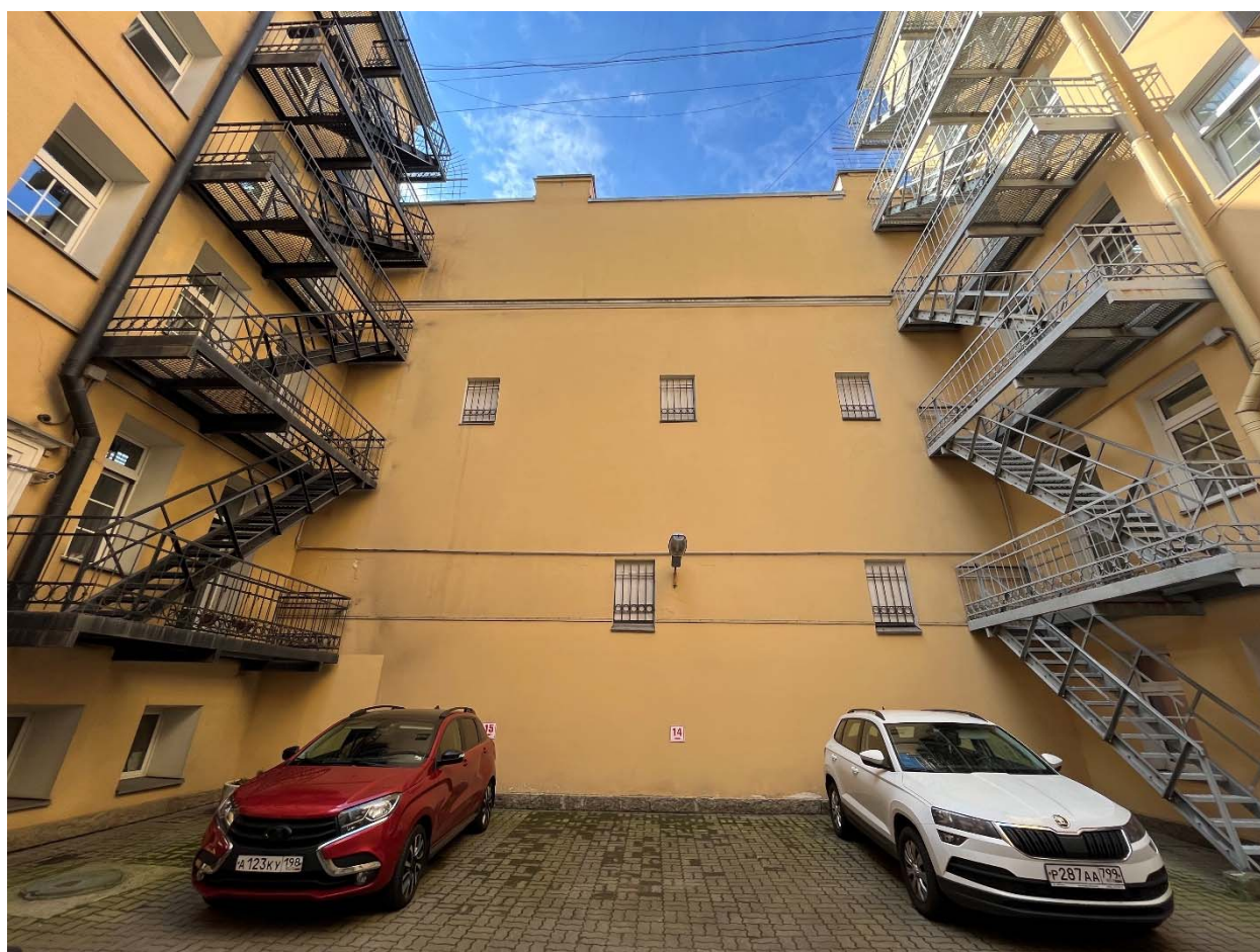
Фото №16. Фрагмент северного дворового фасада.
