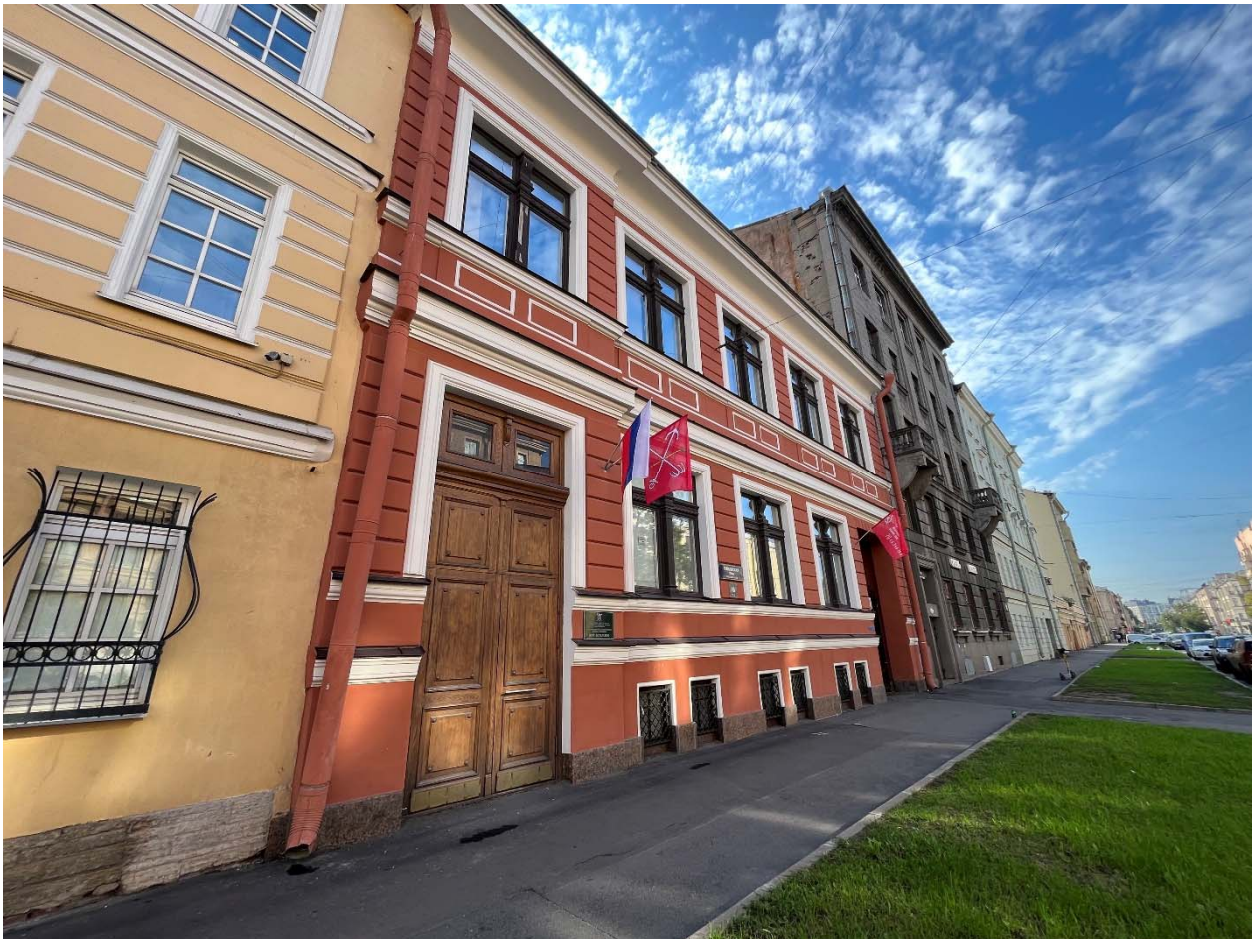
Фото №3. Лицевой западный фасад, общий вид.
