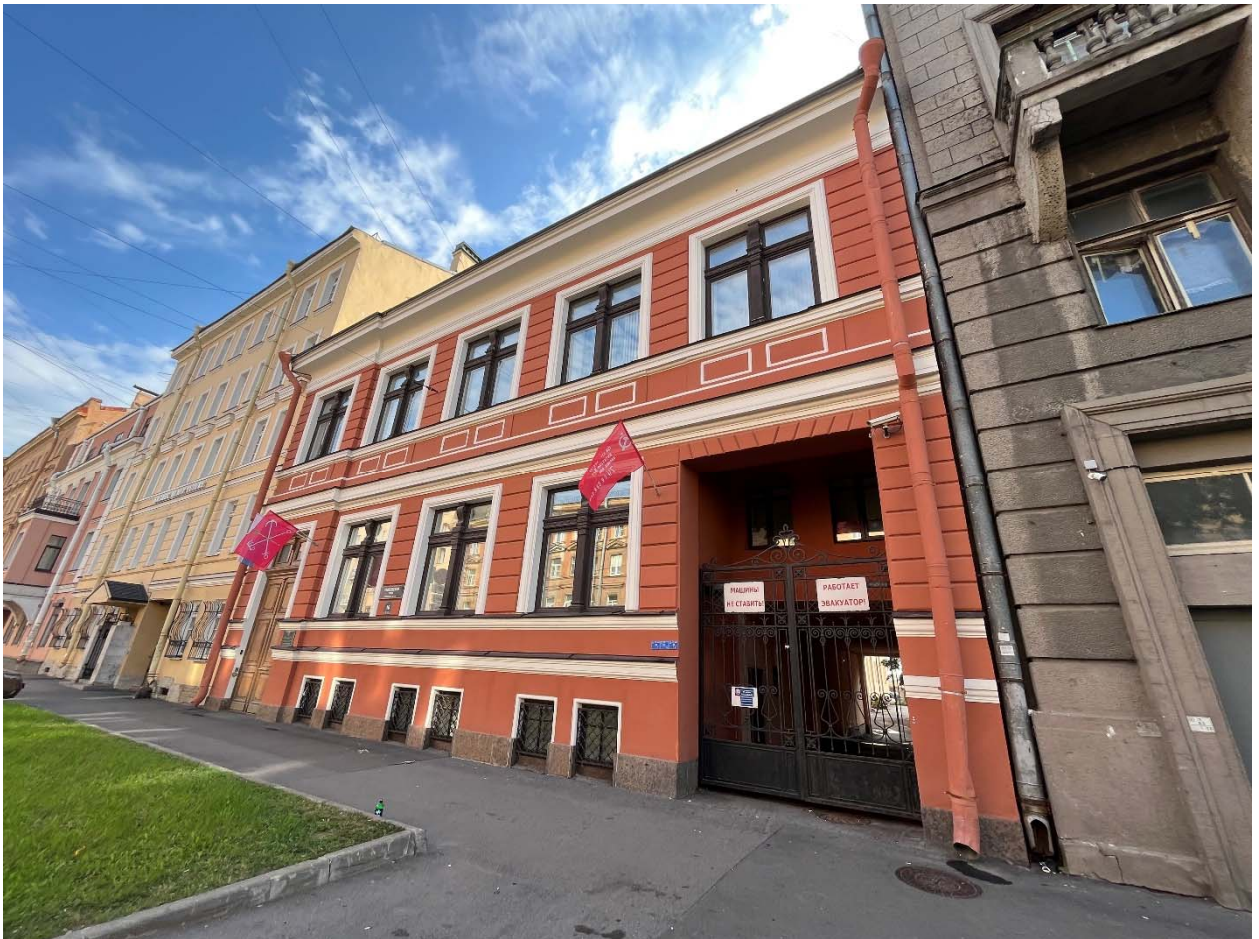
Фото №2. Лицевой западный фасад, общий вид.
