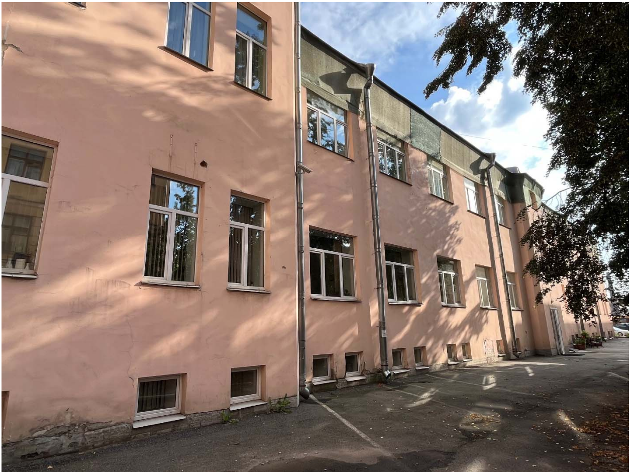
Фото №8. Южный дворовый фасад.
