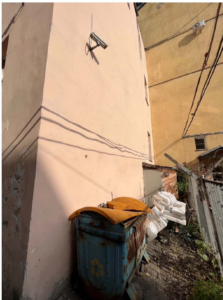
Фото №13. Фрагмент восточного (торцевого) дворового фасада.
