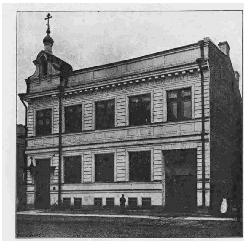
Илл 5. Тамбовская ул., 16 (источник: www.citywalls.ru ).
