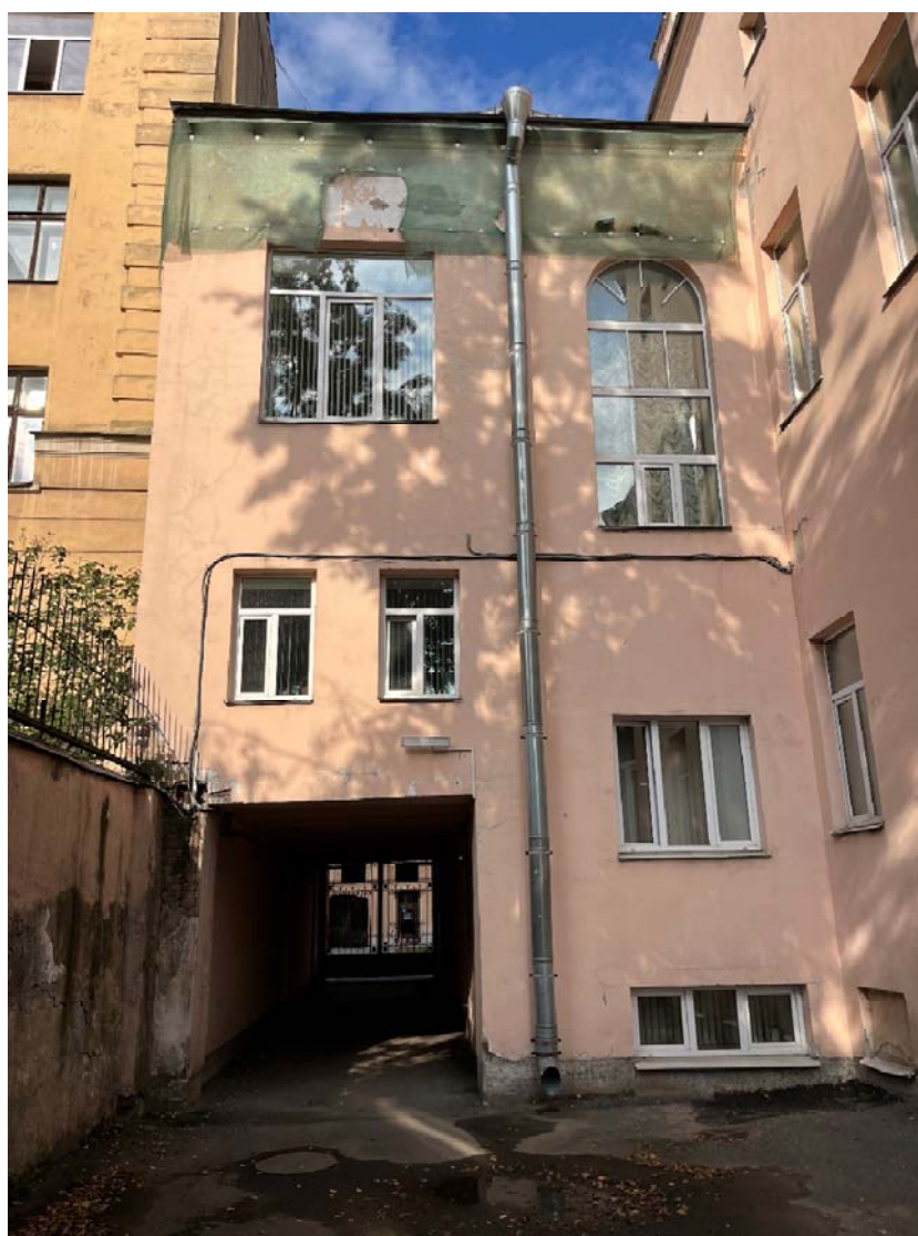
Фото №6. Восточный дворовый фасад.
