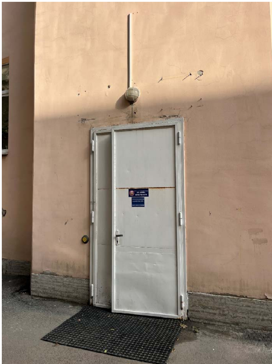
Фото №11. Фрагмент южного дворового фасада, вход здание.
