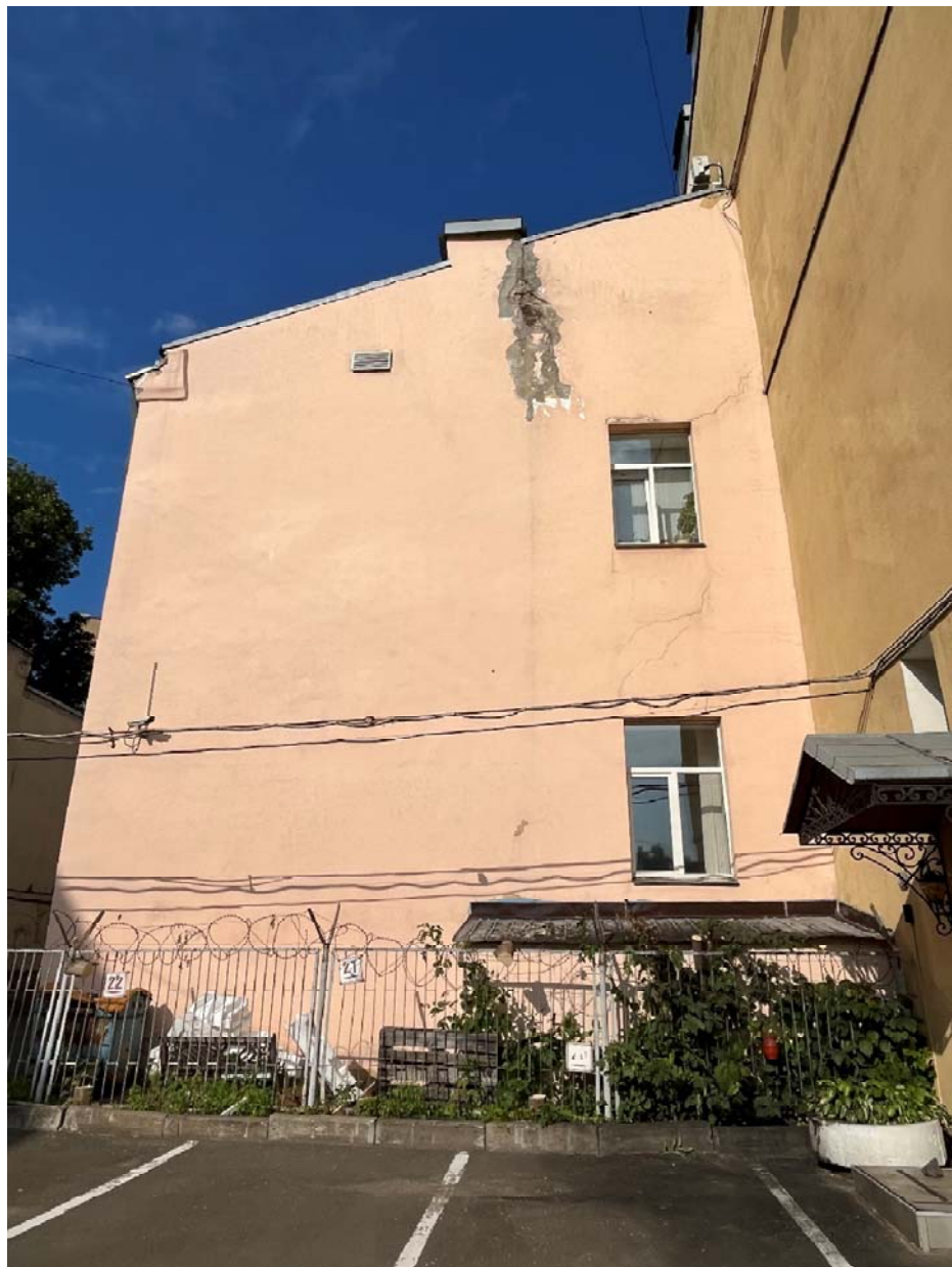
Фото №14. Восточный торцевой фасад.
