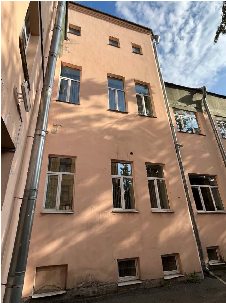
Фото №7. Фрагмент южного дворового фасада.
