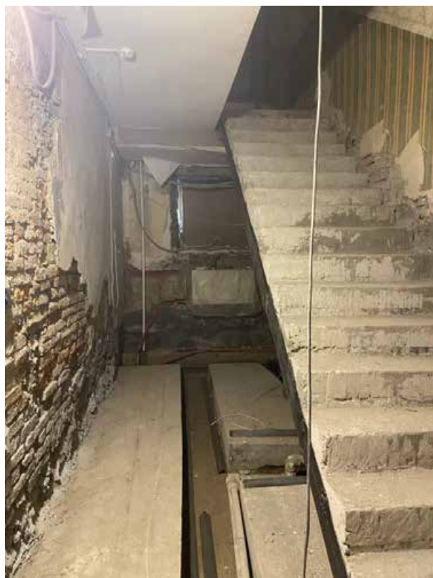
Фото 2. Помещение Л-1 (II).
