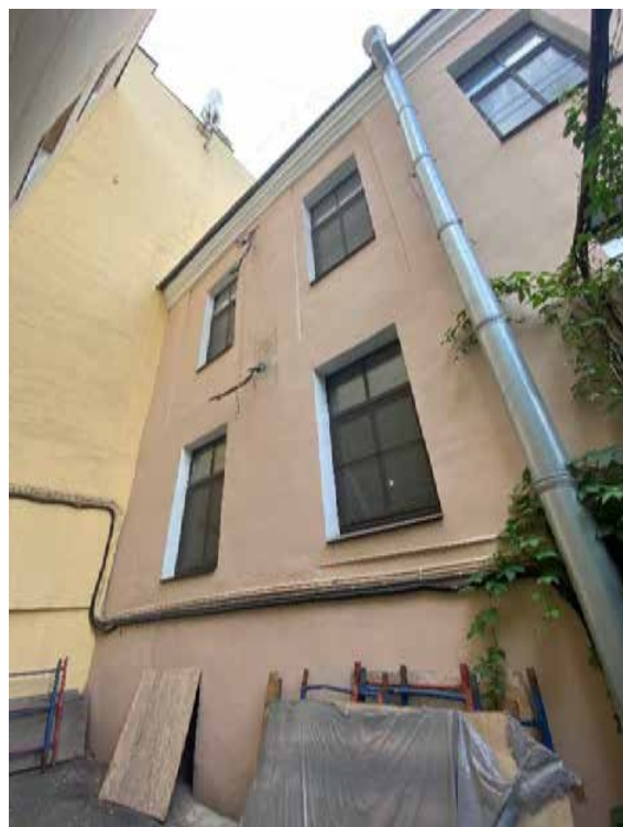
Фото 9. Ид на фрагмент дворового фасада.
