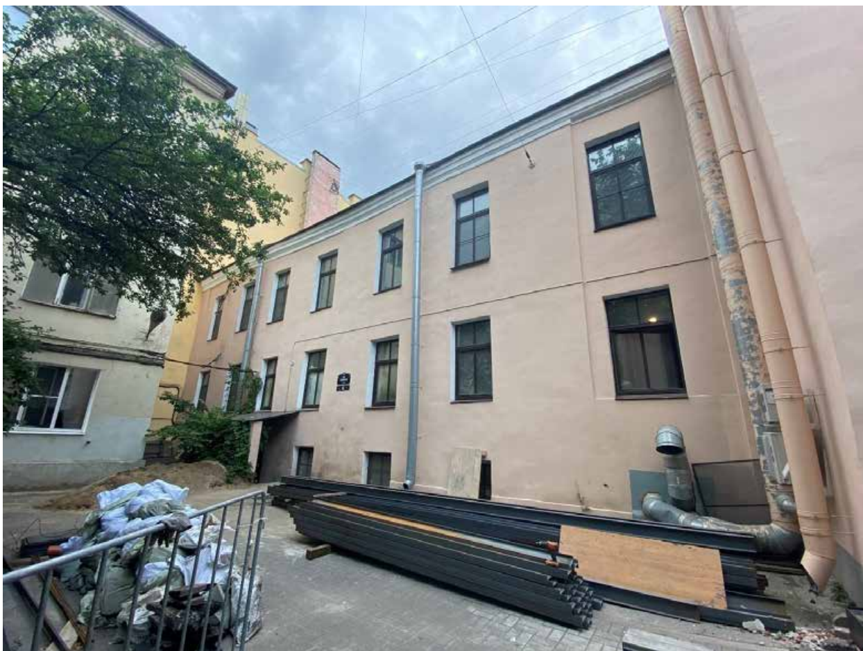
Фото 8. Вид на дворовый фасад.
