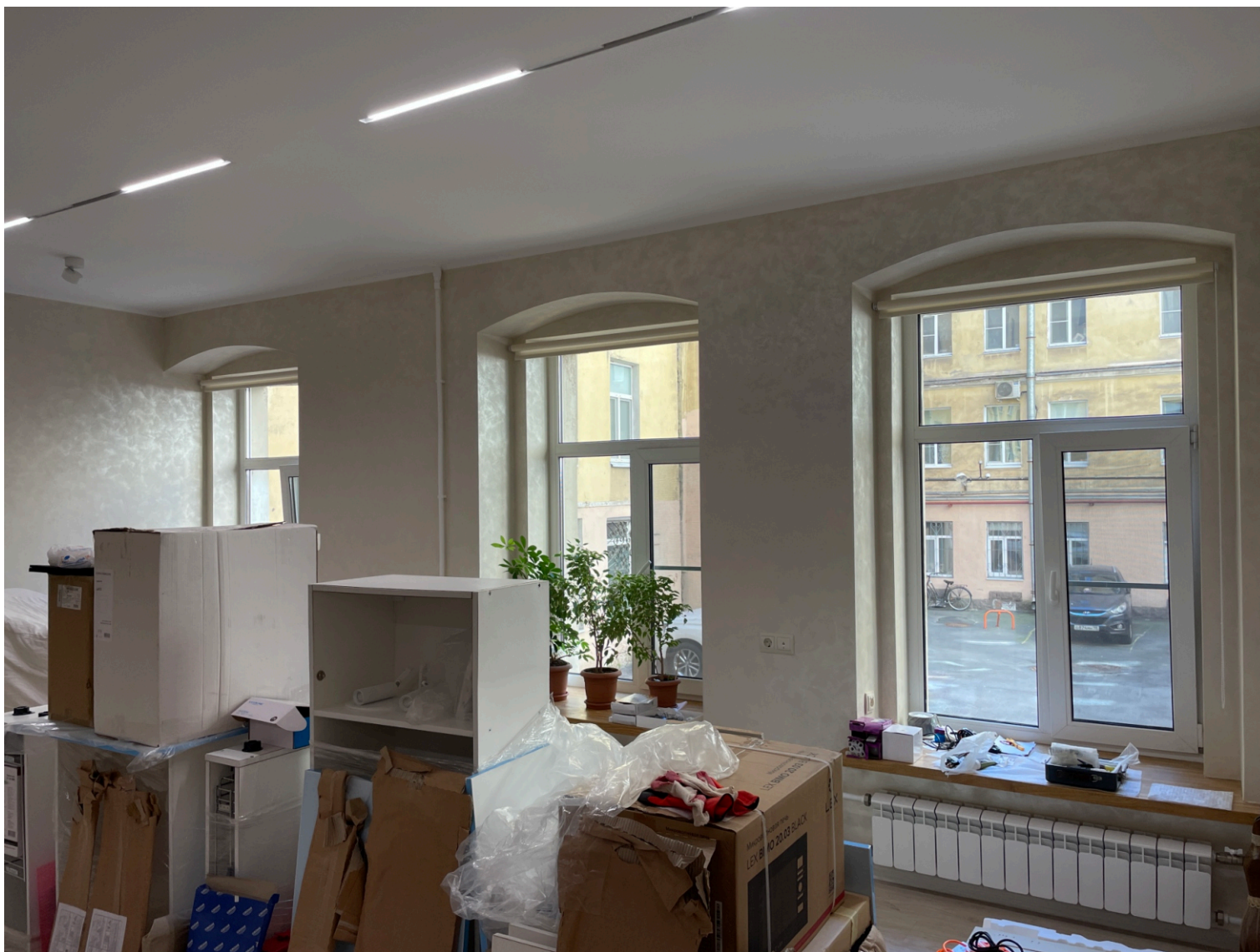
8. “Дом Ф.Ф. Лумберга”. Санкт-Петербург, Перекупной пер., дом 9, лит.А. Фрагмент помещения кв.17. Фото:27.06.2024.
