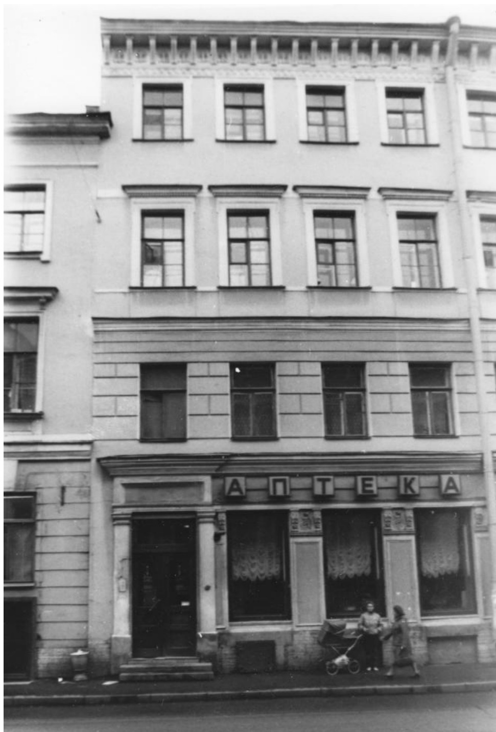
Илл. 9. Проспект Майорова., 33. Вид лицевого фасада. 1987 г. https://pastvu.com
