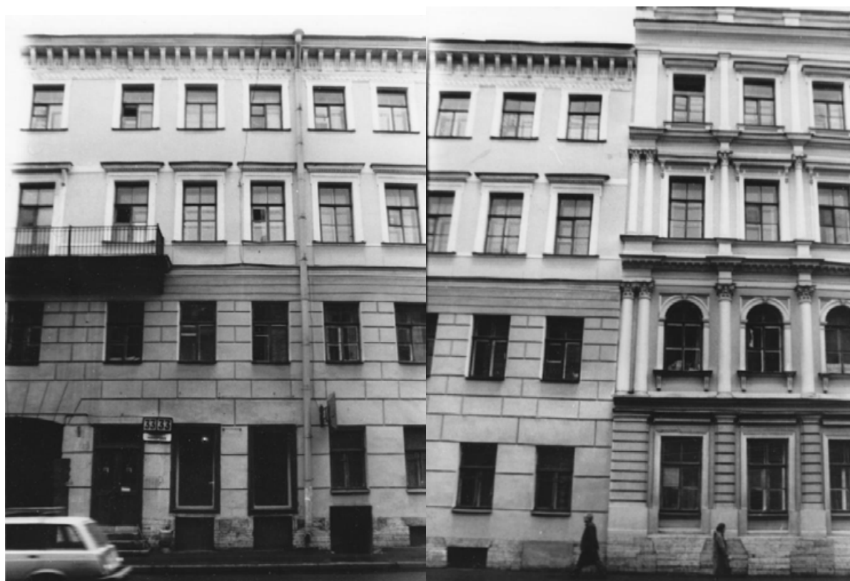
Илл. 10. Проспект Майорова., 33. Вид лицевого фасада. 1987 г. https://pastvu.com
