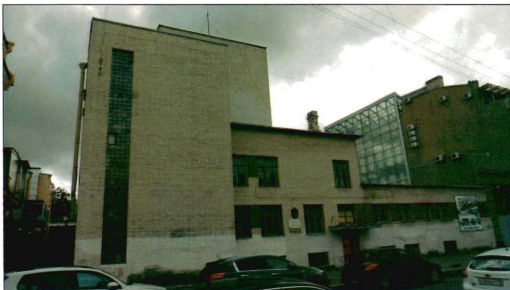
2. Северо-восточный фасад. Вид с востока.
