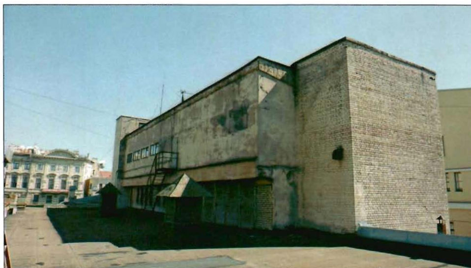
6. Вид с кровли на четырехэтажную часть здания. Вид с запада.
