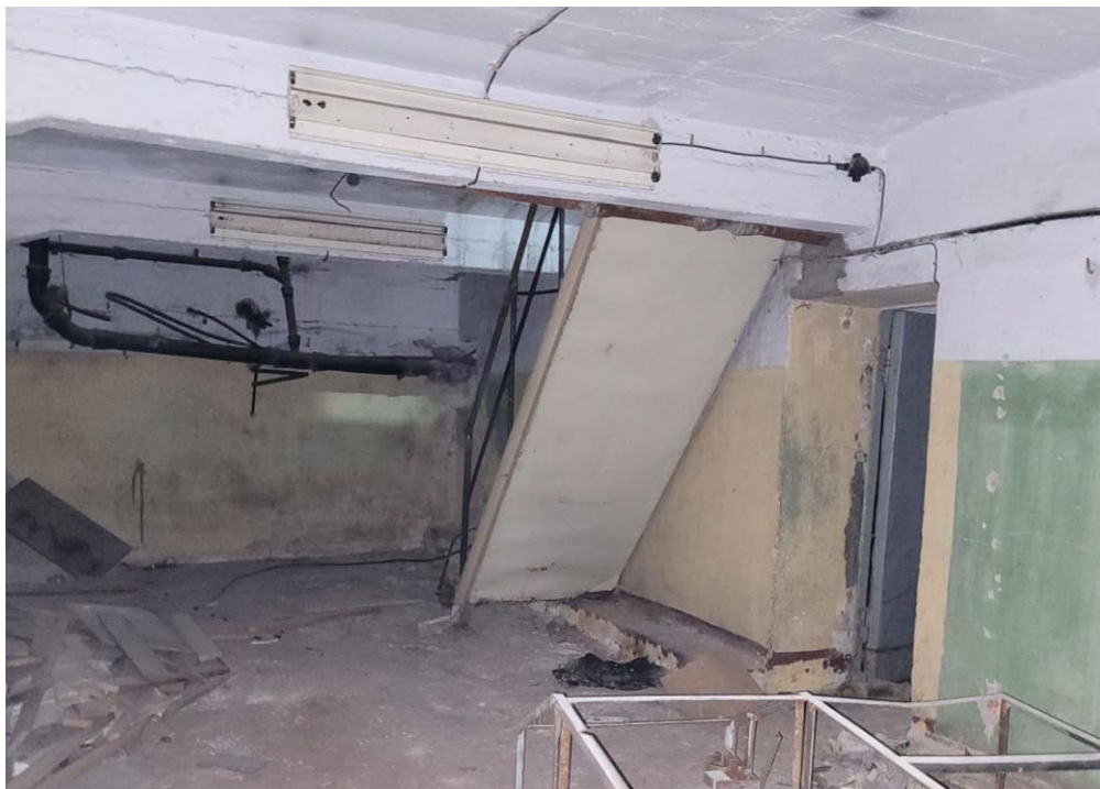
19. Объект культурного наследия регионального значения «Тяговая подстанция “Центральная” (№ 11), обеспечившая восстановление трамвайного движения в блокадном Ленинграде» по адресу: г. Санкт-Петербург, набережная реки Фонтанки, дом 3а, лит. А. Подвал. Фрагмент интерьера. Перекрытие.
