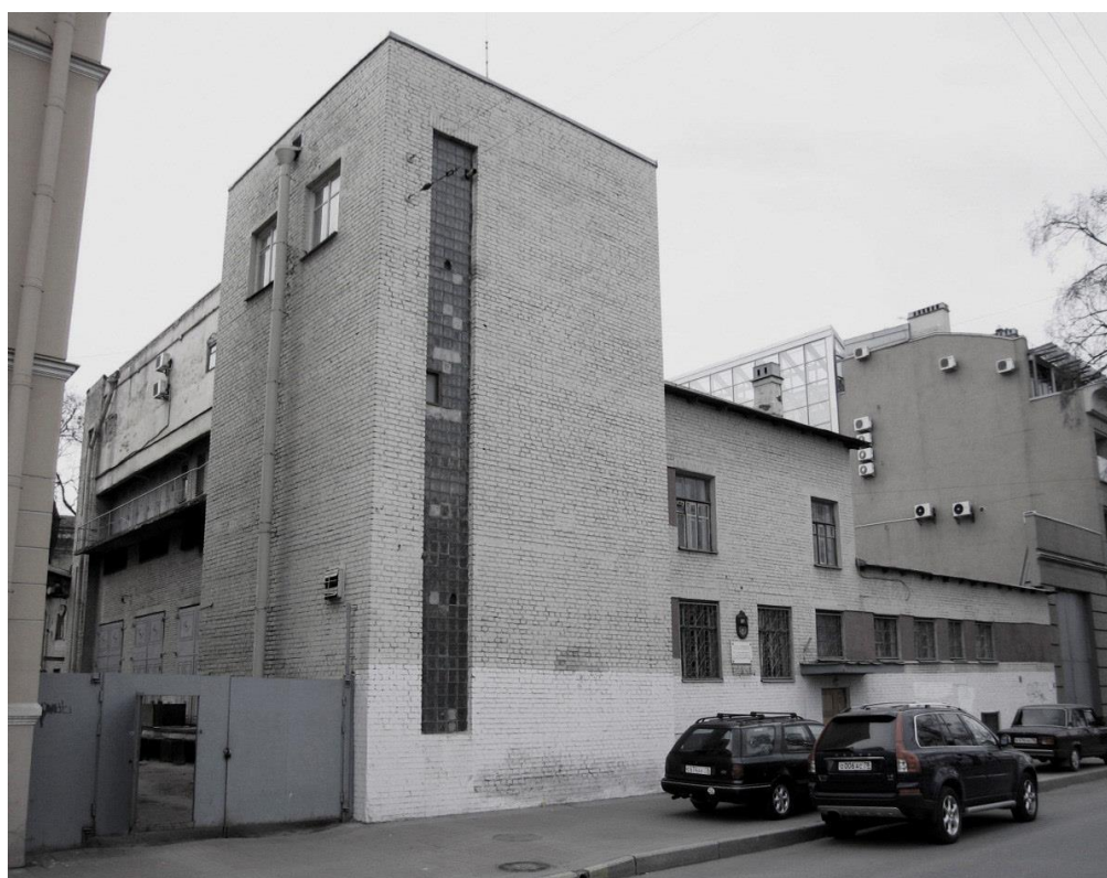
26. Тяговая подстанция № 11 «Комсомольская» на Фонтанке, 3а. Фотография. 2014г. https://pastvu.com/ .
