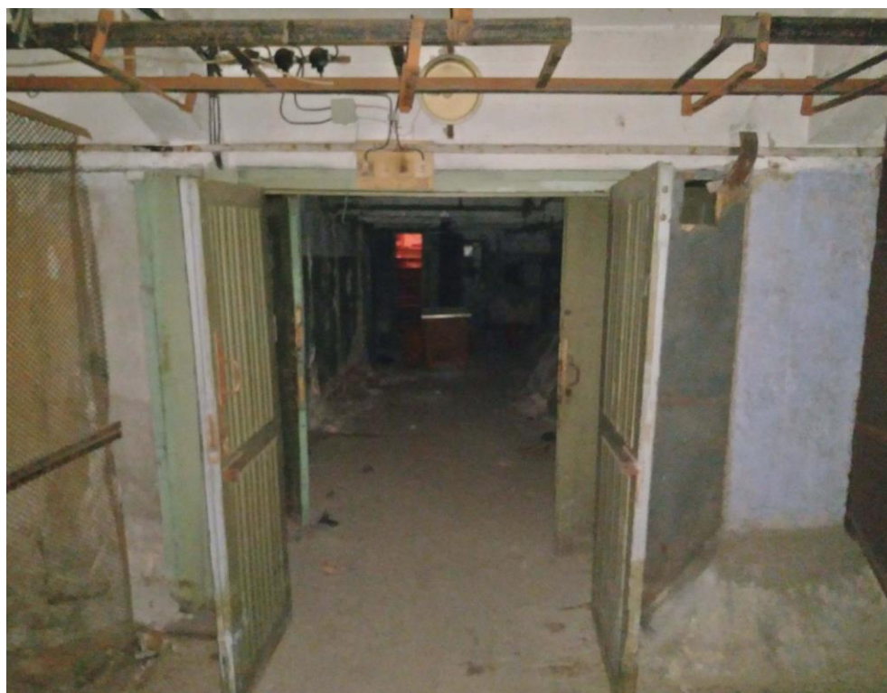
20. Объект культурного наследия регионального значения «Тяговая подстанция “Центральная” (№ 11), обеспечившая восстановление трамвайного движения в блокадном Ленинграде» по адресу: г. Санкт-Петербург, набережная реки Фонтанки, дом 3а, лит. А. Подвал. Фрагмент интерьера.
