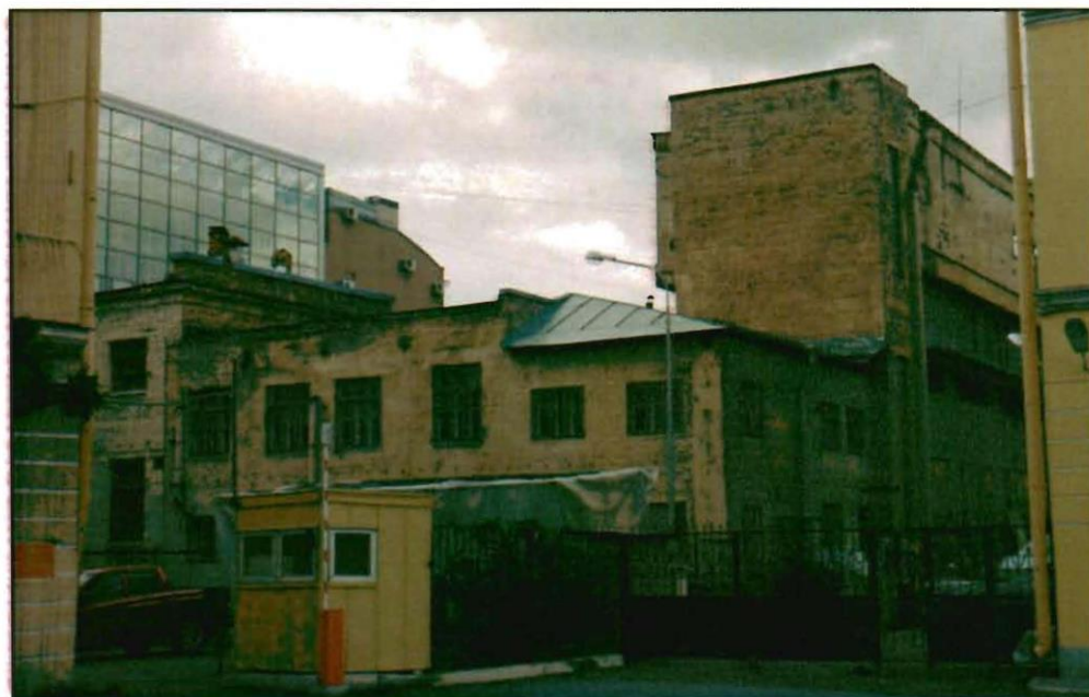
4. Общий вид с юго-запада.
