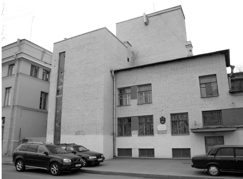
27. Тяговая подстанция № 11 «Комсомольская» на Фонтанке, 3а. Фасад по набережной. Фотография. 2014г. https://pastvu.com/ .
