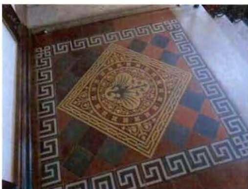
5. Покрытие пола верхнего уровня вестибюля.
