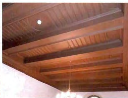
8. Оформление потолка над лестничной клеткой.
