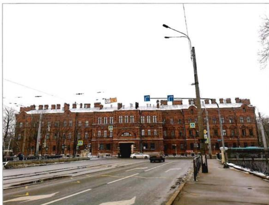
1. Западный фасад объекта культурного наследия.
