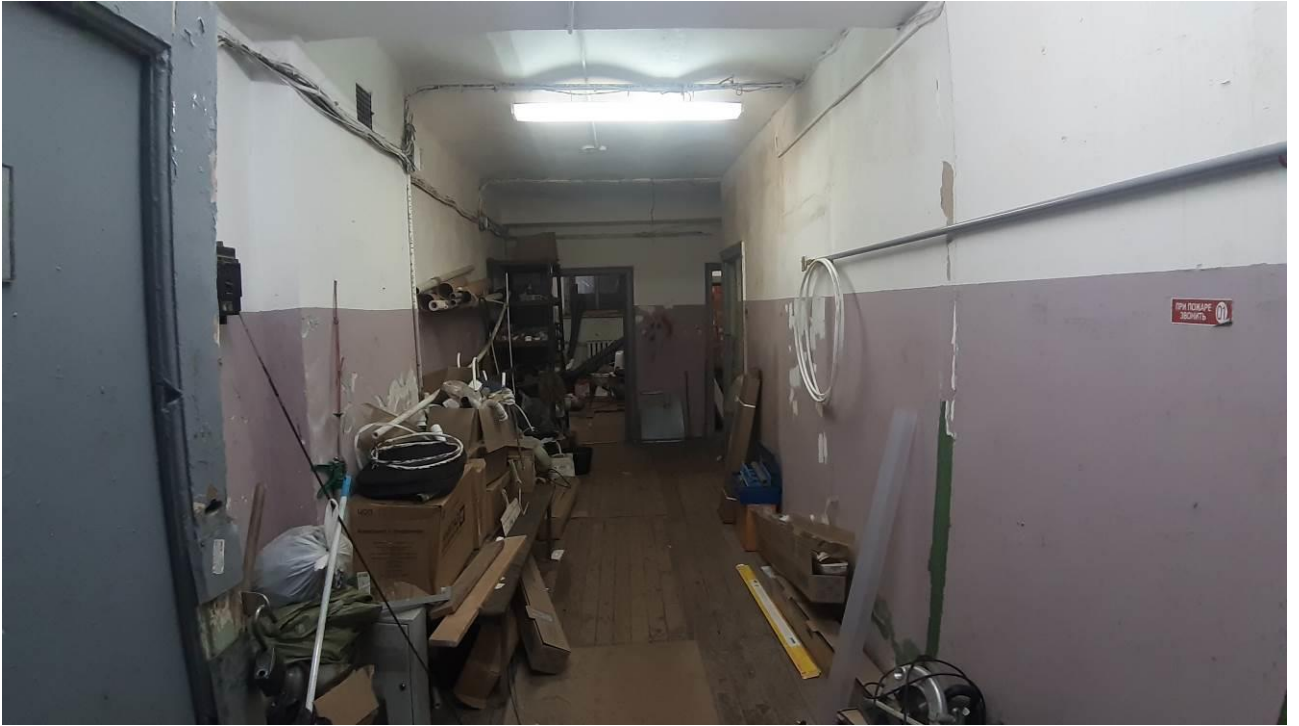
9. «Главный корпус Волковской богадельни». Подвальные помещения. Штиглиц М.С. 23.10.2024.
