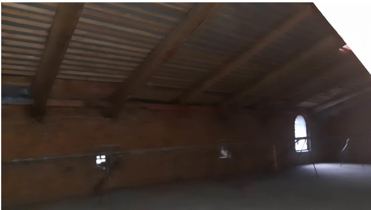
63. «Главный корпус Волковской богадельни». Чердак. Штиглиц М.С. 23.10.2024.
