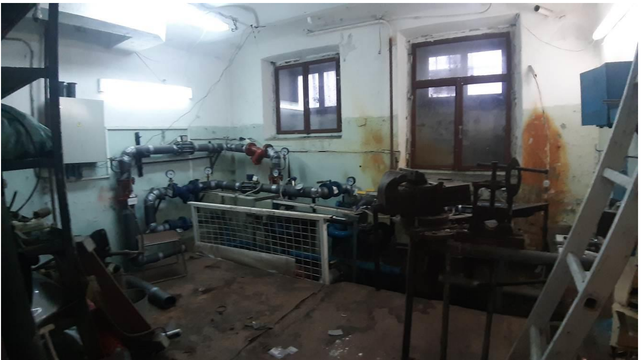
8. «Главный корпус Волковской богадельни». Подвальные помещения. Штиглиц М.С. 23.10.2024.
