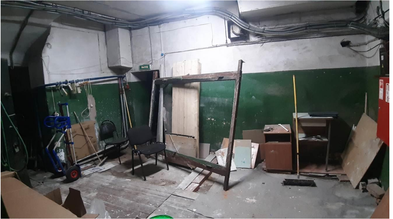
17. «Главный корпус Волковской богадельни». Подвальные помещения. Штиглиц М.С. 23.10.2024.
