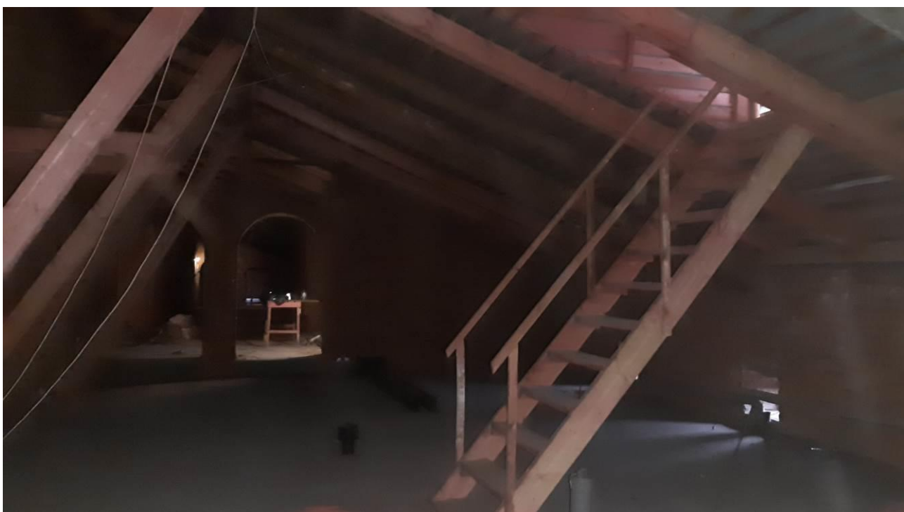
68. «Главный корпус Волковской богадельни». Чердак. Штиглиц М.С. 23.10.2024.
