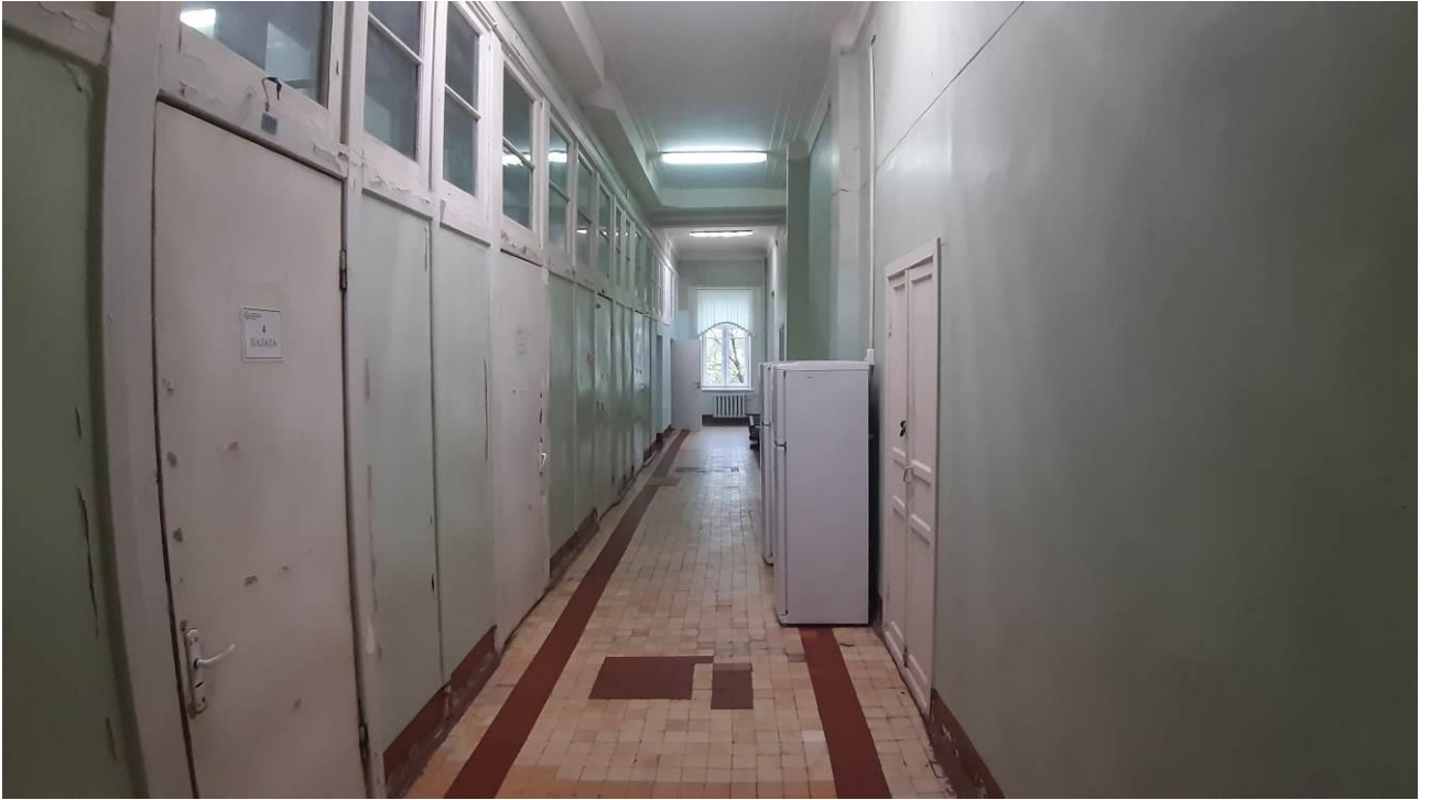
39. «Главный корпус Волковской богадельни». Помещения 2-го этажа. Штиглиц М.С. 23.10.2024.
