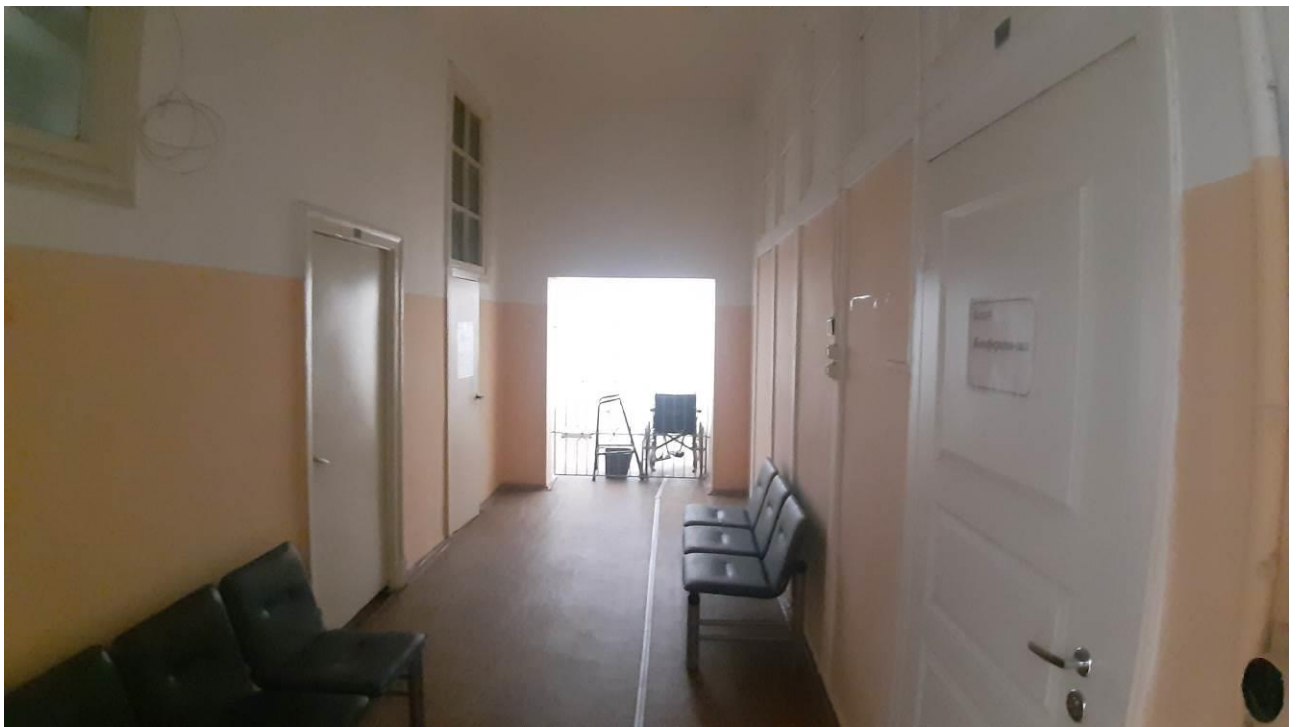
56. «Главный корпус Волковской богадельни». Помещения 3-го этажа. Штиглиц М.С. 23.10.2024.
