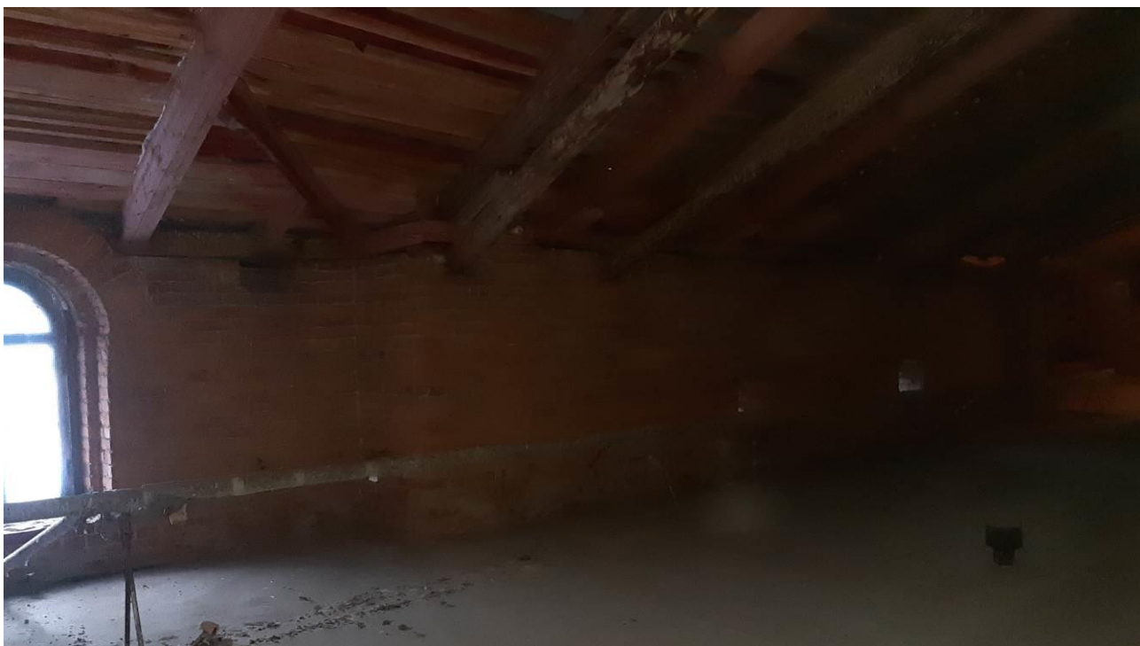
69. «Главный корпус Волковской богадельни». Чердак. Штиглиц М.С. 23.10.2024.
