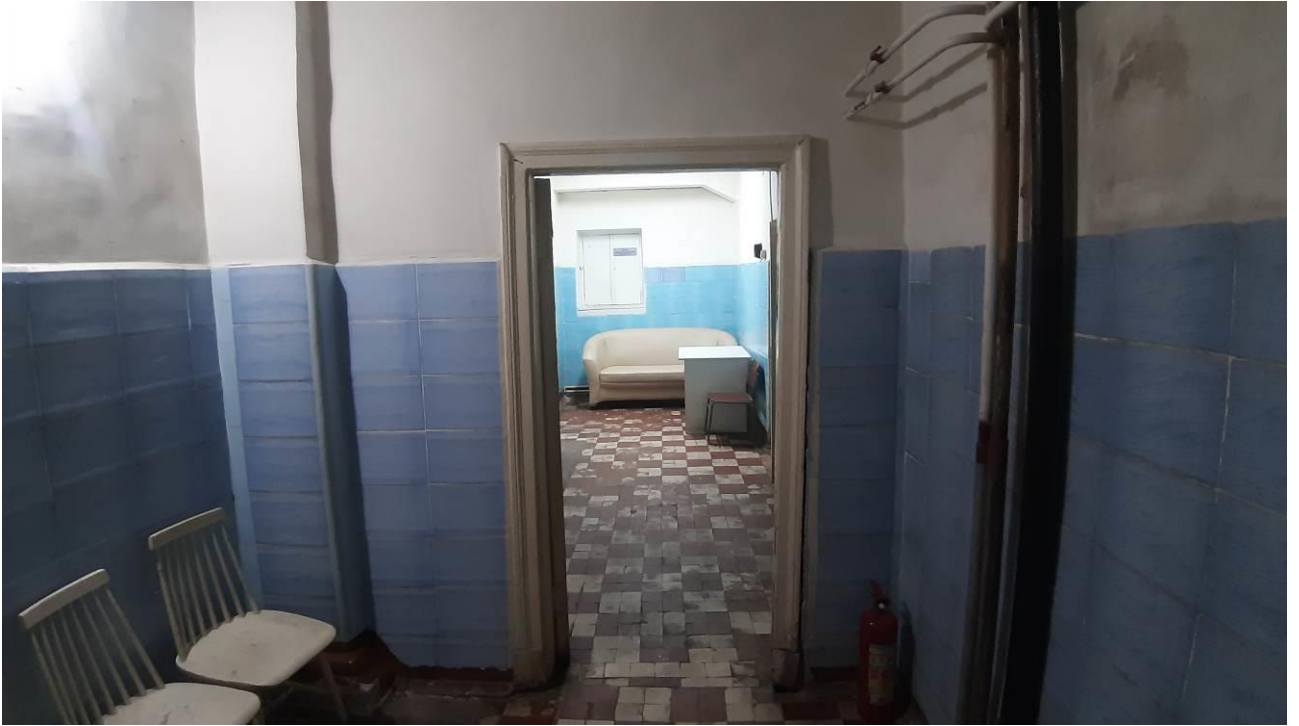
21. «Главный корпус Волковской богадельни». Помещения 1-го этажа. Штиглиц М.С. 23.10.2024.
