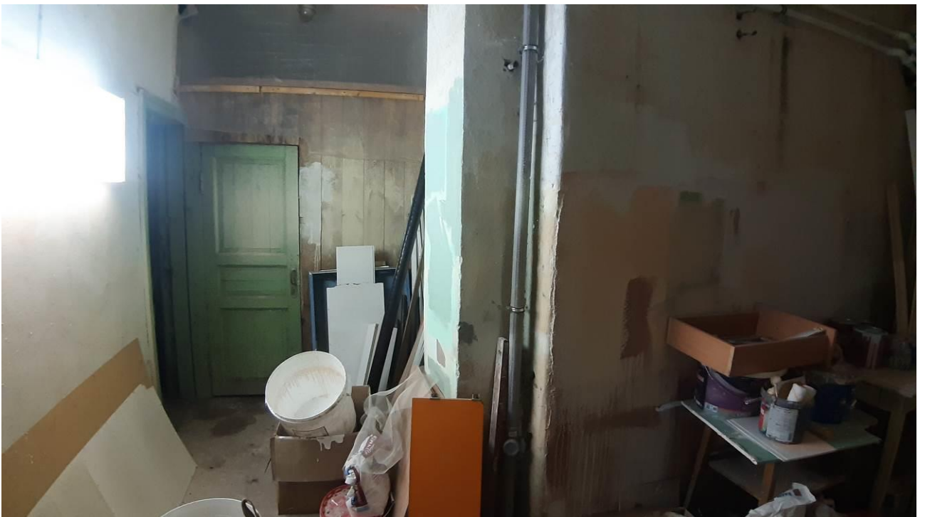
16. «Главный корпус Волковской богадельни». Подвальные помещения. Штиглиц М.С. 23.10.2024.
