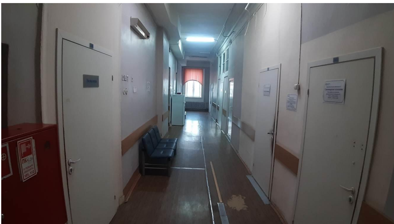
62. «Главный корпус Волковской богадельни». Помещения 3-го этажа. Штиглиц М.С. 23.10.2024.
