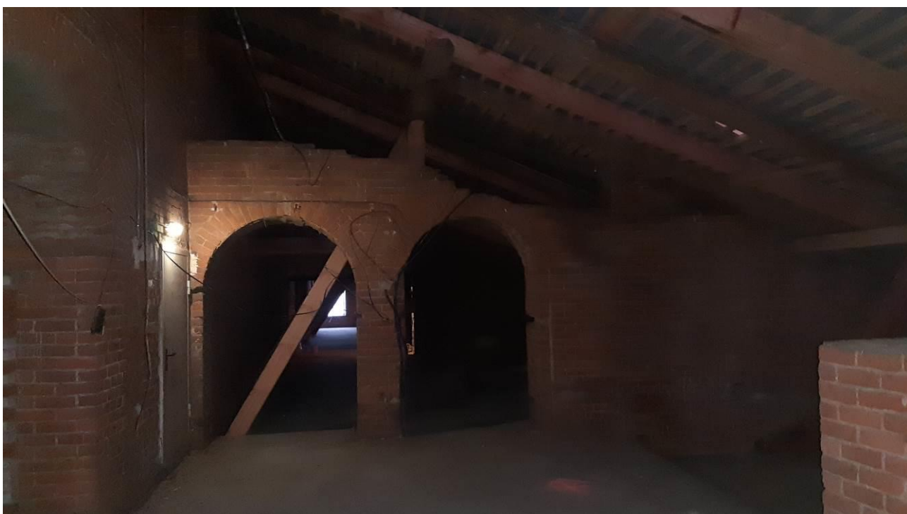
66. «Главный корпус Волковской богадельни». Чердак. Штиглиц М.С. 23.10.2024.
