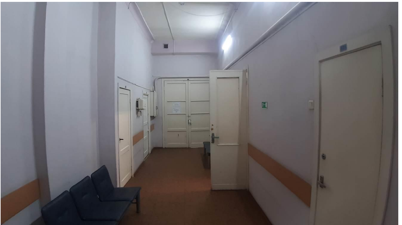
52. «Главный корпус Волковской богадельни». Помещения 3-го этажа. Штиглиц М.С. 23.10.2024.
