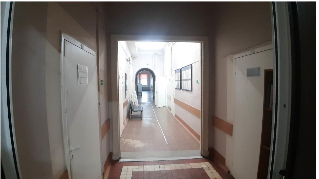
60. «Главный корпус Волковской богадельни». Помещения 3-го этажа. Штиглиц М.С. 23.10.2024.
