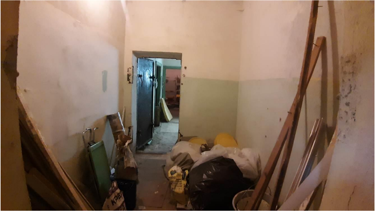
15. «Главный корпус Волковской богадельни». Подвальные помещения. Штиглиц М.С. 23.10.2024.
