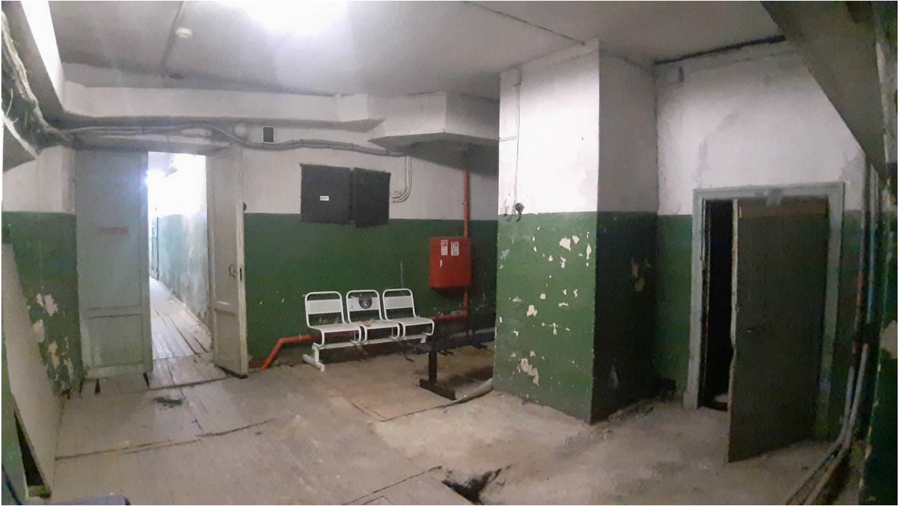
13. «Главный корпус Волковской богадельни». Подвальные помещения. Штиглиц М.С. 23.10.2024.
