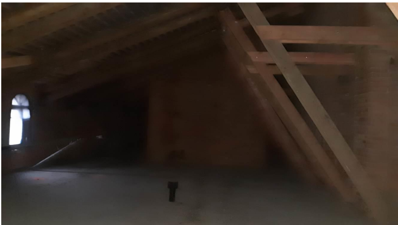
65. «Главный корпус Волковской богадельни». Чердак. Штиглиц М.С. 23.10.2024.
