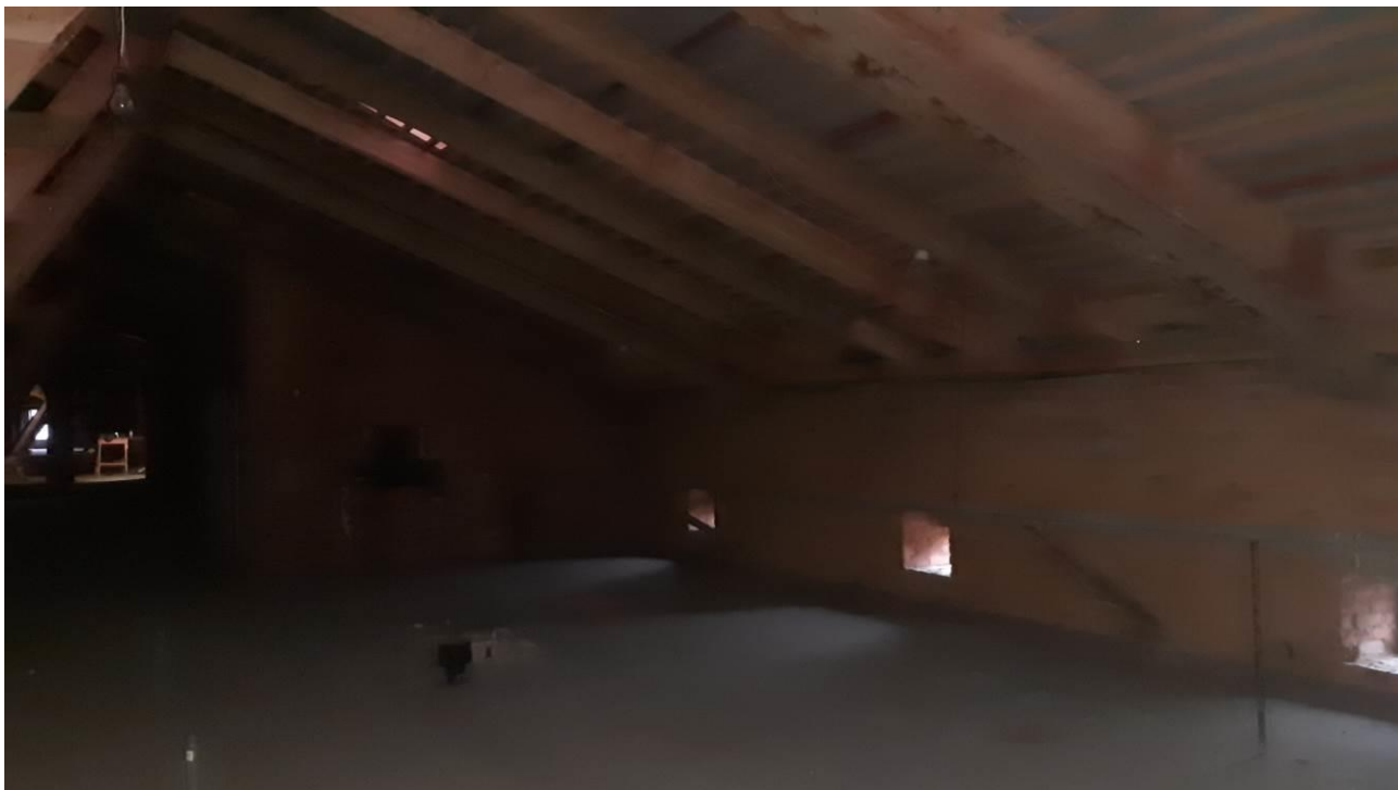
71. «Главный корпус Волковской богадельни». Чердак. Штиглиц М.С. 23.10.2024.
