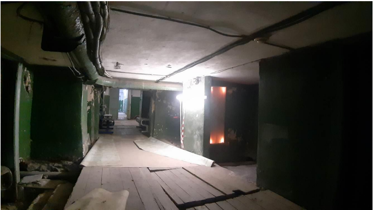
14. «Главный корпус Волковской богадельни». Подвальные помещения. Штиглиц М.С. 23.10.2024.
