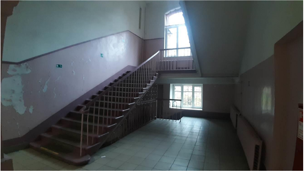
23. «Главный корпус Волковской богадельни». Помещения 1-го этажа. Штиглиц М.С. 23.10.2024.
