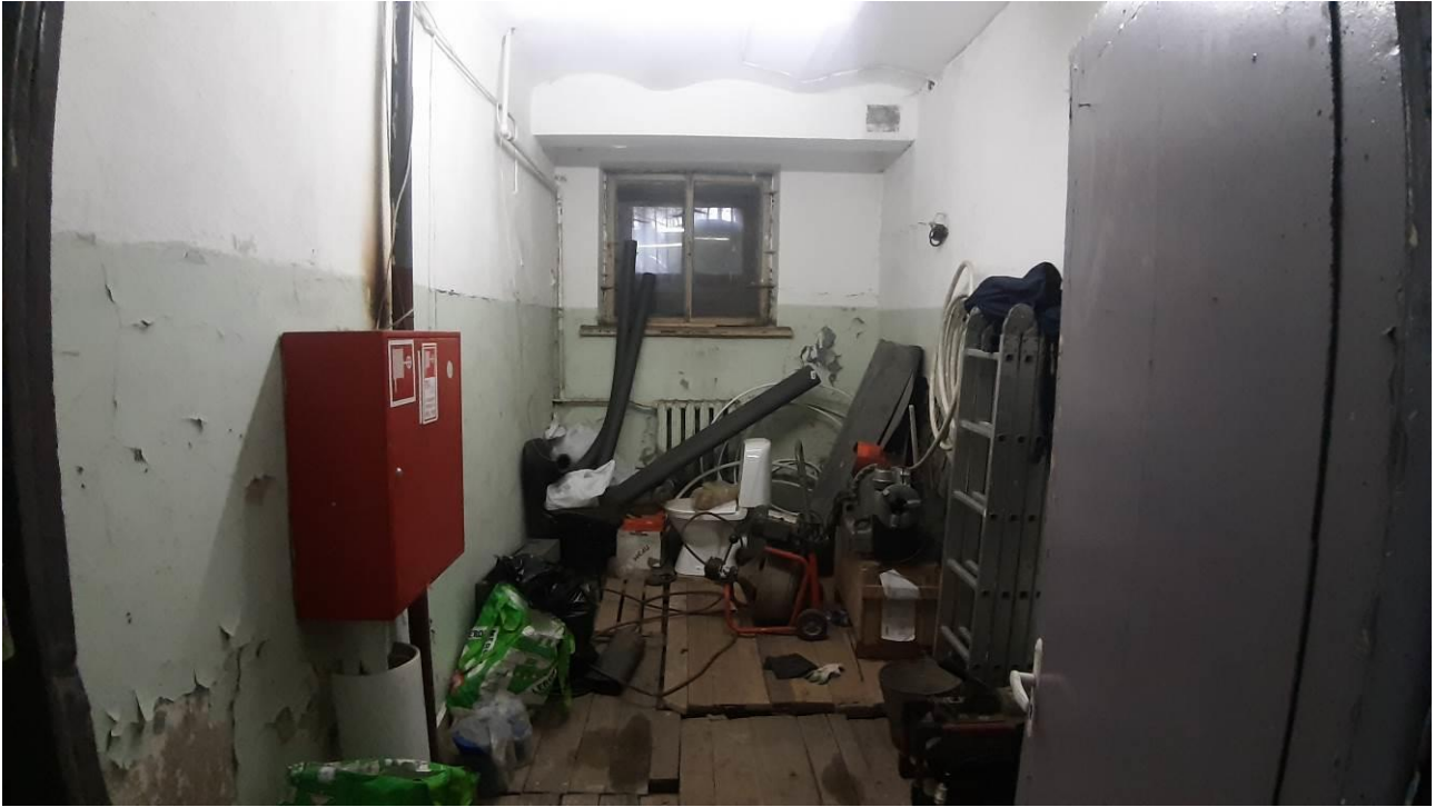
7. «Главный корпус Волковской богадельни». Подвальные помещения. Штиглиц М.С. 23.10.2024.
