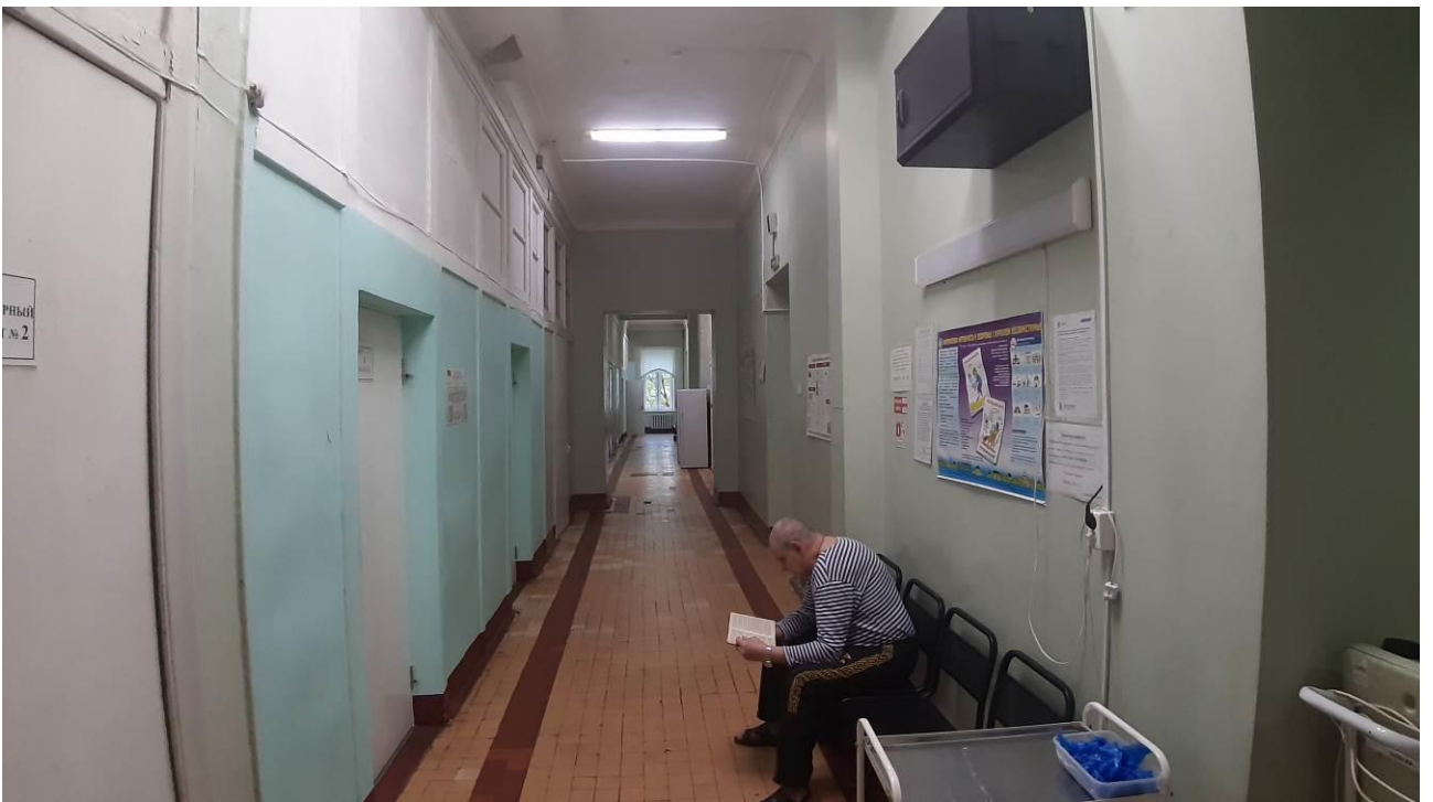
40. «Главный корпус Волковской богадельни». Помещения 2-го этажа. Штиглиц М.С. 23.10.2024.
