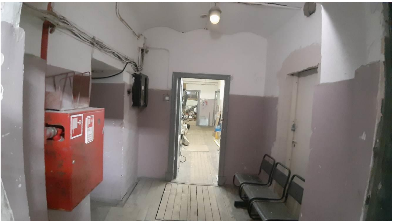
10. «Главный корпус Волковской богадельни». Подвальные помещения. Штиглиц М.С. 23.10.2024.
