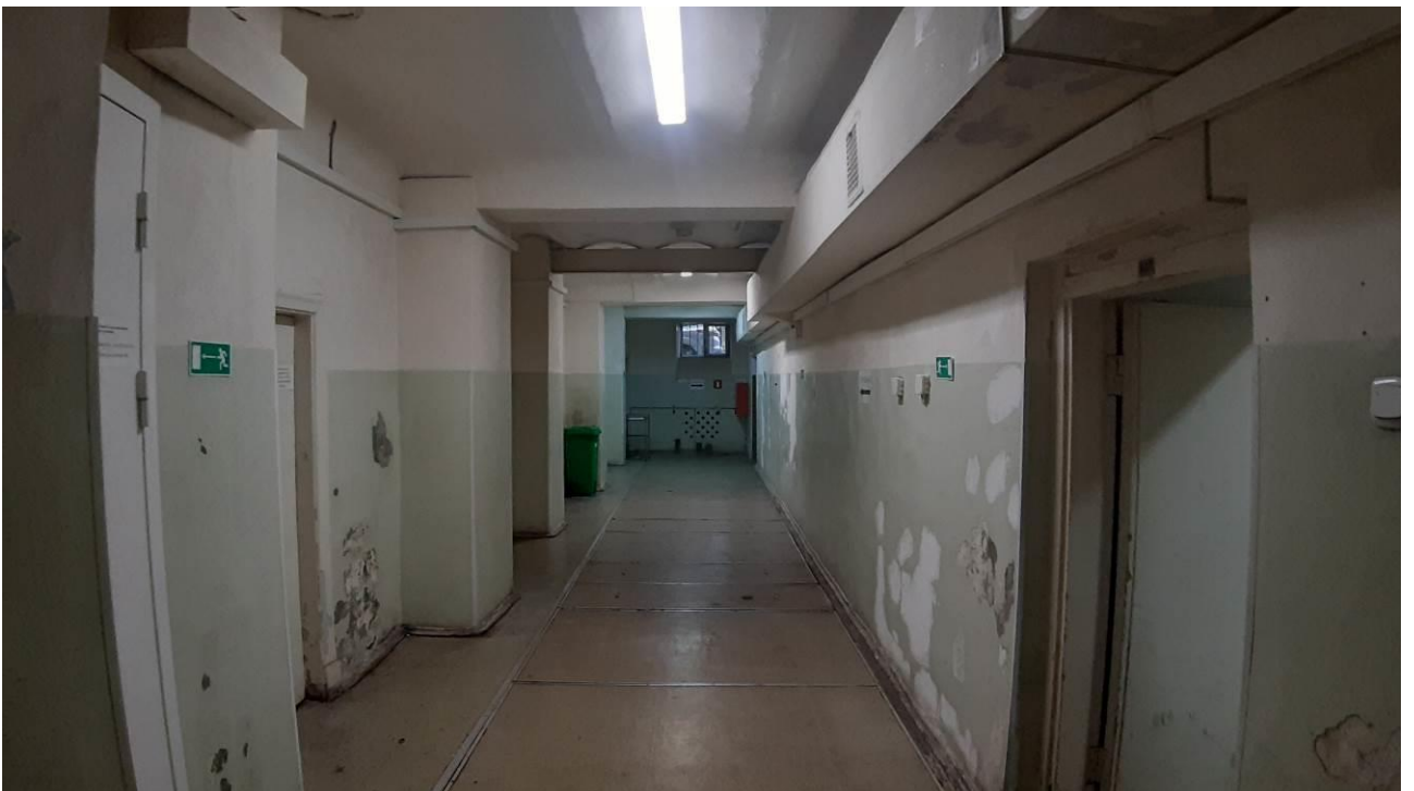
20. «Главный корпус Волковской богадельни». Помещения 1-го этажа. Штиглиц М.С. 23.10.2024.
