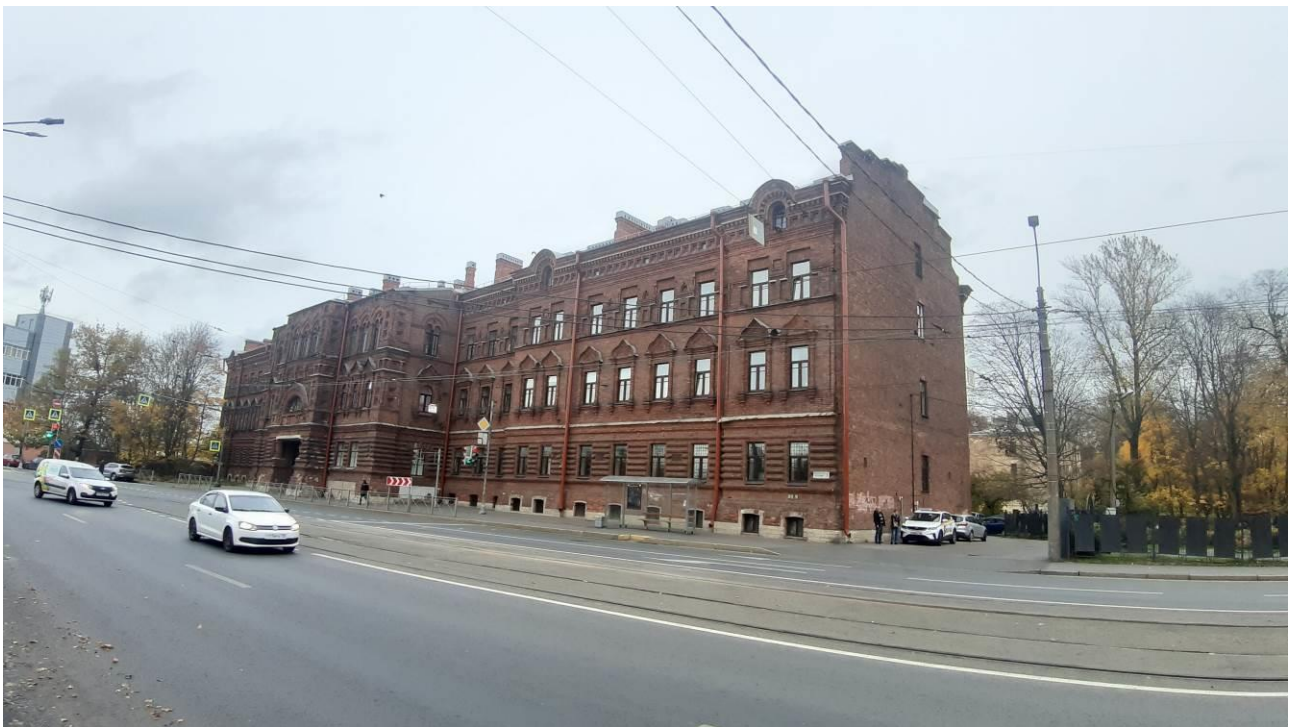
2. «Главный корпус Волковской богадельни». Лицевой фасад. Штиглиц М.С. 23.10.2024.
