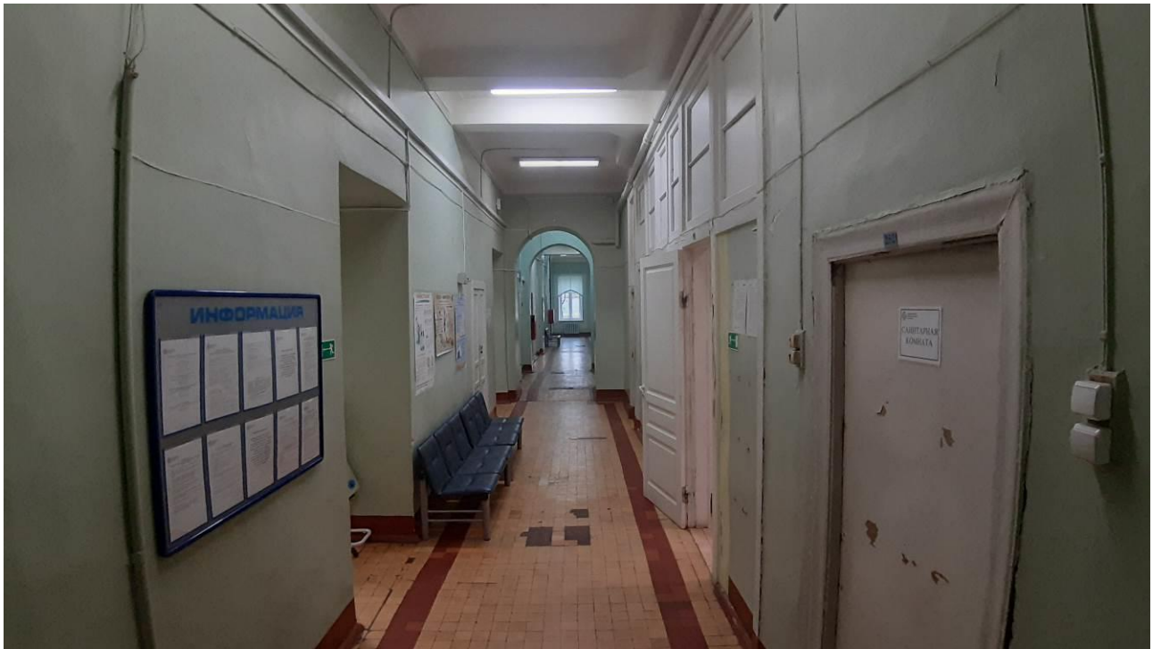
43. «Главный корпус Волковской богадельни». Помещения 2-го этажа. Штиглиц М.С. 23.10.2024.
