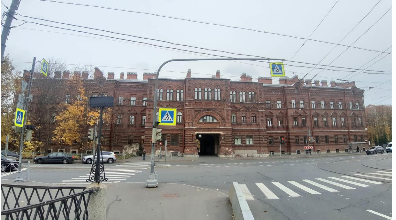
1. «Главный корпус Волковской богадельни». Лицевой фасад. Штиглиц М.С. 23.10.2024.
