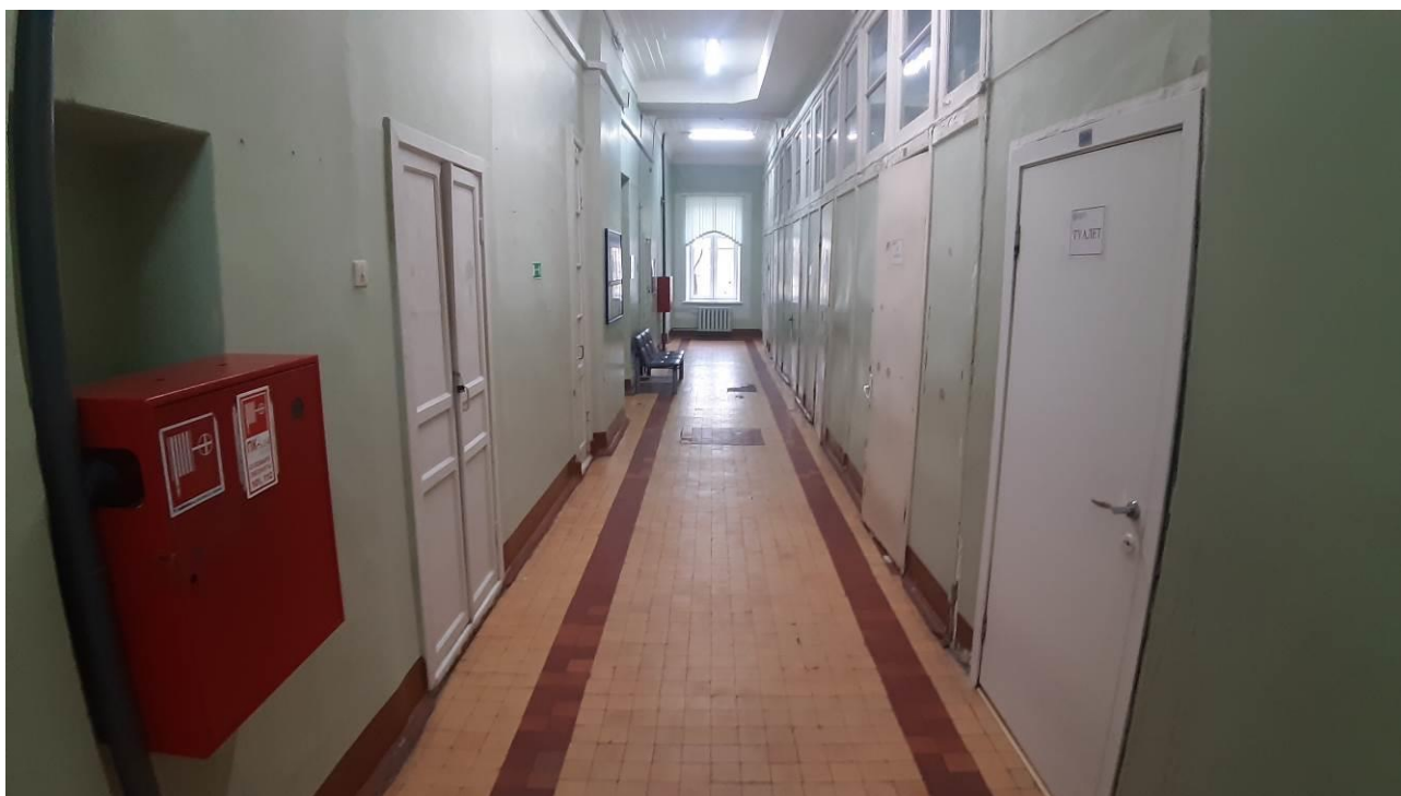
38. «Главный корпус Волковской богадельни». Помещения 2-го этажа. Штиглиц М.С. 23.10.2024.
