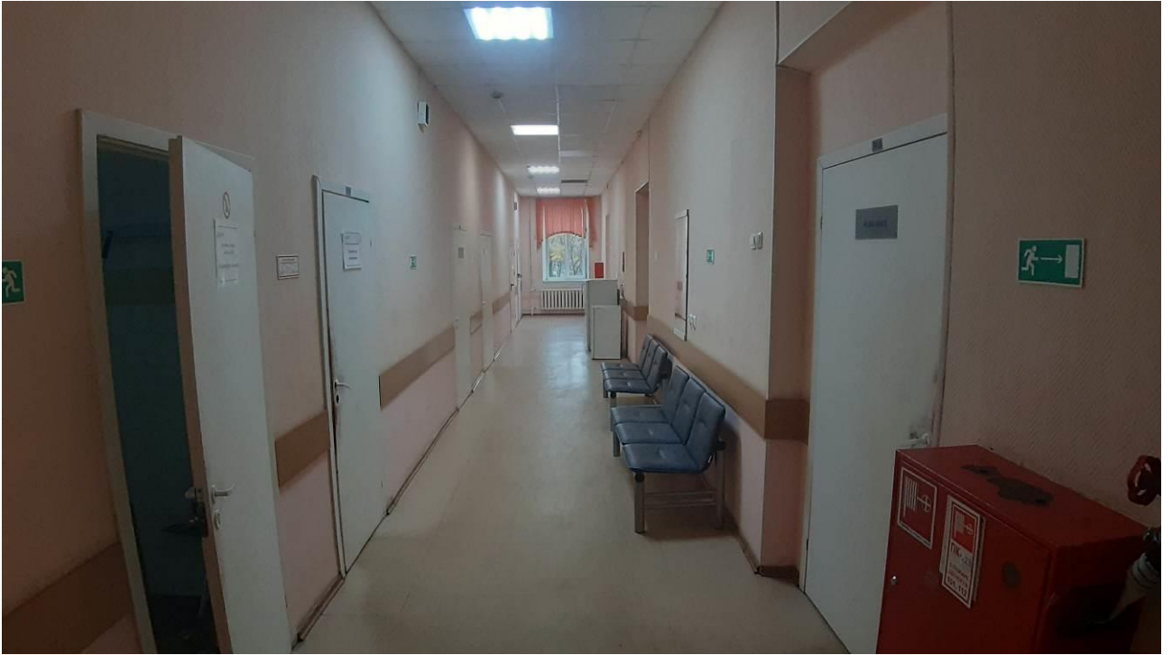
49. «Главный корпус Волковской богадельни». Помещения 3-го этажа. Штиглиц М.С. 23.10.2024.
