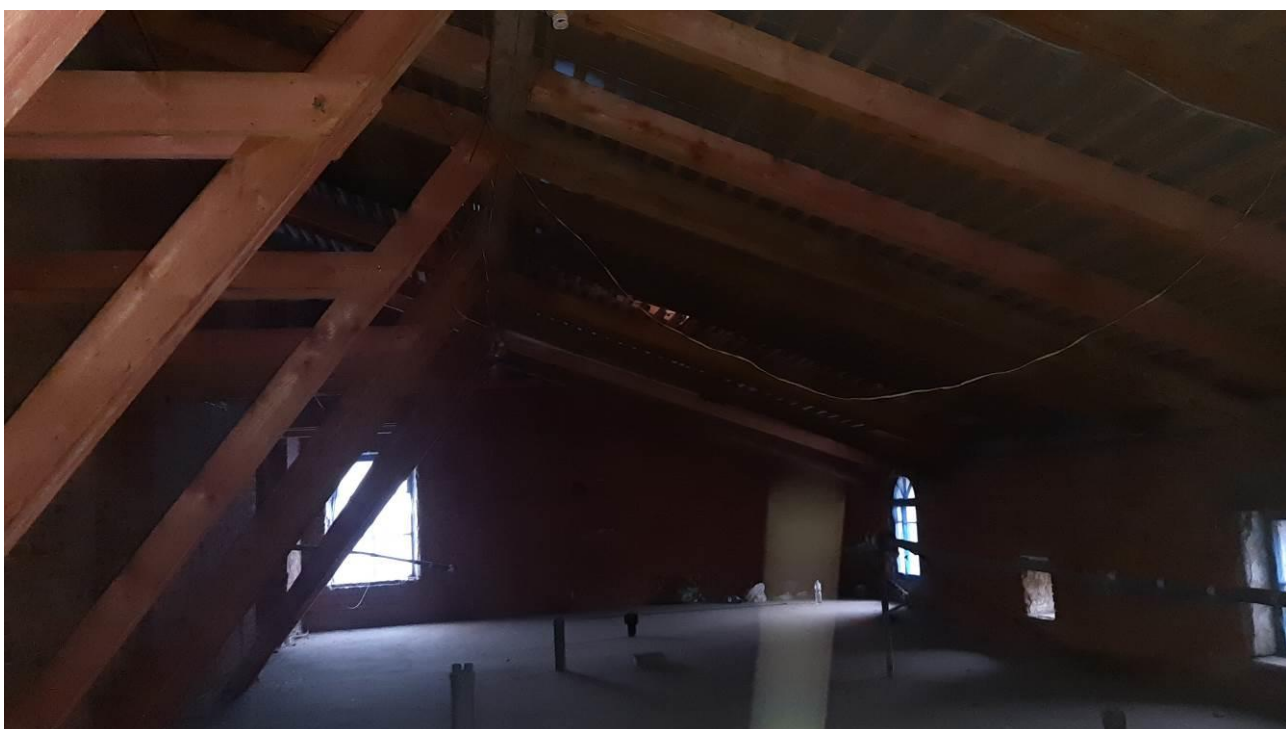
64. «Главный корпус Волковской богадельни». Чердак. Штиглиц М.С. 23.10.2024.
