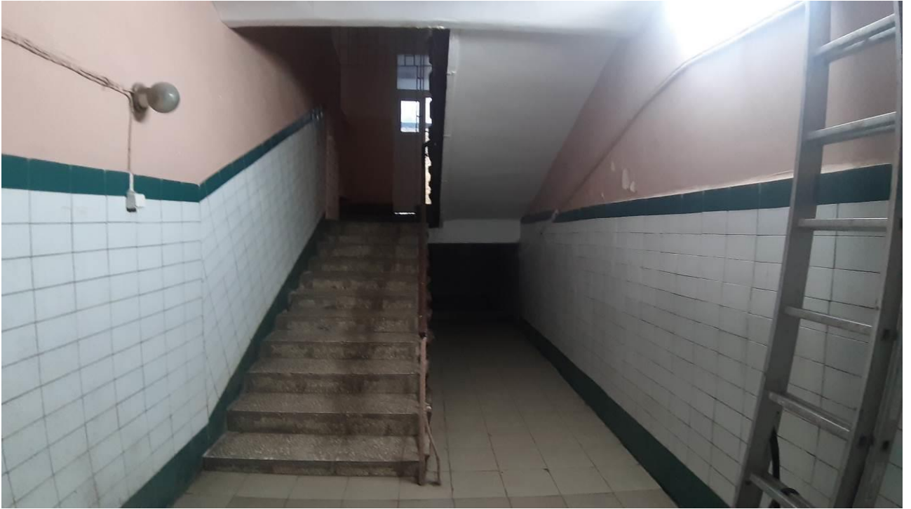
11. «Главный корпус Волковской богадельни». Подвальные помещения. Штиглиц М.С. 23.10.2024.
