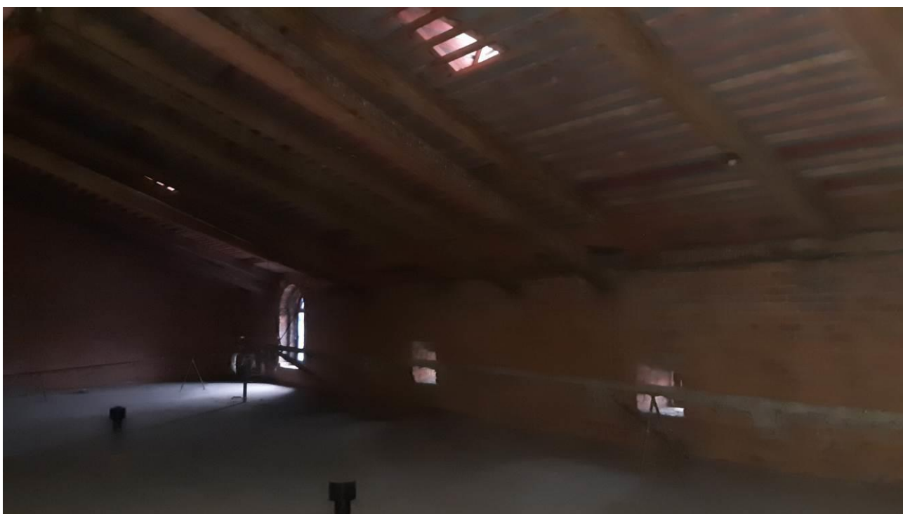
70. «Главный корпус Волковской богадельни». Чердак. Штиглиц М.С. 23.10.2024.
