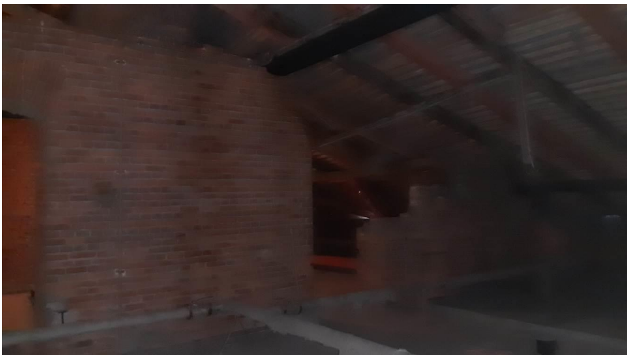
67. «Главный корпус Волковской богадельни». Чердак. Штиглиц М.С. 23.10.2024.
