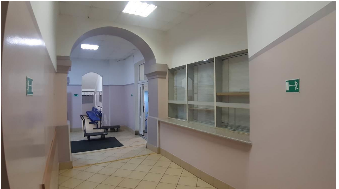
29. «Главный корпус Волковской богадельни». Помещения 1-го этажа. Штиглиц М.С. 23.10.2024.
