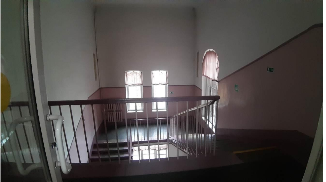
53. «Главный корпус Волковской богадельни». Помещения 3-го этажа. Штиглиц М.С. 23.10.2024.
