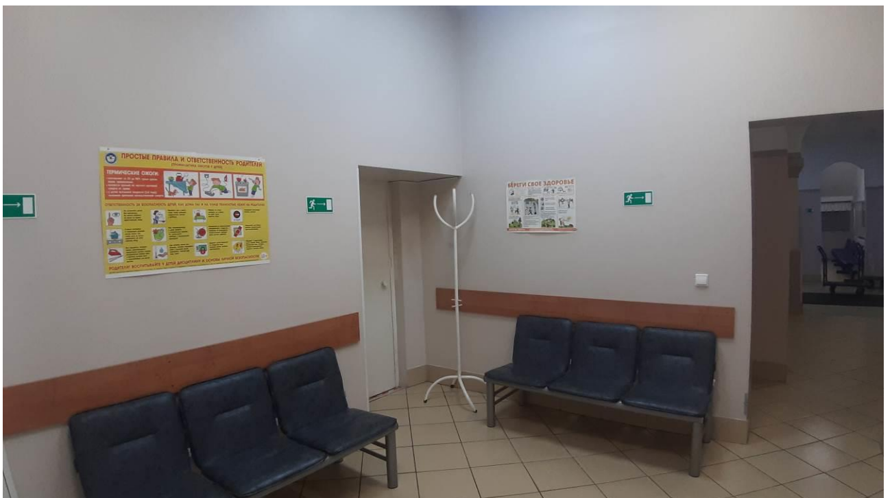
30. «Главный корпус Волковской богадельни». Помещения 1-го этажа. Штиглиц М.С. 23.10.2024.
