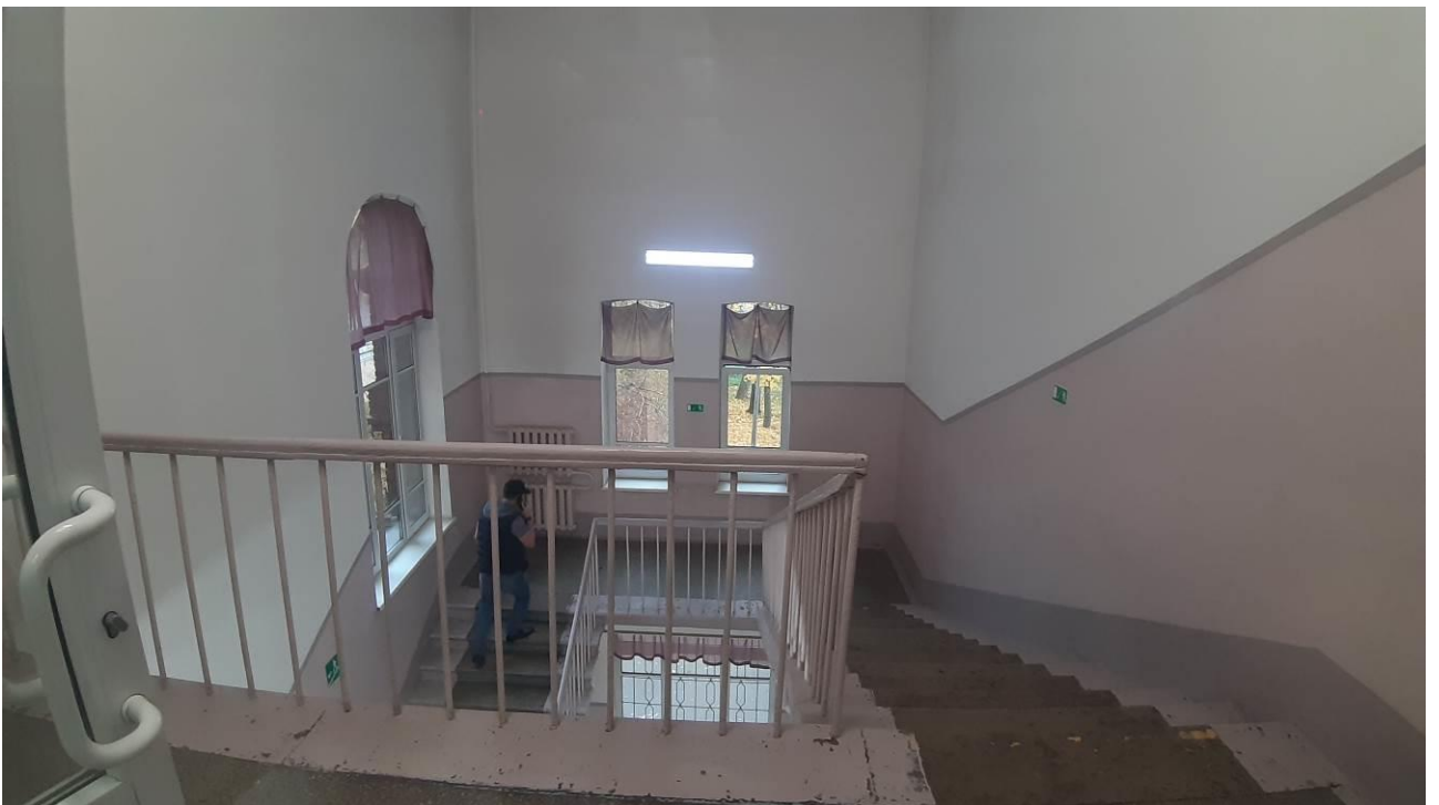
58. «Главный корпус Волковской богадельни». Помещения 3-го этажа. Штиглиц М.С. 23.10.2024.
