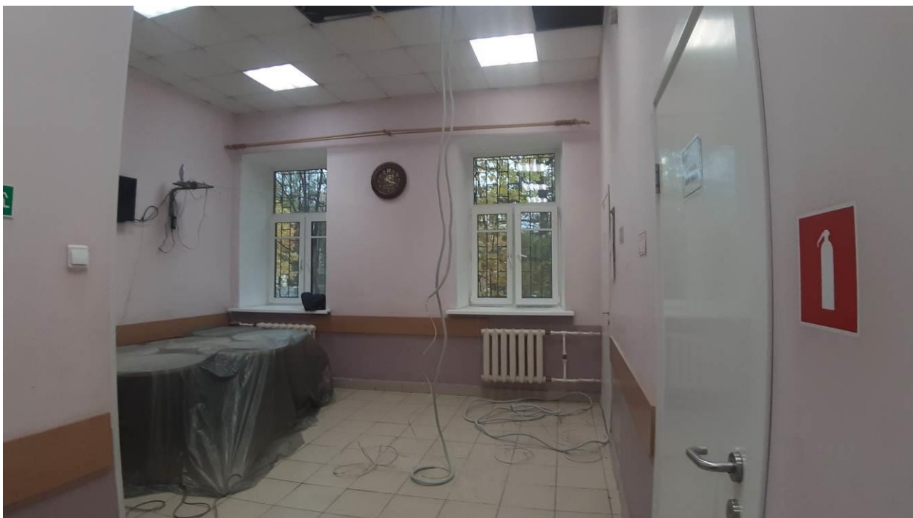
35. «Главный корпус Волковской богадельни». Помещения 1-го этажа. Штиглиц М.С. 23.10.2024.
