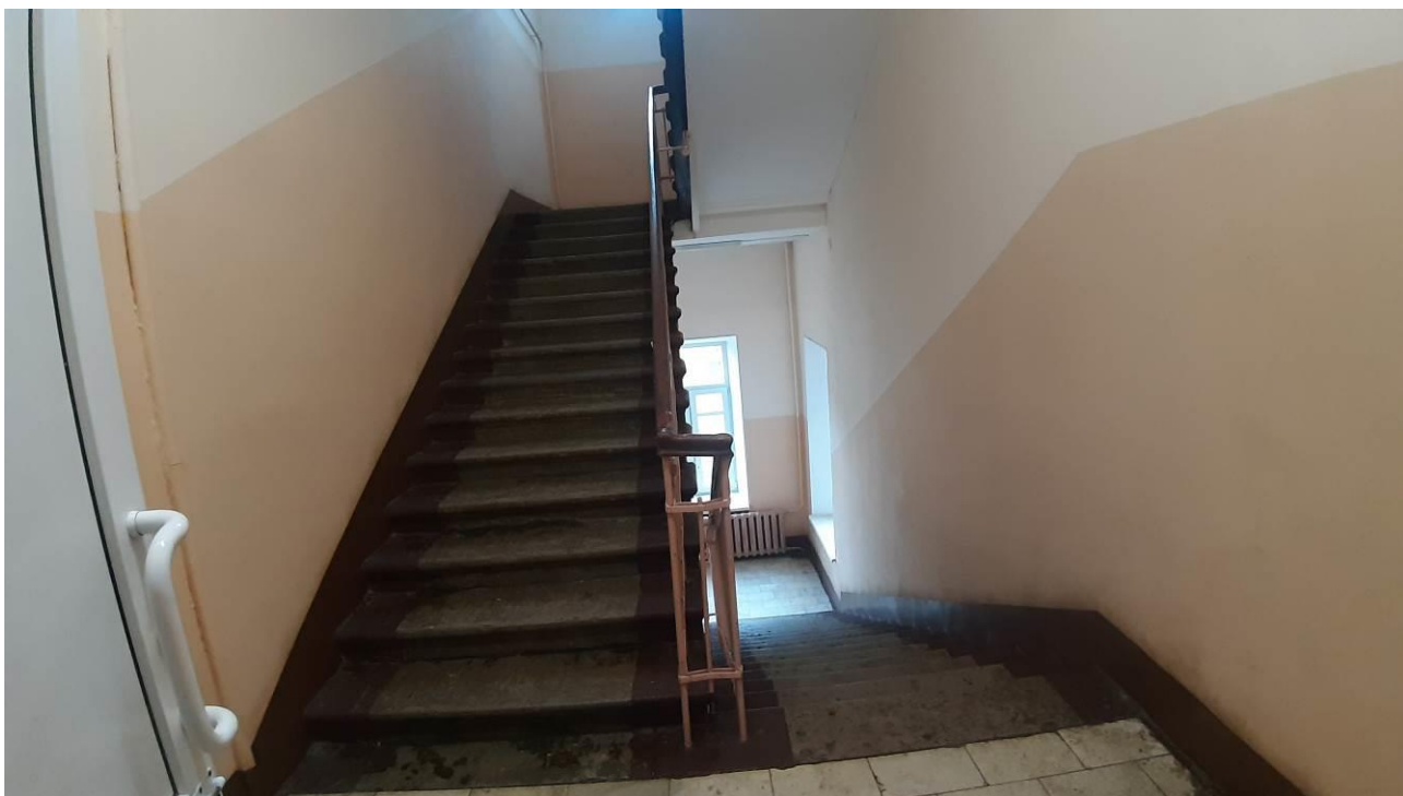
61. «Главный корпус Волковской богадельни». Помещения 3-го этажа. Штиглиц М.С. 23.10.2024.
