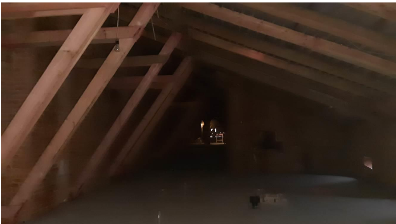
72. «Главный корпус Волковской богадельни». Чердак. Штиглиц М.С. 23.10.2024.
