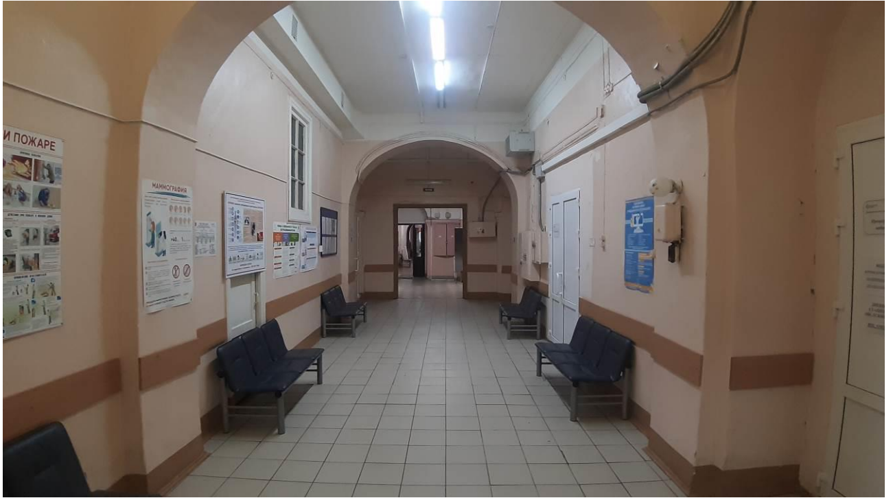
55. «Главный корпус Волковской богадельни». Помещения 3-го этажа. Штиглиц М.С. 23.10.2024.
