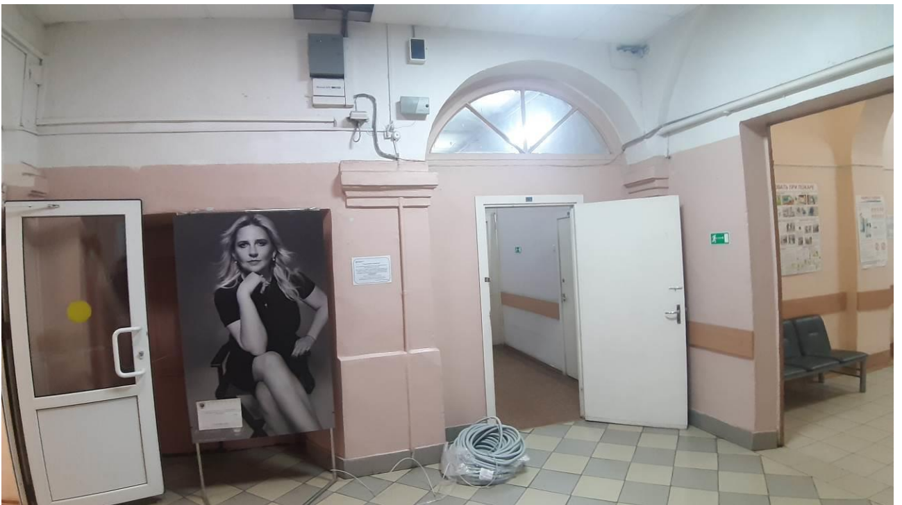
54. «Главный корпус Волковской богадельни». Помещения 3-го этажа. Штиглиц М.С. 23.10.2024.
