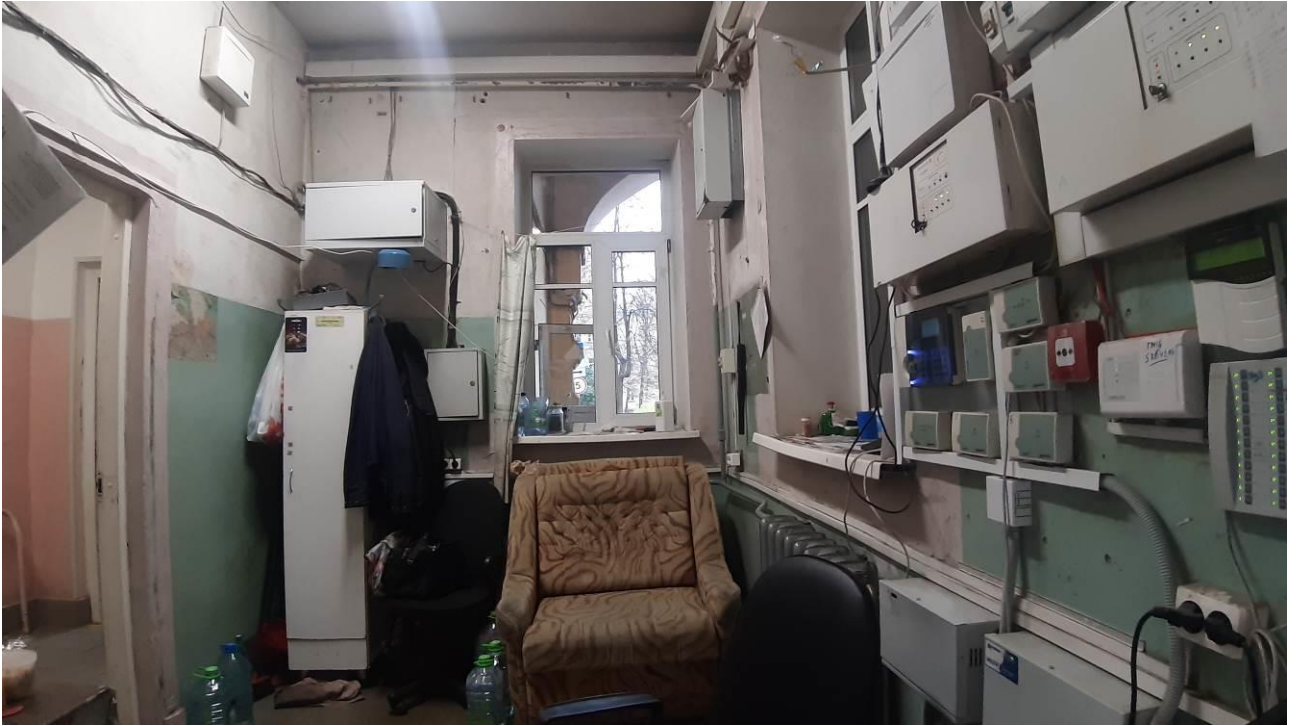
25. «Главный корпус Волковской богадельни». Помещения 1-го этажа. Штиглиц М.С. 23.10.2024.
