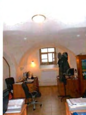
4. Свод цокольного этажа.
