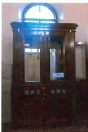
3. Тамбур главного входа.
