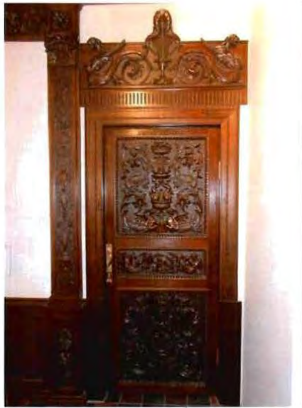
11. Одностворчатое дверное заполнение.
