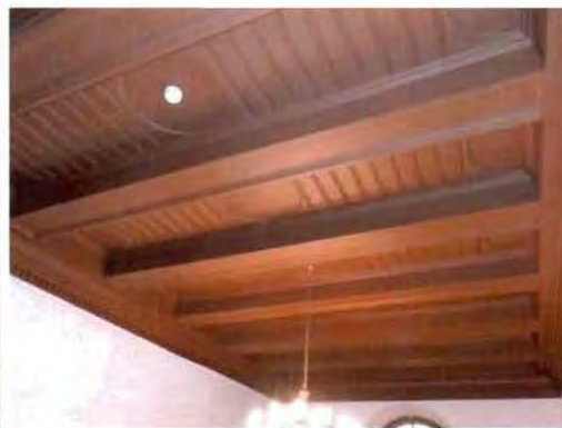
8. Оформление потолка над лестничной клеткой.
