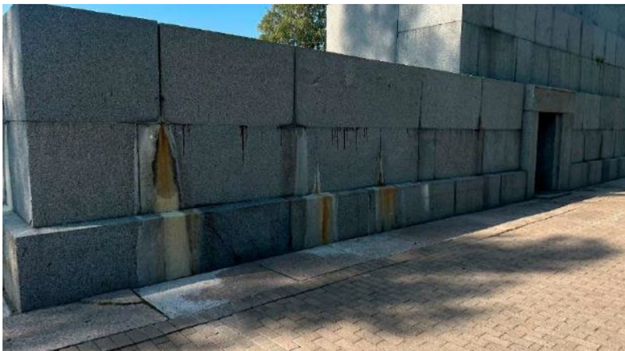
9. Вид с юго-востока на объект культурного наследия федерального значения «Братские могилы защитников и жителей г. Ленинграда, погибших во время блокады 1941-1944 гг.», расположенного по адресу: г. Санкт-Петербург, Серебряков переулок, д. 1, литера А. 26.08.2024
