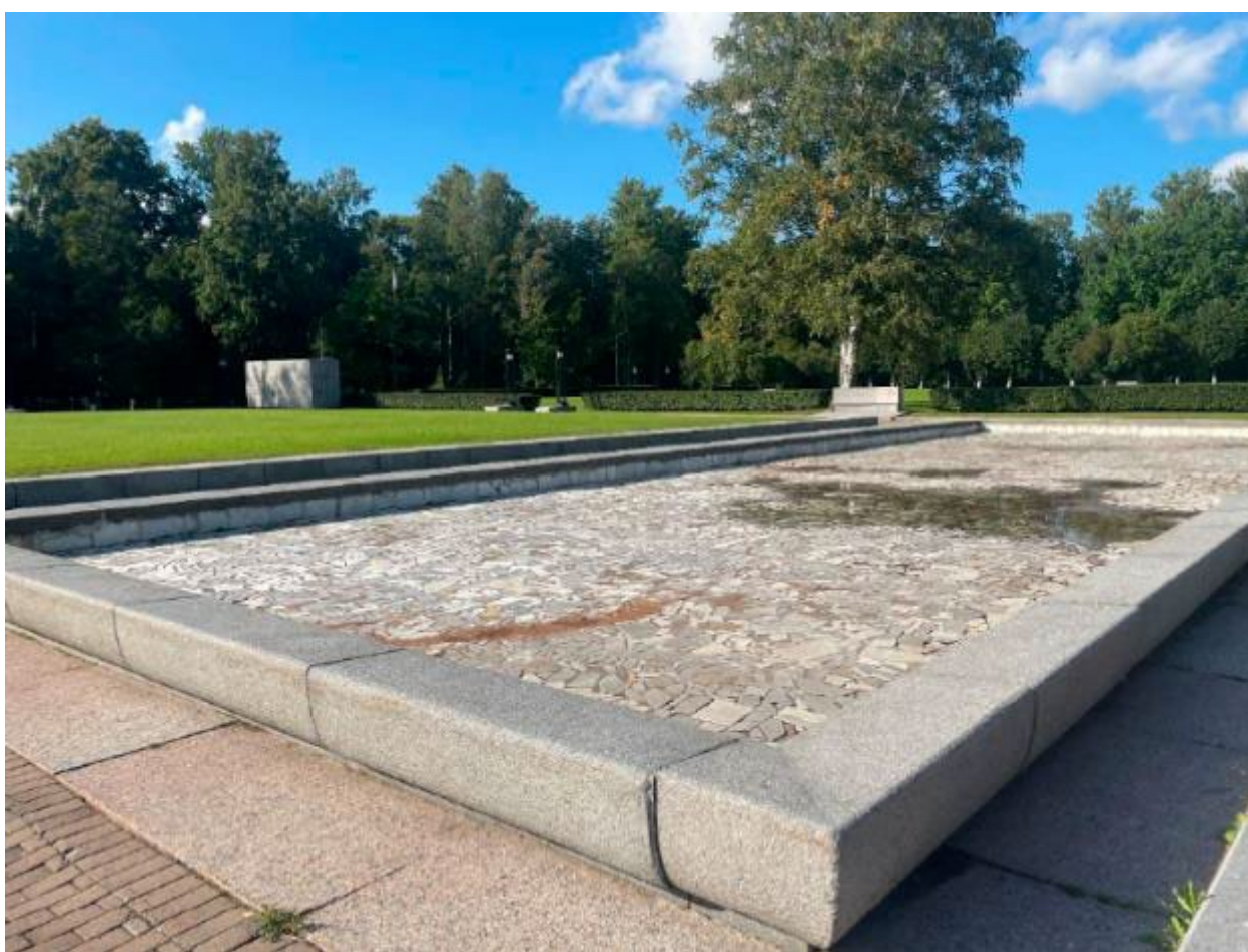
15. Вид с юго-востока на объект культурного наследия федерального значения «Братские могилы защитников и жителей г. Ленинграда, погибших во время блокады 1941-1944 гг.», расположенного по адресу: г. Санкт-Петербург, Серебряков переулок, д. 1, литера А. 26.08.2024
