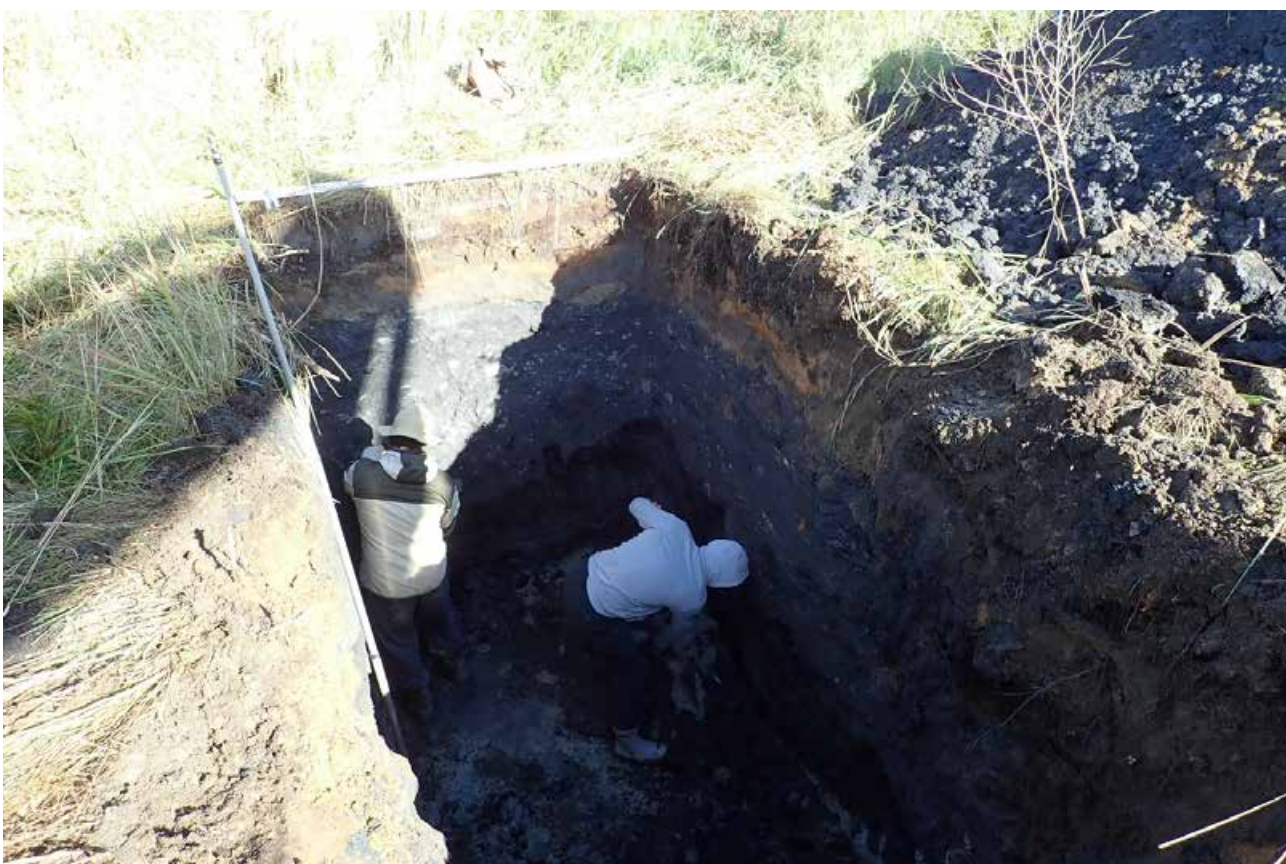
Рис. 19. Г. Санкт-Петербург, Пискаревский проспект, дом 144, литера А3 (кадастровый номер: 78:11:0005607:52). Шурф 5. Обрушение в северо-западной части шурфа из-за стока грунтовых вод. Зачистка по выходу материкового грунта. Рабочий момент. Вид с ЮЗ.
