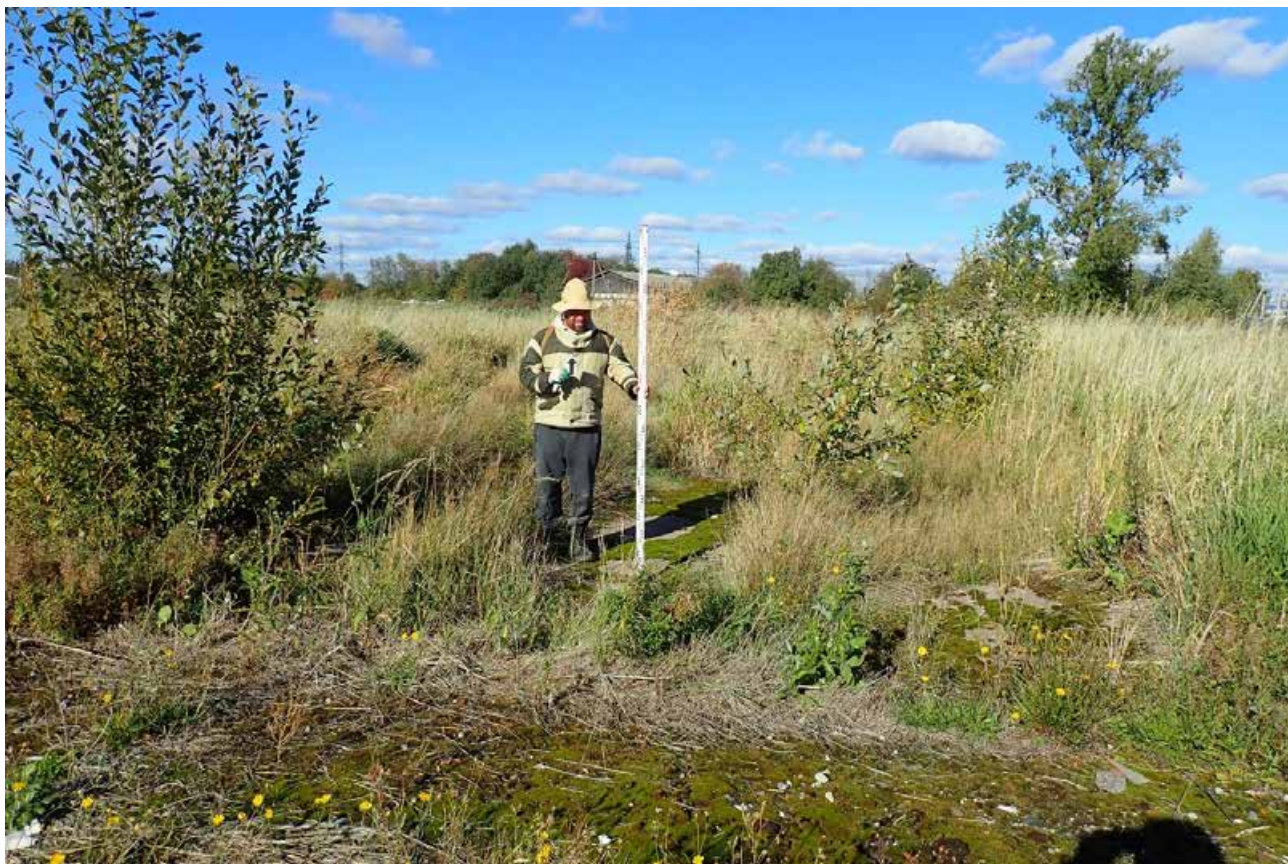
Рис. 30. Г. Санкт-Петербург, Пискаревский проспект, дом 144, литера АЗ (кадастровый номер: 78:11:0005607:52). Точка фотофиксации 4. Вымостка армированными бетонными плитами в юго-восточной части участка. Вид с Ю.
