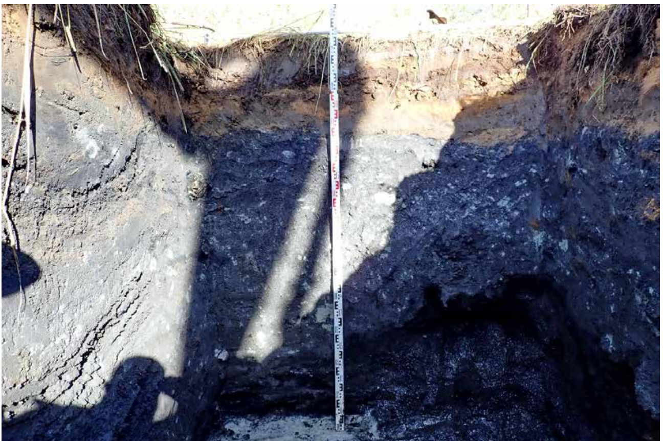
Рис. 76. Г. Санкт-Петербург, Пискаревский проспект, дом 144, литера А3 (кадастровый номер: 78:11:0005607:52). Шурф 5. Северная стенка. Вид с Ю.
