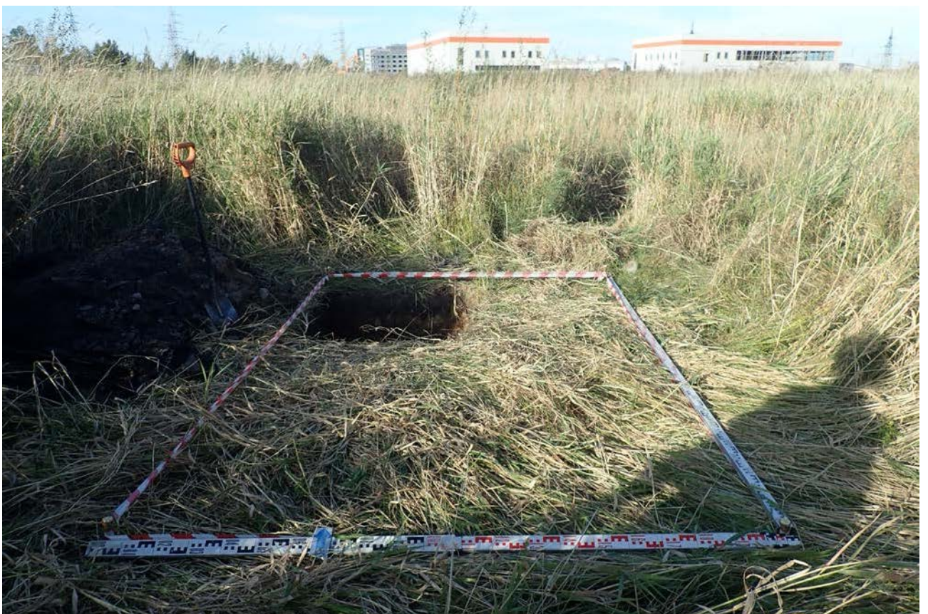
Рис. 44. Г. Санкт-Петербург, Пискаревский проспект, дом 144, литера А3 (кадастровый номер: 78:11:0005607:52). Шурф 1. Расширение шурфа до размеров 2х3 м. Вид с Ю.
