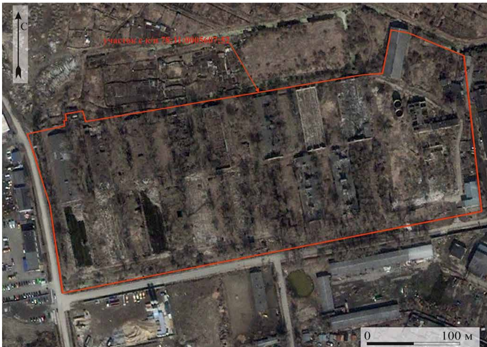
Рис. 12. г. Санкт-Петербург, Пискаревский проспект, дом 144, литера АЗ (кадастровый номер: 78:11:0005607:52). Общий вид обследованного участка на масштабированном спутниковом снимке 2013 года. Используются данные электронного ресурса Google Earth. Дата обращения: 10 сентября 2024 г.
