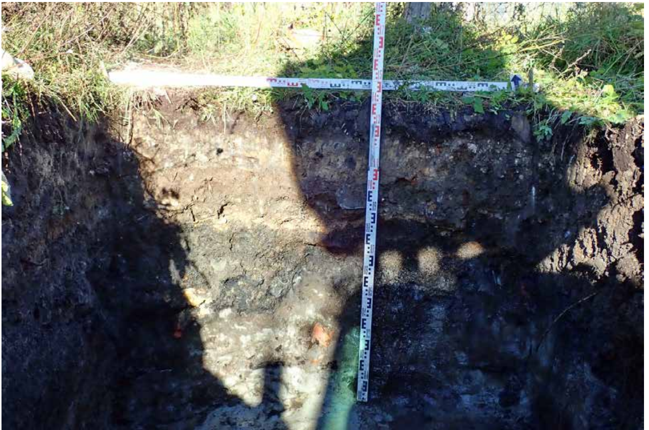
Рис. 93. Г. Санкт-Петербург, Пискаревский проспект, дом 144, литера А3 (кадастровый номер: 78:11:0005607:52). Шурф 8. Северная стенка. Вид с Ю.
