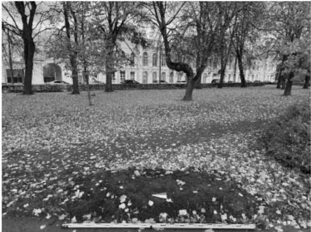
Илл. 139. г. Санкт-Петербург, г. Петергоф, сквер Знаменова – 2024 г. Шурф №8. Засыпка. Вид с З.
