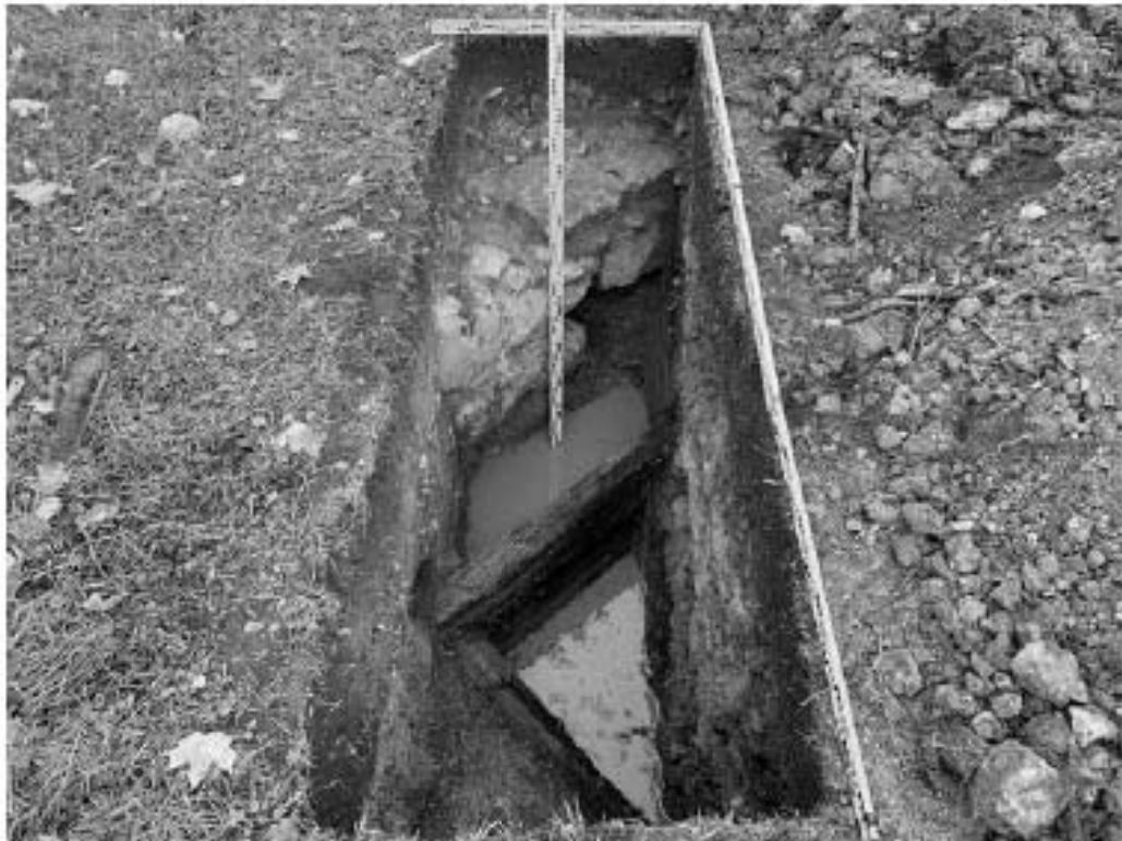
Илл. 179. г. Санкт-Петербург, г. Петергоф, сквер Знаменова – 2024 г. Шурф №13. Фиксация на уровне активного поступления грунтовых вод. Вид с ЮВ.
