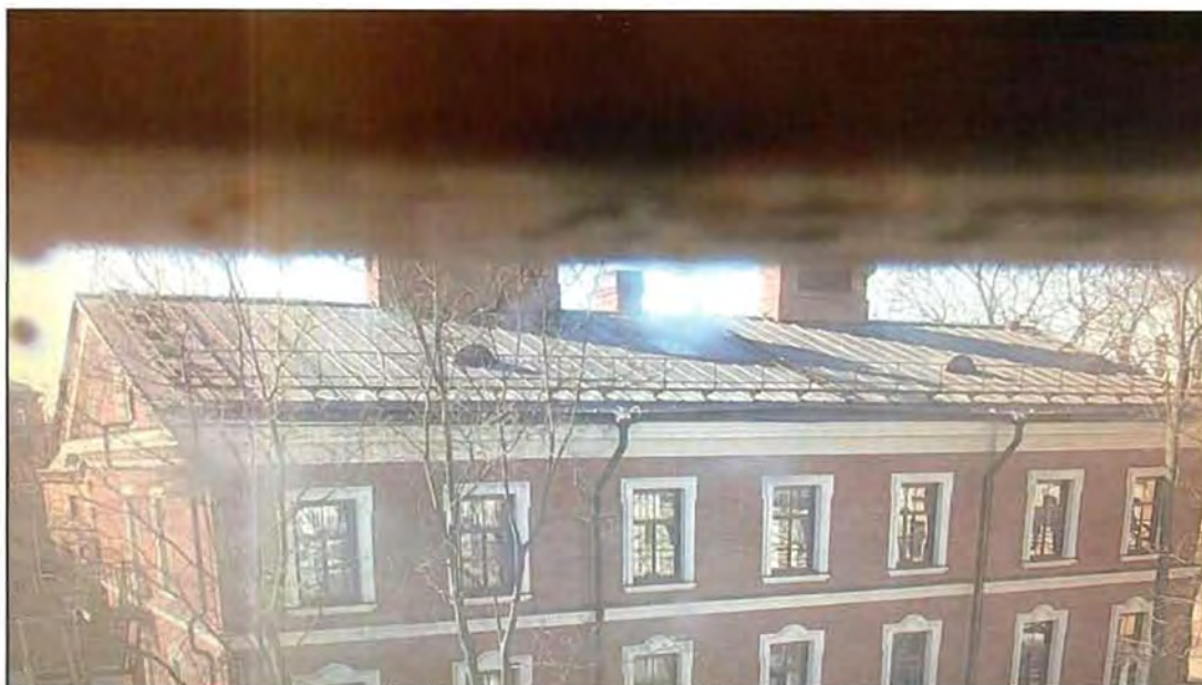
5. Кровля объекта культурного наследия.
