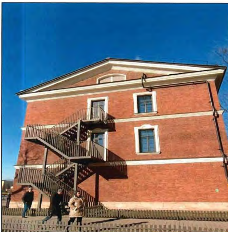
3. Восточный фасад объекта культурного наследия
