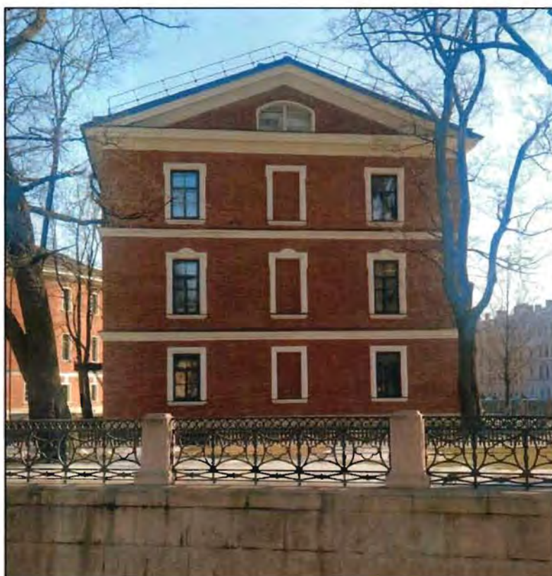
4. Западный фасад объекта культурного наследия.
