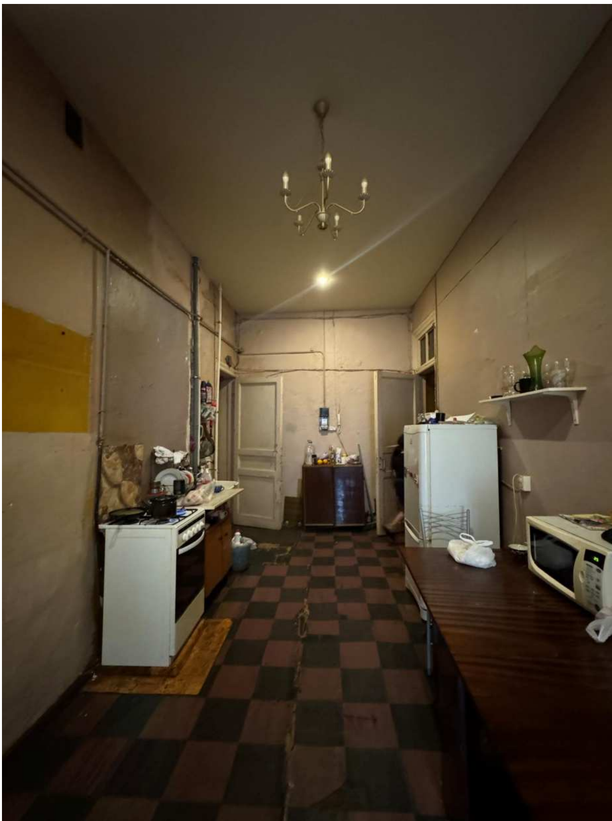
Фото 19. Вид на помещение квартиры № 47 объекта культурного наследия.
