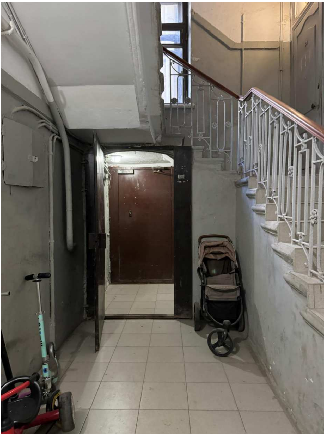
Фото 10. Вид на интерьер лестницы, ведущей к квартире № 47, объекта культурного наследия.
