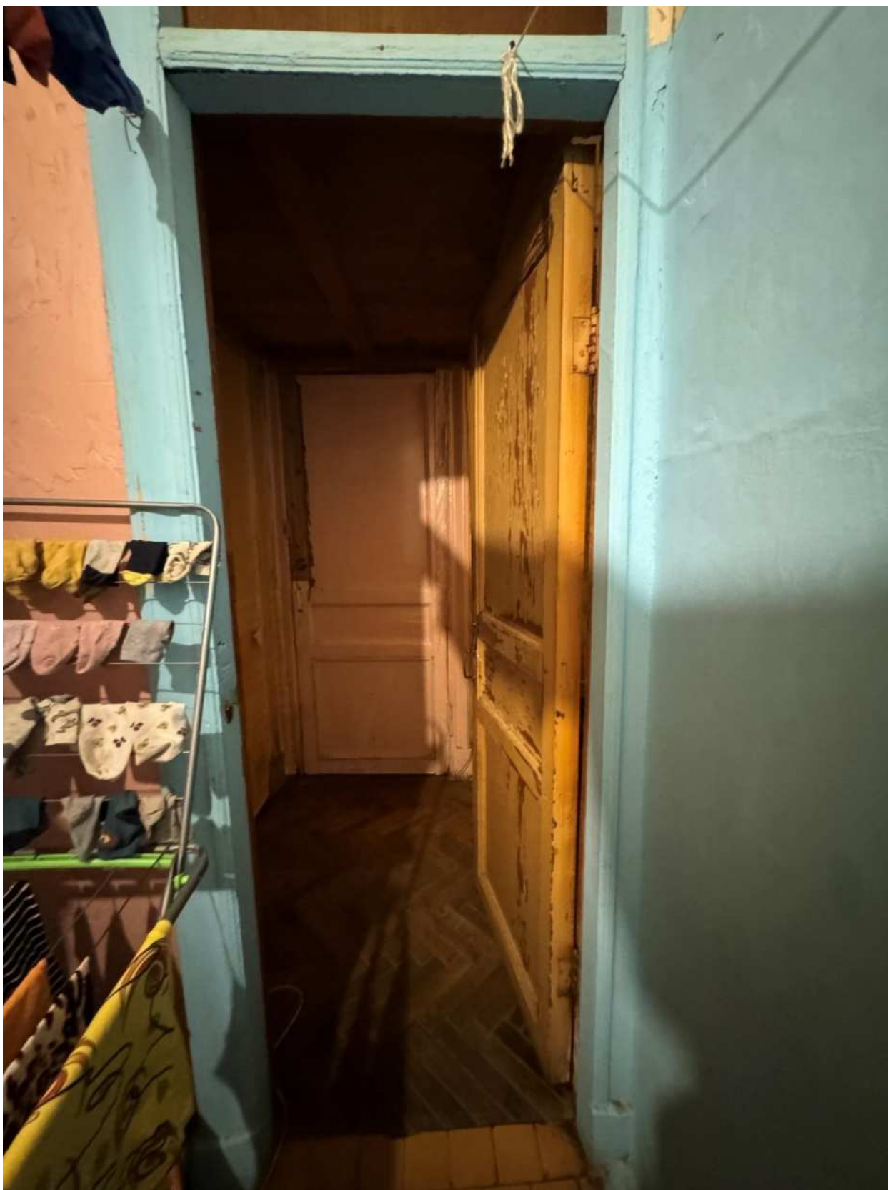
Фото 34. Вид на помещение квартиры № 47 объекта культурного наследия.
