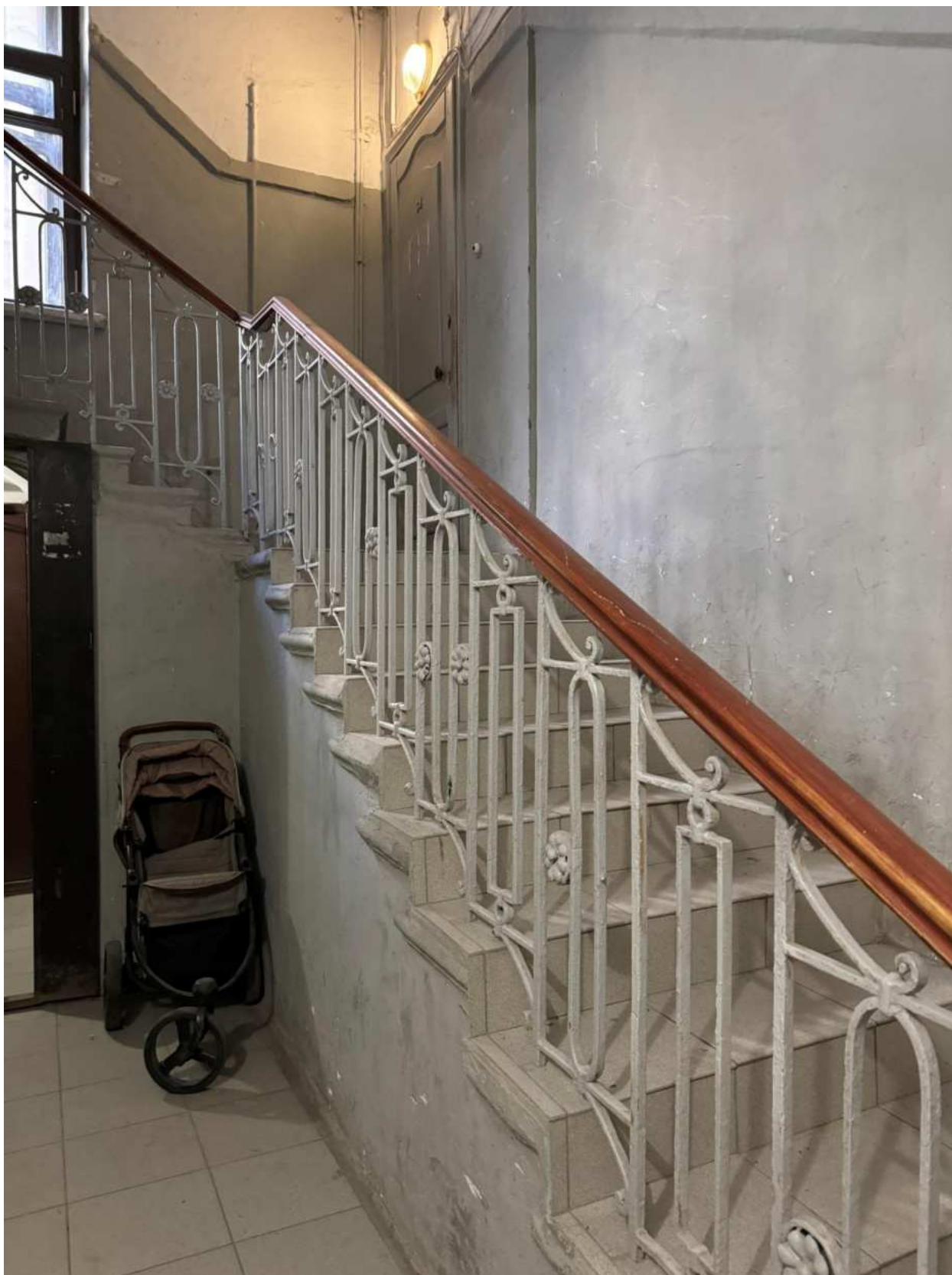
Фото 11. Вид на интерьер лестницы, ведущей к квартире № 47, объекта культурного наследия.
