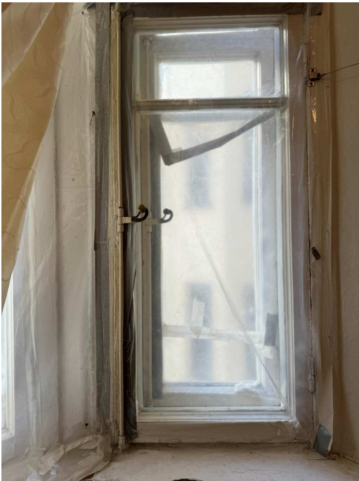
Фото 26. Вид на оконное заполнение квартиры № 47 объекта культурного наследия.
