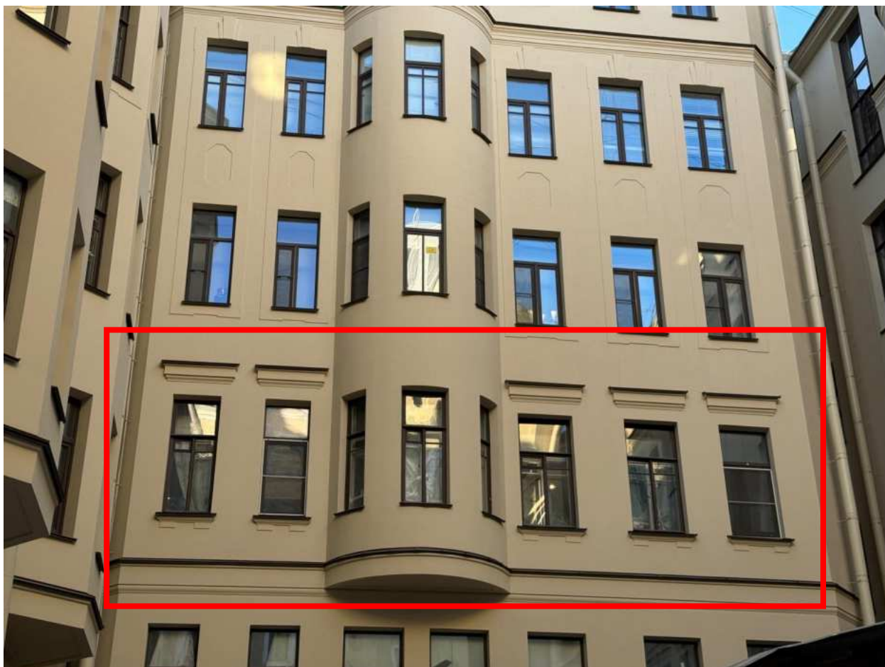
Фото 6. Фрагмент западного дворового фасада объекта культурного наследия.
