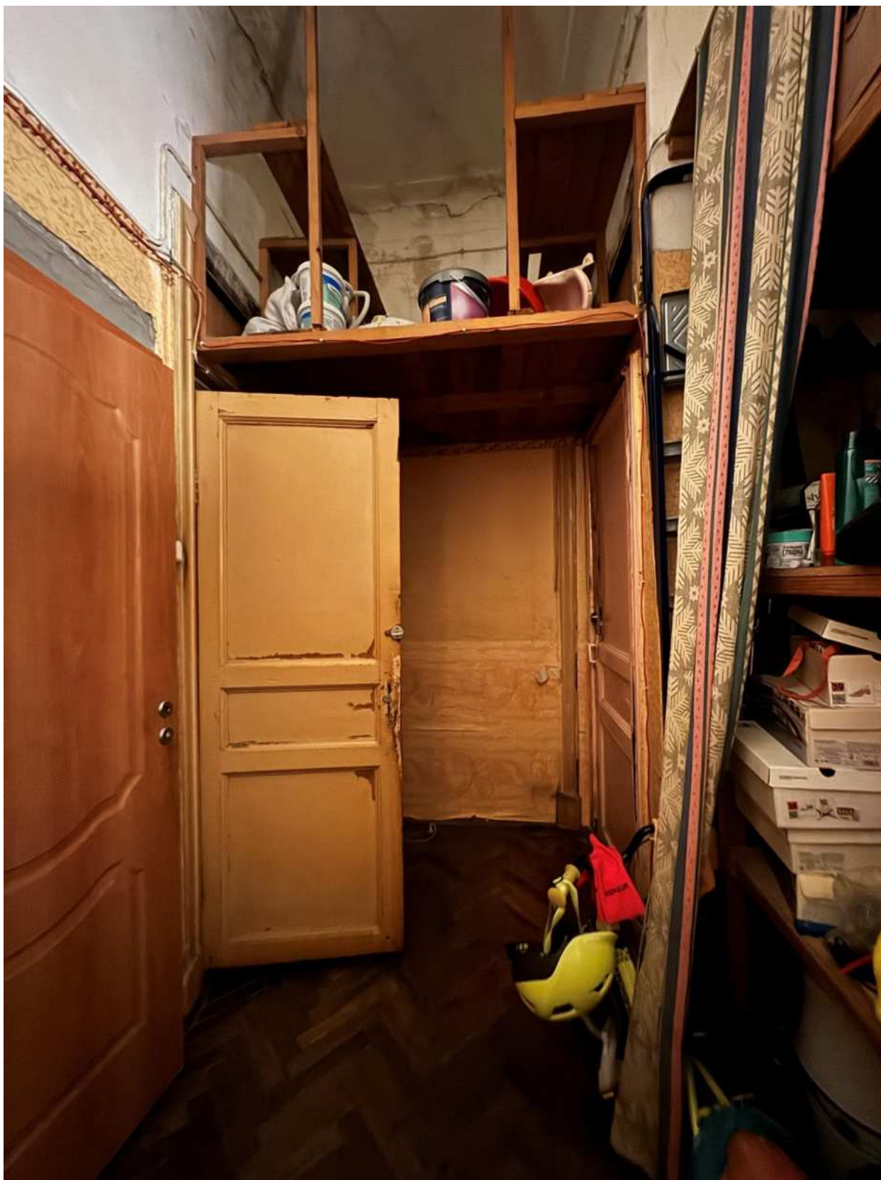
Фото 29. Вид на покрытие пола квартиры № 47 объекта культурного наследия.
