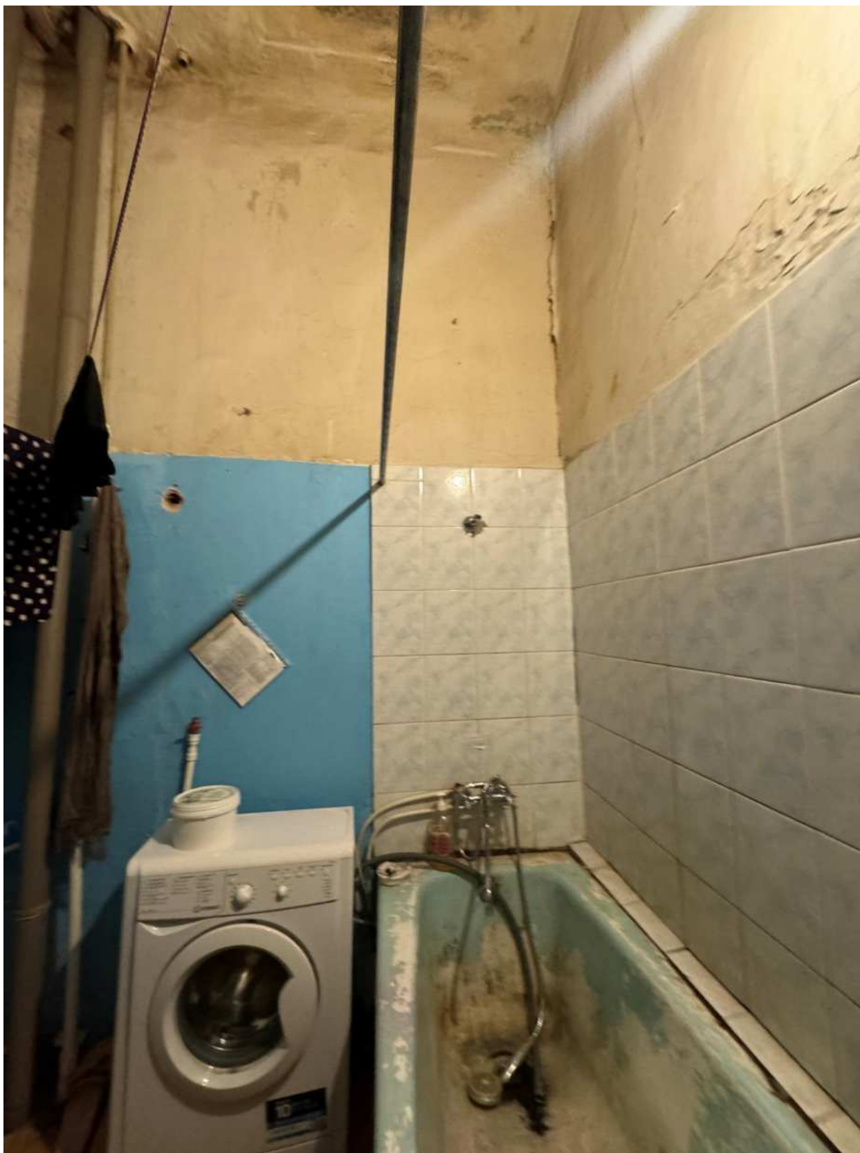
Фото 33. Вид на помещение квартиры № 47 объекта культурного наследия.
