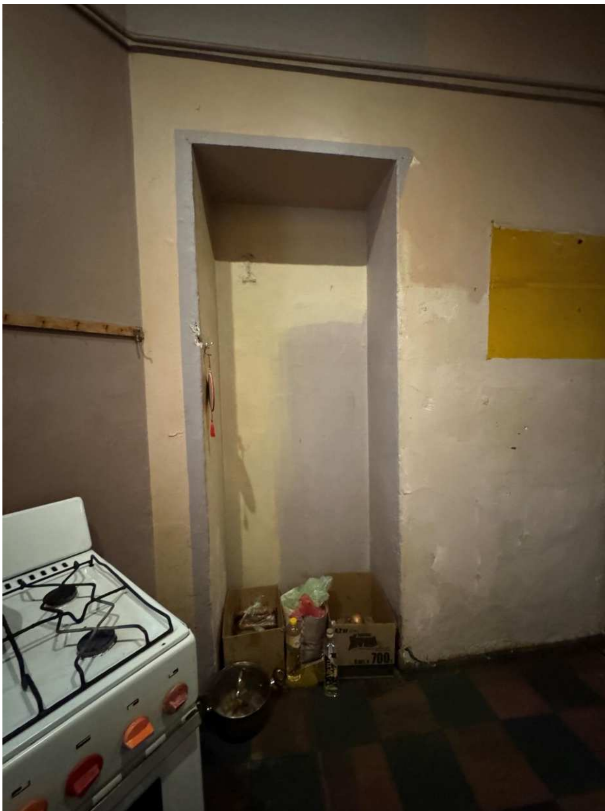
Фото 18. Вид на помещение квартиры № 47 объекта культурного наследия.
