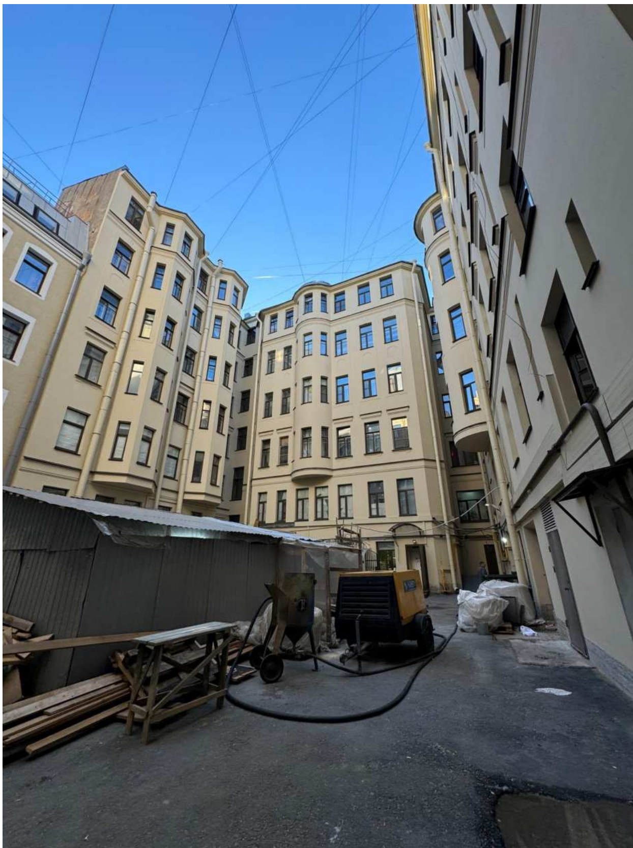
Фото 5. Общий вид дворовых фасадов объекта культурного наследия.
