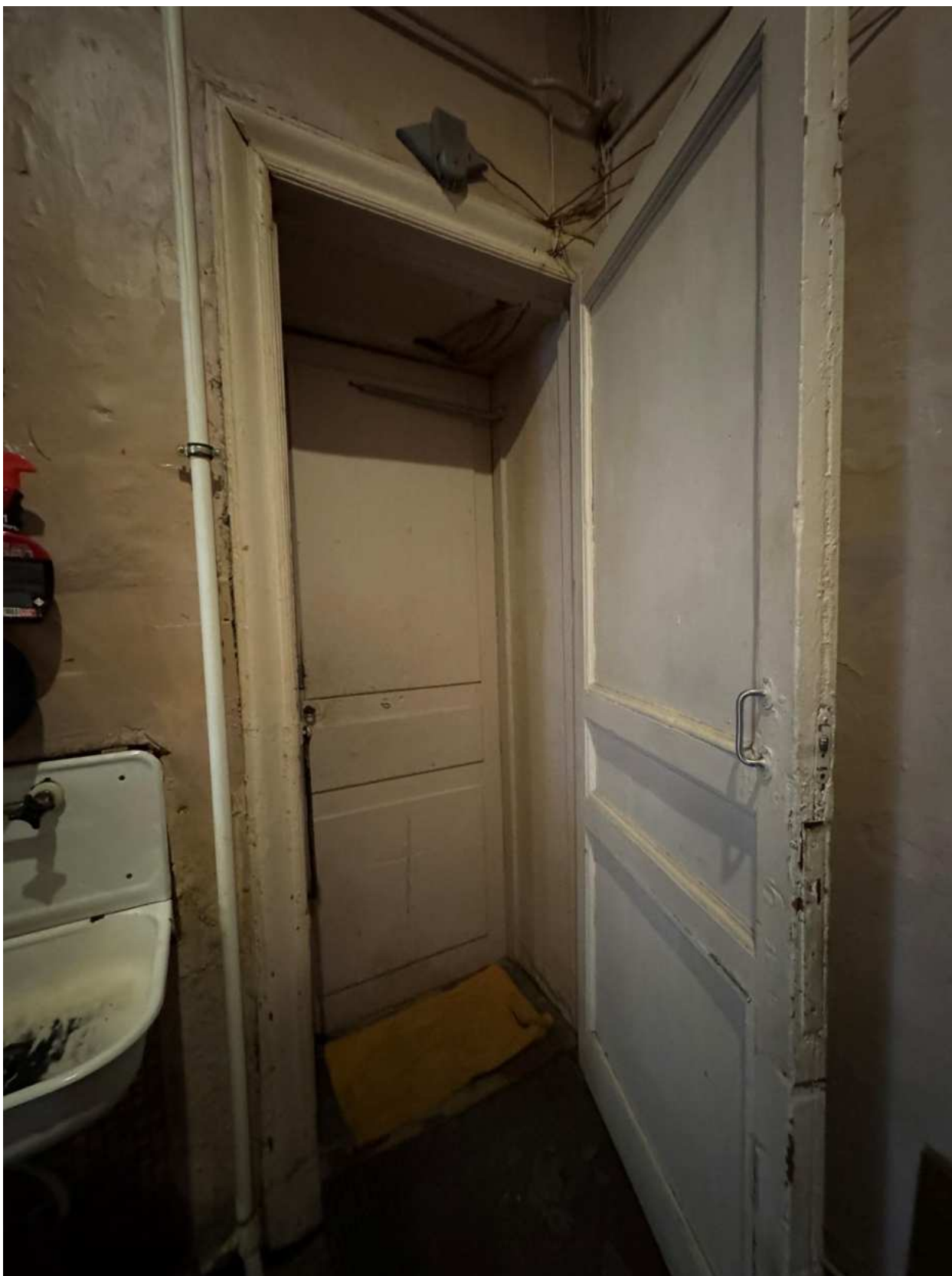
Фото 16. Вид на входное дверное заполнение квартиры № 47 объекта культурного наследия.
