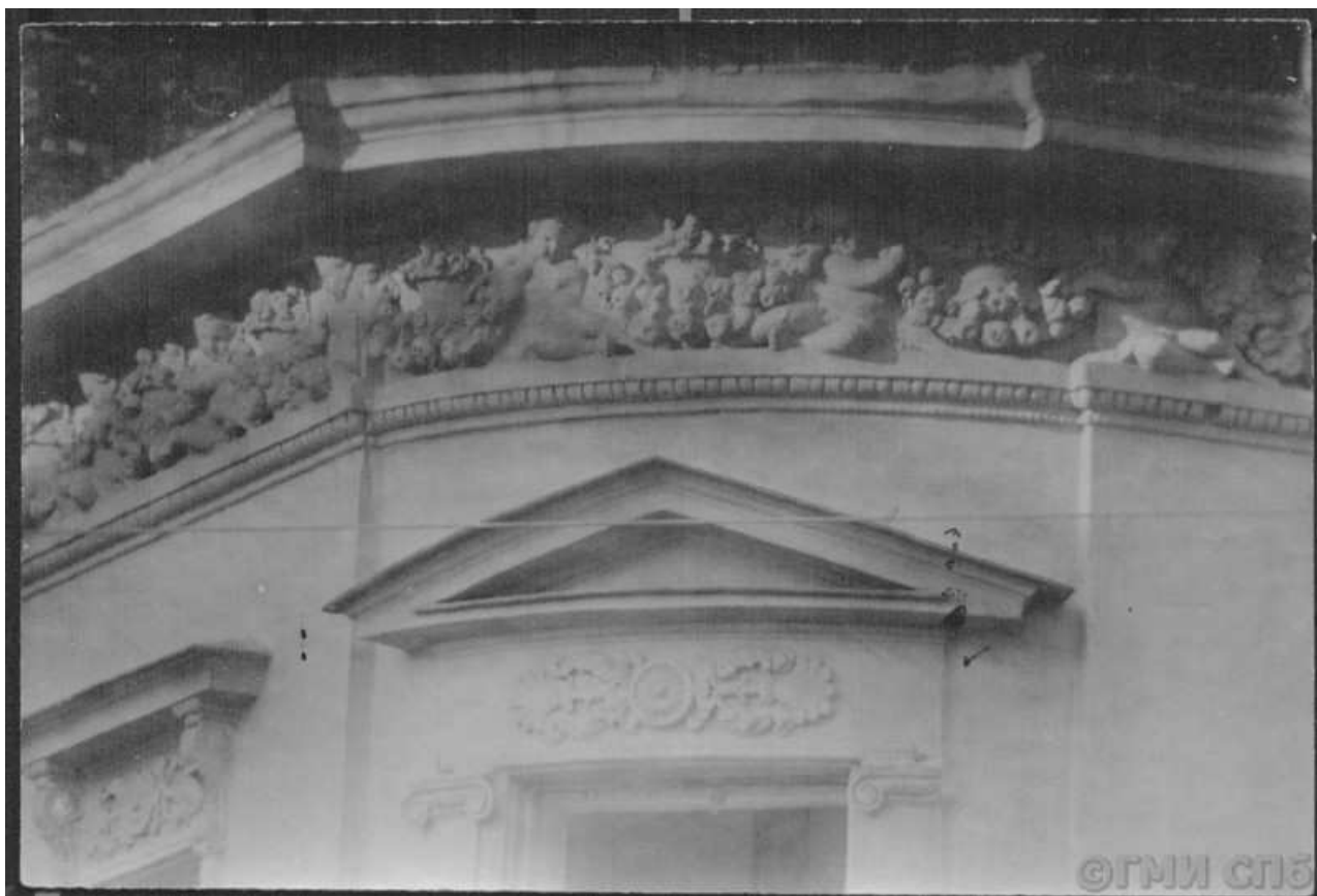
27. Фриз дома на углу Знаменской и Кирочной улиц (Знаменская ул., 46 / Кирочная ул., 19), 1913 г. – Госкаталог РФ. Инв. №: ГМИ СПб Инв.№-II-A-10027 ф
