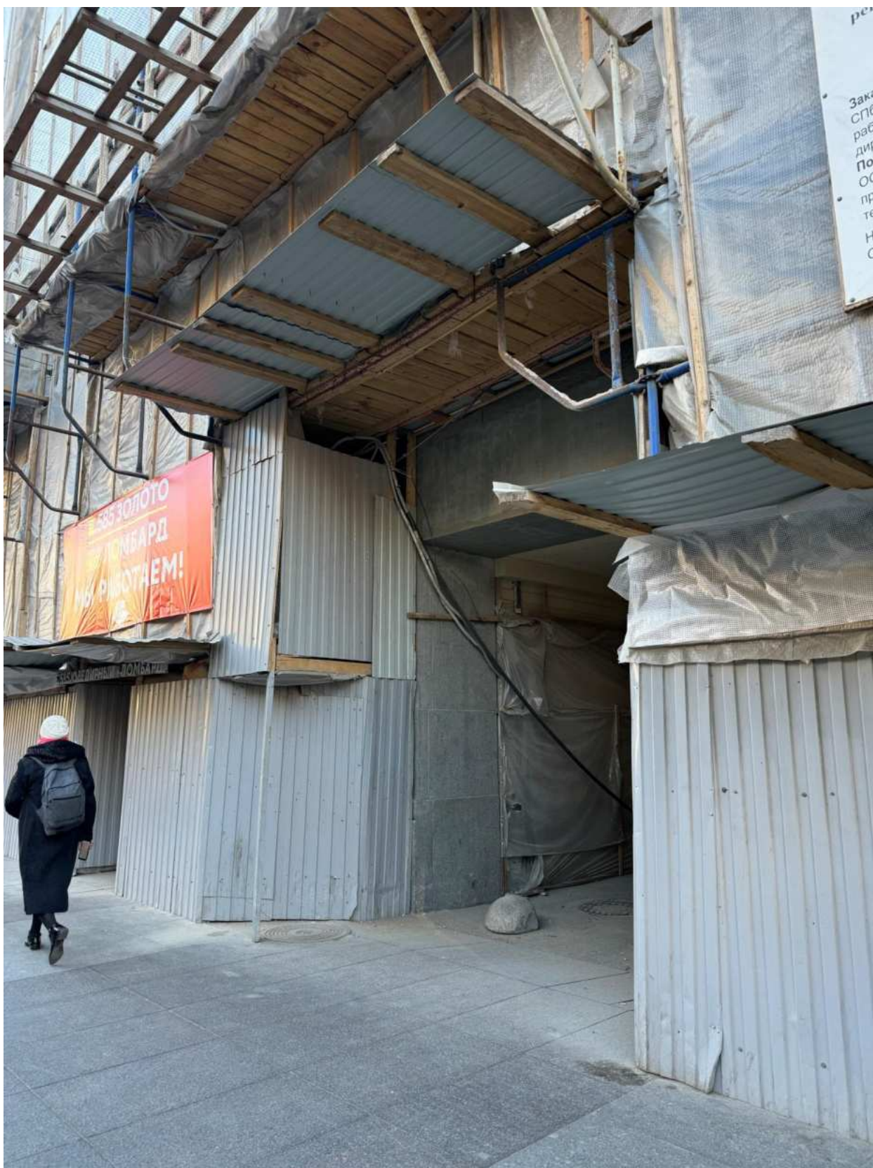
Фото 2. Фрагмент фасада объекта культурного наследия по Кирочной улице.
