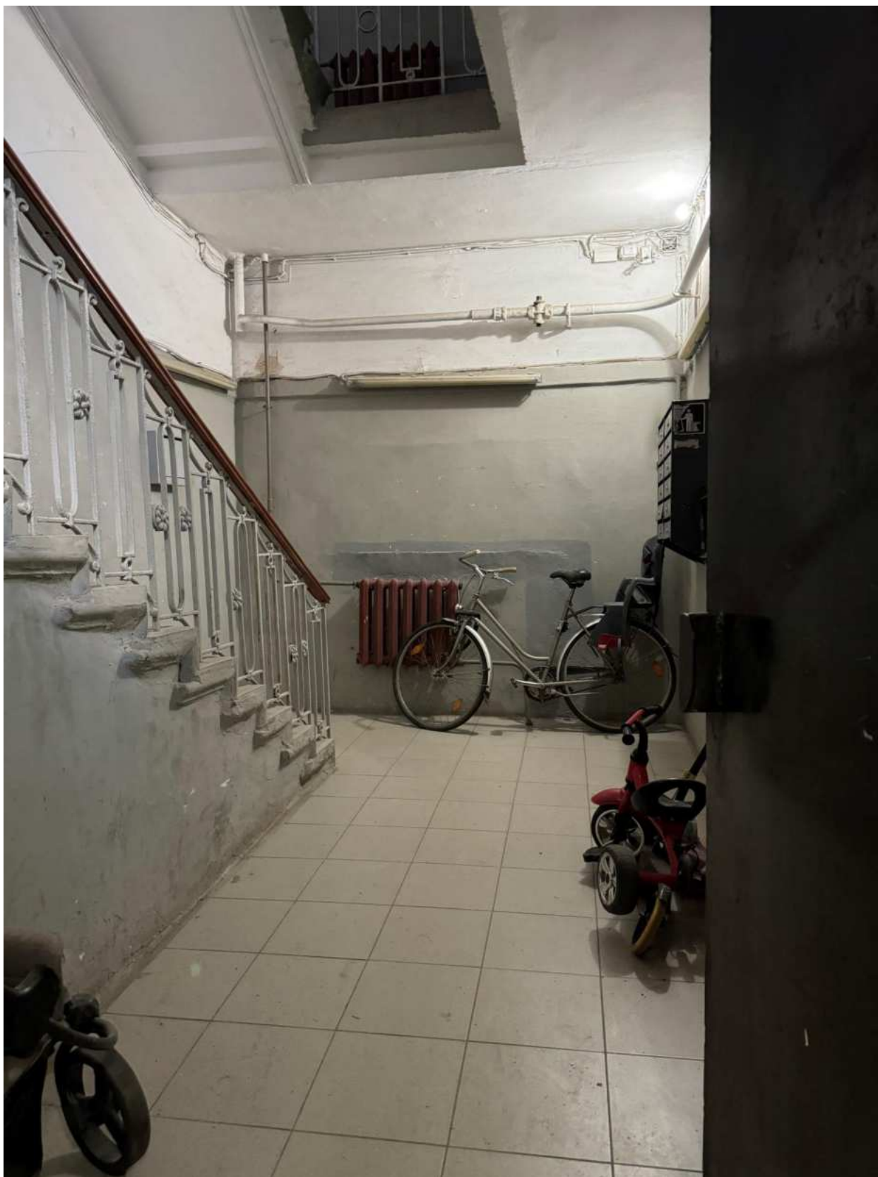
Фото 9. Вид на интерьер лестницы, ведущей к квартире № 47, объекта культурного наследия.
