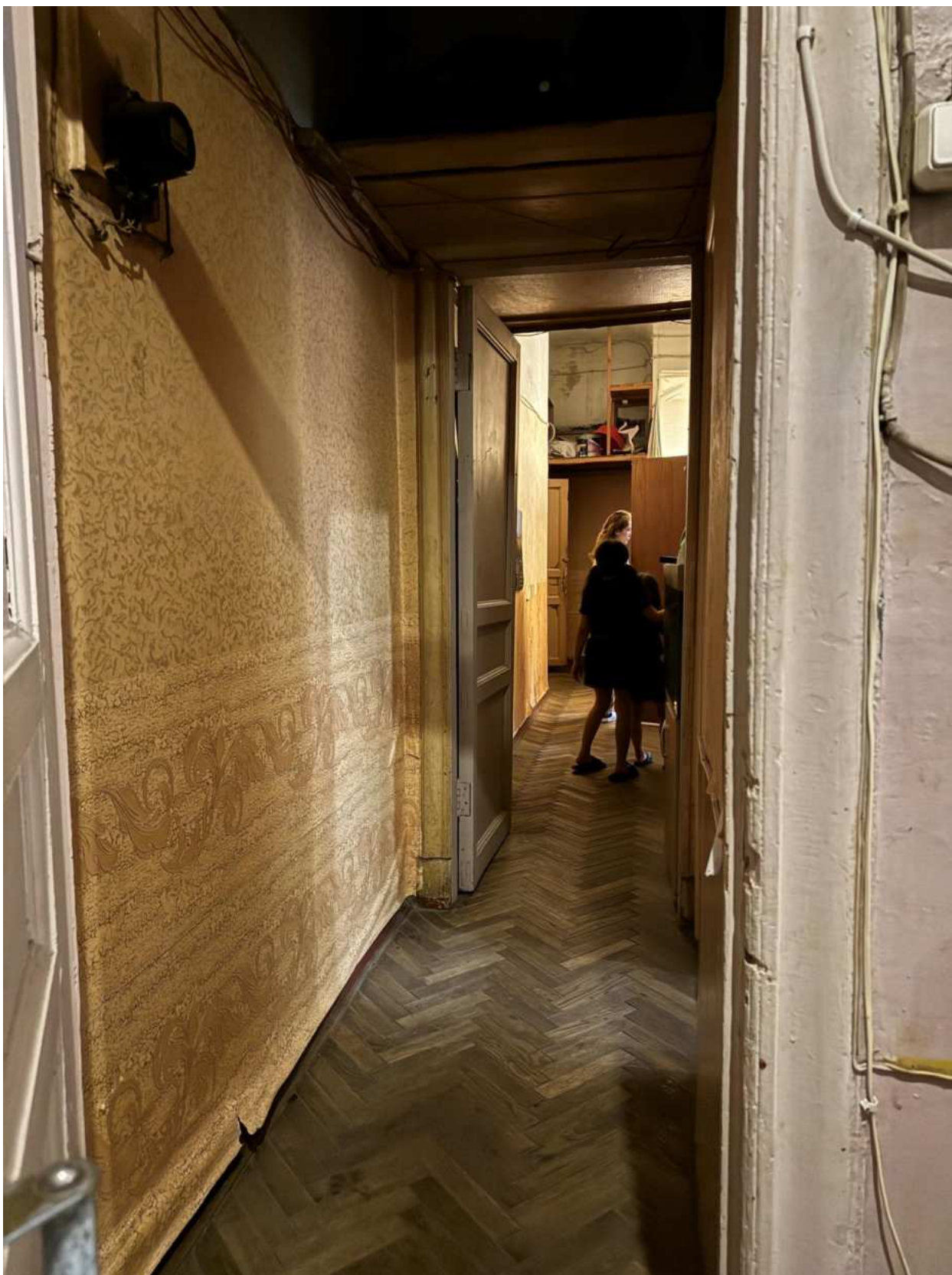
Фото 20. Вид на помещение квартиры № 47 объекта культурного наследия.
