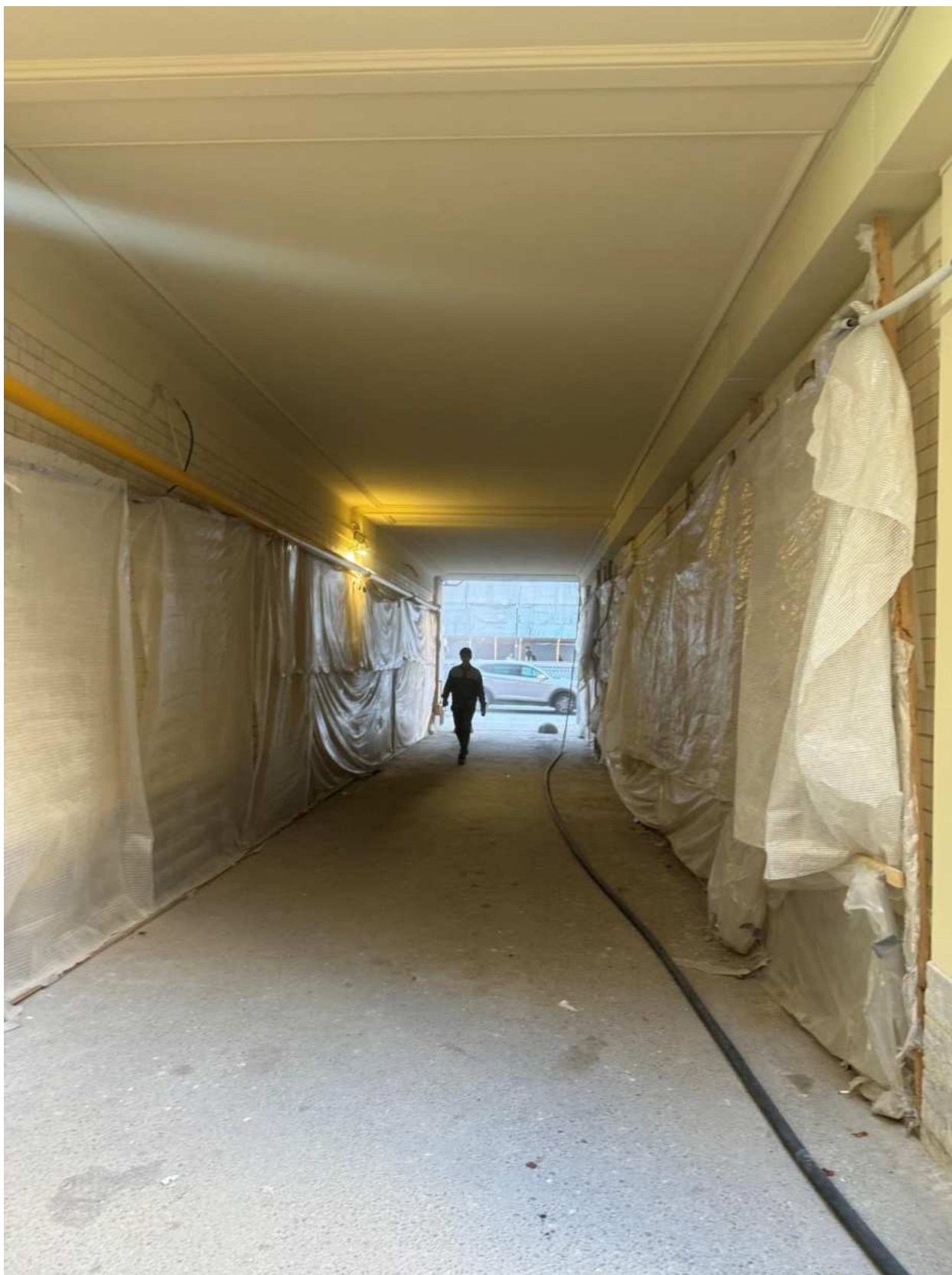
Фото 4. Арка проезда объекта культурного наследия с Кирочной улицы.
