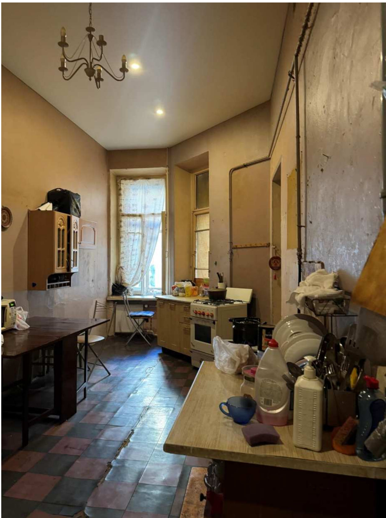
Фото 15. Вид на помещение квартиры № 47 объекта культурного наследия.
