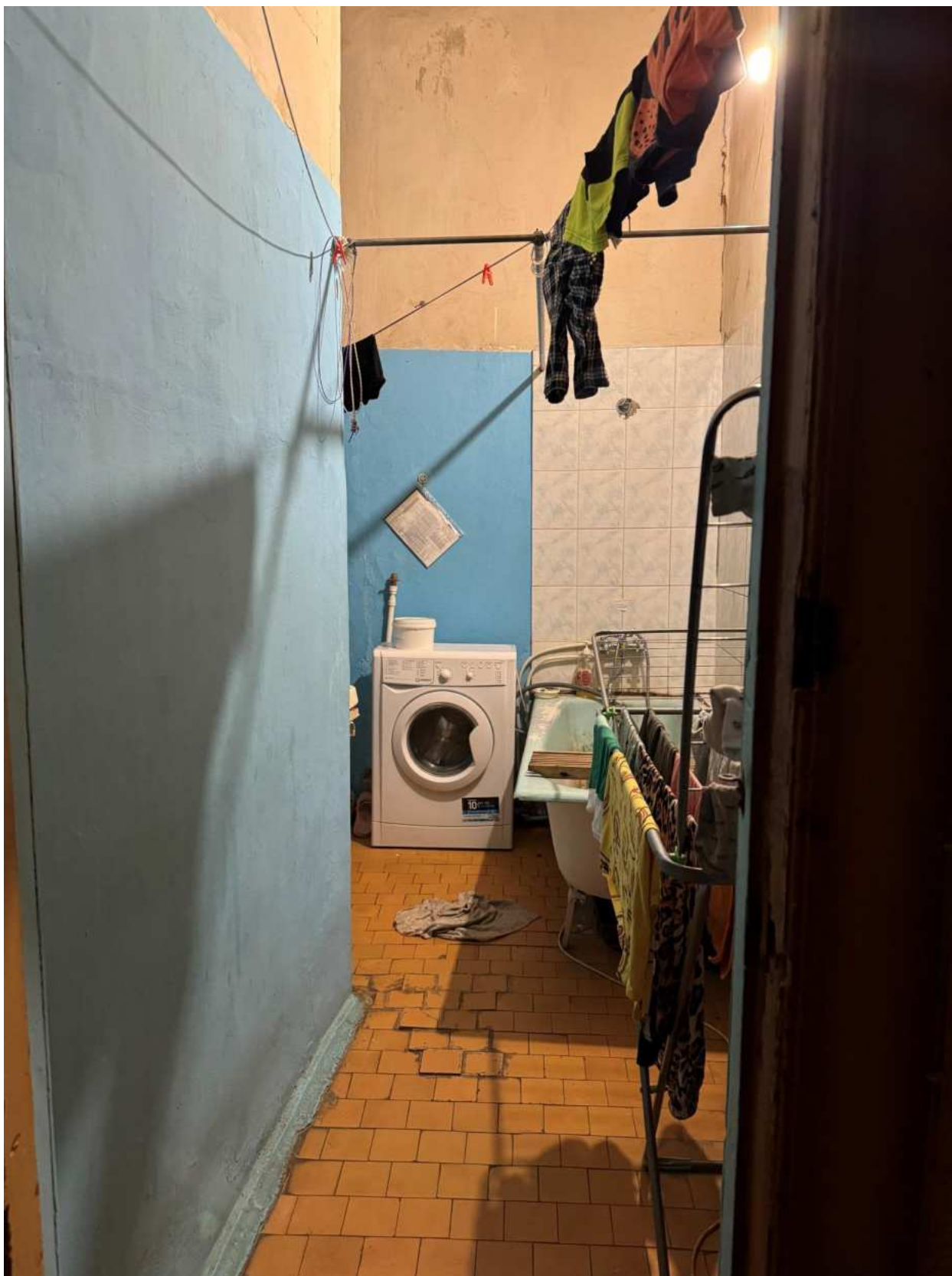
Фото 31. Вид на помещение квартиры № 47 объекта культурного наследия.
