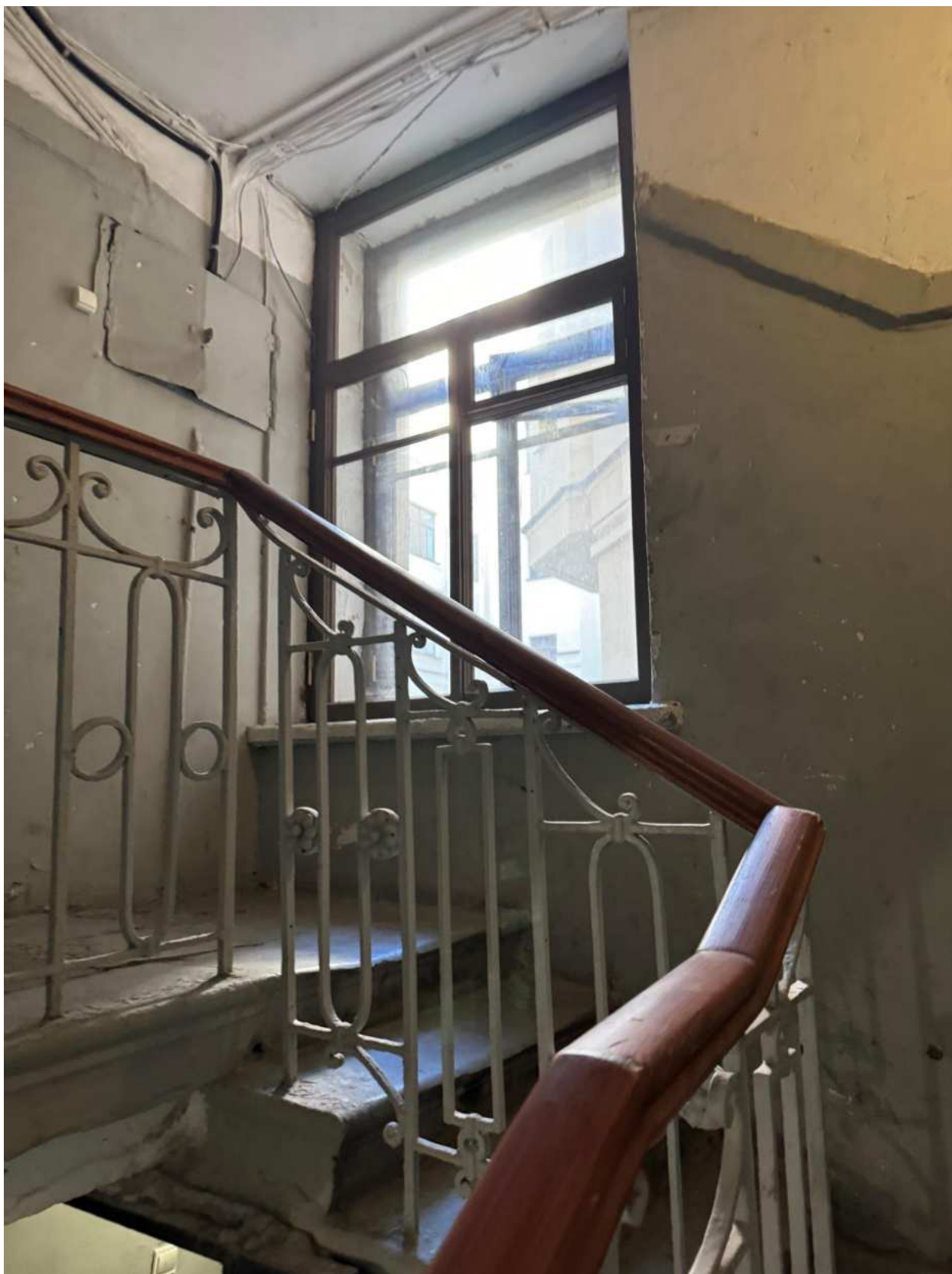
Фото 12. Вид на интерьер лестницы, ведущей к квартире № 47, объекта культурного наследия.
