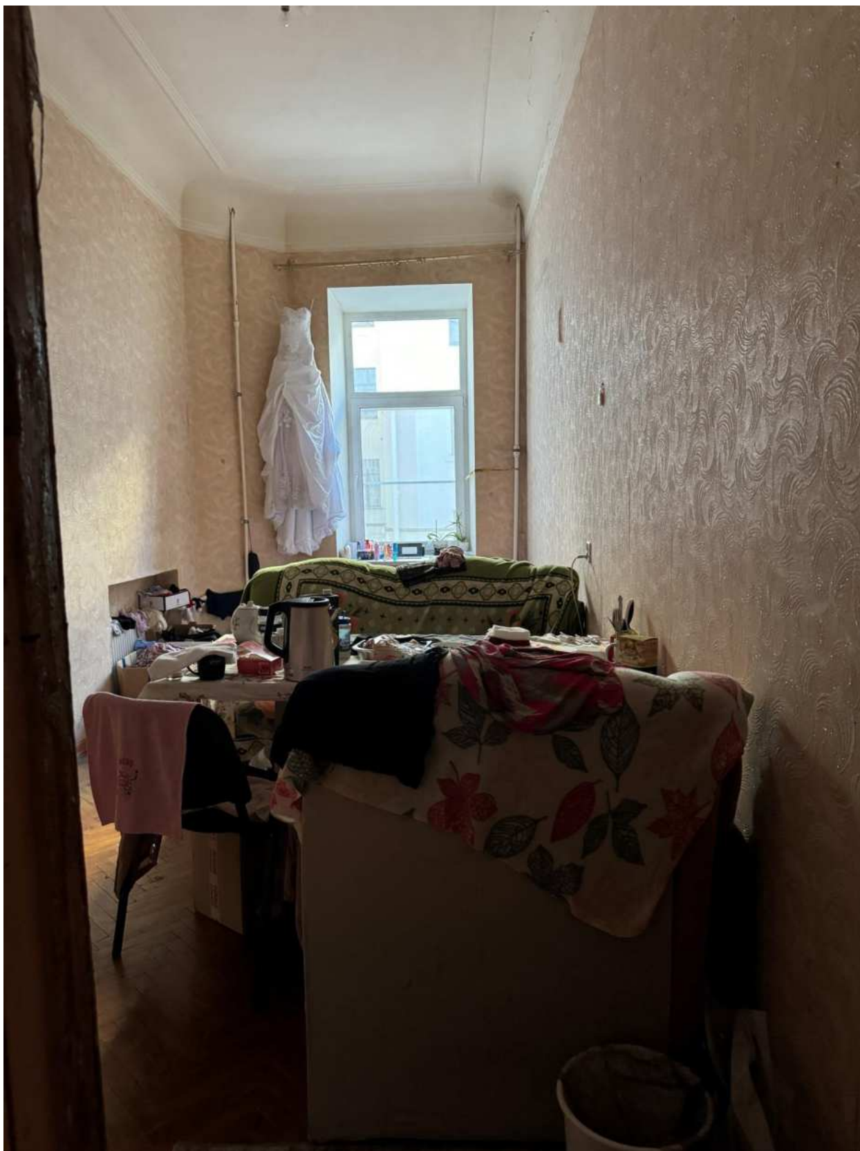
Фото 35. Вид на помещение квартиры № 47 объекта культурного наследия.
