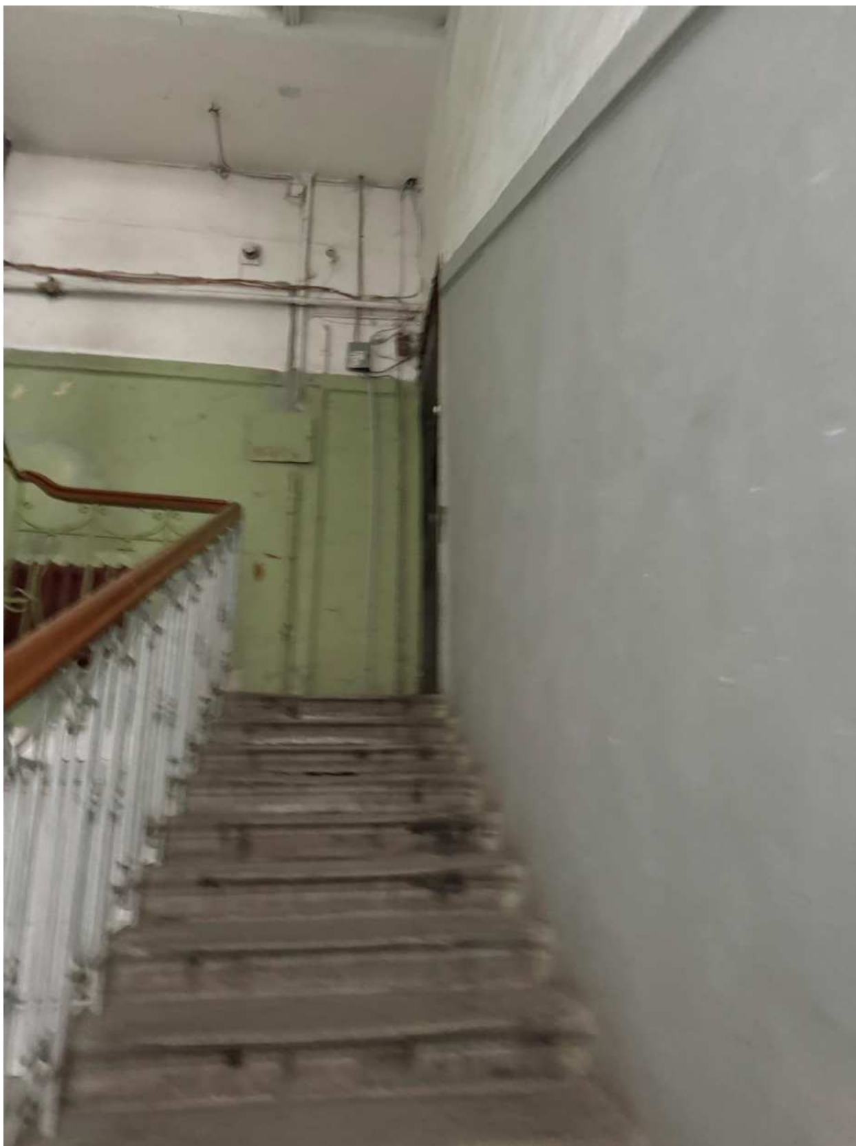
Фото 13. Вид на интерьер лестницы, ведущей к квартире № 47, объекта культурного наследия.
