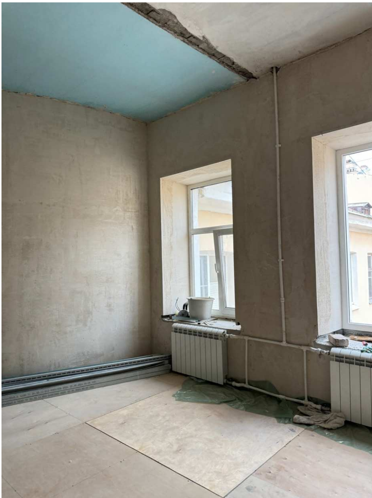
Фото 19. Вид на помещение квартиры № 39 объекта культурного наследия.
