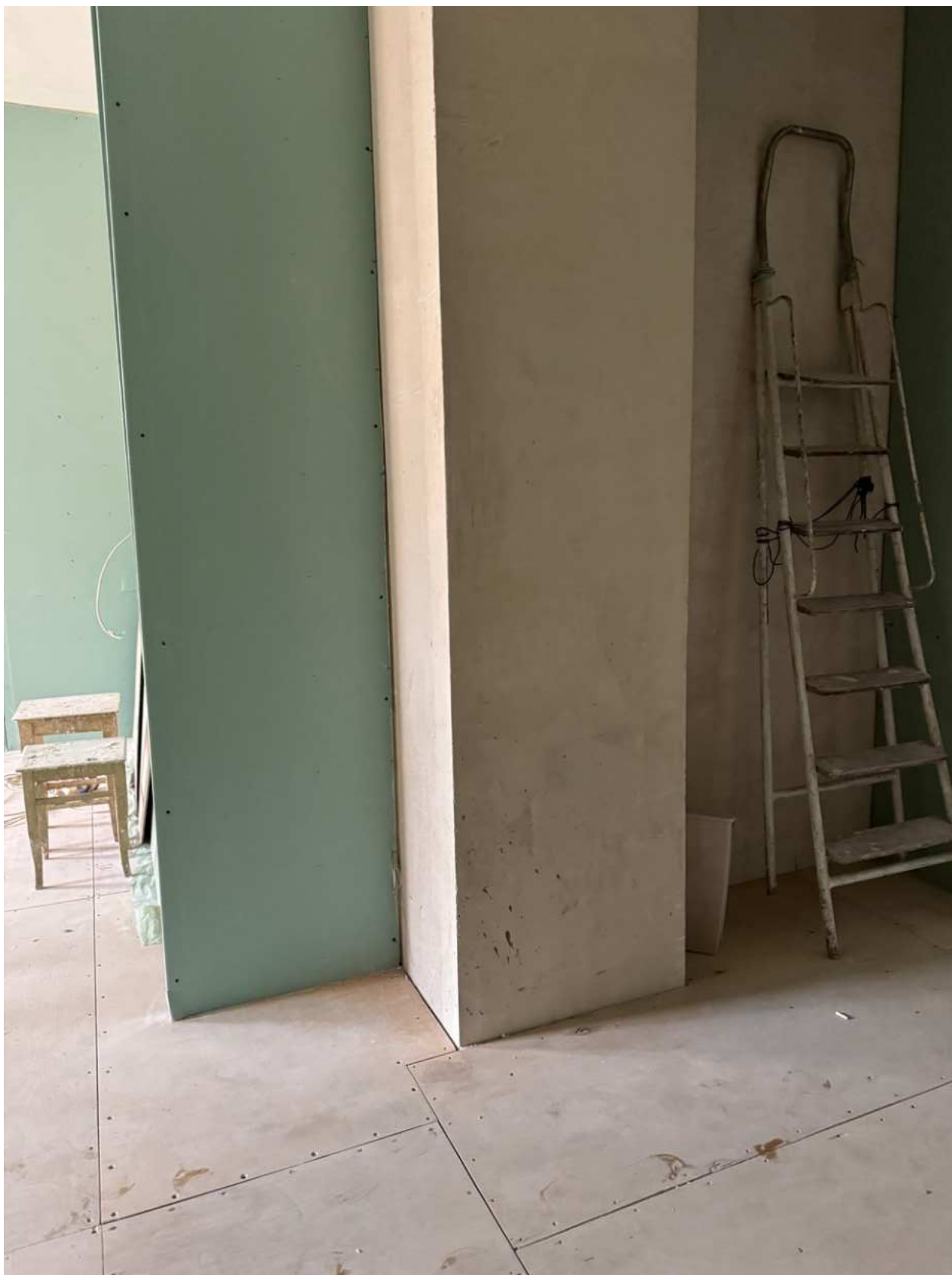
Фото 32. Вид на помещение квартиры № 39 объекта культурного наследия.
