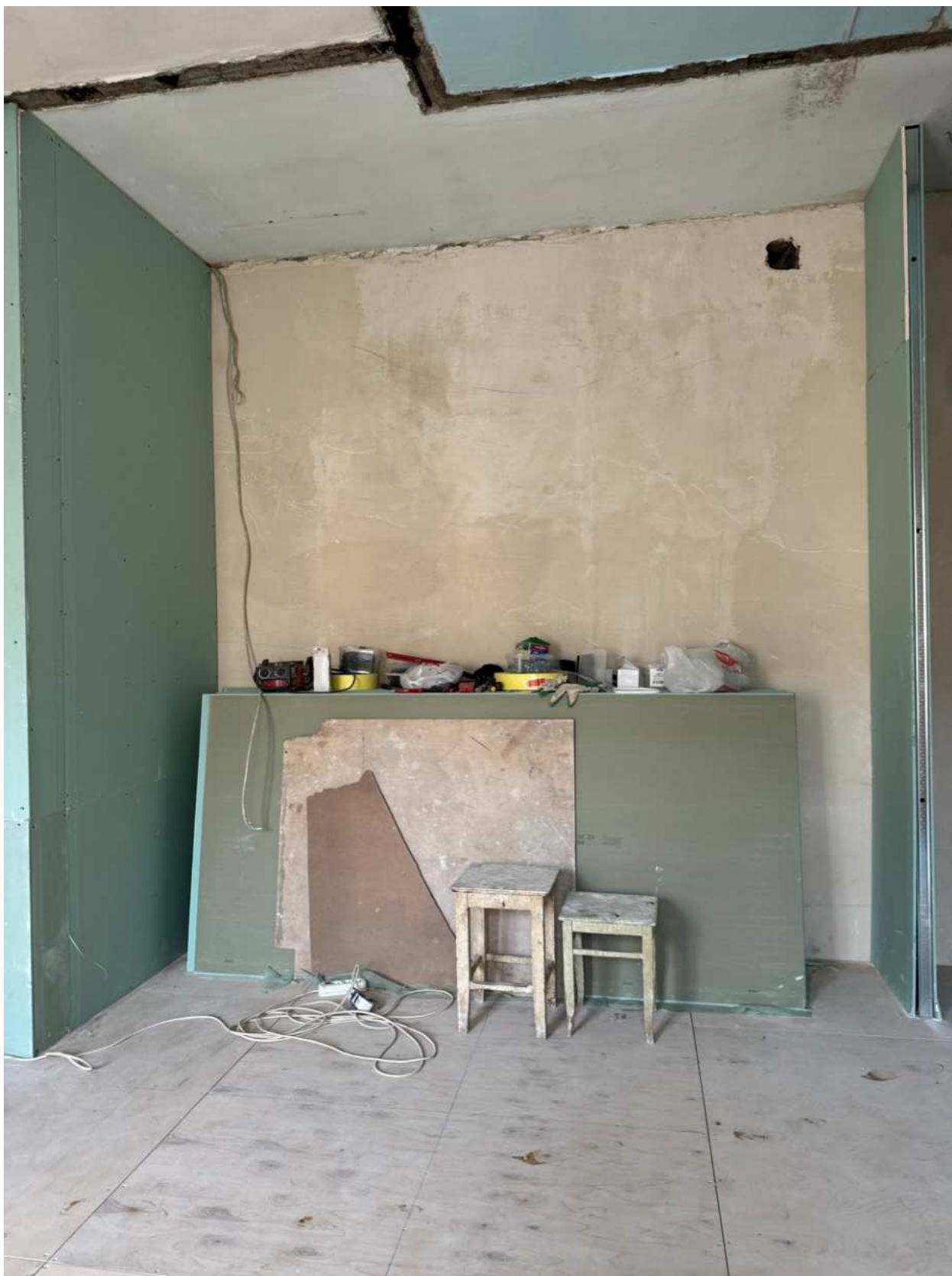
Фото 24. Вид на помещение квартиры № 39 объекта культурного наследия.
