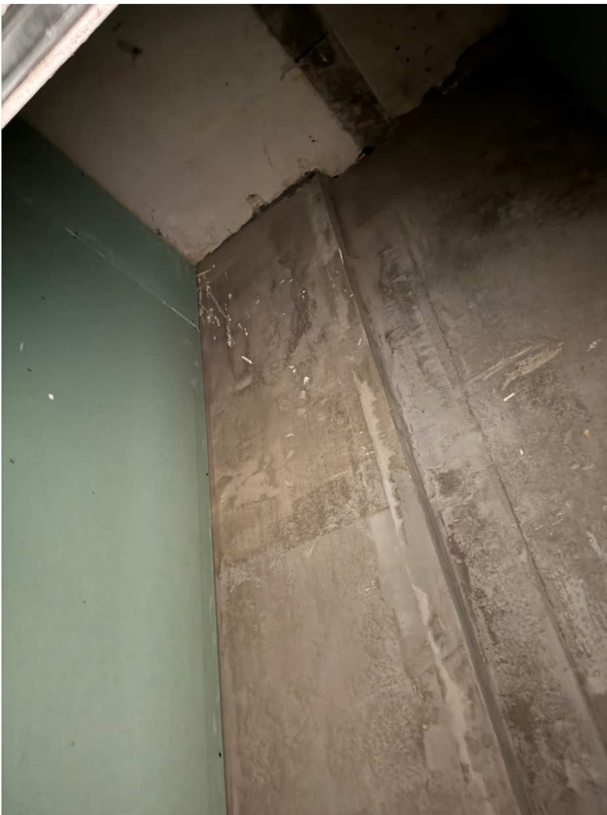
Фото 30. Вид на помещение квартиры № 39 объекта культурного наследия.
