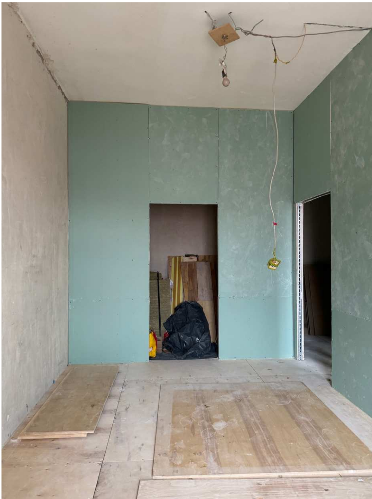
Фото 45. Вид на помещение квартиры № 39 объекта культурного наследия.
