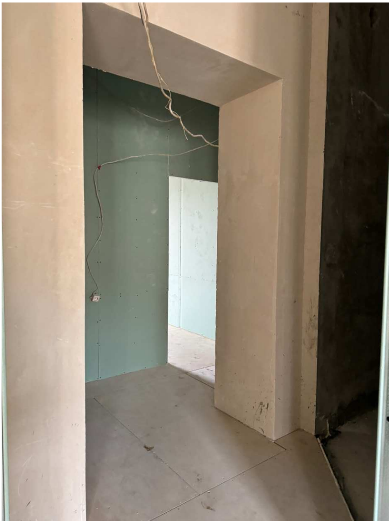
Фото 26. Вид на помещение квартиры № 39 объекта культурного наследия.
