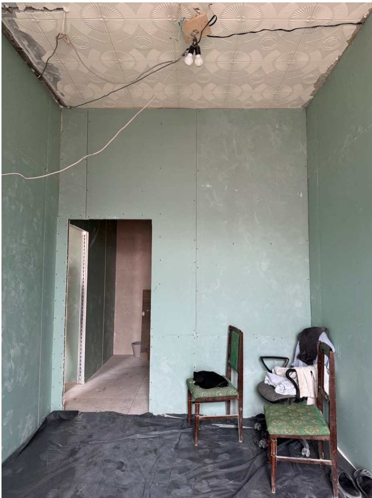
Фото 42. Вид на помещение квартиры № 39 объекта культурного наследия.
