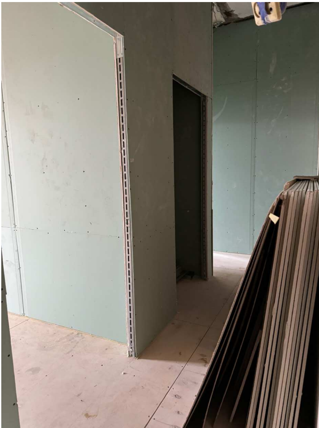
Фото 34. Вид на помещение квартиры № 39 объекта культурного наследия.
