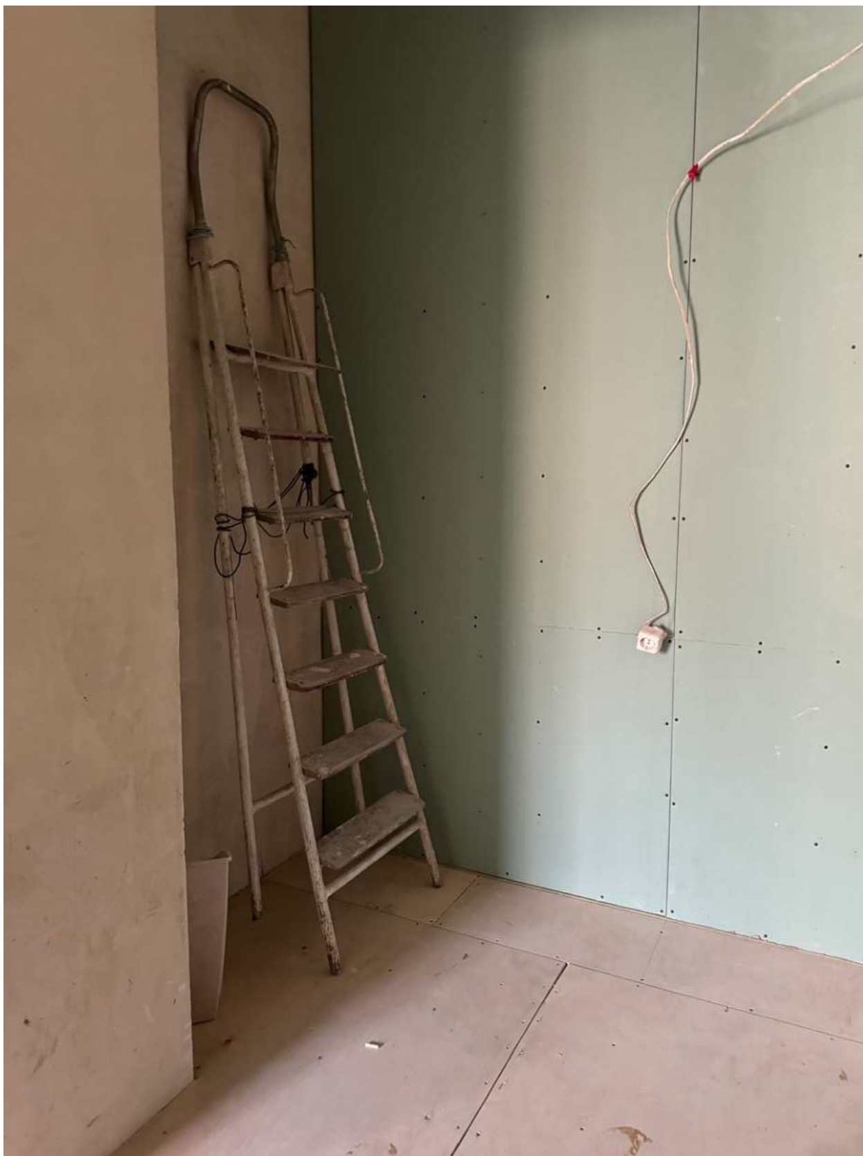
Фото 33. Вид на помещение квартиры № 39 объекта культурного наследия.
