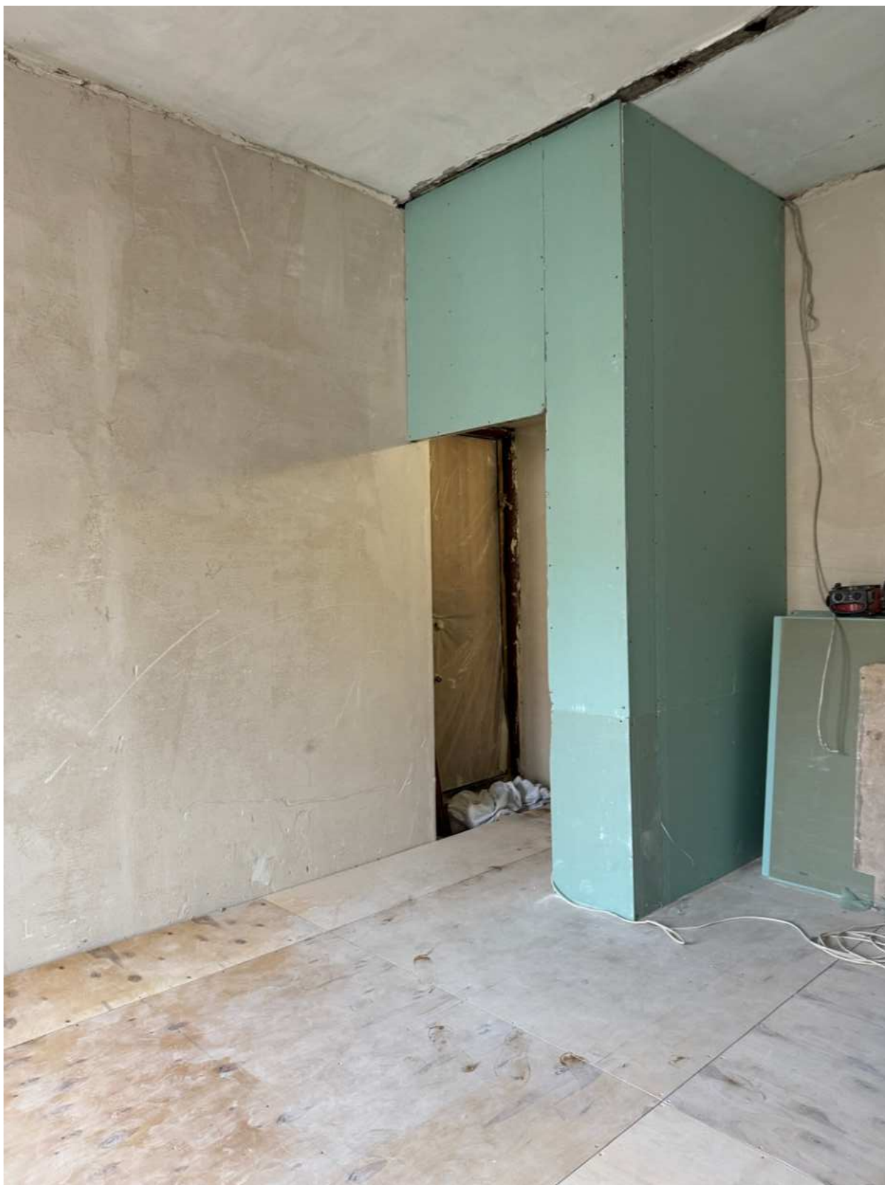
Фото 23. Вид на помещение квартиры № 39 объекта культурного наследия.
