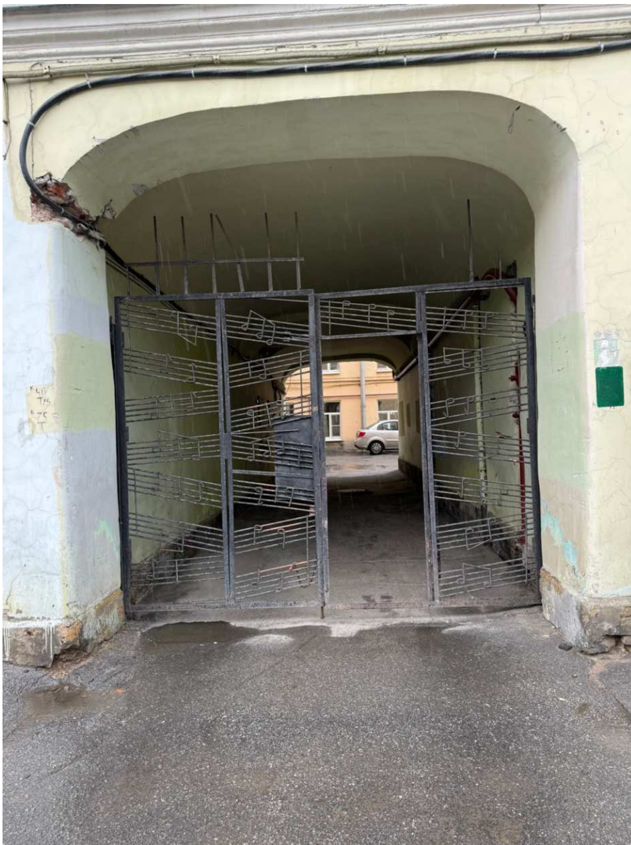
Фото 5. Арка проезда с воротным заполнением объекта культурного наследия.
