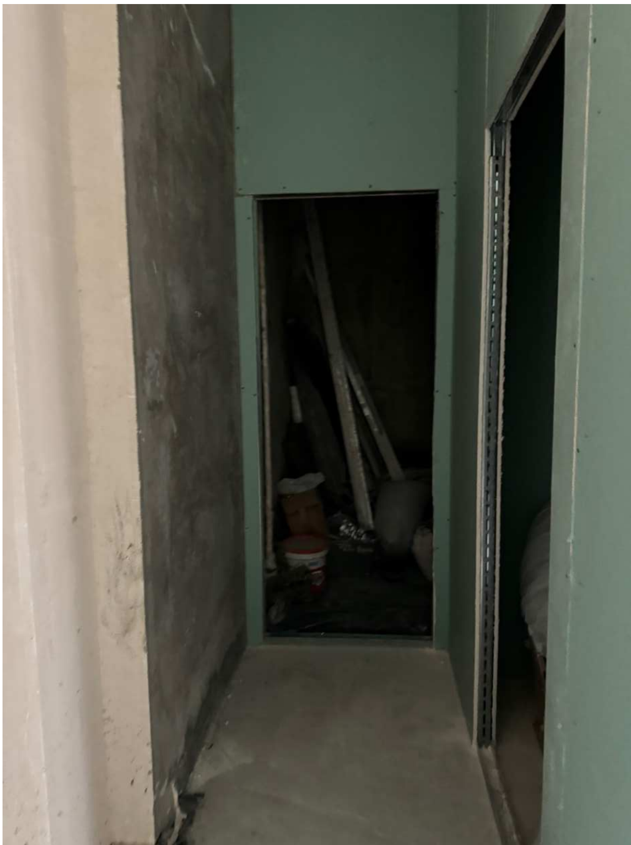
Фото 27. Вид на помещение квартиры № 39 объекта культурного наследия.
