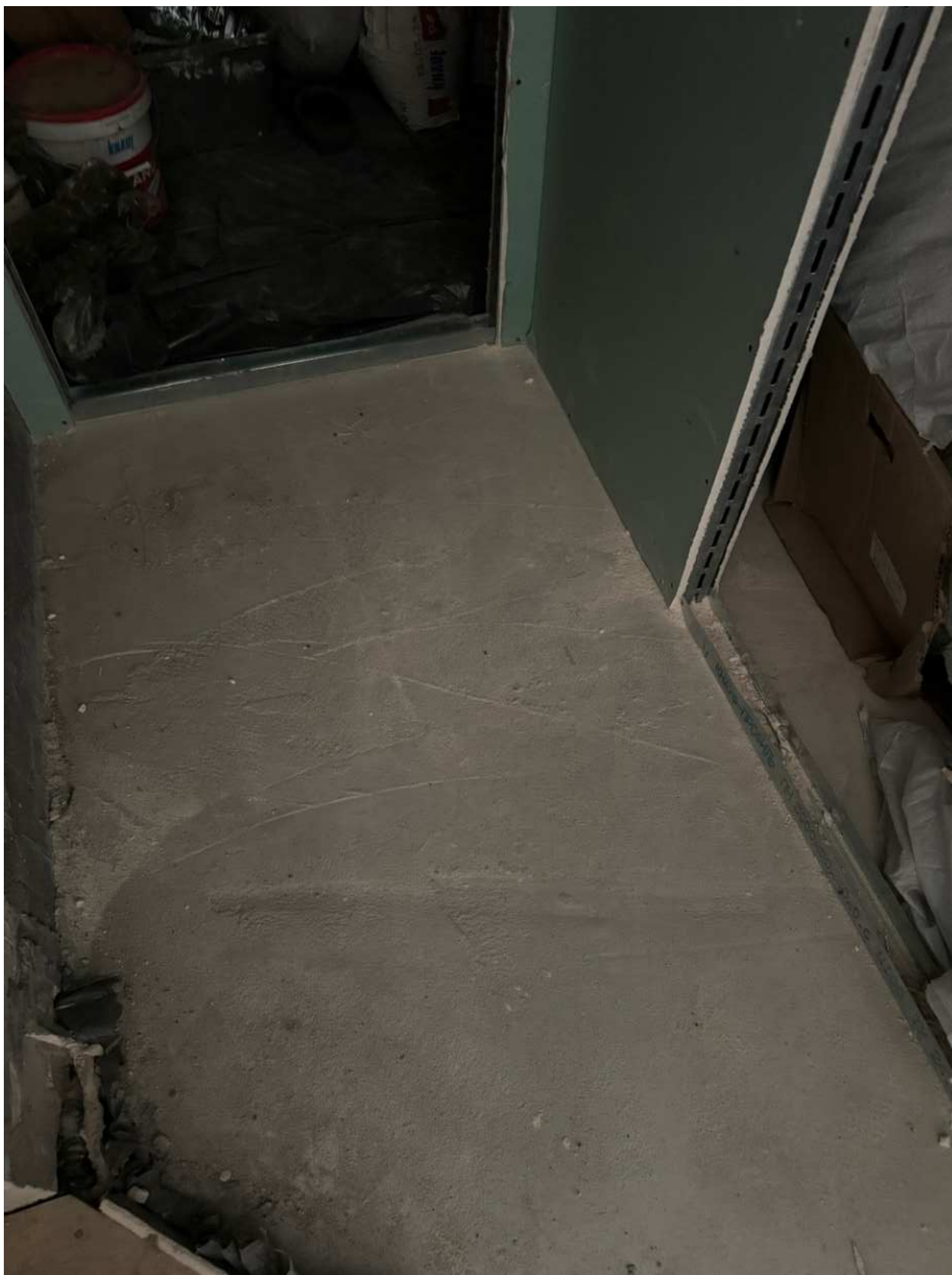
Фото 28. Вид на покрытие пола квартиры № 39 объекта культурного наследия.
