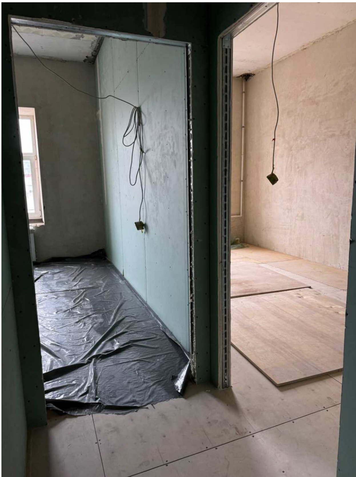
Фото 39. Вид на помещение квартиры № 39 объекта культурного наследия.
