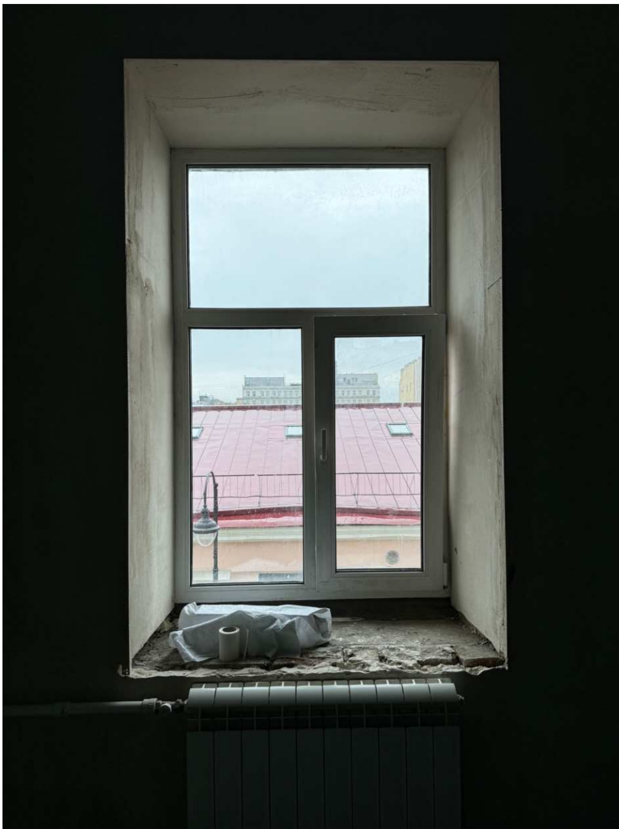
Фото 41. Вид на оконное заполнение квартиры № 39 объекта культурного наследия.
