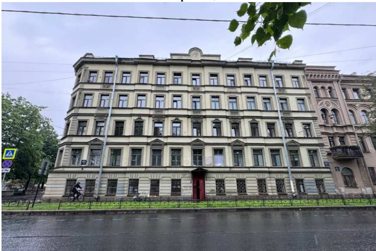
Фото 1. Фасад объекта культурного наследия по 5-й линии В.О.
