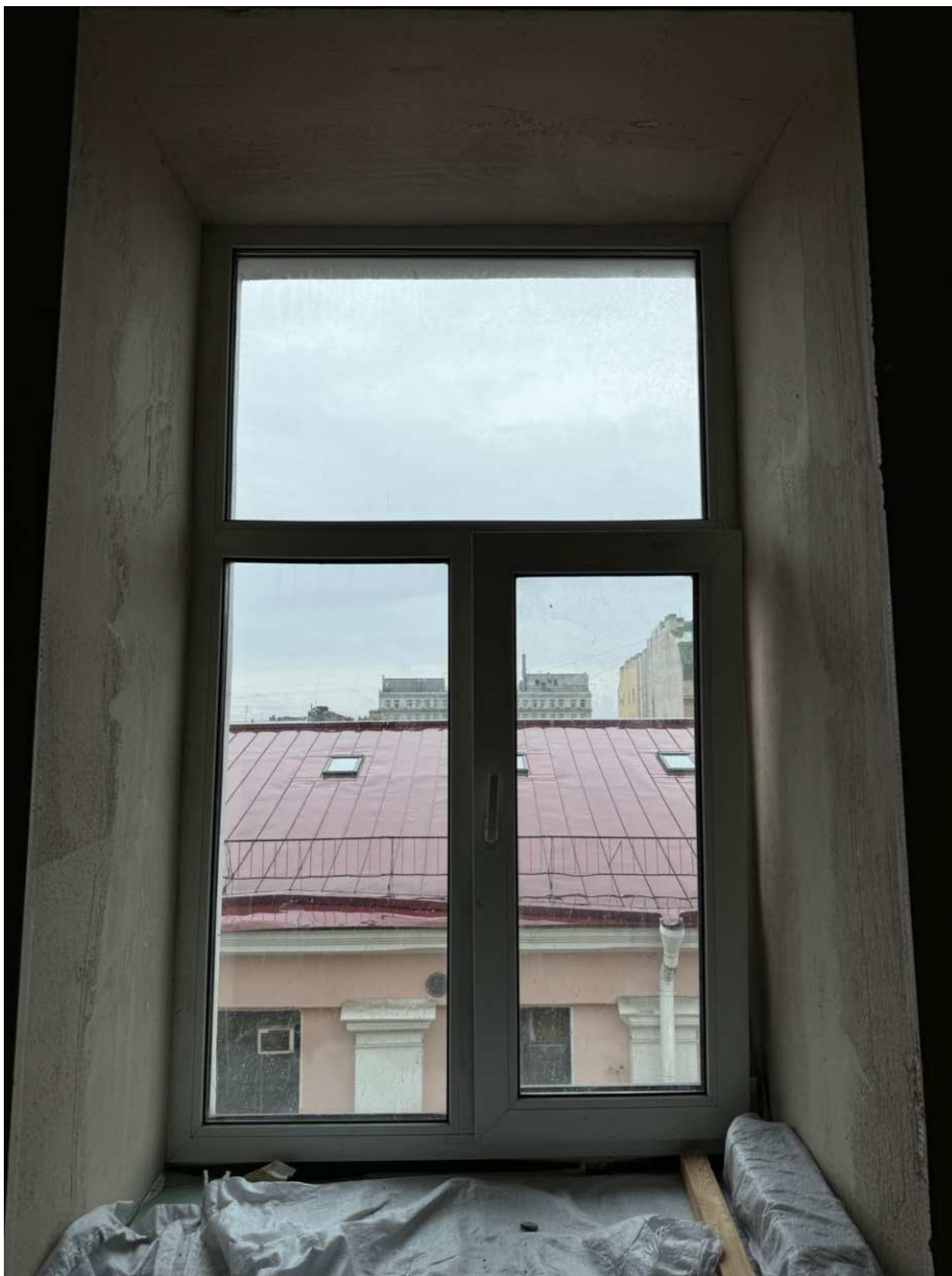
Фото 44. Вид на оконное заполнение квартиры № 39 объекта культурного наследия.
