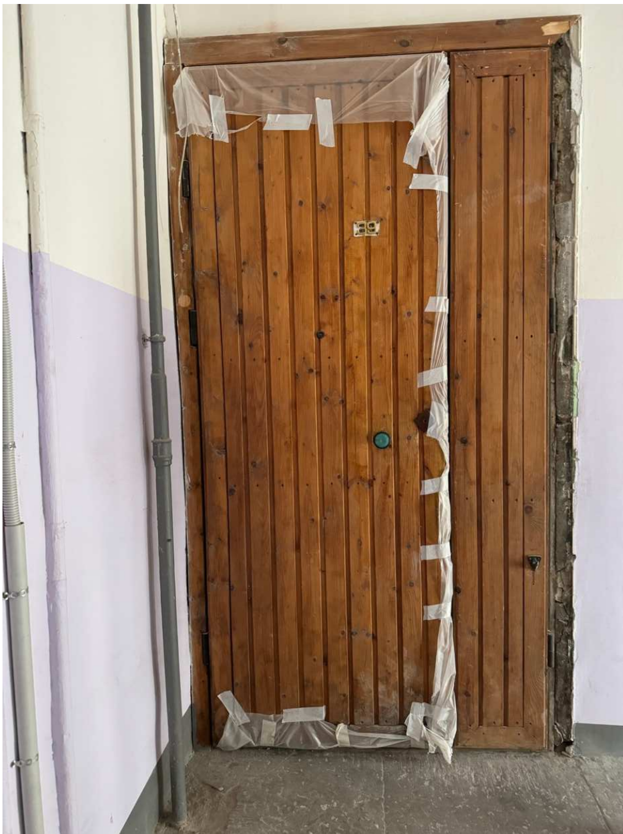
Фото 15. Дверное заполнение квартиры № 39 объекта культурного наследия.
