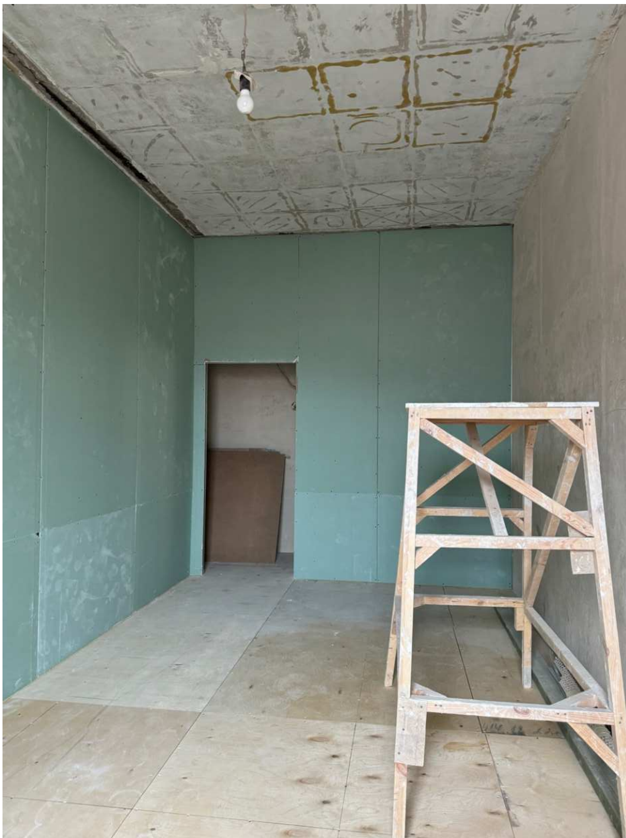
Фото 37. Вид на помещение квартиры № 39 объекта культурного наследия.
