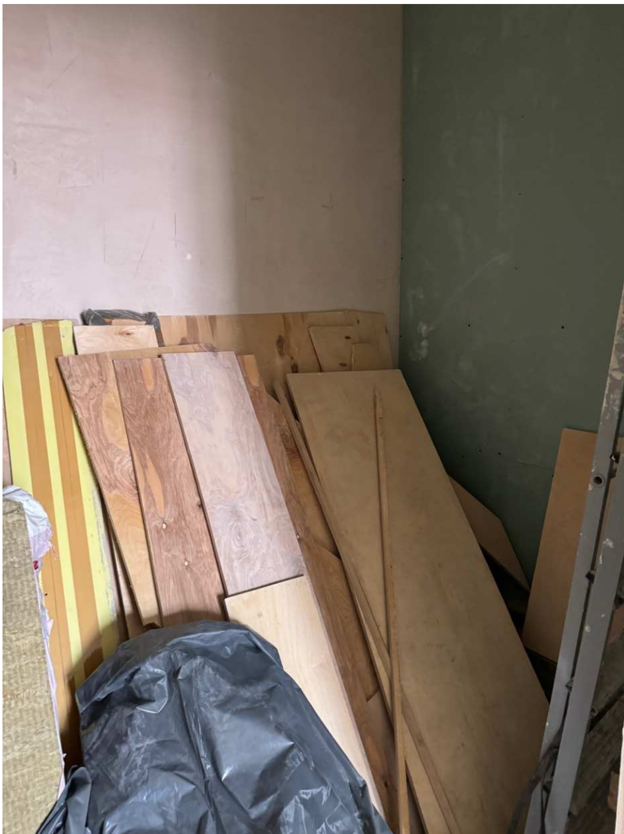
Фото 46. Вид на помещение квартиры № 39 объекта культурного наследия.
