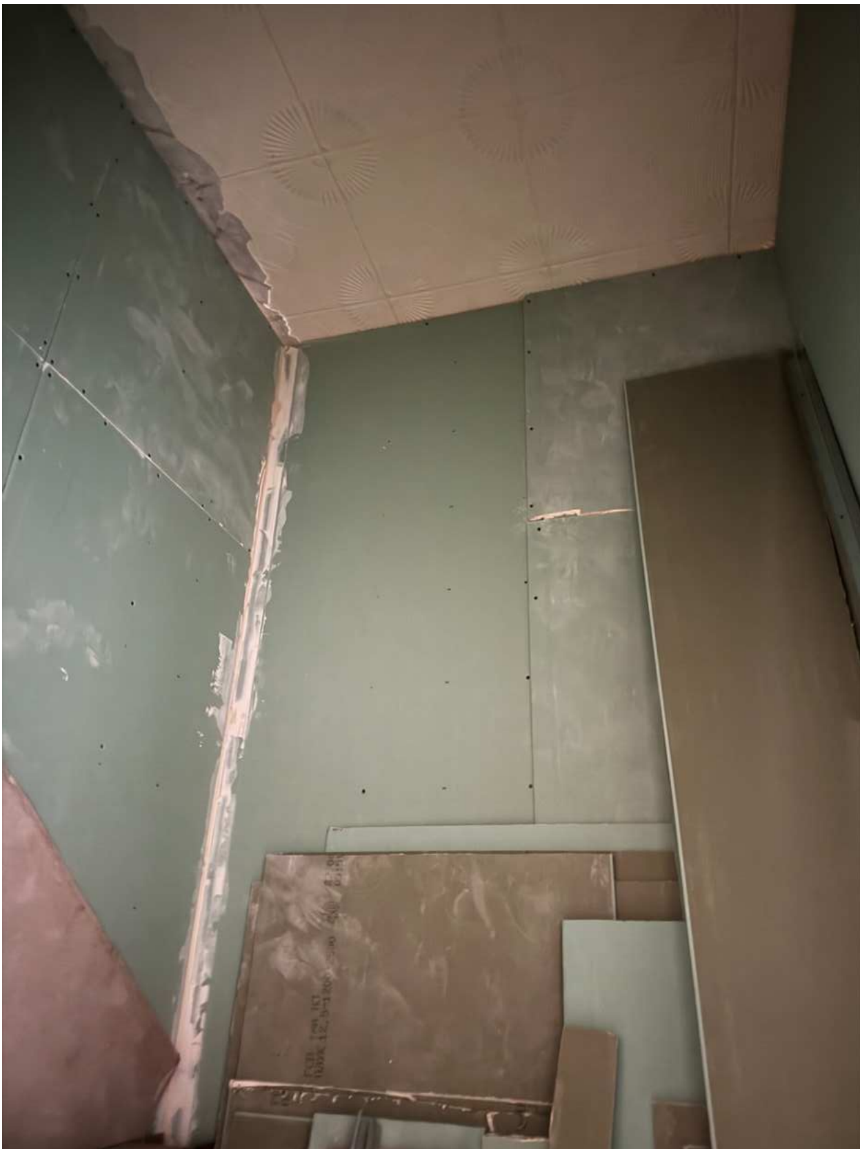
Фото 38. Вид на помещение квартиры № 39 объекта культурного наследия.
