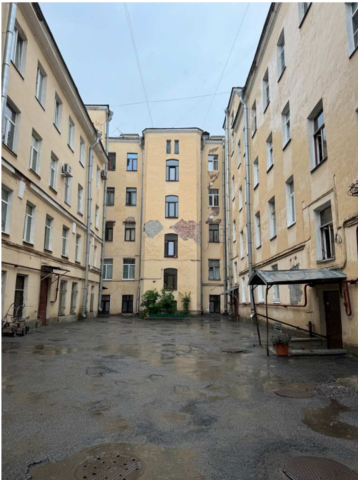
Фото 10. Общий вид дворовых фасадов объекта культурного наследия.
