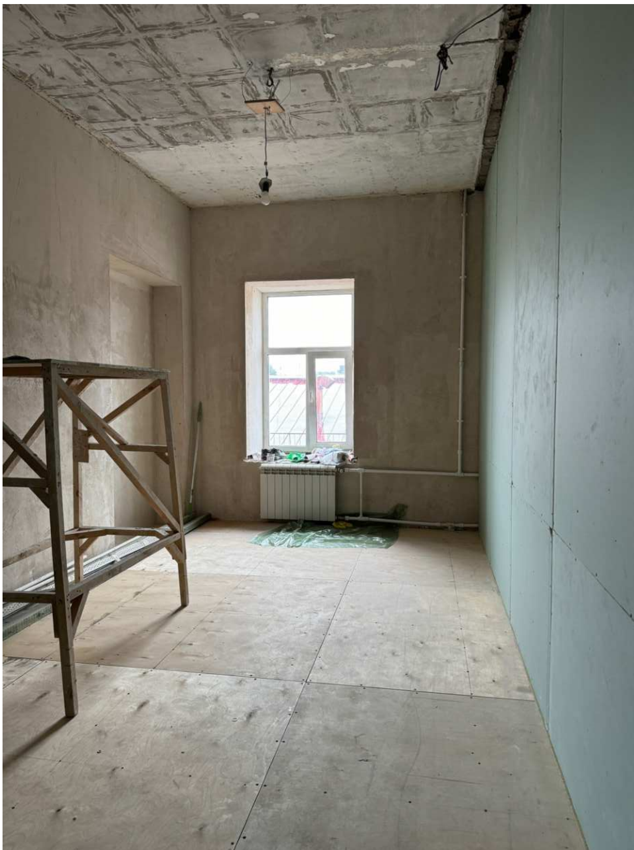
Фото 35. Вид на помещение квартиры № 39 объекта культурного наследия.
