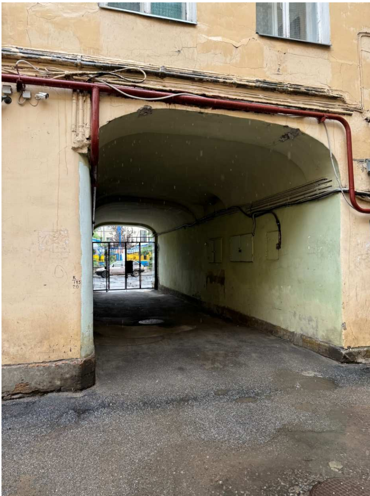
Фото 9. Вид на арку проезда объекта культурного наследия.
