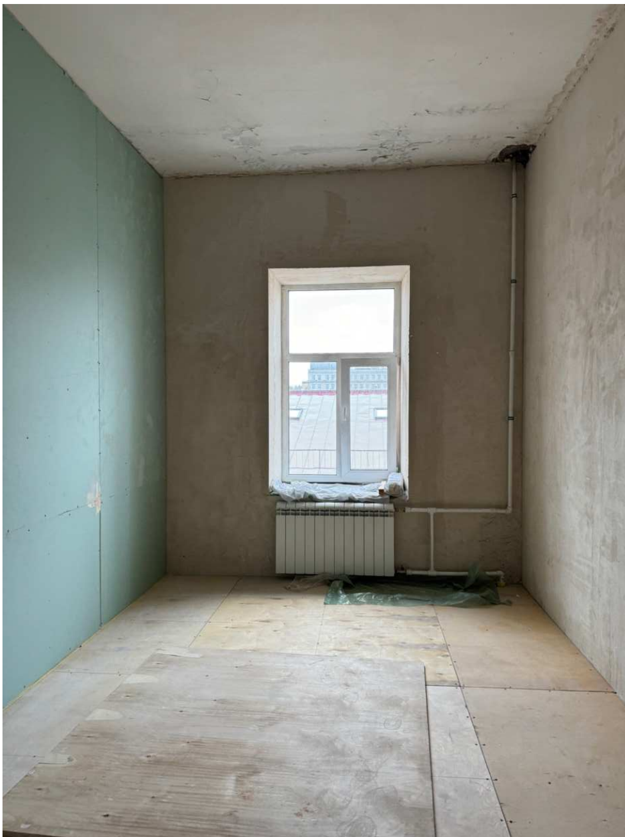
Фото 43. Вид на помещение квартиры № 39 объекта культурного наследия.
