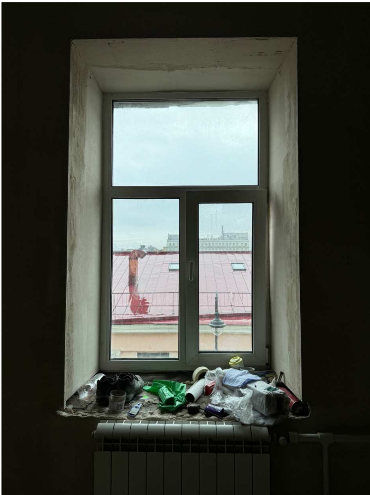
Фото 36. Вид на оконное заполнение квартиры № 39 объекта культурного наследия.
