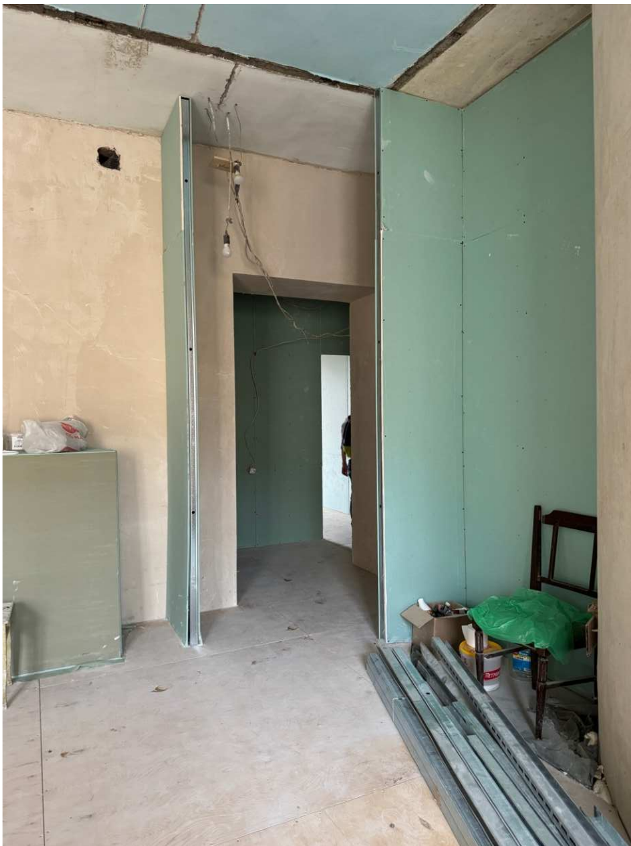
Фото 25. Вид на помещение квартиры № 39 объекта культурного наследия.
