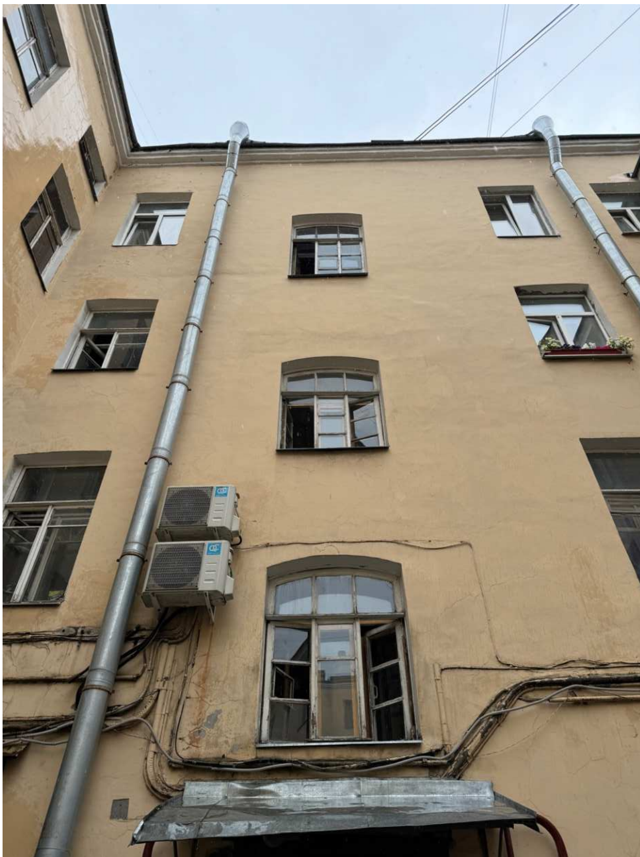
Фото 8. Фрагмент дворового фасада с окнами квартиры № 39 объекта культурного наследия.
