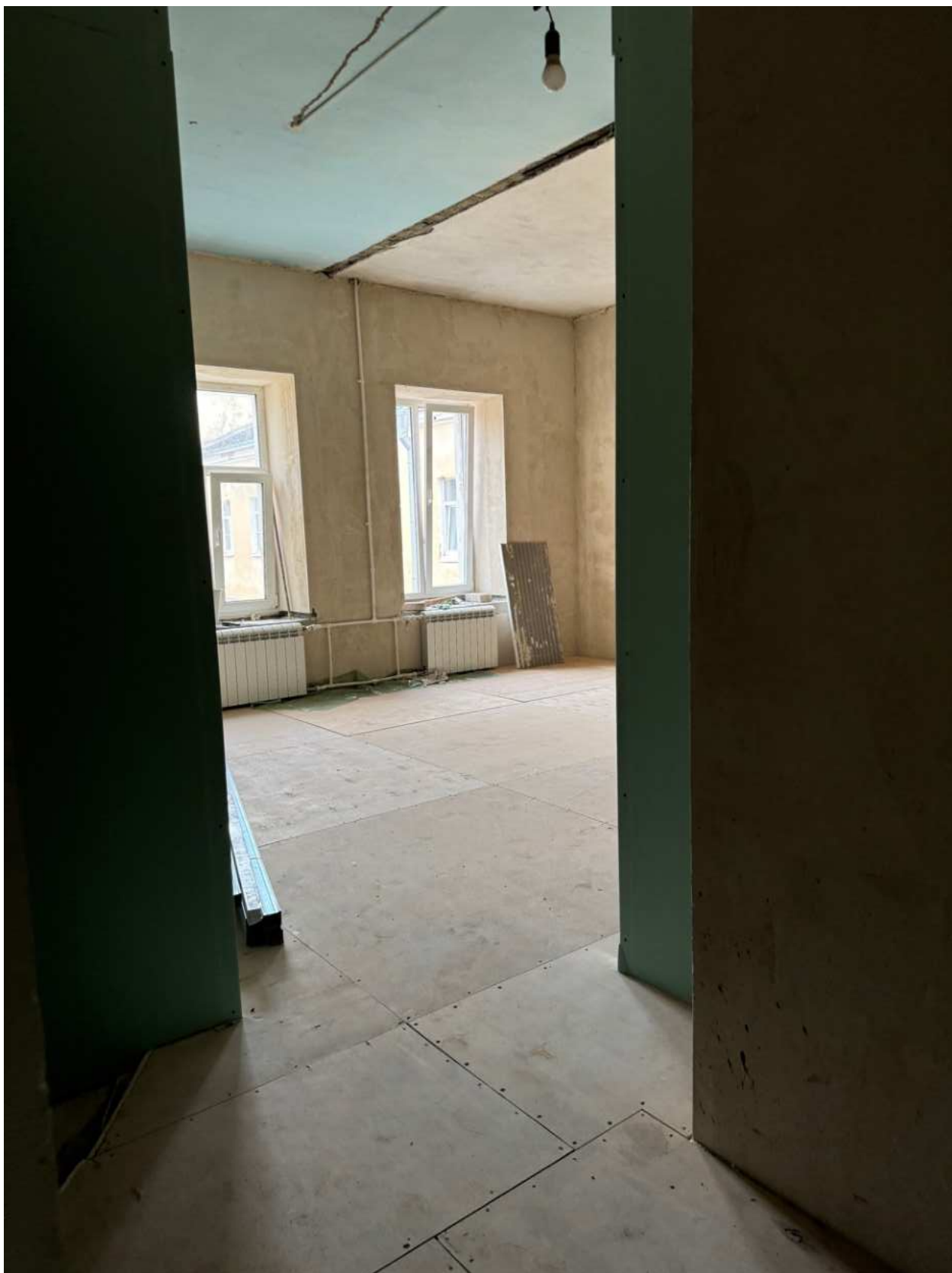
Фото 49. Вид на помещение квартиры № 39 объекта культурного наследия.
