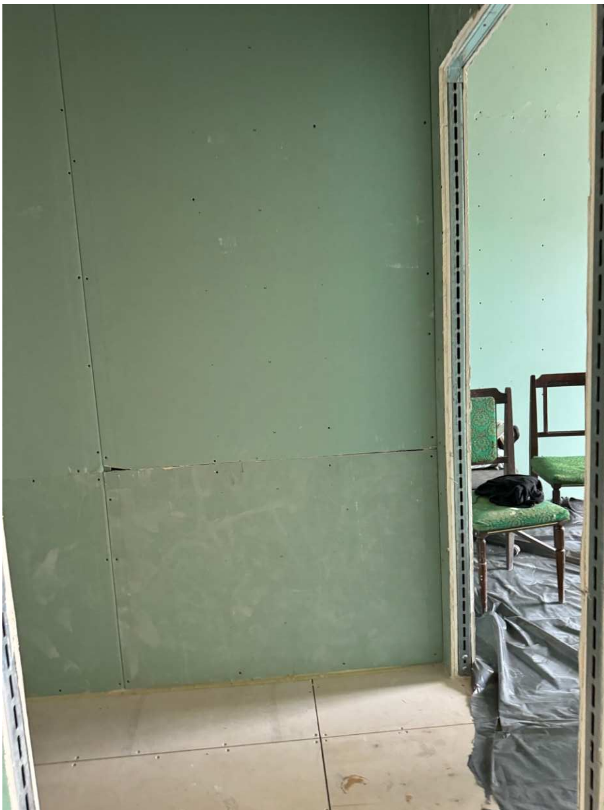
Фото 47. Вид на помещение квартиры № 39 объекта культурного наследия.
