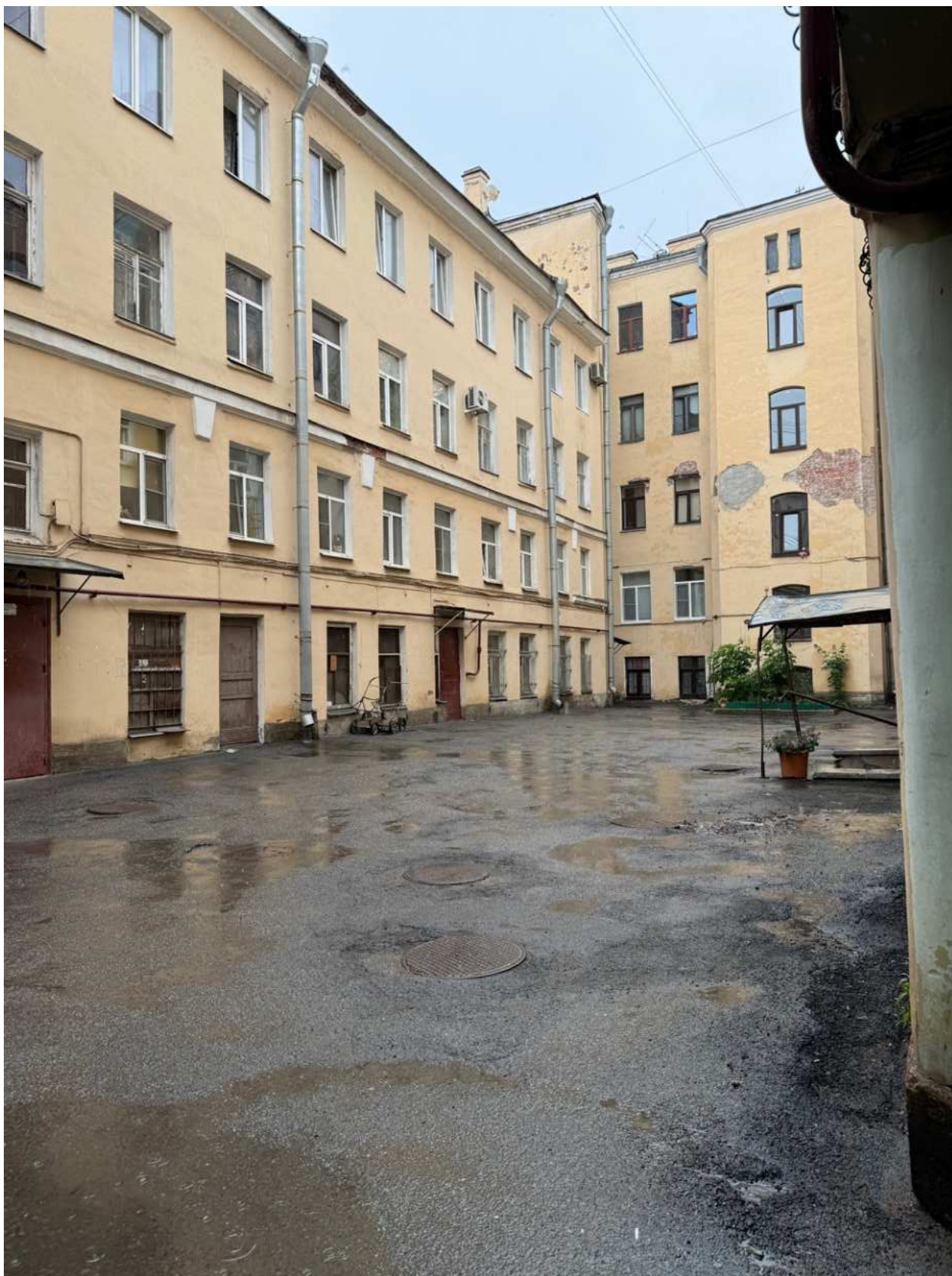
Фото 6. Общий вид дворовых фасадов объекта культурного наследия.
