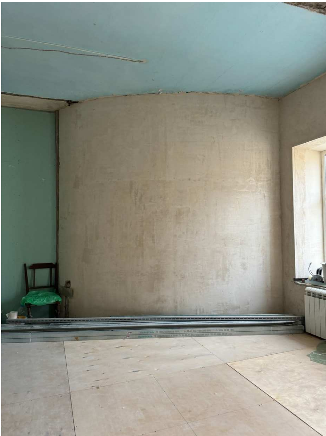
Фото 20. Вид на помещение квартиры № 39 объекта культурного наследия.
