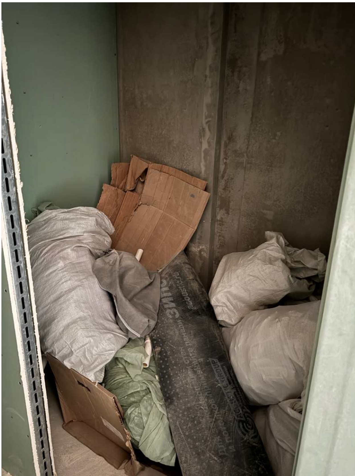
Фото 29. Вид на помещение квартиры № 39 объекта культурного наследия.
