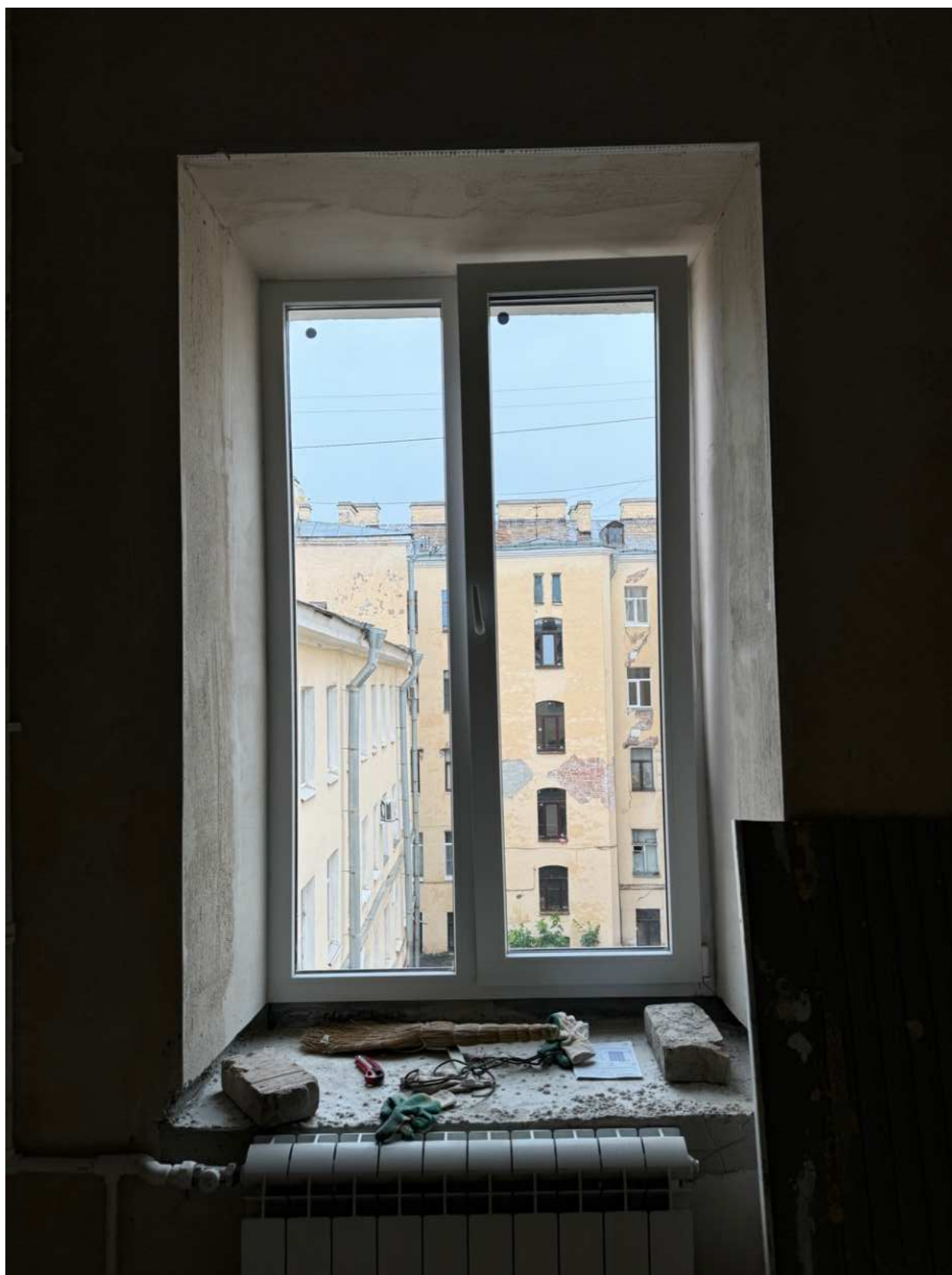
Фото 21. Вид на оконное заполнение квартиры № 39 объекта культурного наследия.
