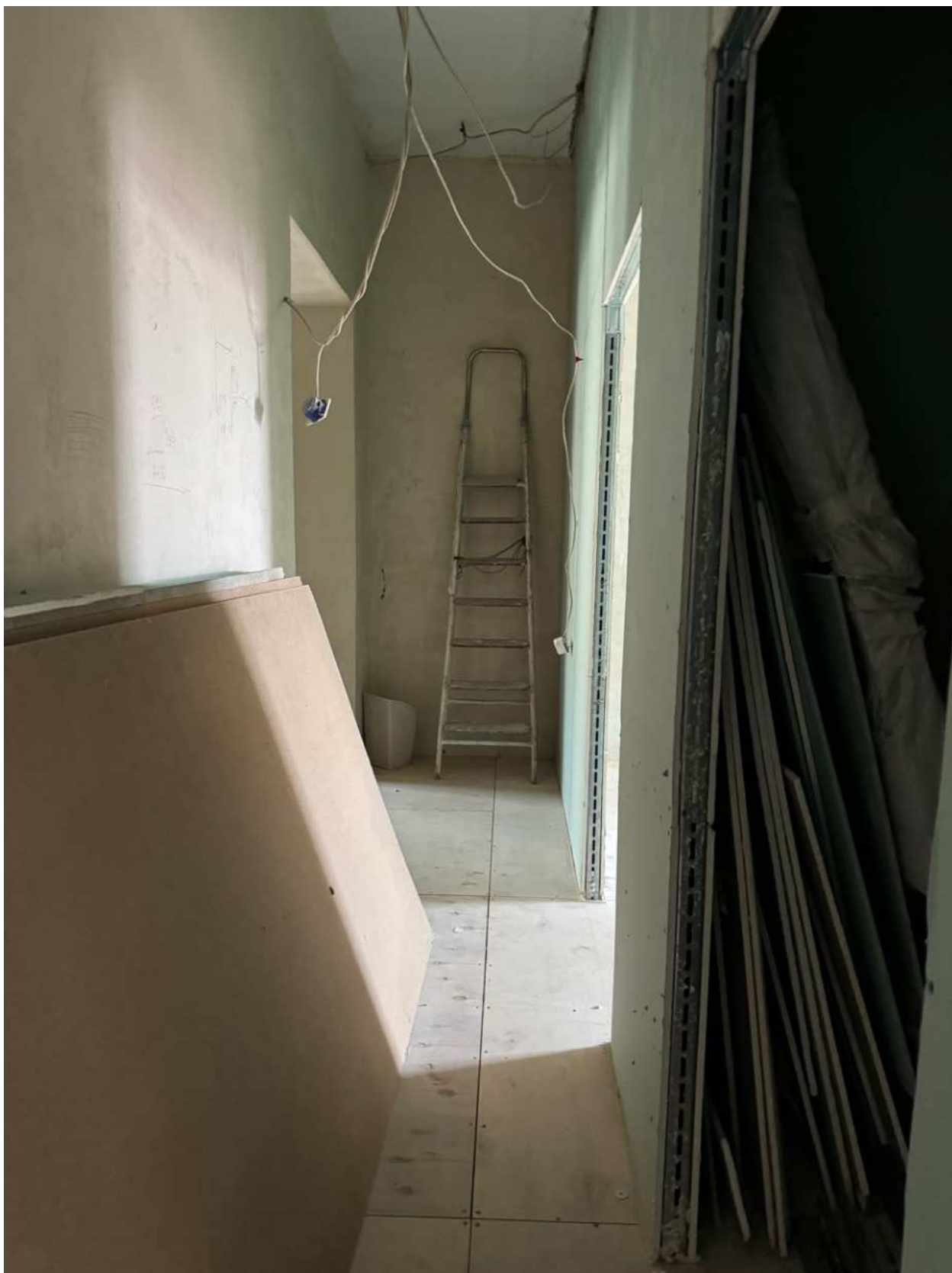
Фото 48. Вид на помещение квартиры № 39 объекта культурного наследия.
