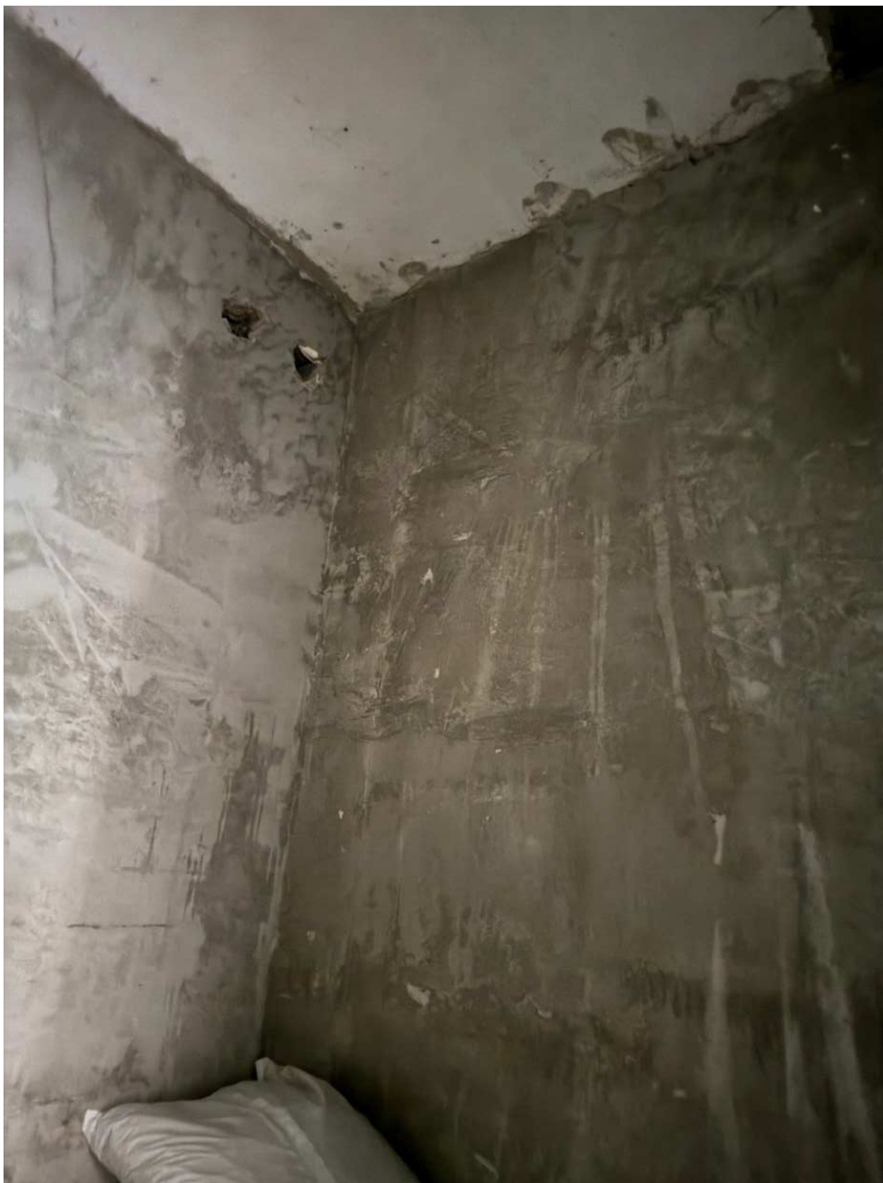
Фото 31. Вид на помещение квартиры № 39 объекта культурного наследия.
