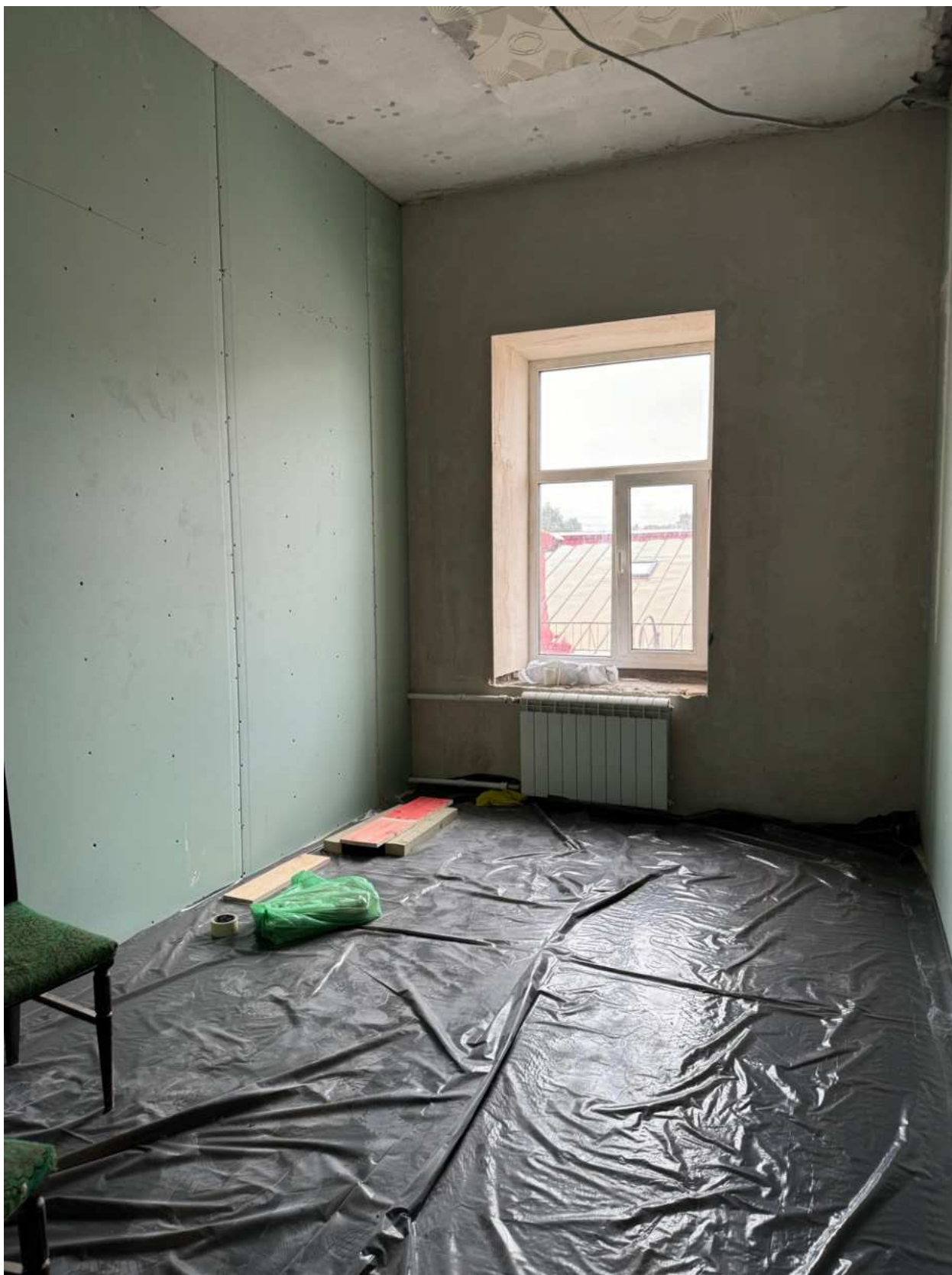
Фото 40. Вид на помещение квартиры № 39 объекта культурного наследия.
