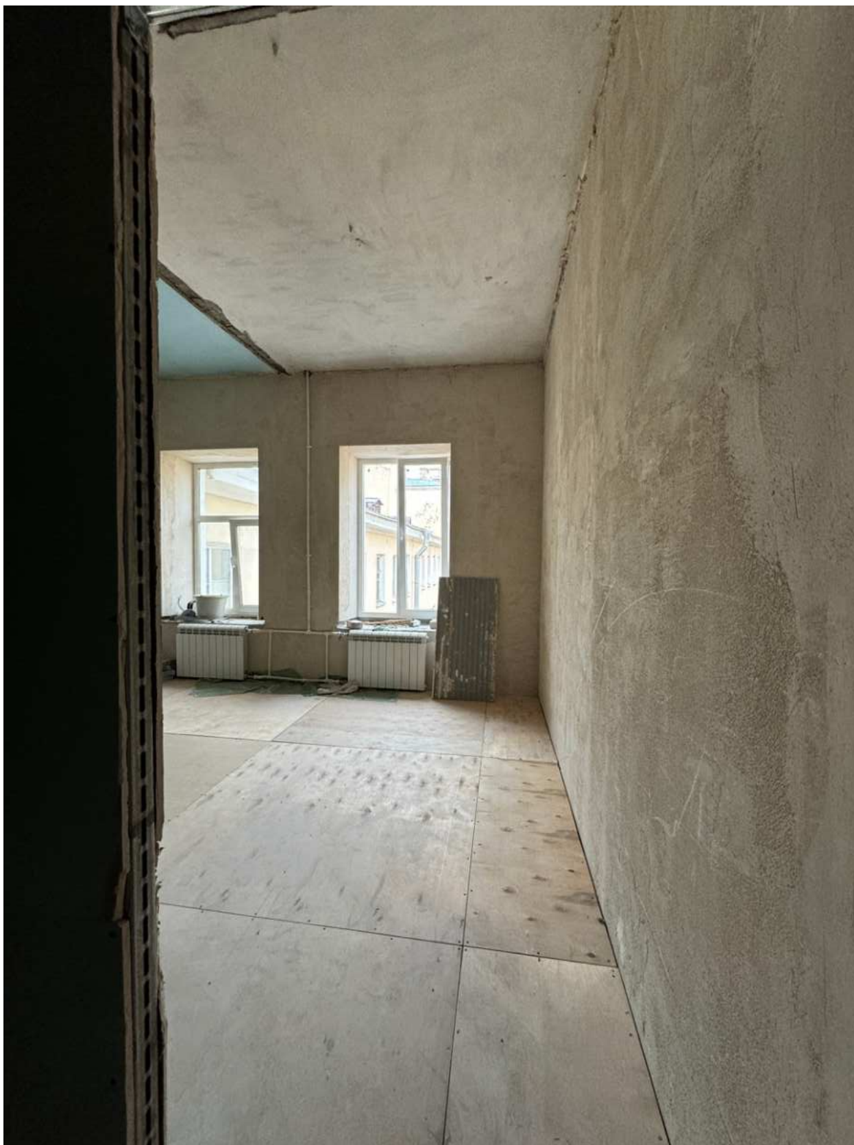
Фото 18. Вид на помещение квартиры № 39 объекта культурного наследия.
