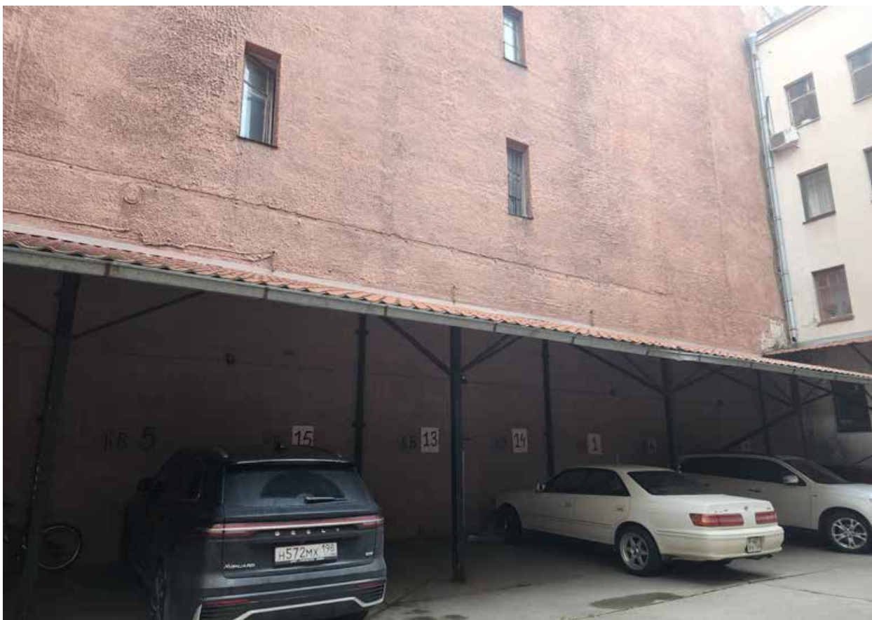
Фото 2. Дворовой фасад. Навес.
