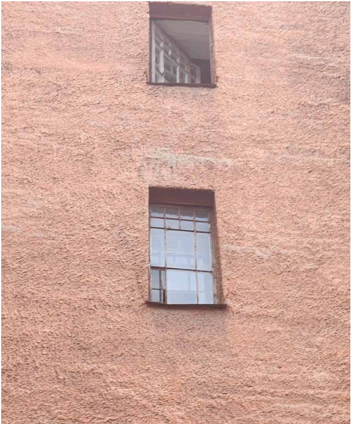
Фото 4. Дворовой фасад. Оконные заполнения в уровне 3 -го и 4 -го этажей.
