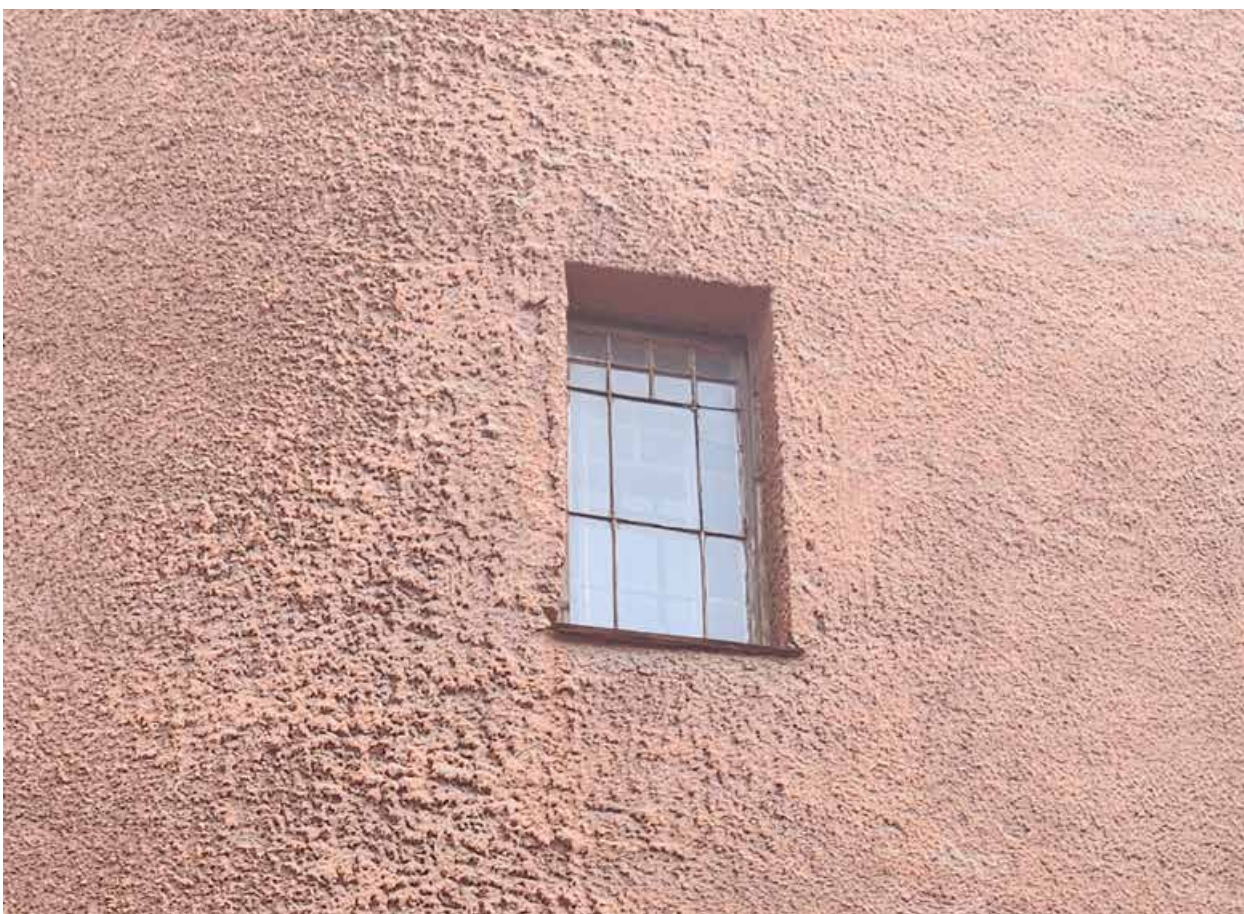
Фото 3. Дворовой фасад. Оконное заполнение в уровне 3 -го этажа.
