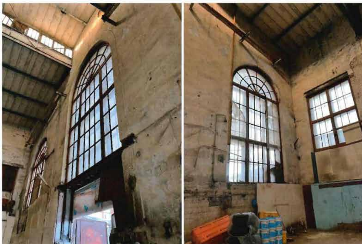
Фото 12, 13. Фрагменты оконных проемов на западной стене объекта культурного наследия.
