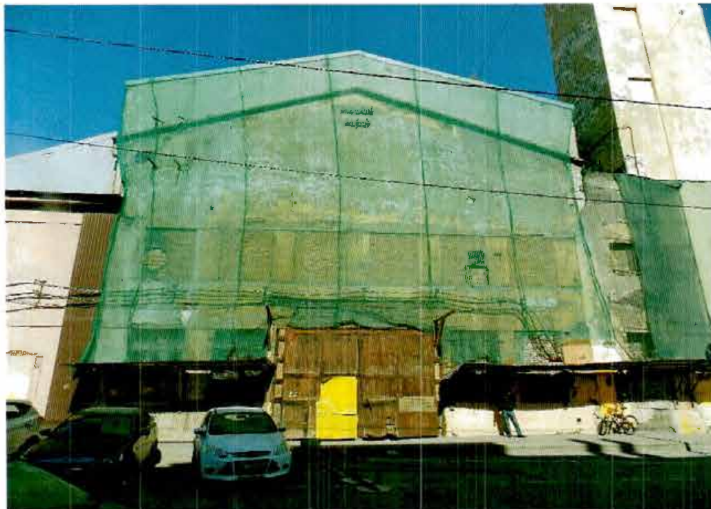
3. Вид на юго-восточный фасад.
