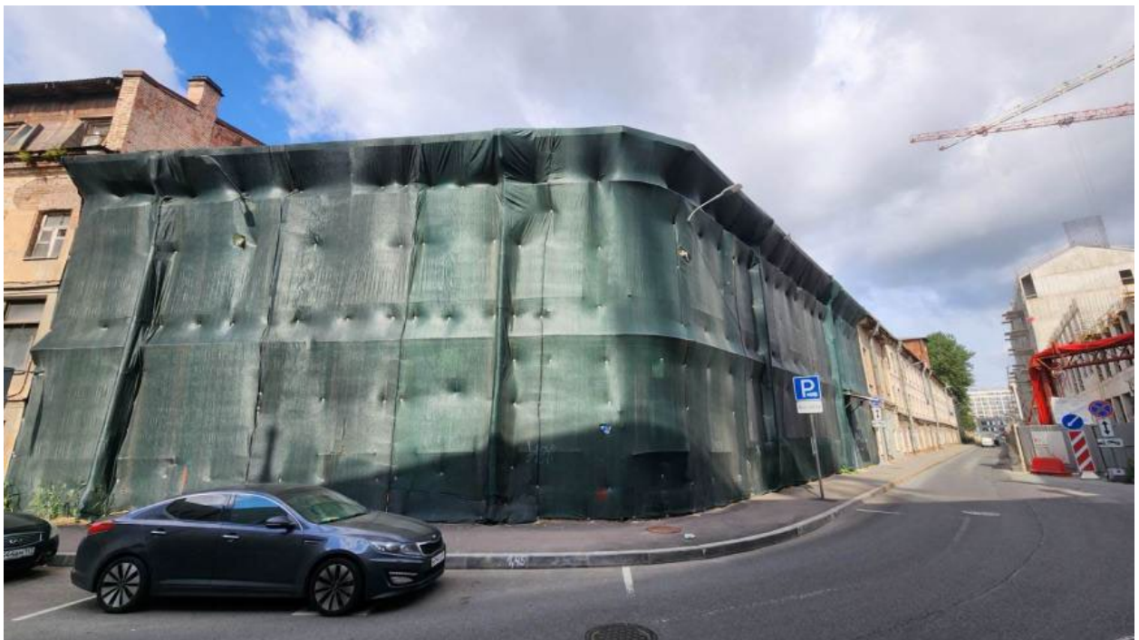
7. Лицевые фасады выявленного объекта культурного наследия «Кожевенный завод А.А. Парамонова. Особняк владельца», по адресу: г. Санкт-Петербург, Кожевенная линия, д. 1-3, литера Р, на зону производства работ. 14.08.2024
