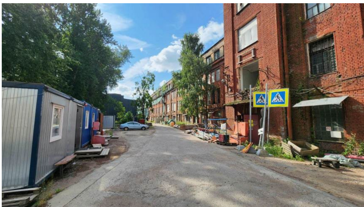
4. Вид от объекта культурного наследия регионального значения «Канатный цех с водонапорной башней завода «Красный гвоздильщик» по адресу: г. Санкт-Петербург, 25-я линия В.О., д. 6, корп. 1, литера Б, на зону производства работ. 14.08.2024
