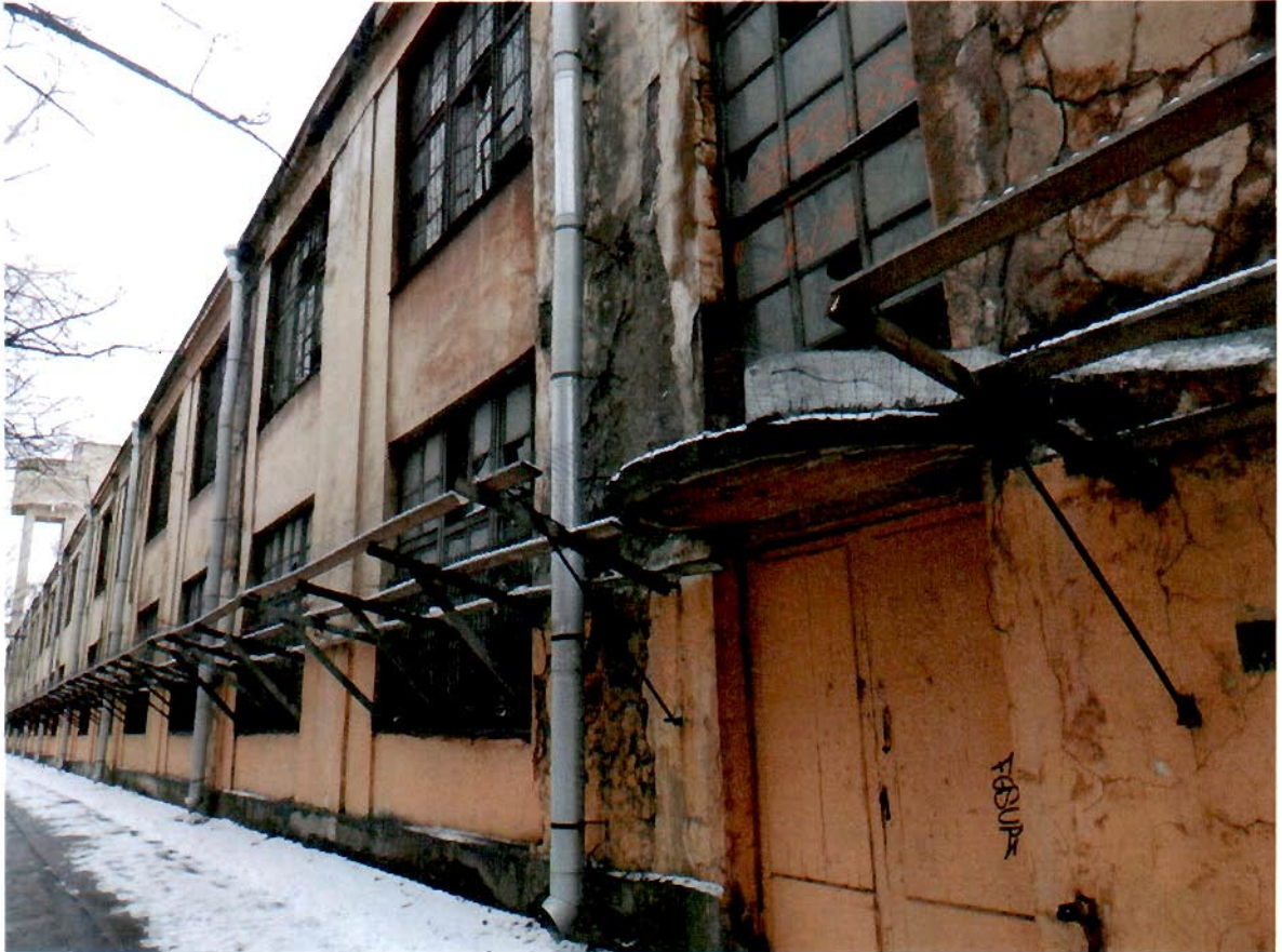
3. Лицевой фасад со стороны 25 линии В.О.
