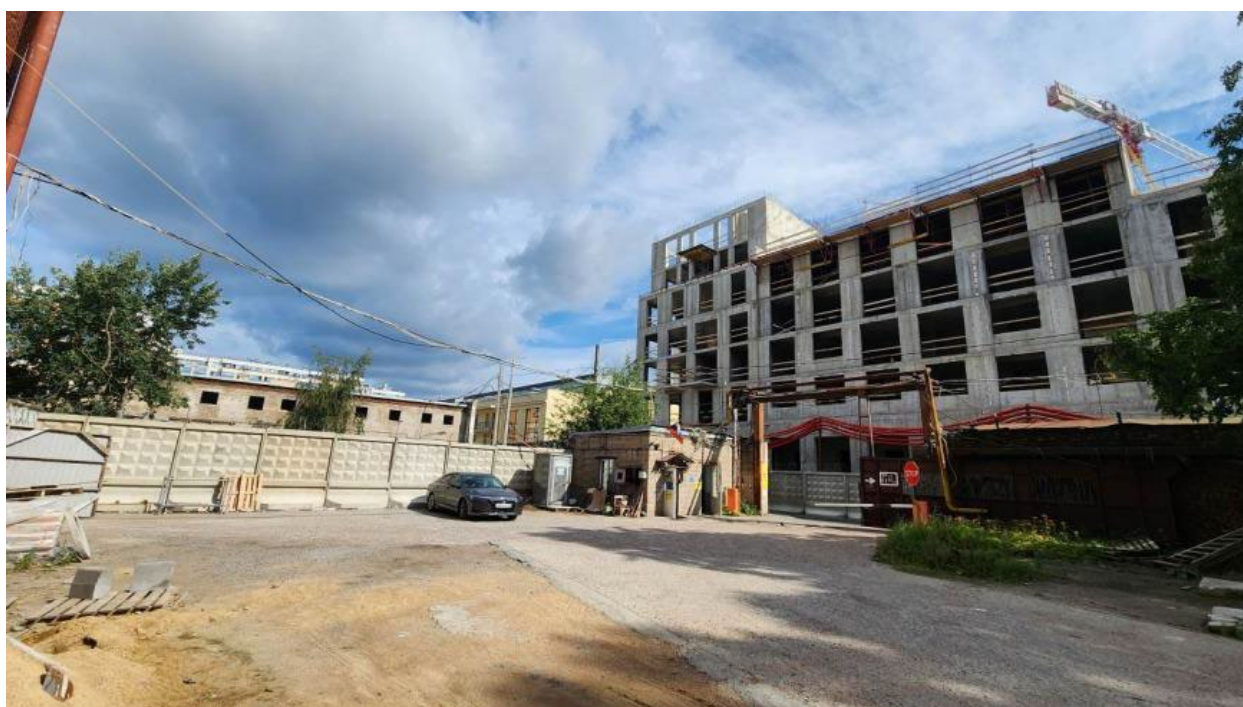
2. Вид от объекта культурного наследия регионального значения «Канатный цех с водонапорной башней завода «Красный гвоздильщик» по адресу: г. Санкт-Петербург, 25-я линия В.О., д. 6, корп. 1, литера Б, на зону производства работ. 14.08.2024
