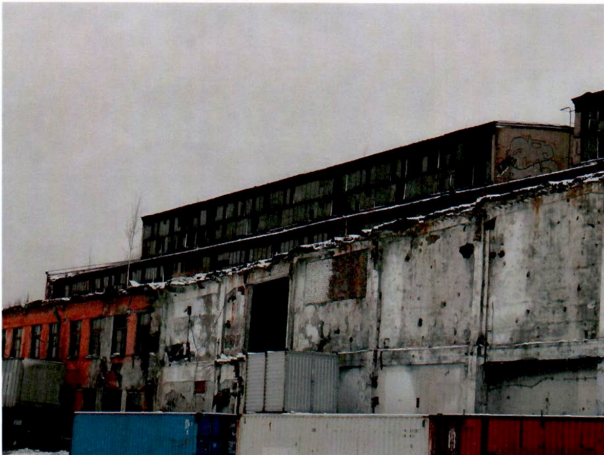
5. Западный дворовый фасад
