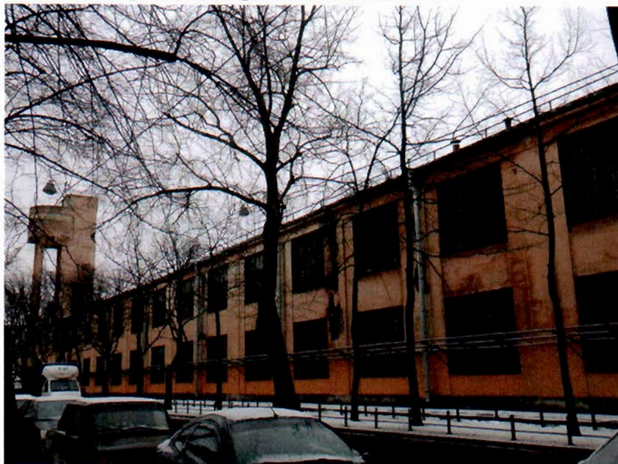
1. Лицевой фасад со стороны 25-й линии В.О.
