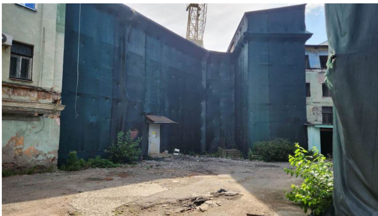
8. Вид на выявленный объект культурного наследия «Кожевенный завод А.А. Парамонова. Особняк владельца», по адресу: г. Санкт-Петербург, Кожевенная линия, д. 1-3, литера Р, от зоны производства работ. 14.08.2024
