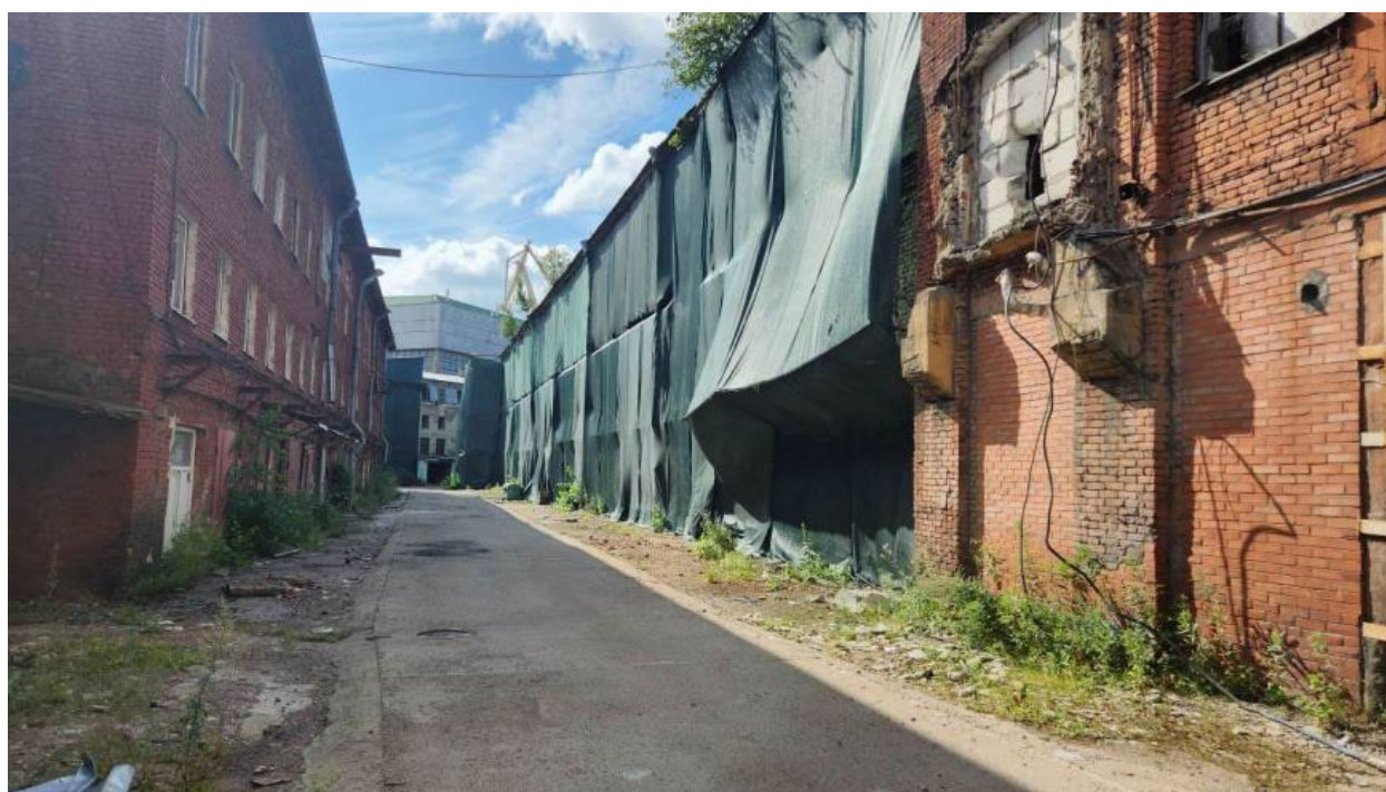
5. Вид на выявленный объект культурного наследия «Кожевенный завод А.А. Парамонова. Котельная», по адресу: г. Санкт-Петербург, Кожевенная линия, д. 1-3, литера Д, со стороны зоны производства работ. 14.08.2024
