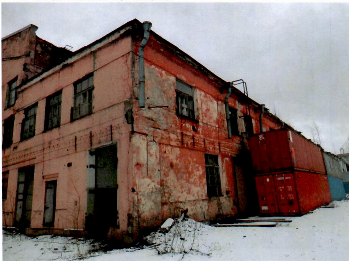
6. Северо-западный дворовый фасад
