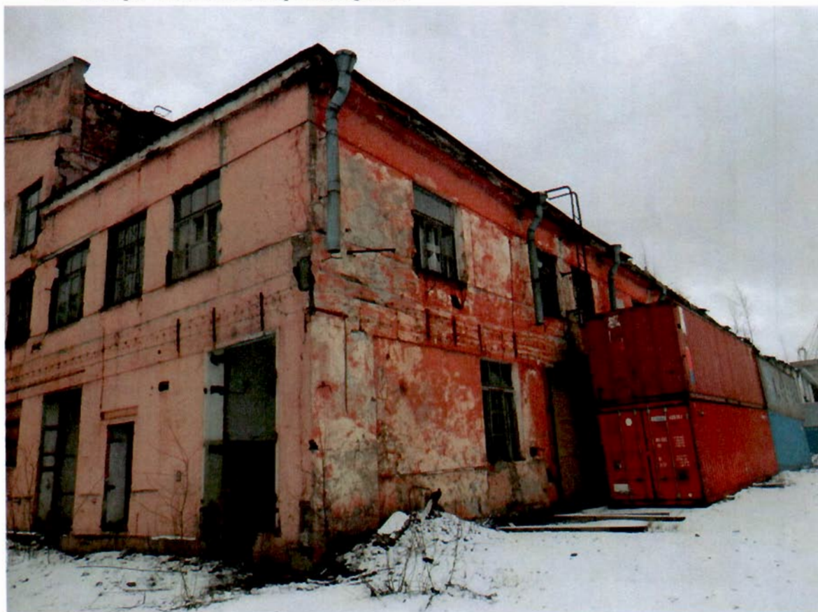
6. Северо-западный дворовый фасад
