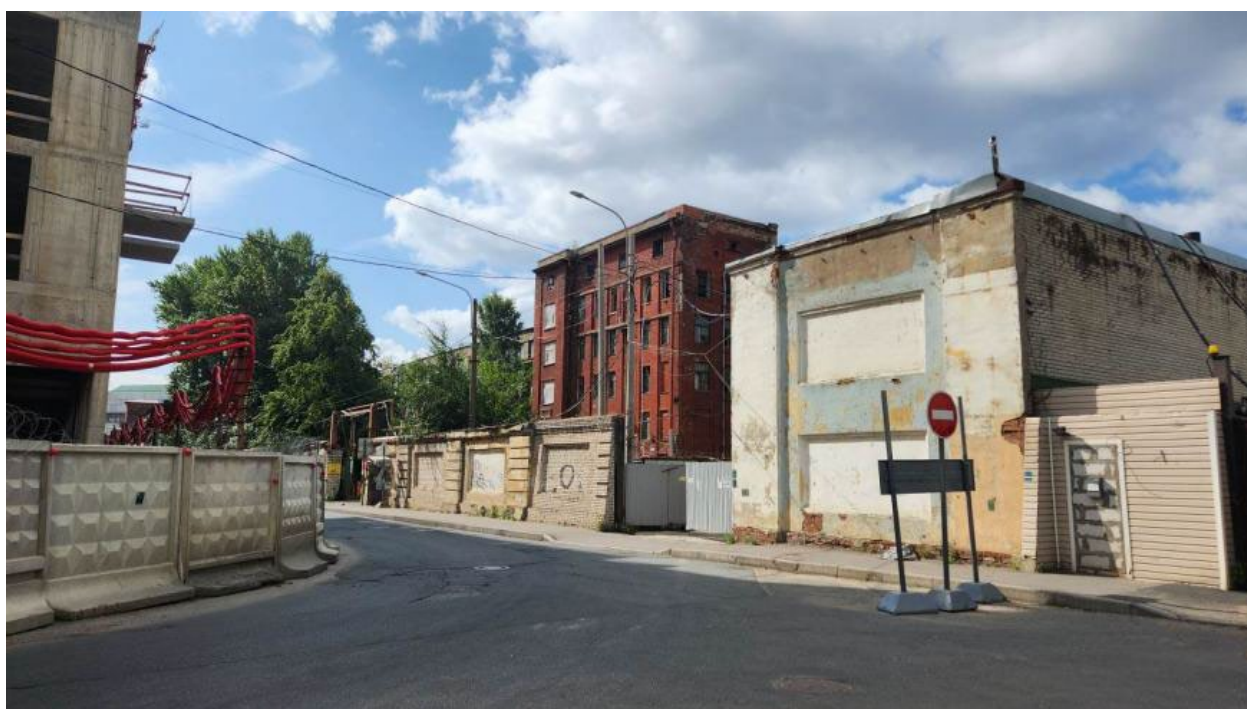
3. Вид от объекта культурного наследия регионального значения «Канатный цех с водонапорной башней завода «Красный гвоздильщик» по адресу: г. Санкт-Петербург, 25-я линия В.О., д. 6, корп. 1, литера Б, на зону производства работ. 14.08.2024
