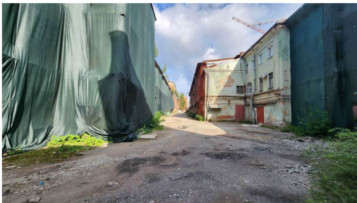
9. Вид на выявленный объект культурного наследия «Кожевенный завод А.А. Парамонова. Особняк владельца», по адресу: г. Санкт-Петербург, Кожевенная линия, д. 1-3, литера Р, от зоны производства работ. 14.08.2024
