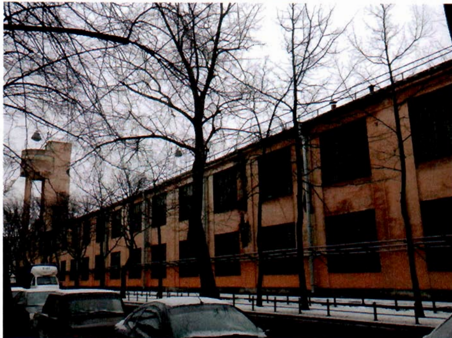
1. Лицевой фасад со стороны 25-й линии В.О.
