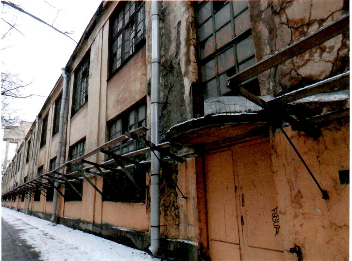
3. Лицевой фасад со стороны 25 линии В.О.
