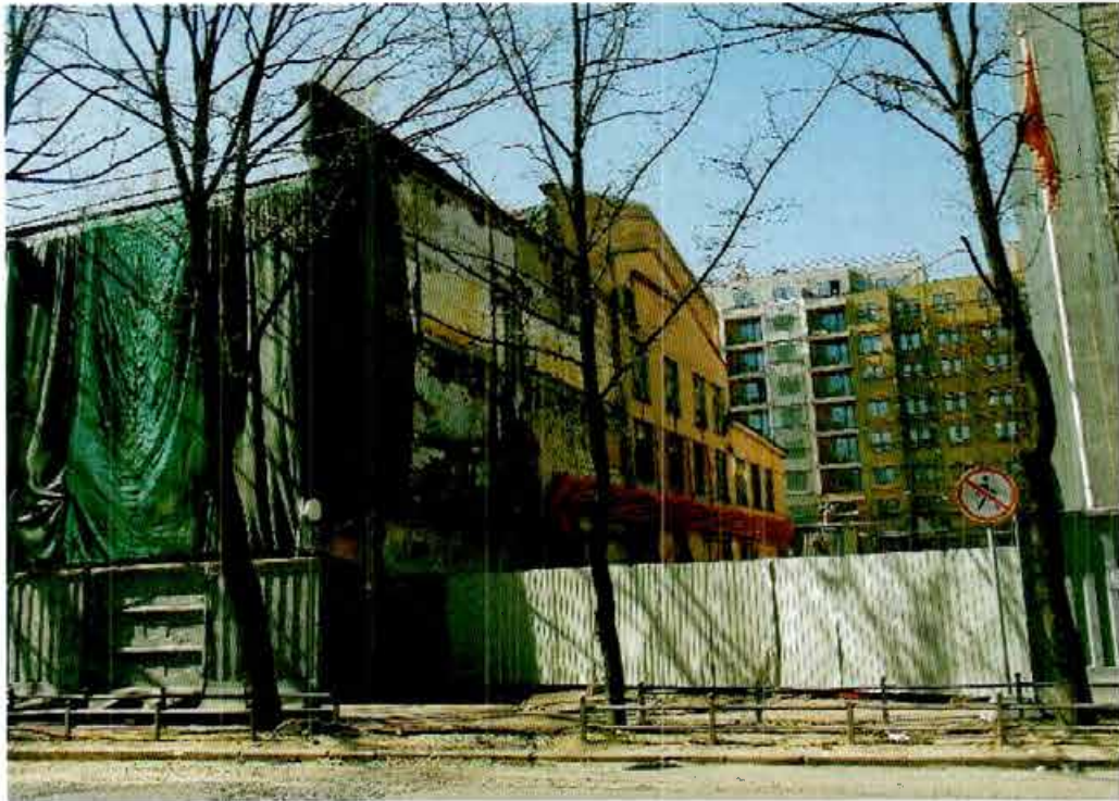
2. Вид на северо-западный фасад.
