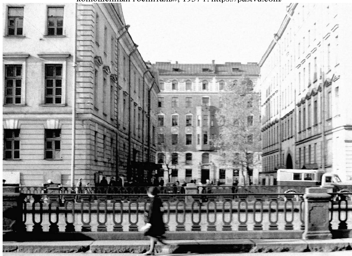
13. Вид на объект культурного наследия регионального значения «Придворно–конюшенный госпиталь», 1960-е гг. https://pastvu.com/
