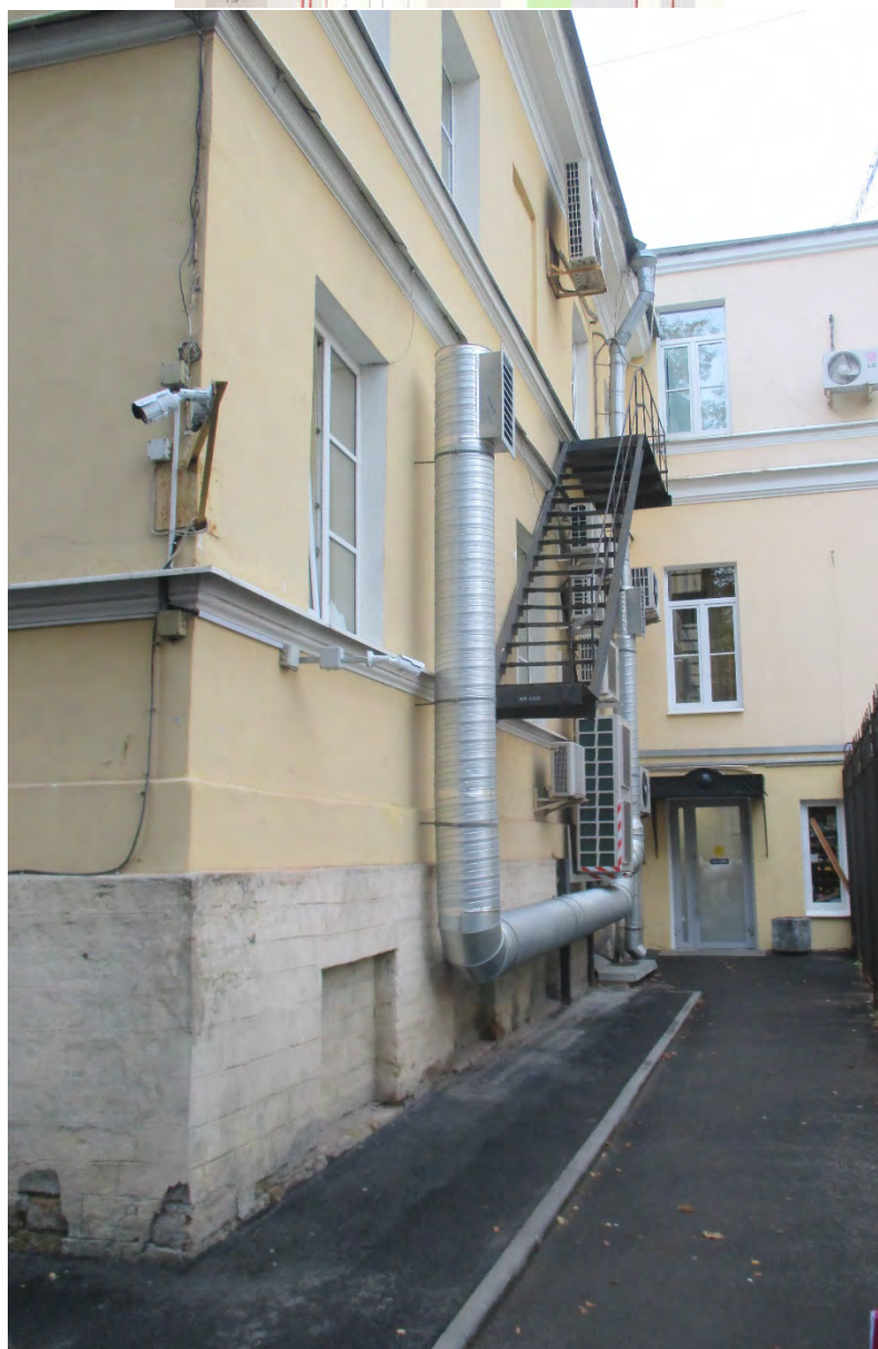
18. Объект культурного наследия регионального значения «9-я солдатская казарма», по адресу: Санкт-Петербург, ул. Радищева, д.39, литера А. Фрагмент дворового фасада. Дата съемки: 22.08.2024г.
