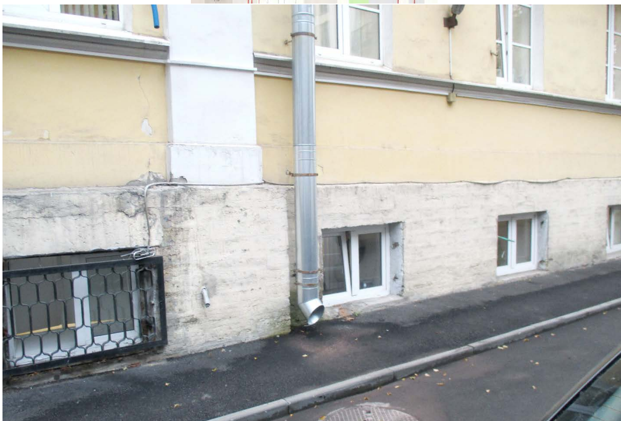
10. Объект культурного наследия регионального значения «9-я солдатская казарма», по адресу: Санкт-Петербург, ул. Радищева, д.39, литера А. Фрагмент дворового фасада. Дата съемки: 22.08.2024г.
