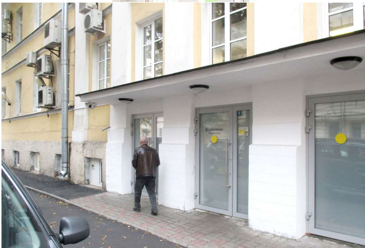
11. Объект культурного наследия регионального значения «9-я солдатская казарма», по адресу: Санкт-Петербург, ул. Радищева, д.39, литера А. Фрагмент дворового фасада. Дата съемки: 22.08.2024г.
