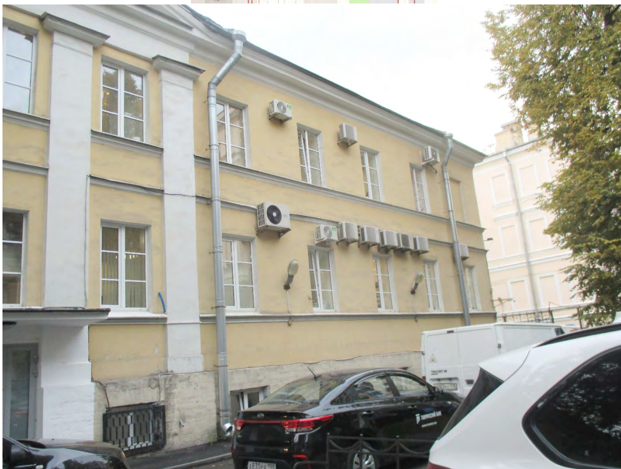
13. Объект культурного наследия регионального значения «9-я солдатская казарма», по адресу: Санкт-Петербург, ул. Радищева, д.39, литера А. Фрагмент дворового фасада. Дата съемки: 22.08.2024г.
