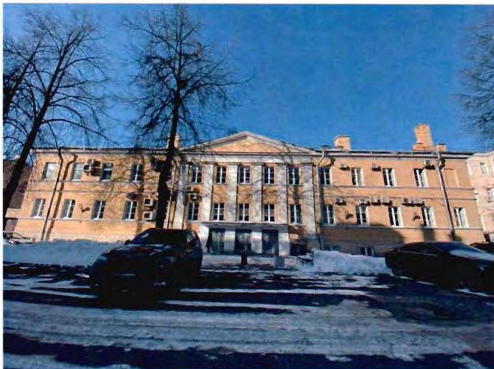
2. Восточный фасад объекта культурного наследия.
