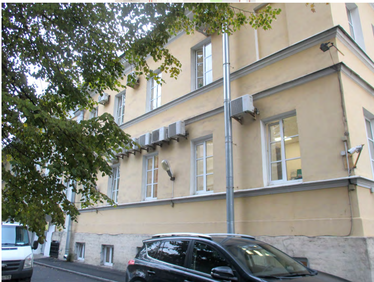
14. Объект культурного наследия регионального значения «9-я солдатская казарма», по адресу: Санкт-Петербург, ул. Радищева, д.39, литера А. Фрагмент дворового фасада. Дата съемки: 22.08.2024г.
