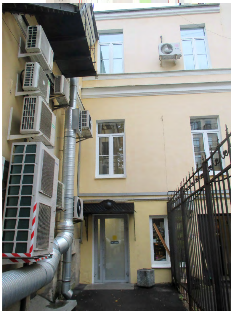
17. Объект культурного наследия регионального значения «9-я солдатская казарма», по адресу: Санкт-Петербург, ул. Радищева, д.39, литера А. Фрагмент дворового фасада. Дата съемки: 22.08.2024г.
