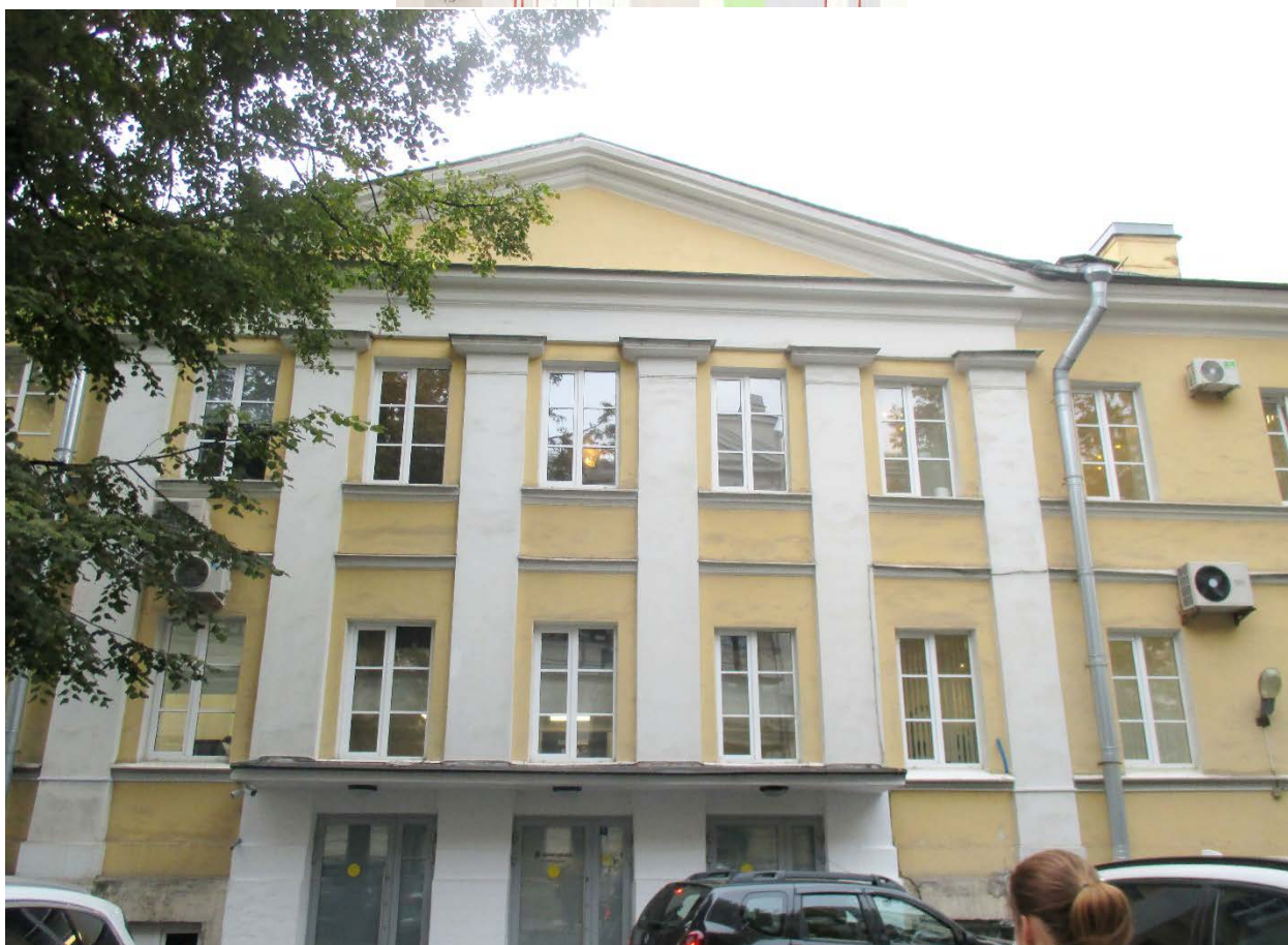
12. Объект культурного наследия регионального значения «9-я солдатская казарма», по адресу: Санкт-Петербург, ул. Радищева, д.39, литера А. Фрагмент дворового фасада. Дата съемки: 22.08.2024г.
