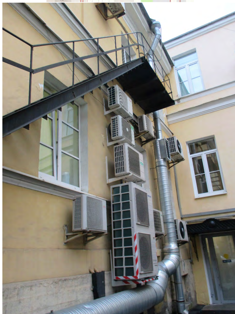
16. Объект культурного наследия регионального значения «9-я солдатская казарма», по адресу: Санкт-Петербург, ул. Радищева, д.39, литера А. Фрагмент дворового фасада. Дата съемки: 22.08.2024г.
