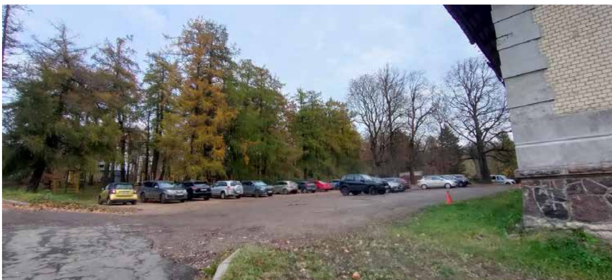
Фото 2. Общий вид территории с юго-запада в восточном направлении от западного фасада объекта культурного наследия федерального значения «Больница общины Святого Георгия»
