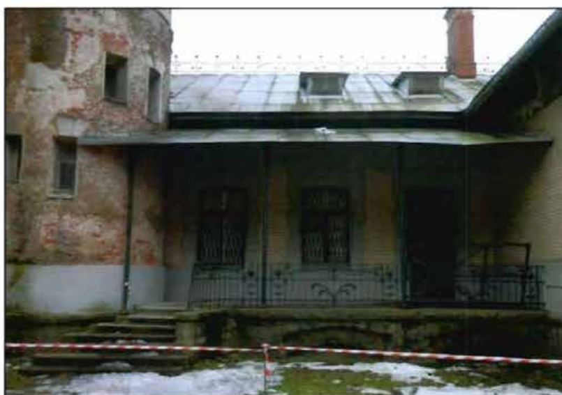
6. «Больница общины Святого Георгия». Северный фасад. Фрагмент. Крыльцо-терраса.
