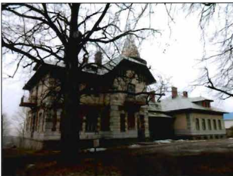
4. «Больница общины Святого Георгия». Общий вид с северо-востока.
