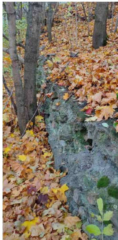
Фото 28. Вид на прилегающую территорию к южному фасаду в западном направлении
