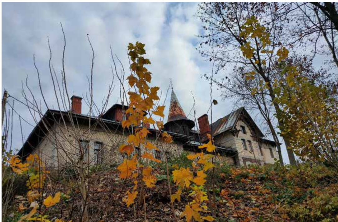
Фото 20. Вид на южный фасад объекта культурного наследия федерального значения «Больница общины Святого Георгия» с прилегающей территорией
