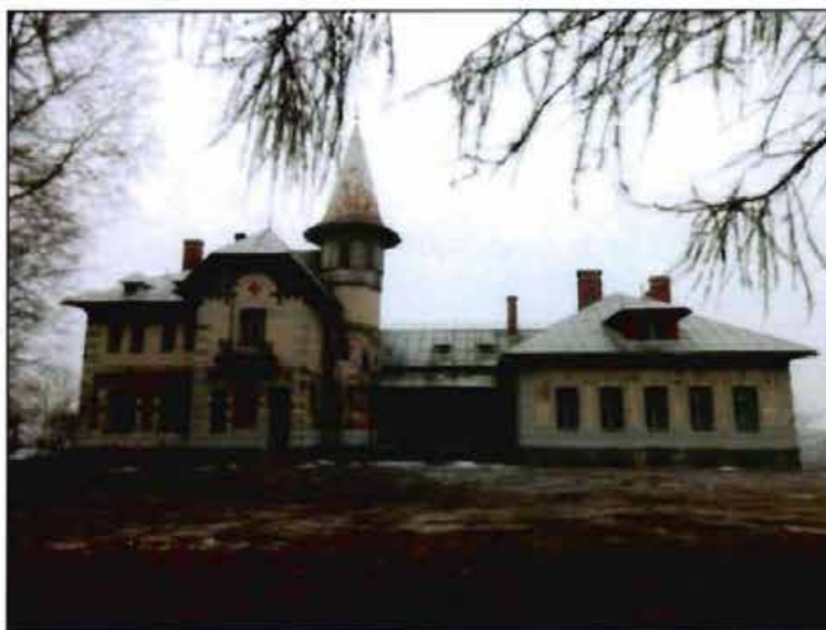
1. «Больница общины Святого Георгия». Северный фасад. Общий вид.
