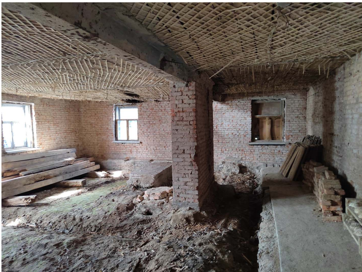
Фото 17. Внутренние помещения. Опорный столб из кирпича.
