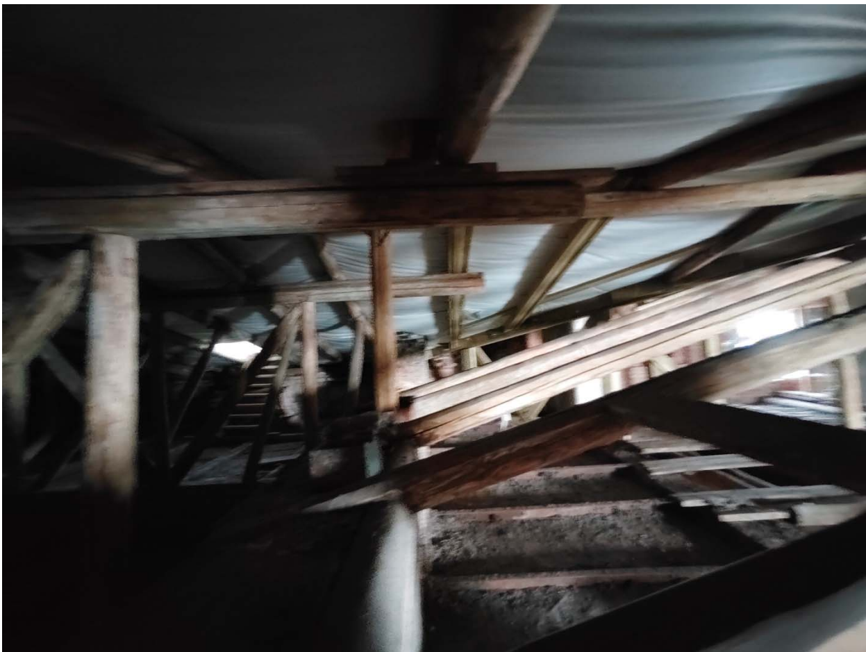
Фото 41. Чердак. Несущие конструкции крыши.
