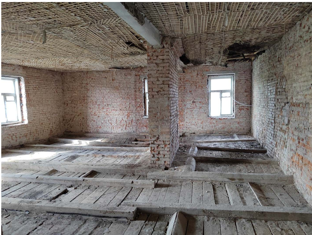
Фото 35. Помещения второго этажа.
