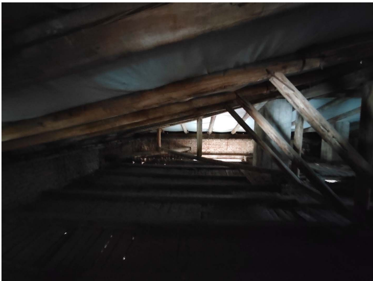
Фото 40. Чердак. Несущие конструкции крыши.
