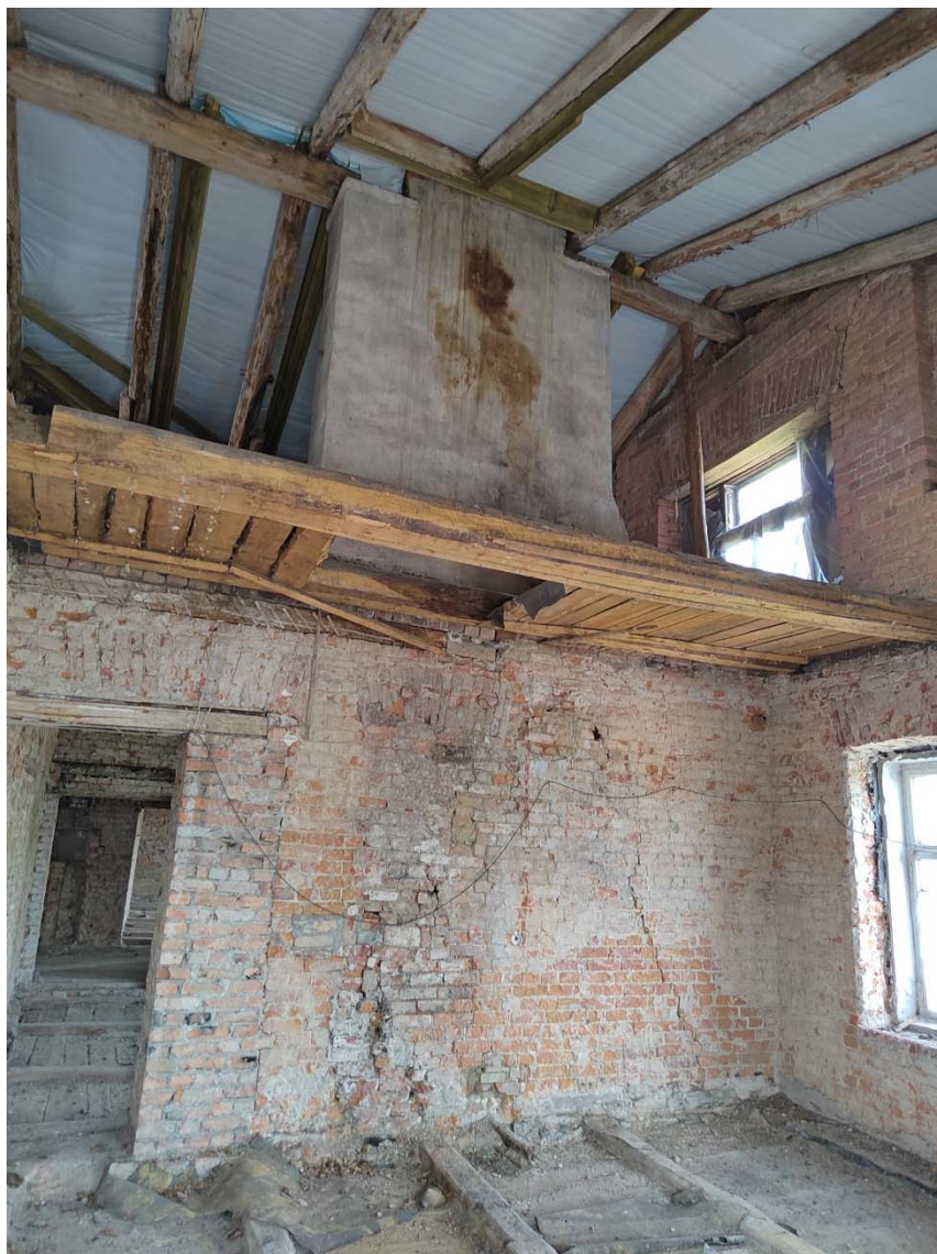
Фото 37. Помещения второго этажа.
