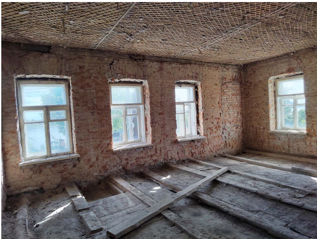
Фото 34. Помещения второго этажа.
