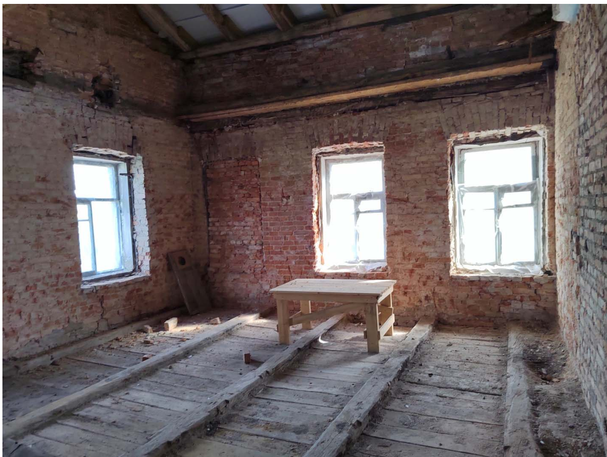
Фото 38. Помещения второго этажа.
