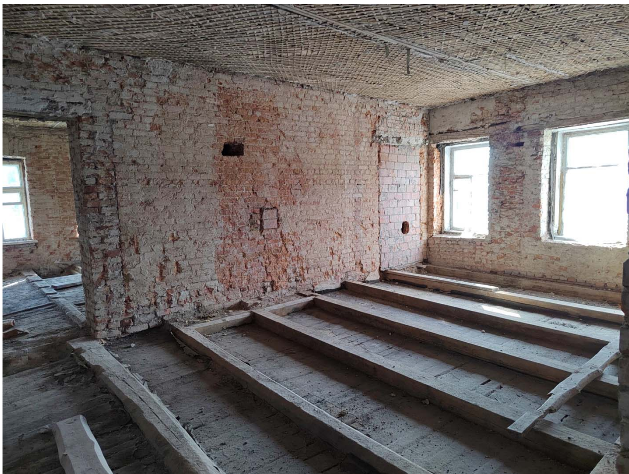
Фото 33. Помещения второго этажа.
