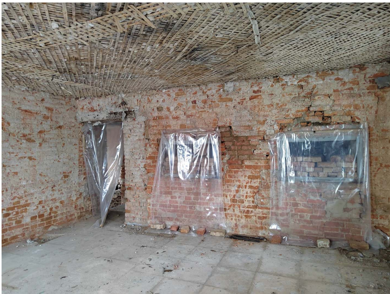
Фото 22. Помещение 1 этажа. Заложенные проемы.
