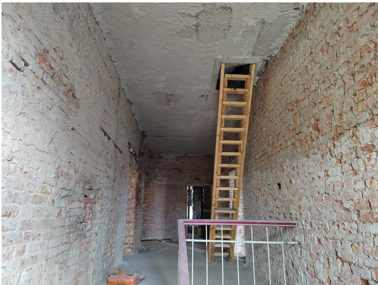
Фото 32. Подъем на чердак.
