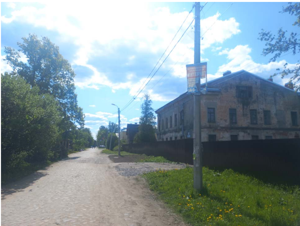
Фото 9. Контур 1 Достопримечательного места. Выявленный объект культурного наследия “Дом Захаровых”, расположенный в границах Достопримечательного места. Бульжное мощение шоссе на участке проектирования.
