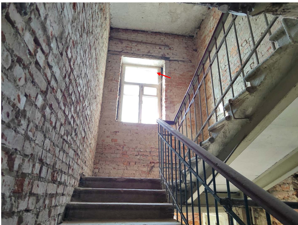
Фото 30. Площадка лестницы между этажами.
