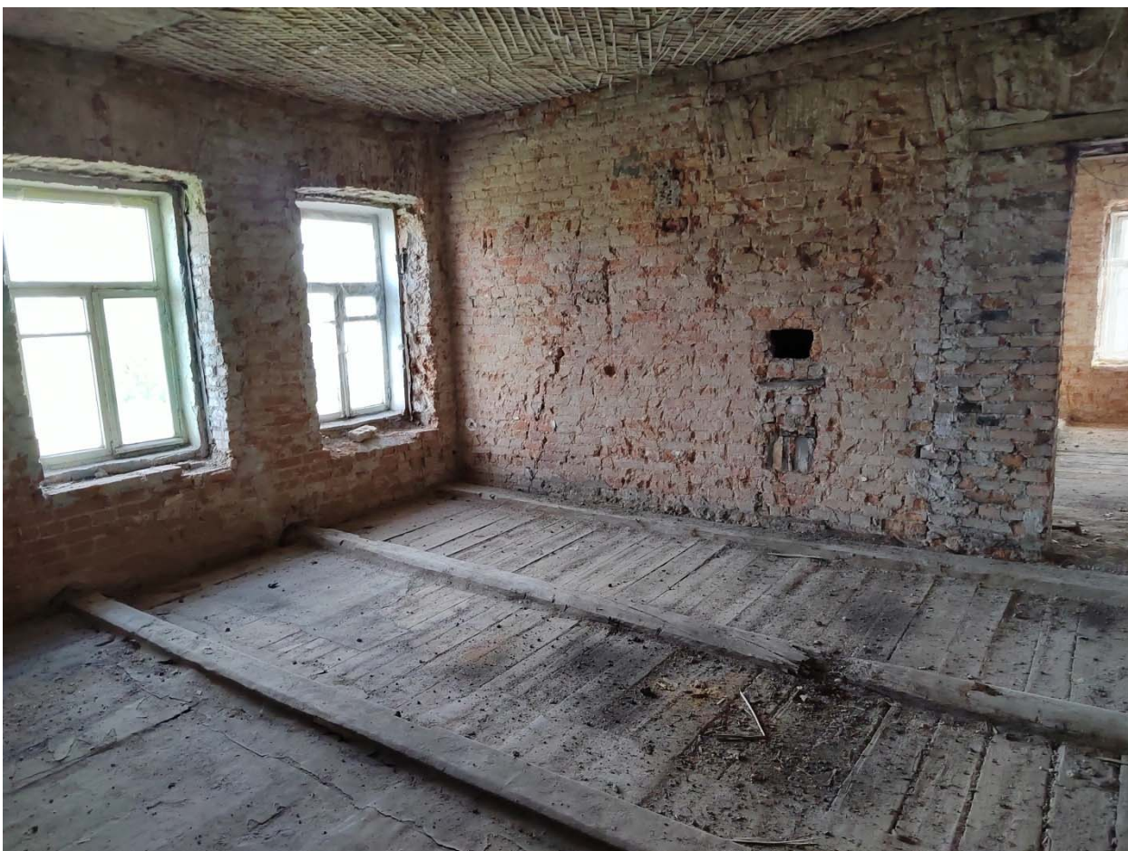
Фото 36. Помещения второго этажа.
