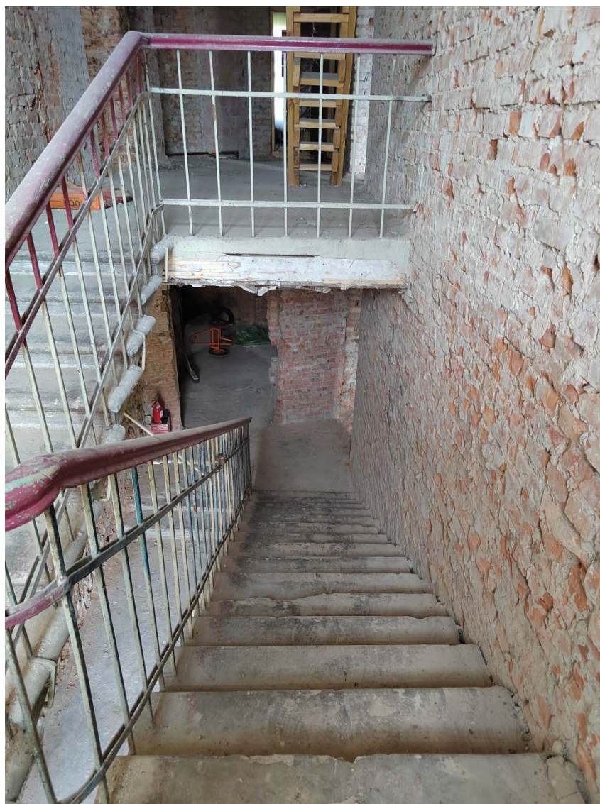
Фото 31. Лестница. Вид с площадки.
