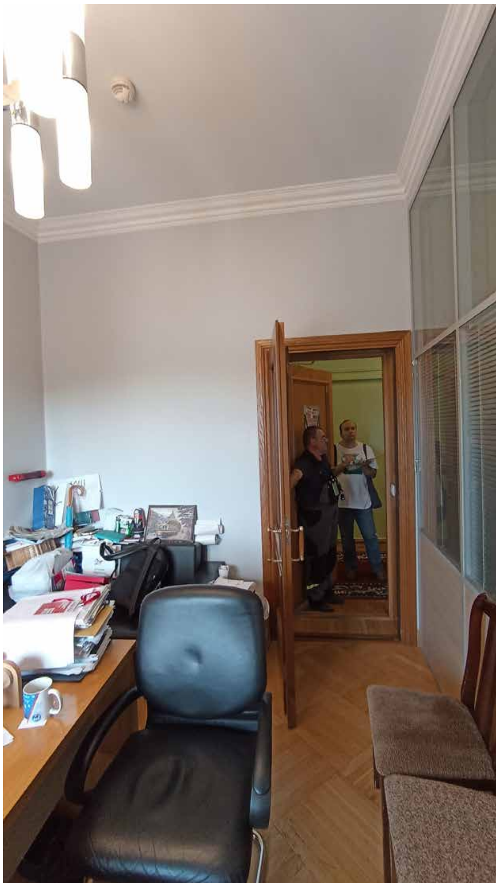
76. 5-й этаж, помещение 516. Вид на место предполагаемой установки кондиционера (над дверным проемом).
