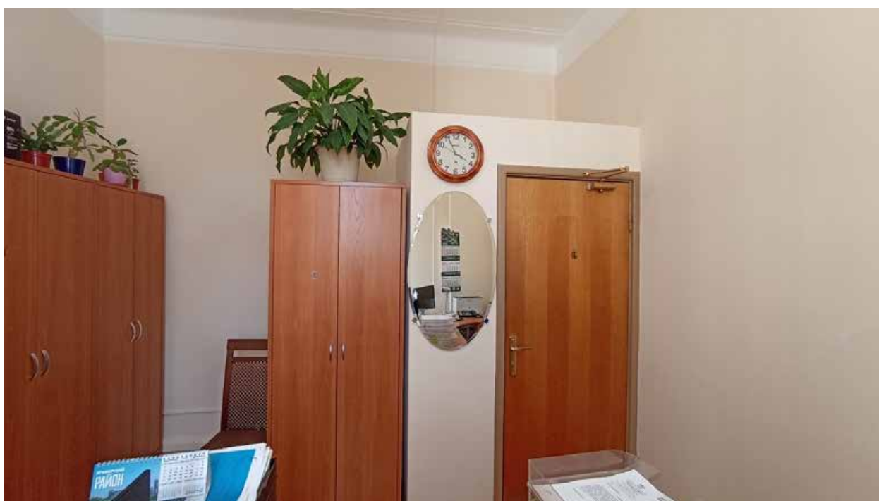
58. 4-й этаж, помещение 419. Вид на место предполагаемой установки кондиционера (над дверным проемом).
