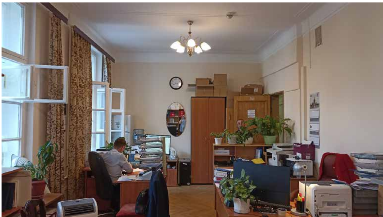
53. 4-й этаж, помещение 410. Вид на место предполагаемой установки кондиционера (над дверным проемом).
