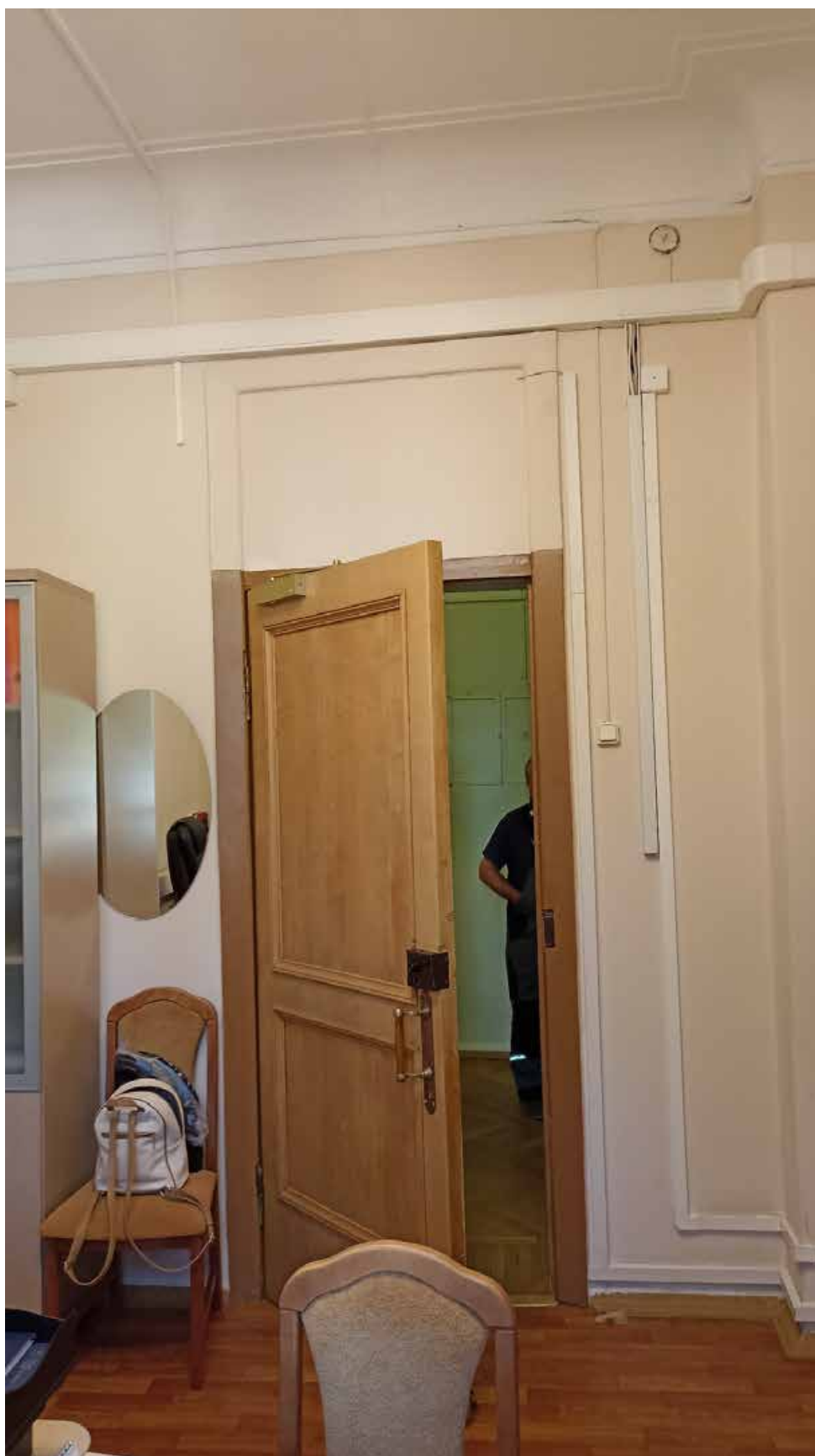
40. 3-й этаж, помещение 310. Вид на место предполагаемой установки кондиционера (над дверным проемом).
