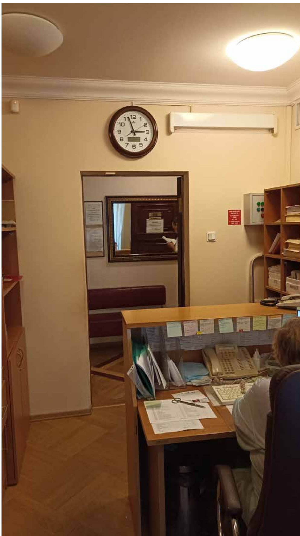
32. 2-й этаж, помещение 214.1. Вид на место предполагаемой установки кондиционера (над дверным проемом).
