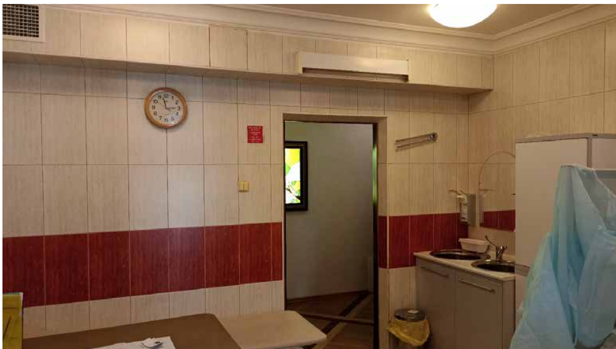
30. 2-й этаж, помещение 213. Вид на место предполагаемой установки кондиционера (над дверным проемом).
