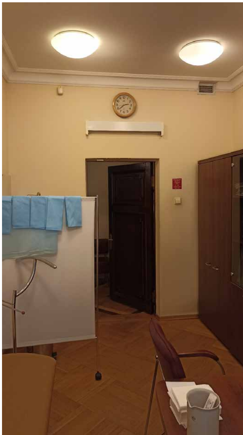
14. 1-й этаж, помещение 112. Вид на место предполагаемой установки кондиционера (над дверным проемом).
