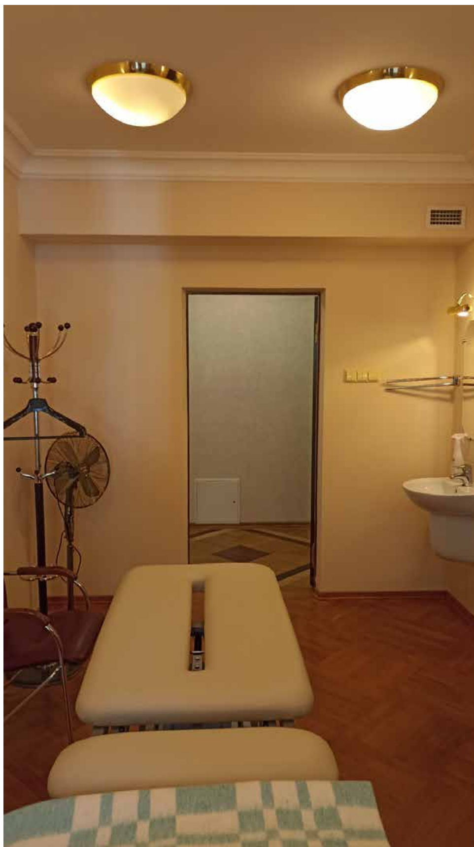
25. 2-й этаж, помещение 208. Вид на место предполагаемой установки кондиционера (над дверным проемом).
