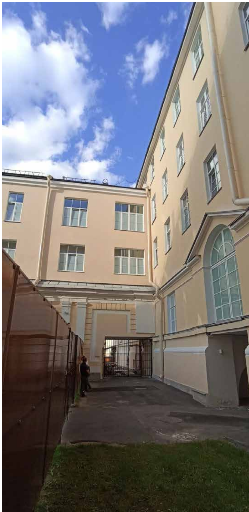
8. Южная часть западного фасада, вид снизу, с юго-запада.
