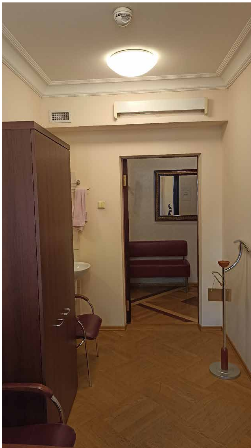
28. 2-й этаж, помещение 212. Вид на место предполагаемой установки кондиционера (над дверным проемом).
