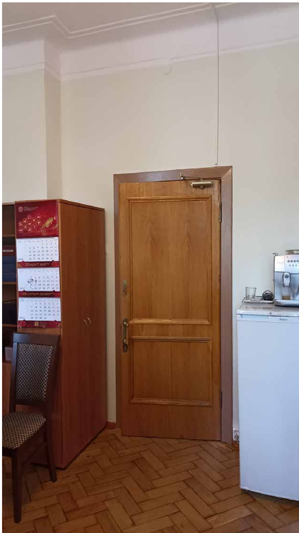
52. 4-й этаж, помещение 408. Вид на место предполагаемой установки кондиционера (над дверным проемом).
