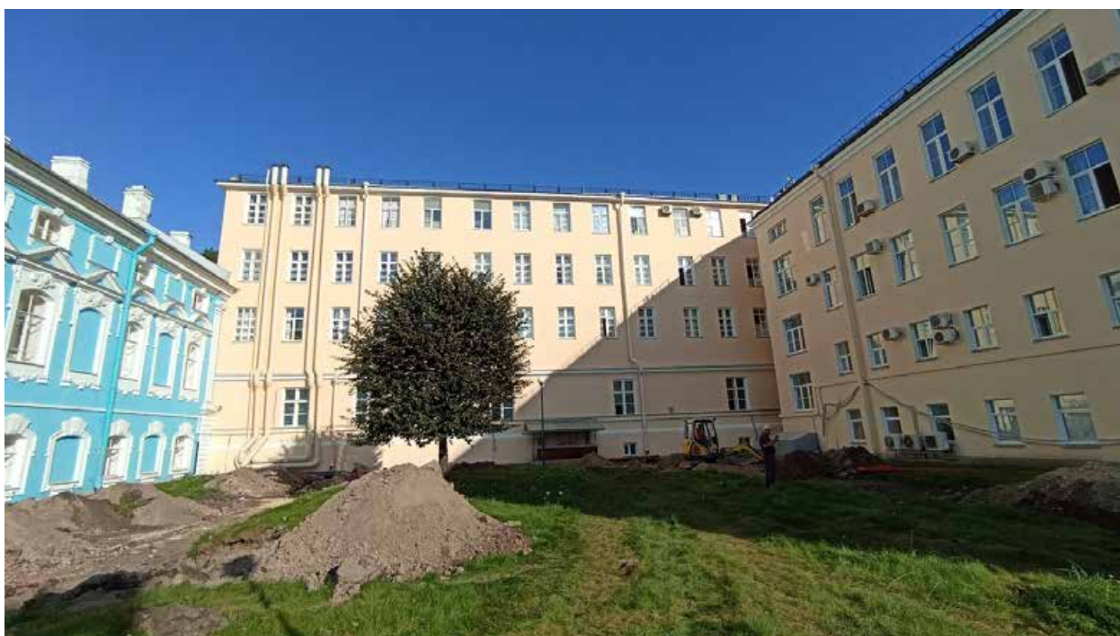
6. Вид на северную часть западного фасада с запада.
