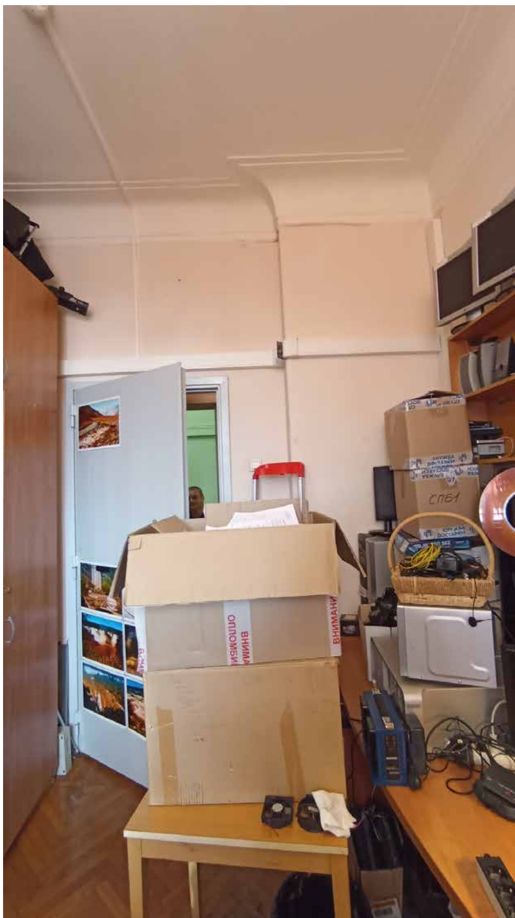
77. 5-й этаж, помещение 521. Вид на место предполагаемой установки кондиционера (над дверным проемом).
