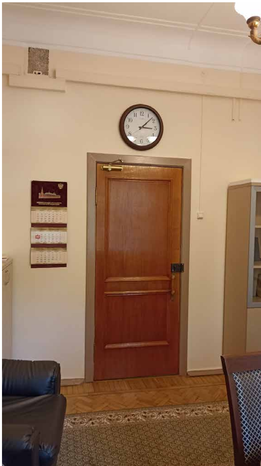
41. 3-й этаж, помещение 311. Вид на место предполагаемой установки кондиционера (над дверным проемом).
