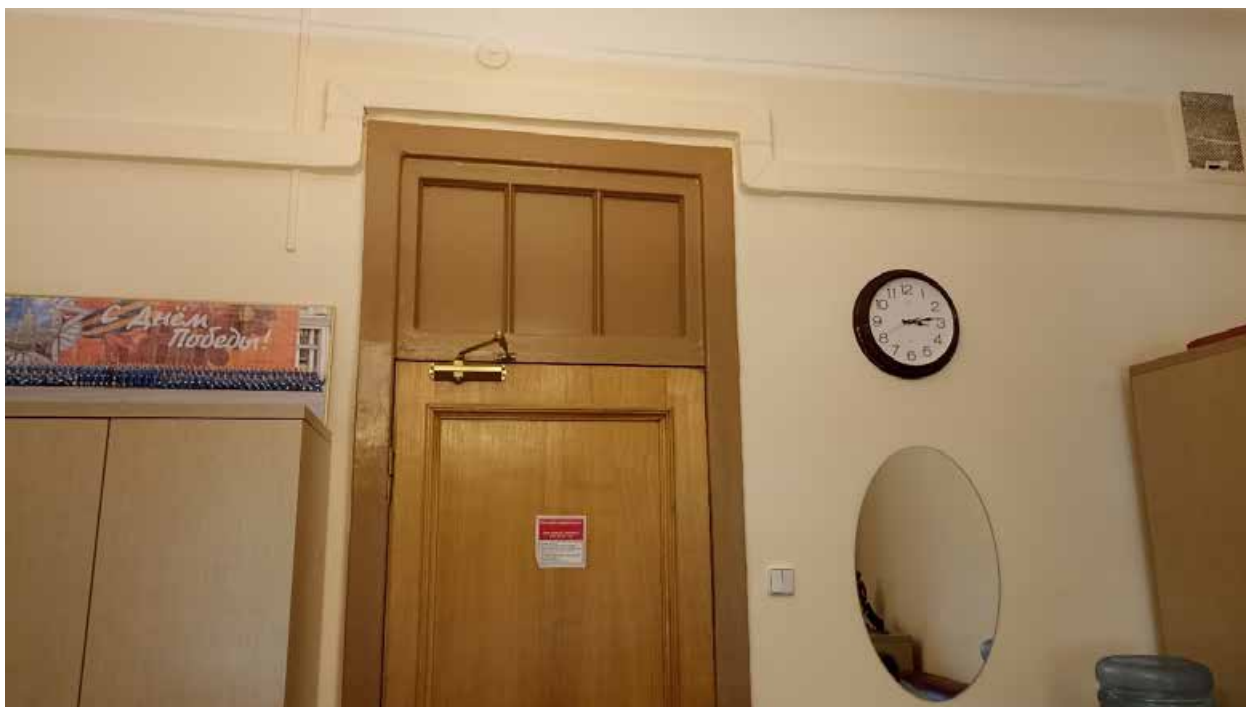
37. 3-й этаж, помещение 303. Вид на место предполагаемой установки кондиционера (над дверным проемом).
