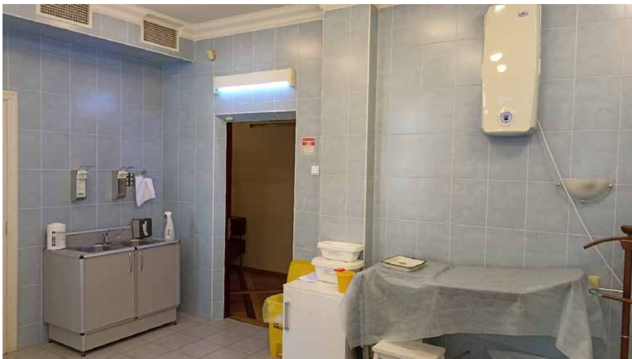
12. 1-й этаж, помещение 110. Вид на место предполагаемой установки кондиционера (над дверным проемом).
