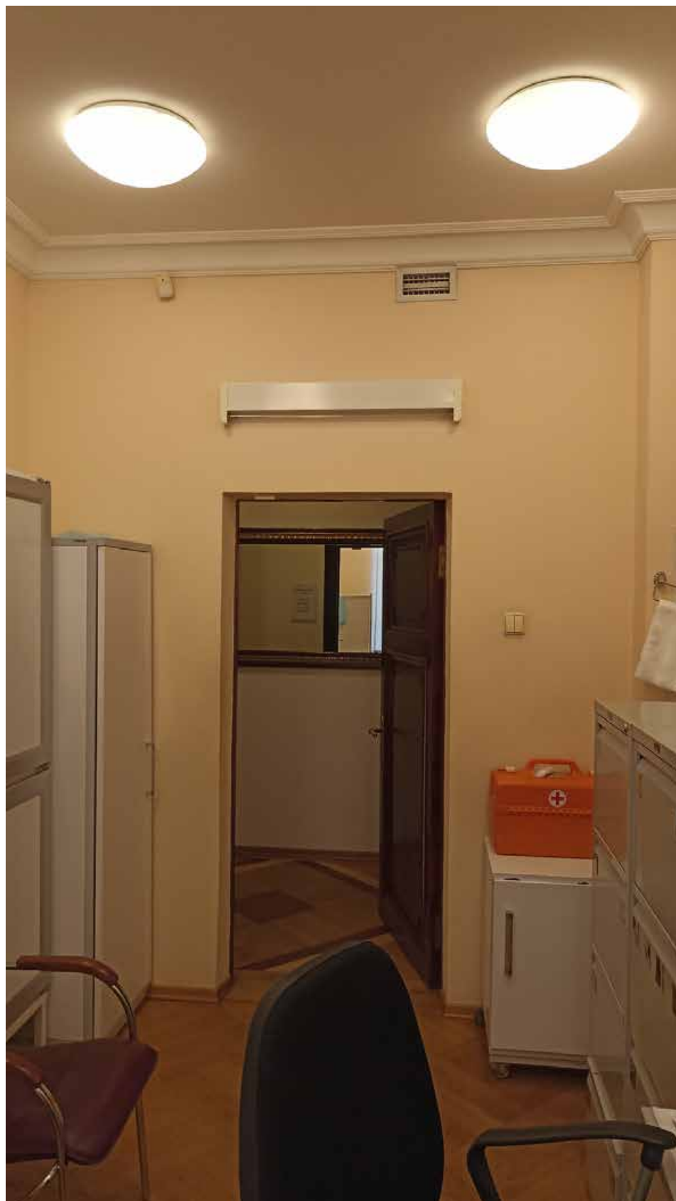
15. 1-й этаж, помещение 113. Вид на место предполагаемой установки кондиционера (над дверным проемом).
