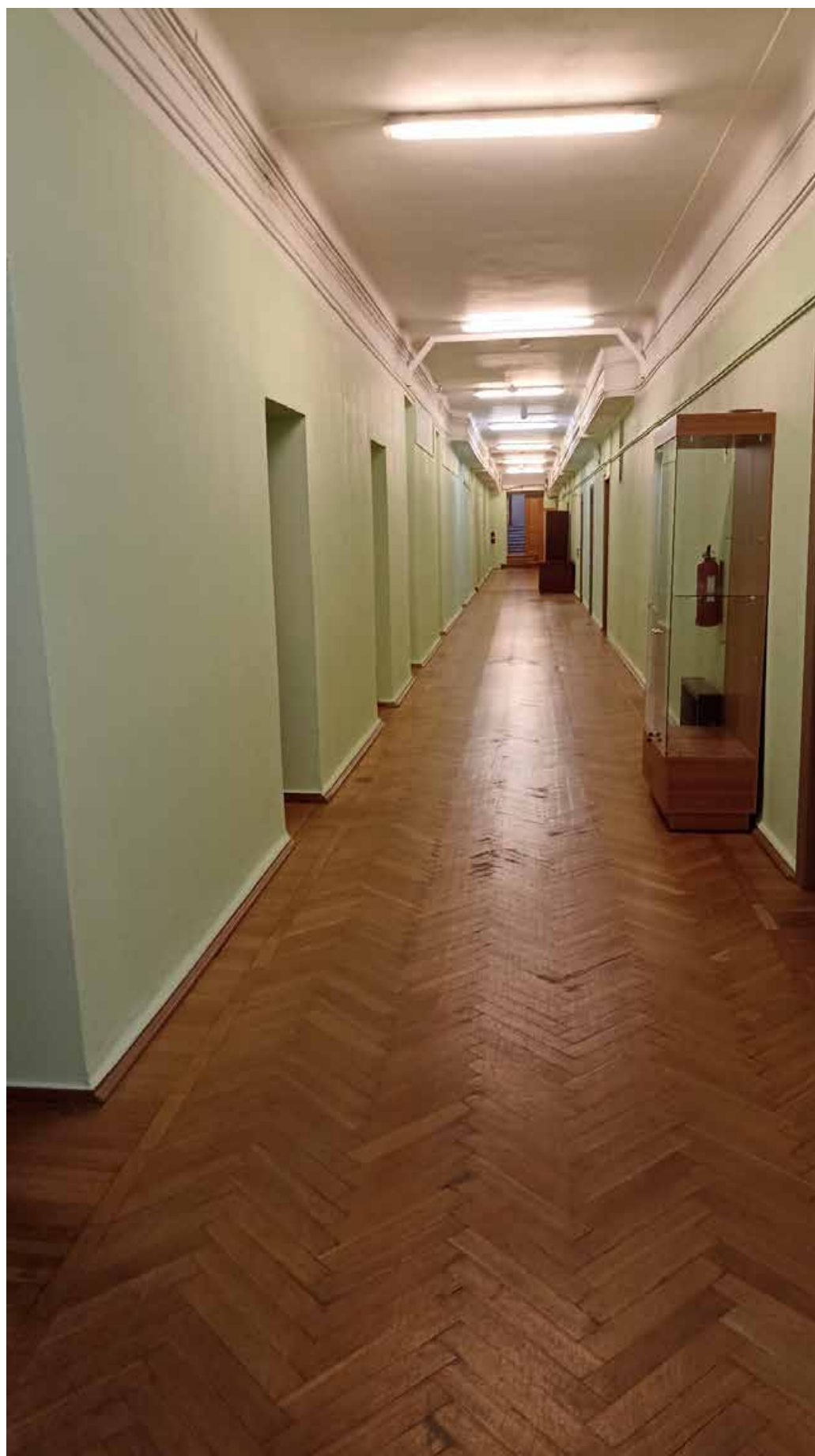
35. Коридор 3-го этажа
