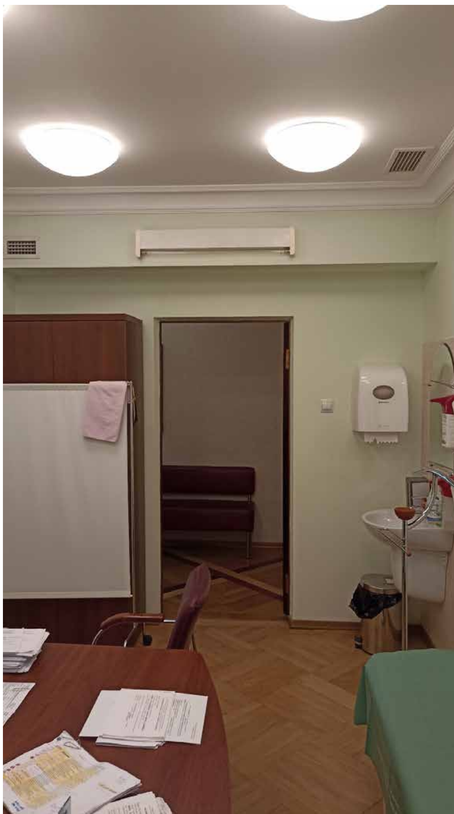
23. 2-й этаж, помещение 204. Вид на место предполагаемой установки кондиционера (над дверным проемом).
