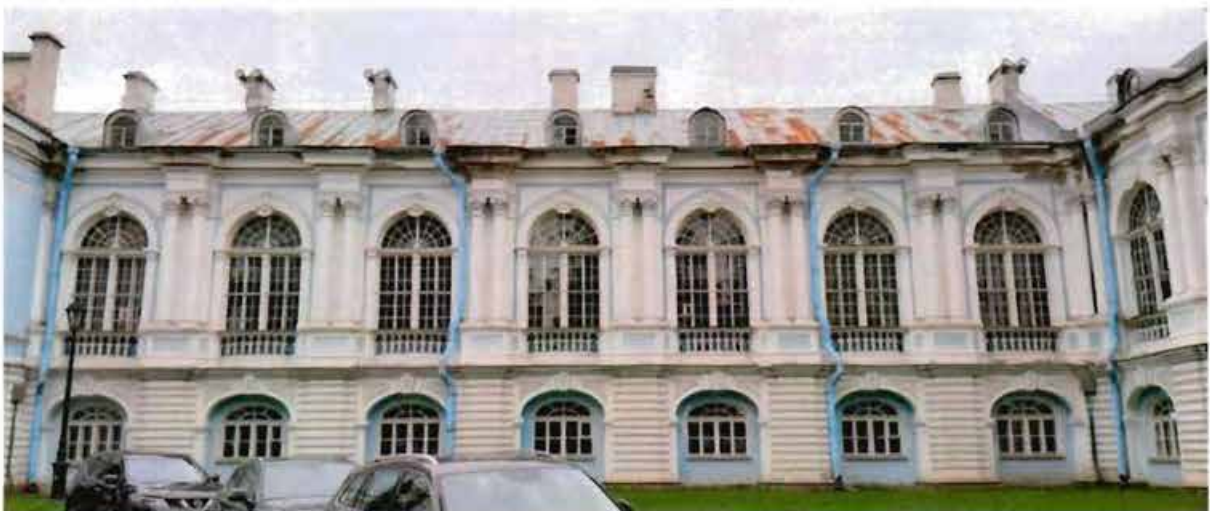
2. Восточный фасад северо-западного корпуса
