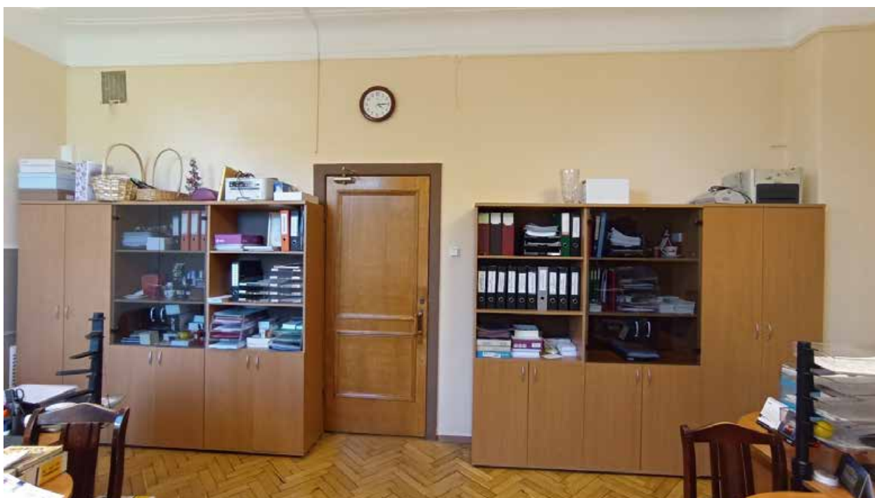
74. 5-й этаж, помещение 512. Вид на место предполагаемой установки кондиционера (над дверным проемом).
