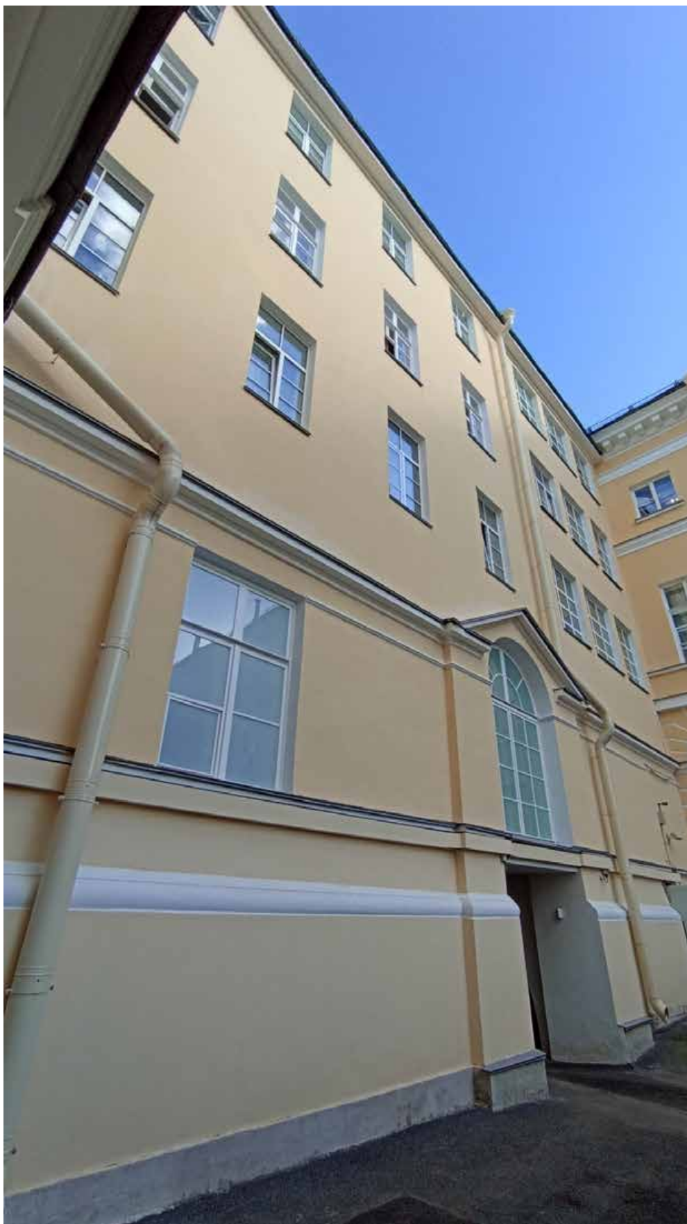
7. Южная часть западного фасада, вид снизу, с северо-запада.
