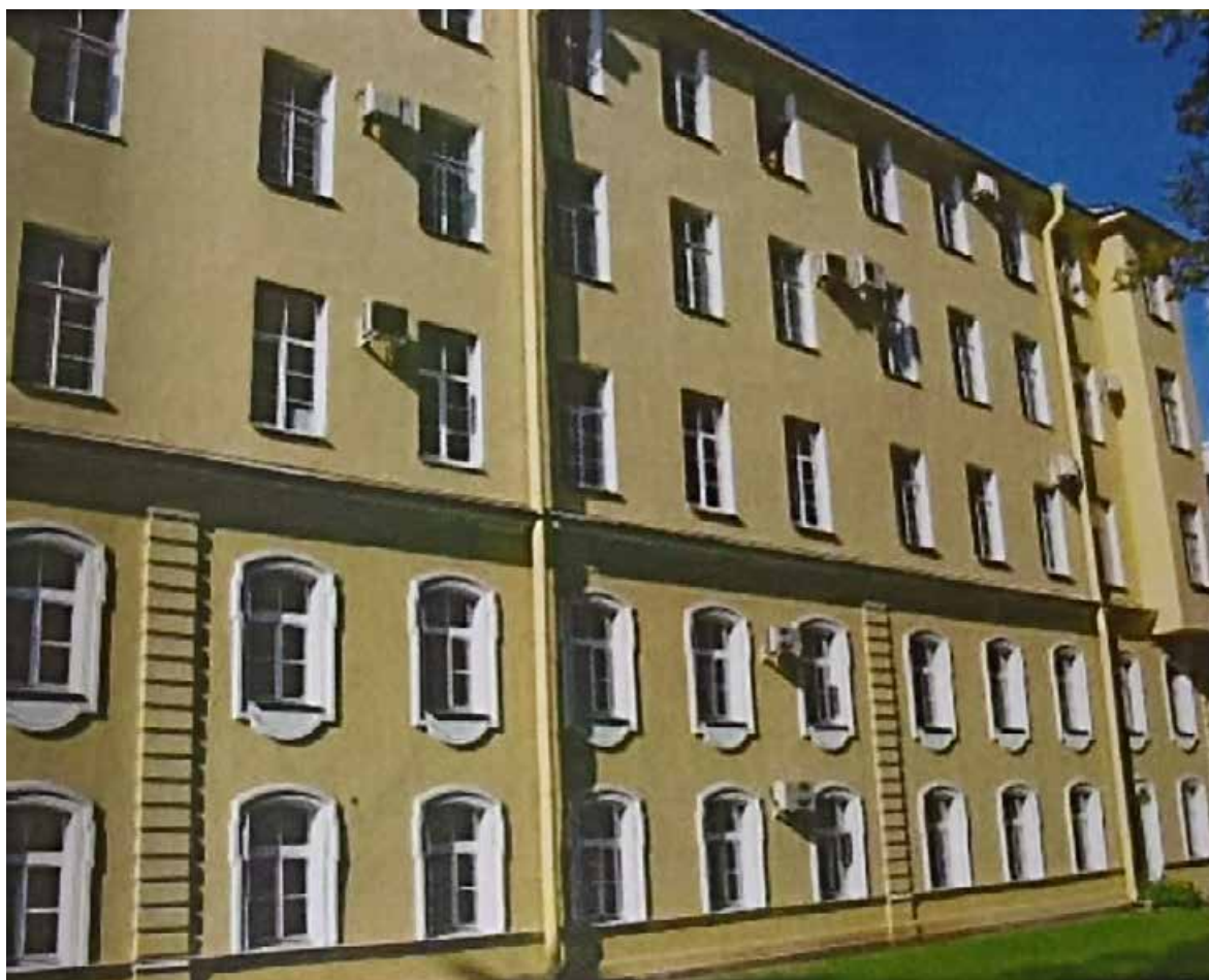
18. Северная часть восточного фасада юго-восточного корпуса. Фото 01.03.2015. Акт по результатам ГИКЭ документов, обосновывающих включение ОКН фед. значения «Корпуса жилые (каре) с угловыми церквями», входящими в состав ОКН фед. Значения «Смольный монастырь «...».
