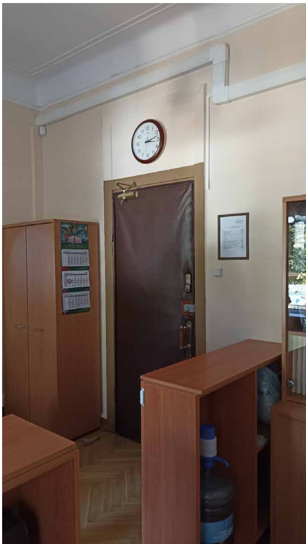
38. 3-й этаж, помещение 304. Вид на место предполагаемой установки кондиционера (над дверным проемом).
