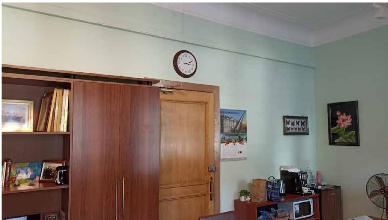
39. 3-й этаж, помещение 308. Вид на место предполагаемой установки кондиционера (над дверным проемом).
