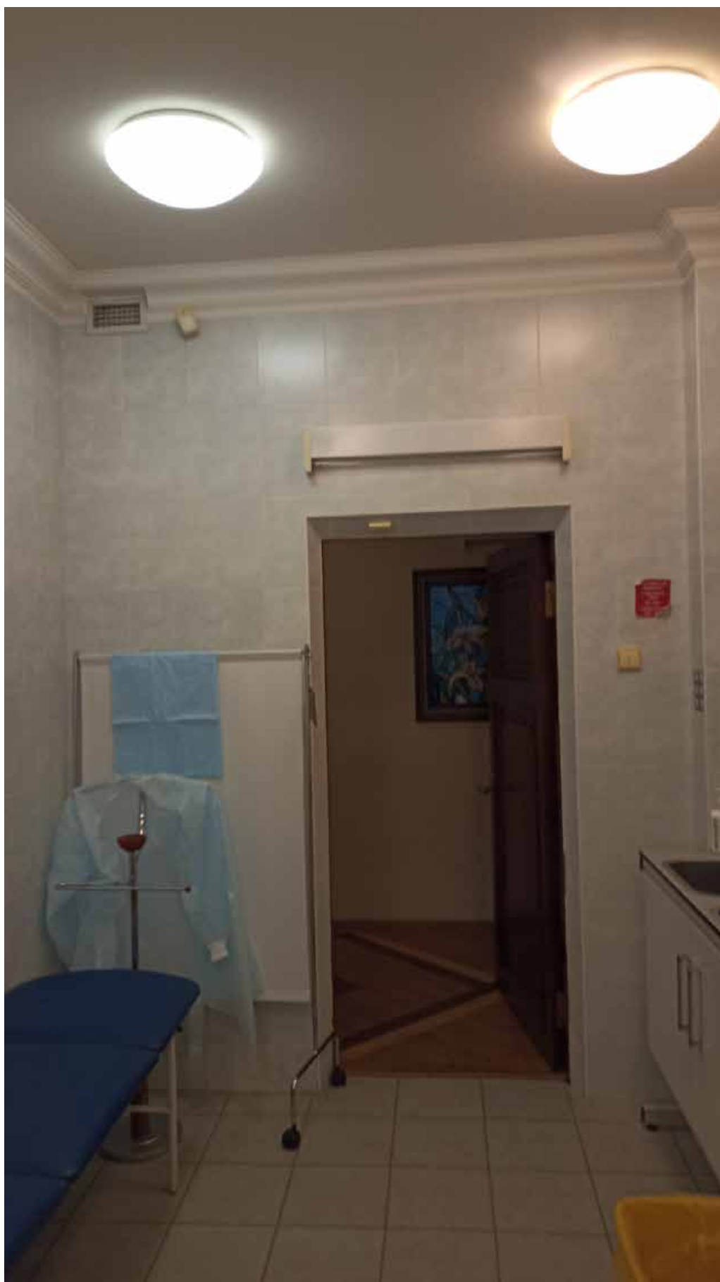
11. 1-й этаж, помещение 109. Вид на место предполагаемой установки кондиционера (над дверным проемом).
