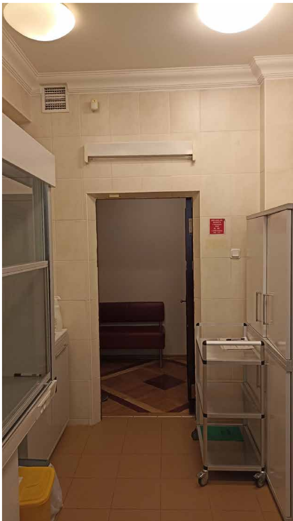
10. 1-й этаж, помещение 107. Вид на место предполагаемой установки кондиционера (над дверным проемом).
