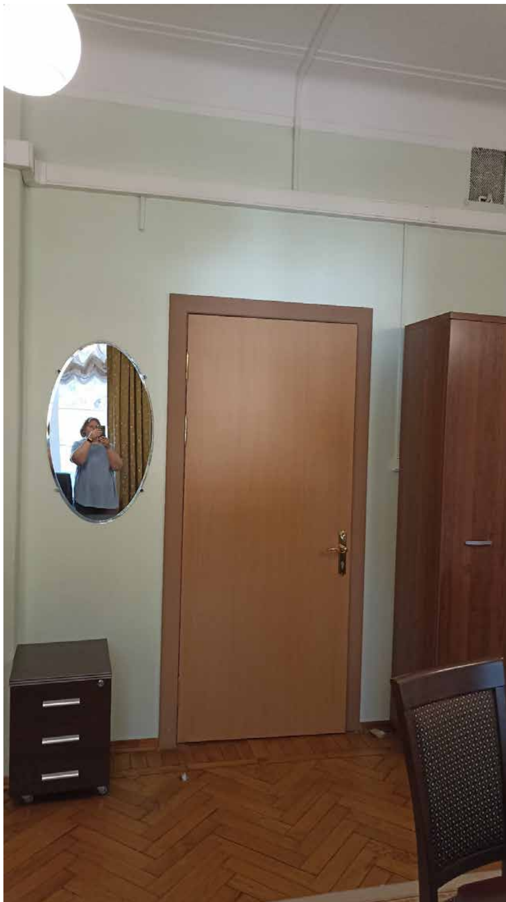
36. 3-й этаж, помещение 302. Вид на место предполагаемой установки кондиционера (над дверным проемом).
