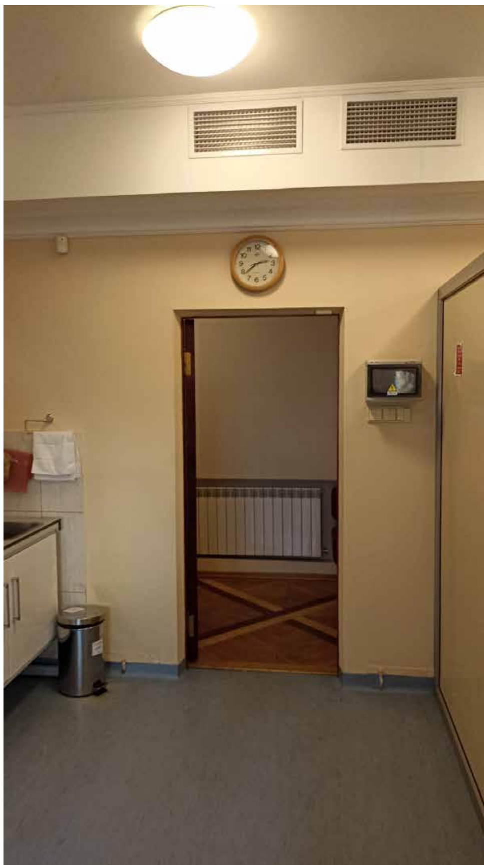
19. 1-й этаж, помещение 116. Вид на место предполагаемой установки кондиционера (над дверным проемом).
