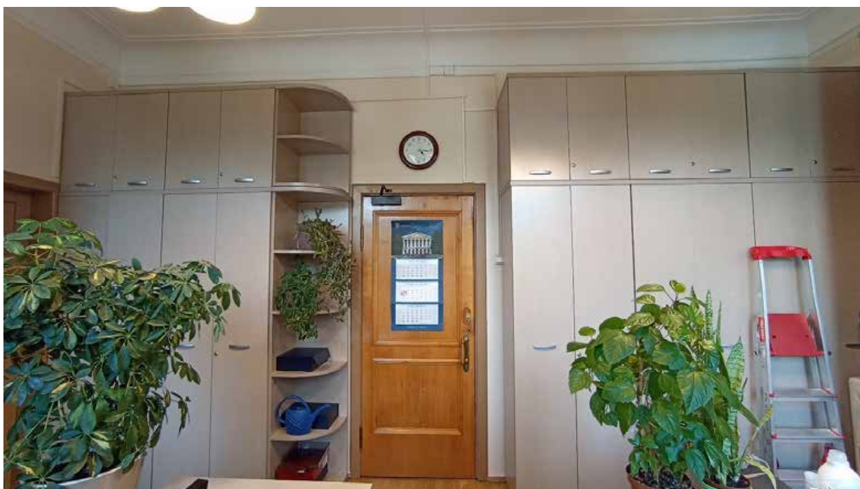
70. 5-й этаж, помещение 507. Вид на место предполагаемой установки кондиционера (над дверным проемом).
