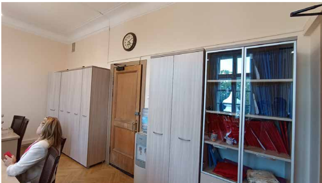
71. 5-й этаж, помещение 508. Вид на место предполагаемой установки кондиционера (над дверным проемом).
