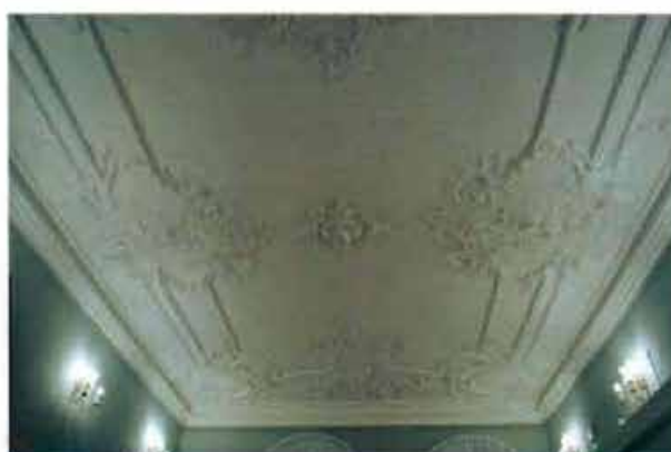
16. (Фрагмент интерьера восточного корпуса)
