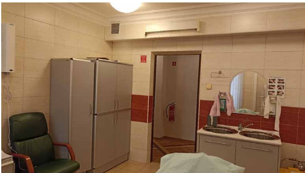
31. 2-й этаж, помещение 214. Вид на место предполагаемой установки кондиционера (над дверным проемом).
