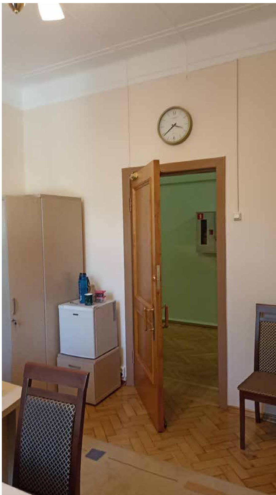
54. 4-й этаж, помещение 412. Вид на место предполагаемой установки кондиционера (над дверным проемом).
