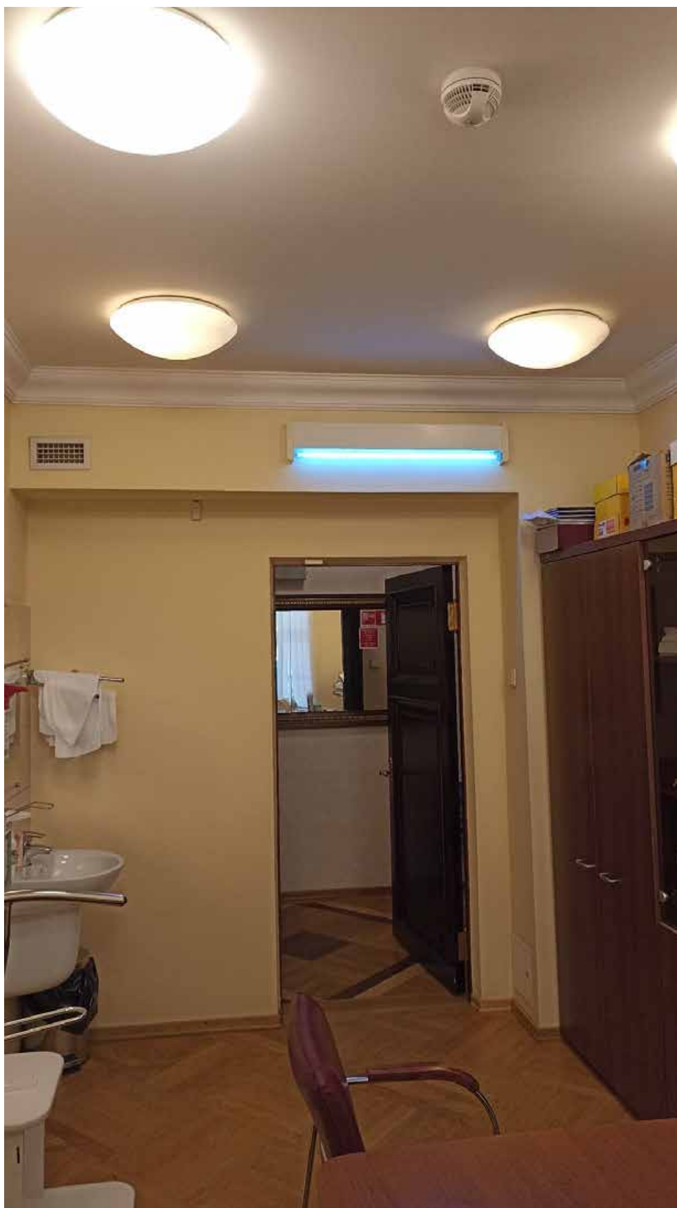
22. 2-й этаж, помещение 203. Вид на место предполагаемой установки кондиционера (над дверным проемом).
