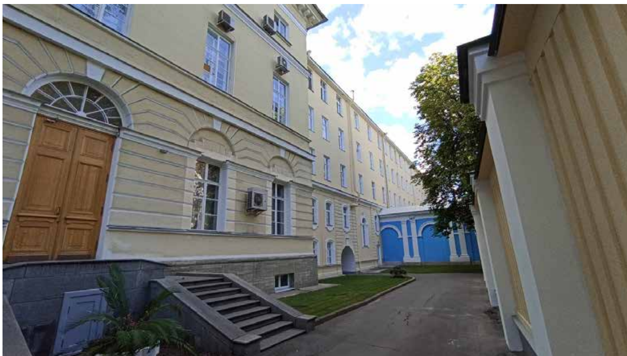
1. Вид на южную часть восточного фасада с юго-востока.
