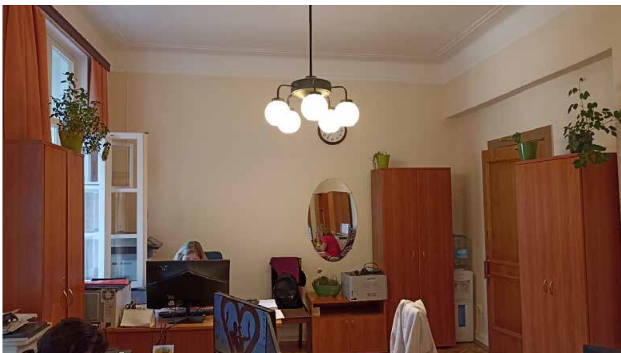
51. 4-й этаж, помещение 407. Вид на место предполагаемой установки кондиционера (над дверным проемом).
