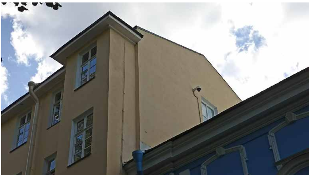
5. Северный (торцевой) фасад, вид снизу, с северо-востока.
