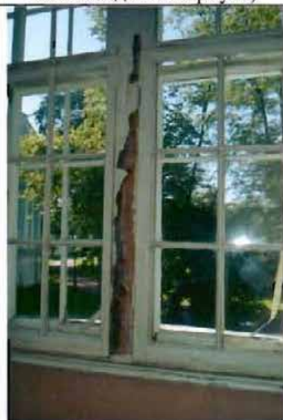
13. (Фрагмент интерьера восточного корпуса)
