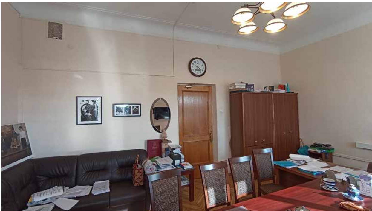
80. 5-й этаж, помещение 524. Вид на место предполагаемой установки кондиционера (над дверным проемом).
