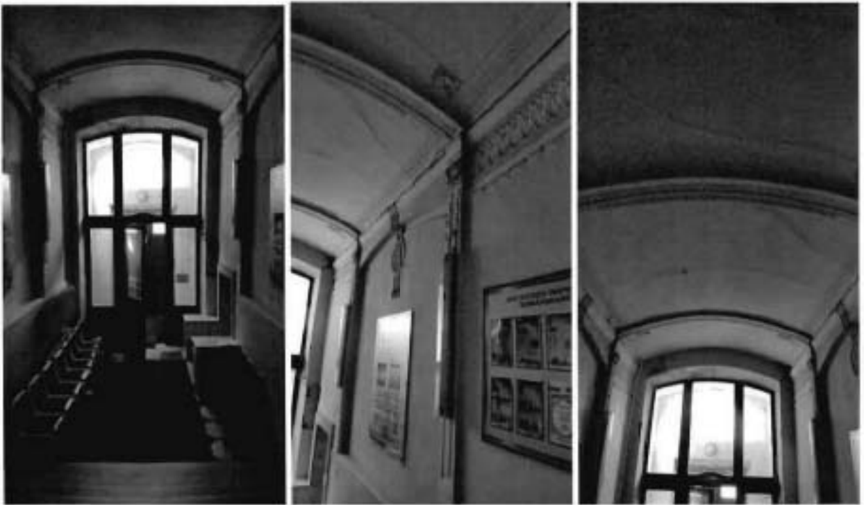
10, 11, 12. Парадный вестибюль объекта культурного наследия
