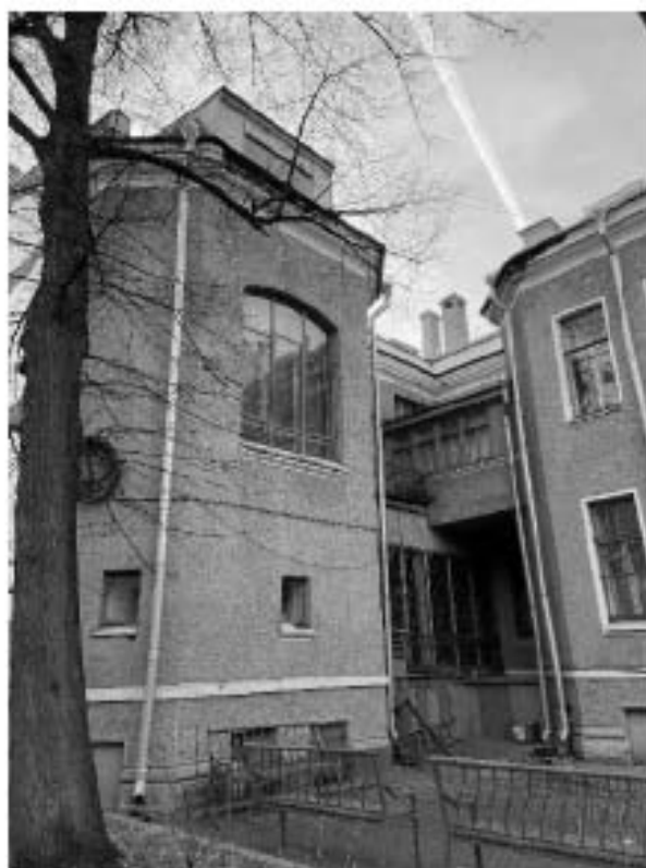
Фото 8. Вид на часть восточного фасада исследуемого здания.
