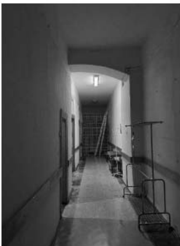
Фото 20. Коридор. Помещение 2Н (8).
