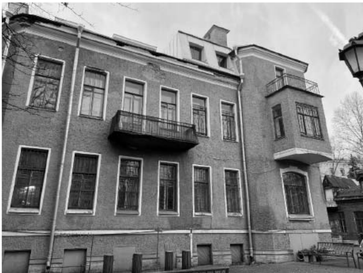
Фото 7. Вид на часть восточного фасада исследуемого здания.
