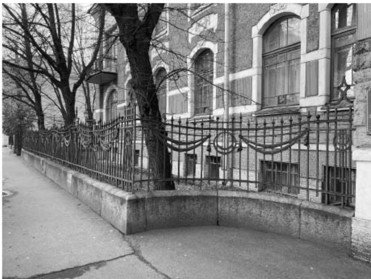
Фото 3. Вид на ограду.
