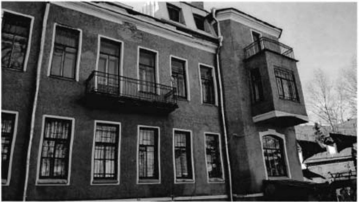
9. Восточный фасад объекта культурного наследия
