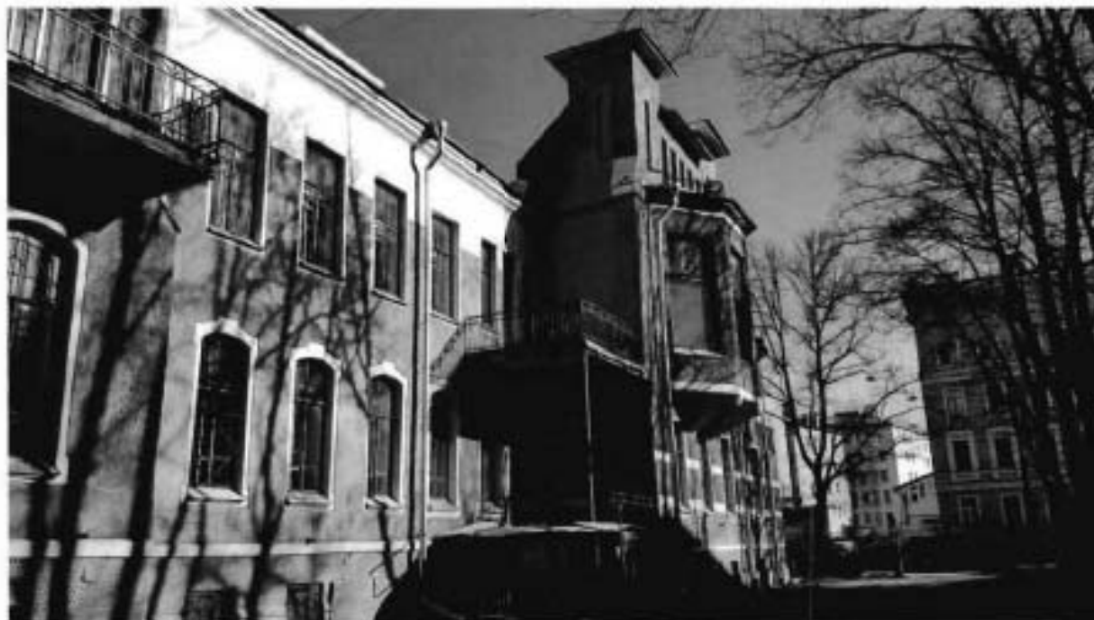
5. Западный фасад объекта культурного наследия
