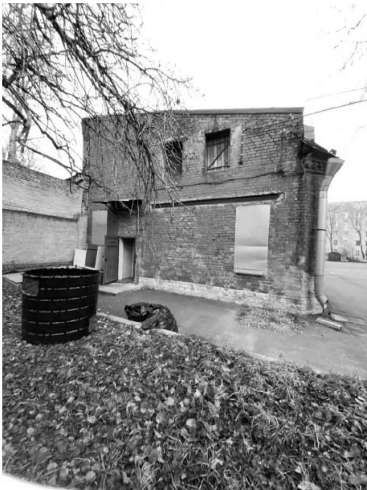
Фото 12. Западный фасад служебного корпуса.
