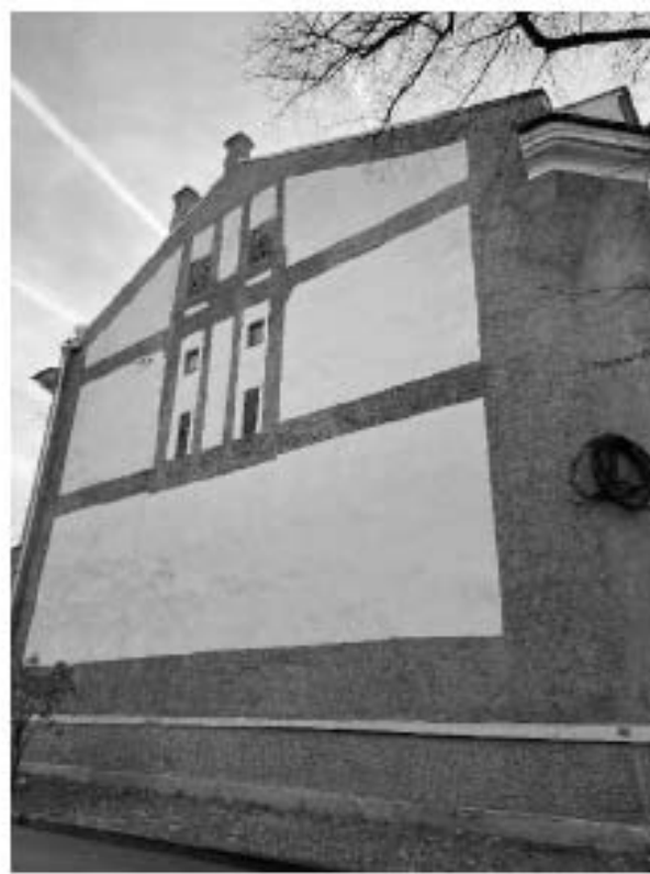
Фото 9. Вид на часть восточного фасада исследуемого здания.
