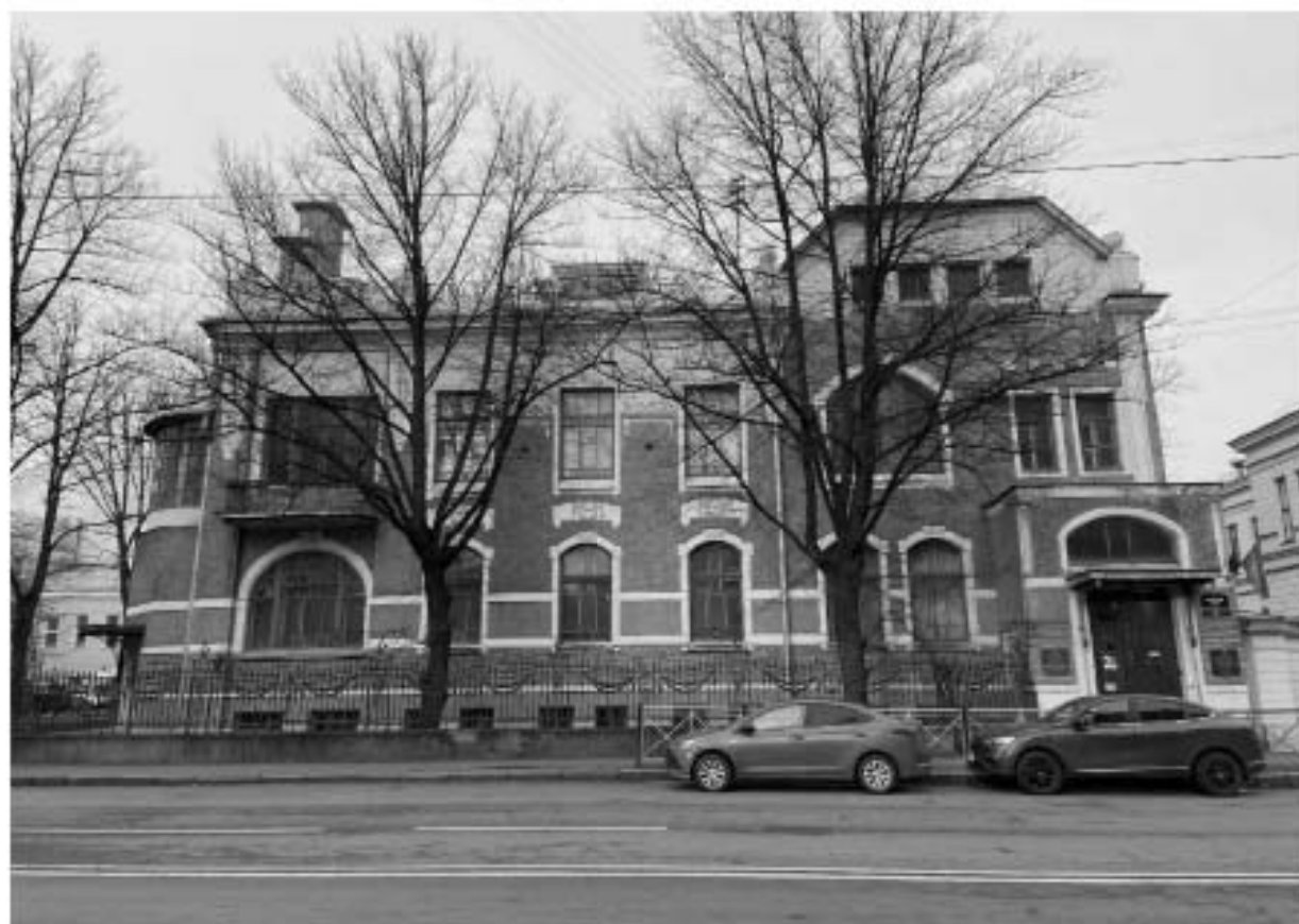
Фото 4. Вид на лицевой фасад исследуемого здания по Рижскому проспекту.
