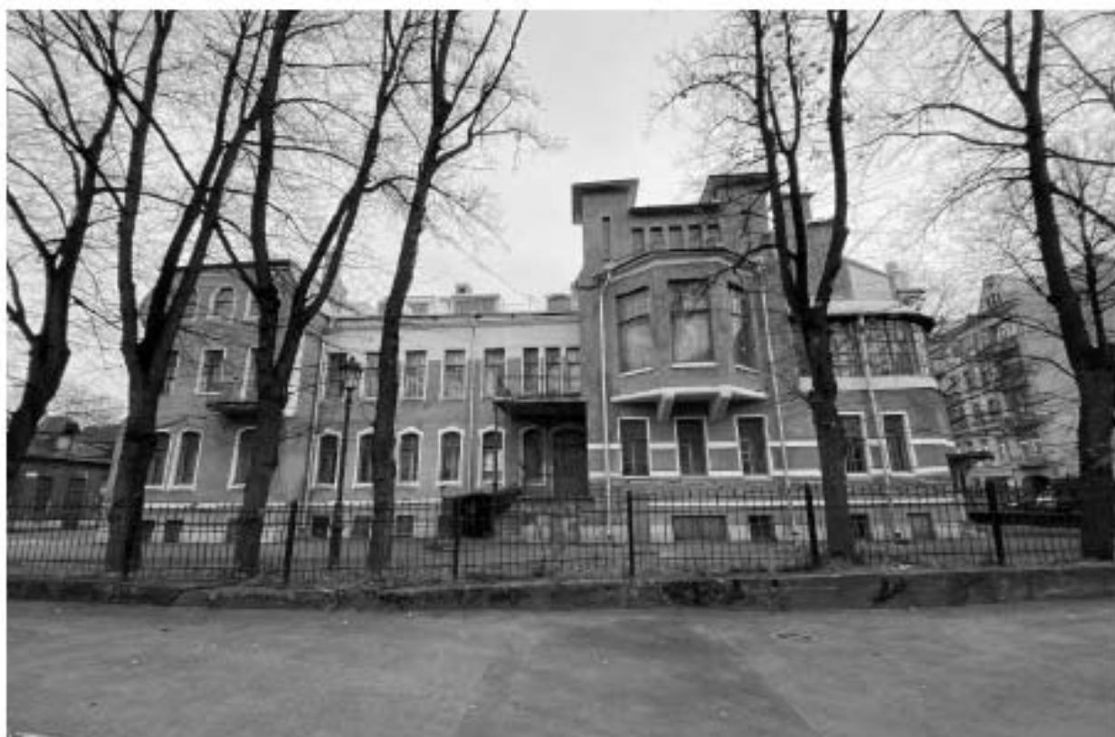
Фото 5. Вид на западный фасад исследуемого здания.
