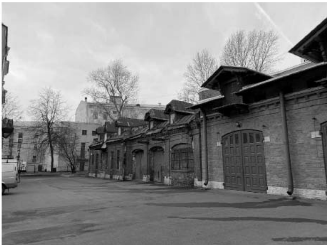
Фото 10. Лицевой фасад служебного корпуса.
