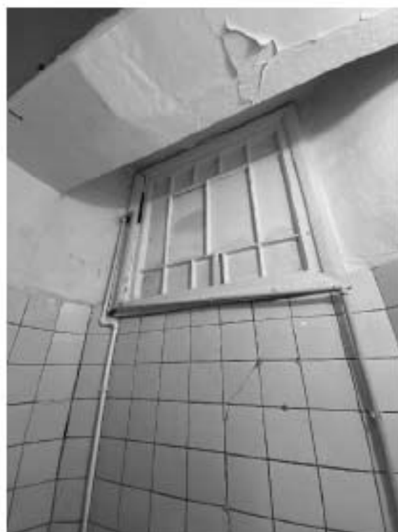
Фото 29. Санузел. Помещение 2Н (20).
