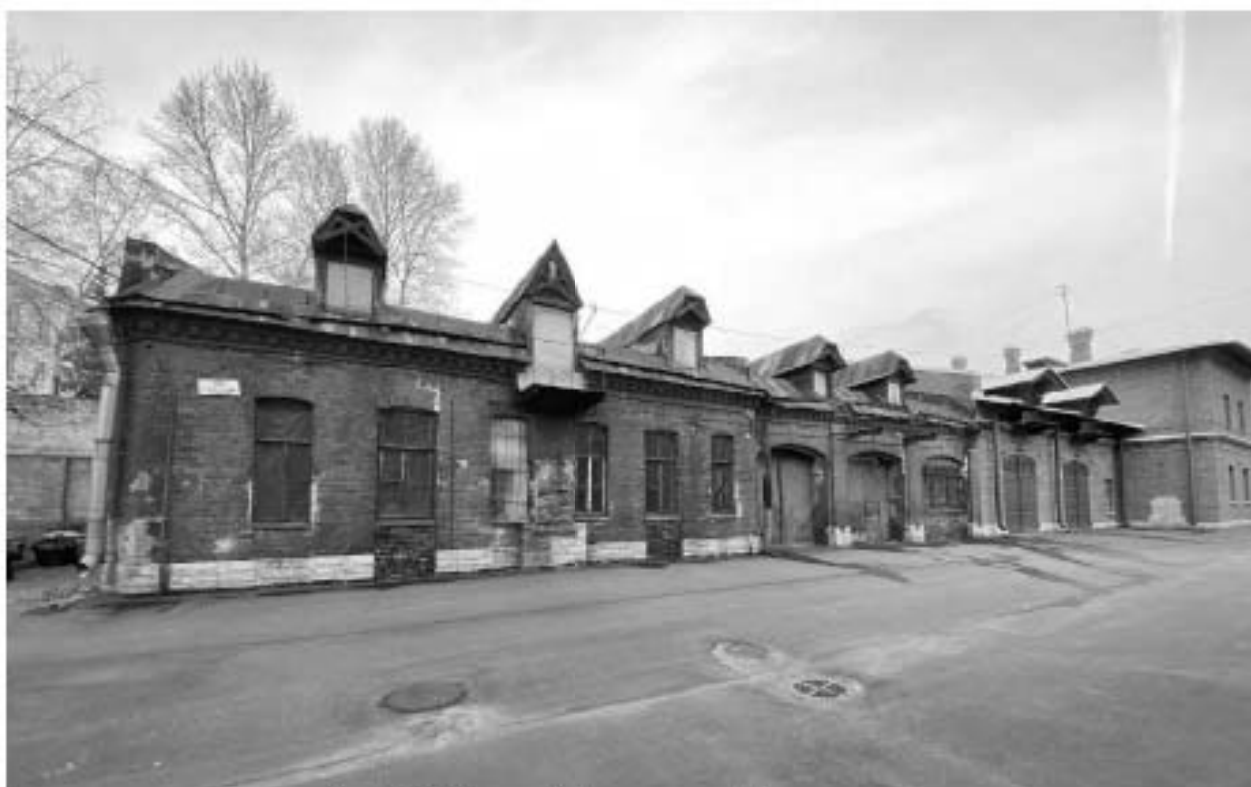
Фото 11. Лицевой фасад служебного корпуса.
