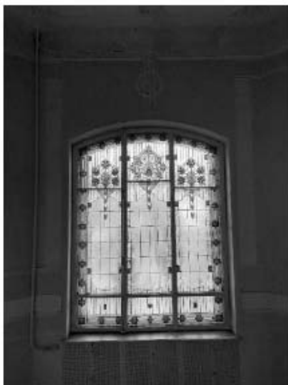
Фото 57. Витраж в помещении парадной лестницы.
