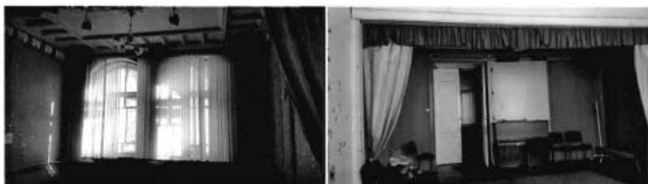
21, 22, 23, 24, 25, 26. Помещения 1 этажа в южной части объекта культурного наследия
