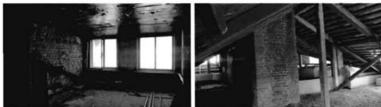
72, 73, 74, 75. Чердак объекта культурного наследия
