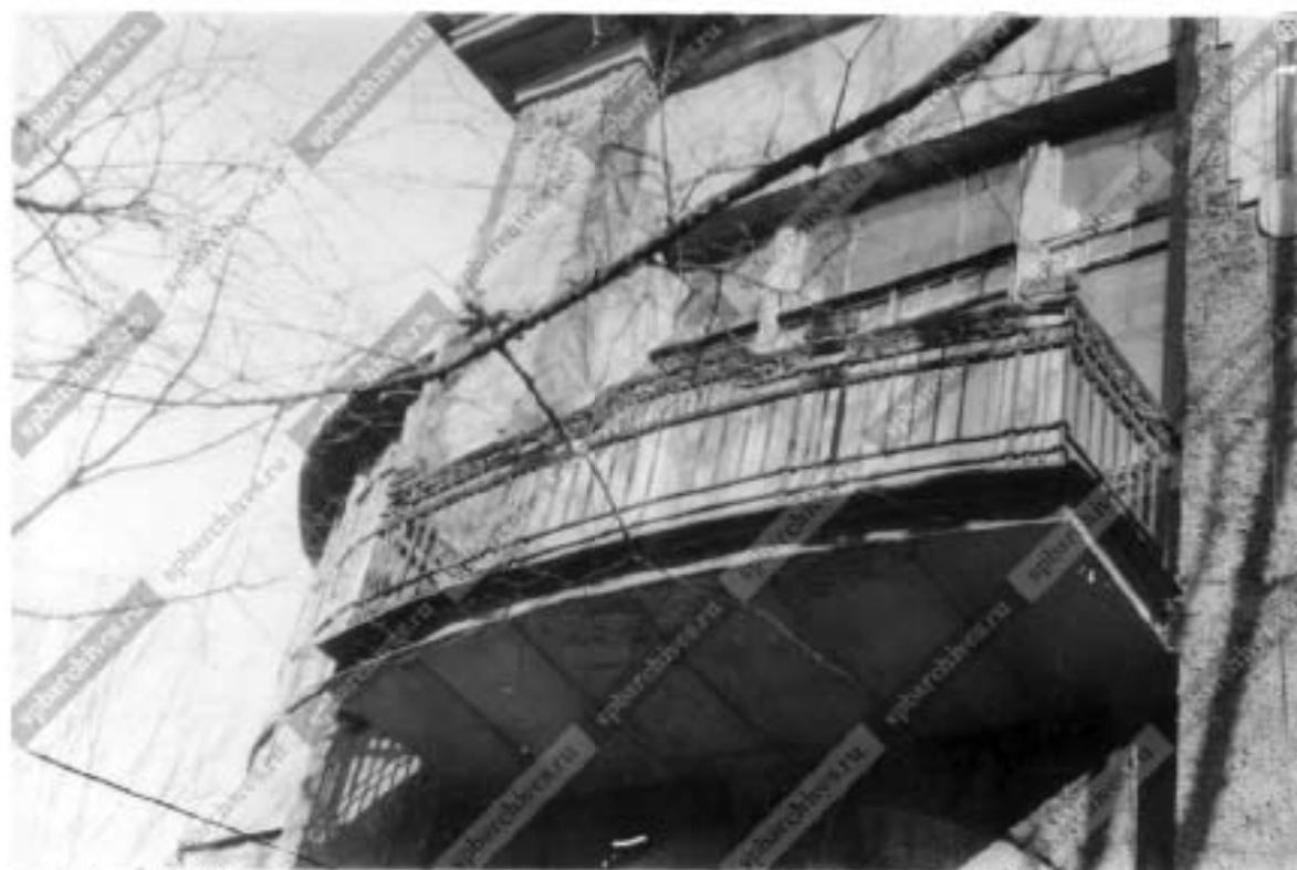
Илл. 12. Вид части закругленного балкона на фасаде дома № 29 по проспекту Огородникова ( бывший особняк М.В.Зива, архитектор Б.И.Гиршович, 1905-1907 гг.). Дата: 1989 г. Источник: ЦГАКФФД СПб. Оп.1АР-154. Ед.хр.217804.
