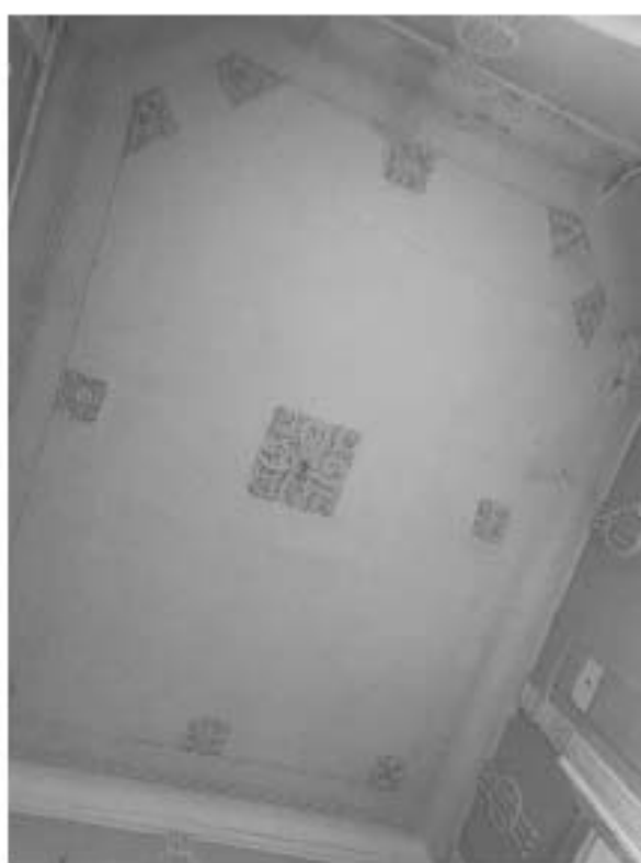
Фото 56. Потолок в помещении парадной лестницы.
