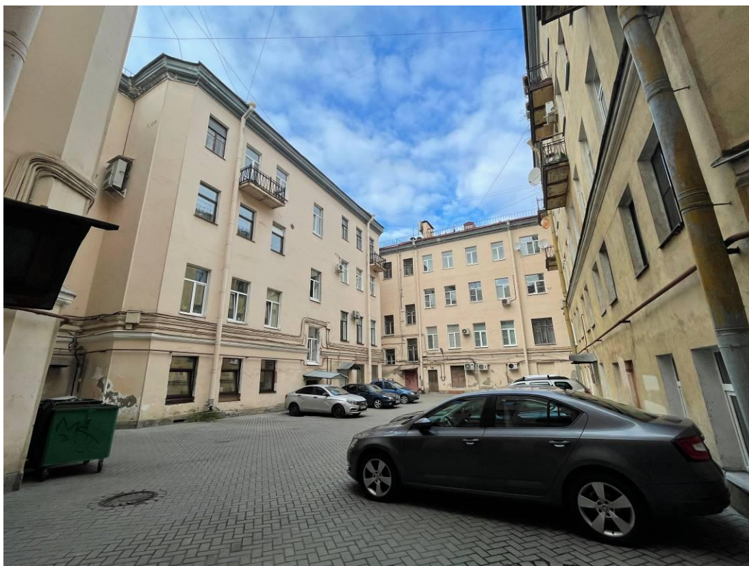
Фото 5. Фрагмент дворового фасада выявленного объекта культурного наследия «Дом Г. Голлидея, в котором в 1-й половине 19 в. жили артисты Брянские, Каратыгины, Е.А. Телешова, А.С. Яковлев и др.»
