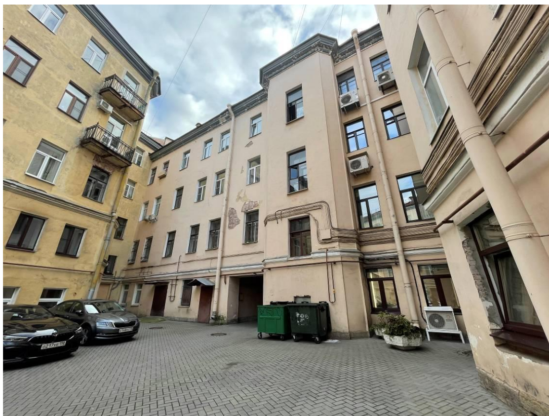
Фото 6. Фрагмент дворового фасада выявленного объекта культурного наследия «Дом Г. Голлидея, в котором в 1-й половине 19 в. жили артисты Брянские, Каратыгины, Е.А. Телешова, А.С. Яковлев и др.»
