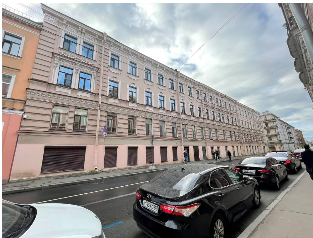
Фото 2. Лицевой фасад выявленного объекта культурного наследия «Дом Г. Голлидея, в котором в 1-й половине 19 в. жили артисты Брянские, Каратыгины, Е.А. Телешова, А.С. Яковлев и др.» (по ул. Декабристов)
