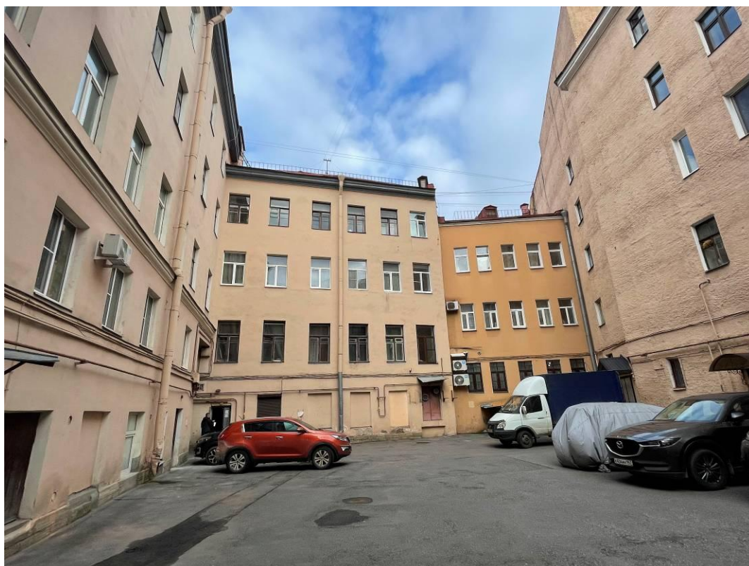
Фото 8. Фрагмент дворового фасада выявленного объекта культурного наследия «Дом Г. Голлидея, в котором в 1-й половине 19 в. жили артисты Брянские, Каратыгины, Е.А. Телешова, А.С. Яковлев и др.»
