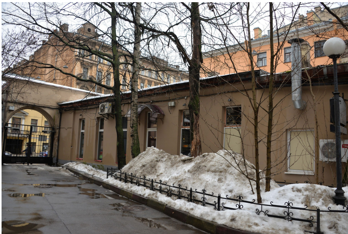
3. Вид дворового фасада выявленного объекта культурного наследия «Служебный флигель»
