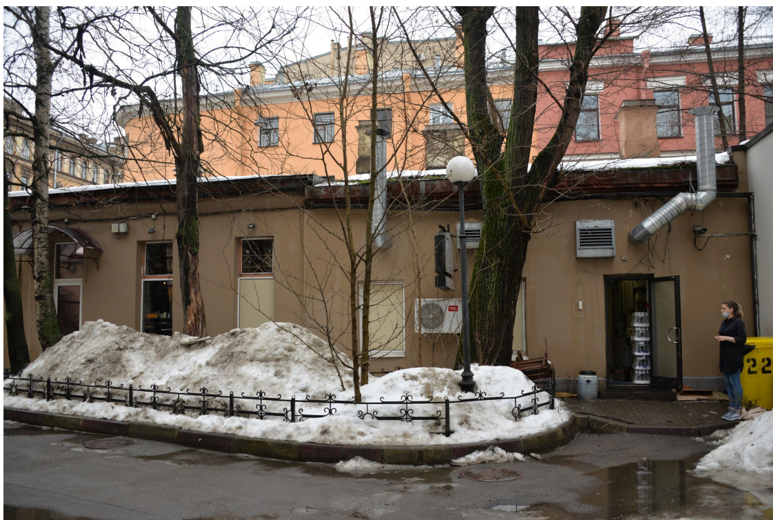
4. Вид дворового фасада выявленного объекта культурного наследия «Служебный флигель»
