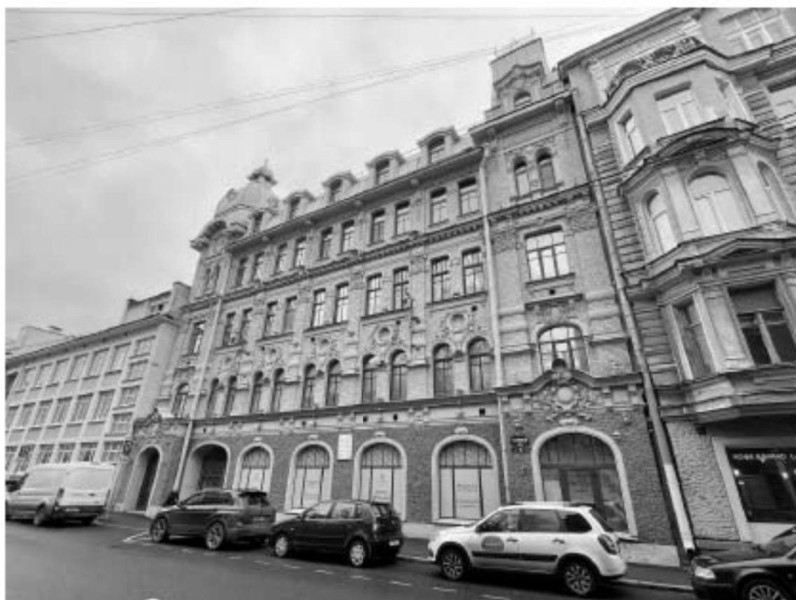
Фото 1. Лицевой фасад объекта культурного наследия регионального значения «Доходный дом и издательство С.М. Проппера» (по Галерной ул.)
