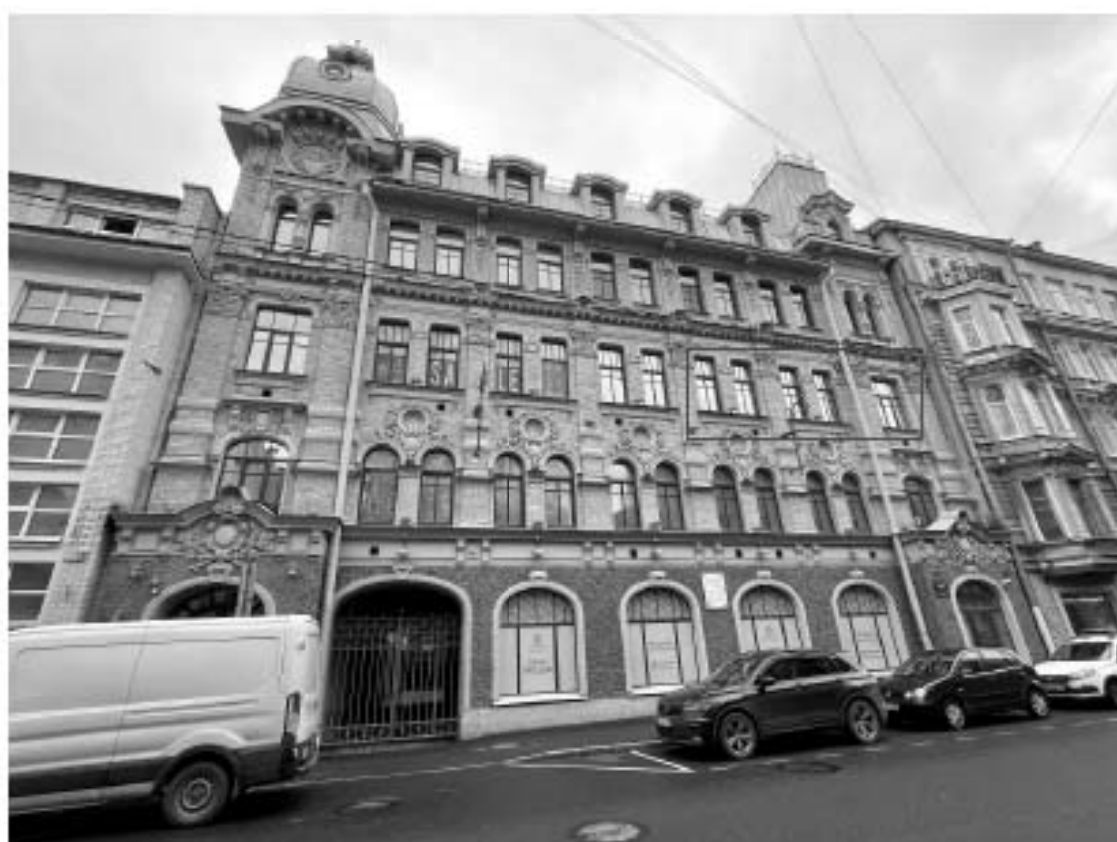
Фото 2. Лицевой фасад объекта культурного наследия регионального значения «Доходный дом и издательство С.М. Проппера» (по Галерной ул.)
