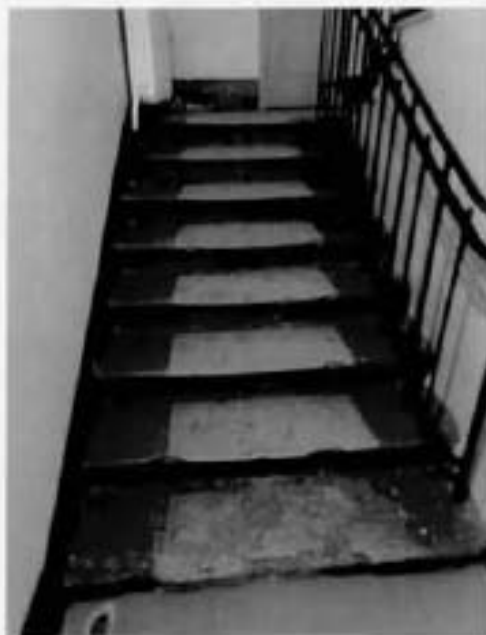
7. Интерьер. Помещение 1-Н(20) объекта культурного наследия в уровне 1-го этажа.
