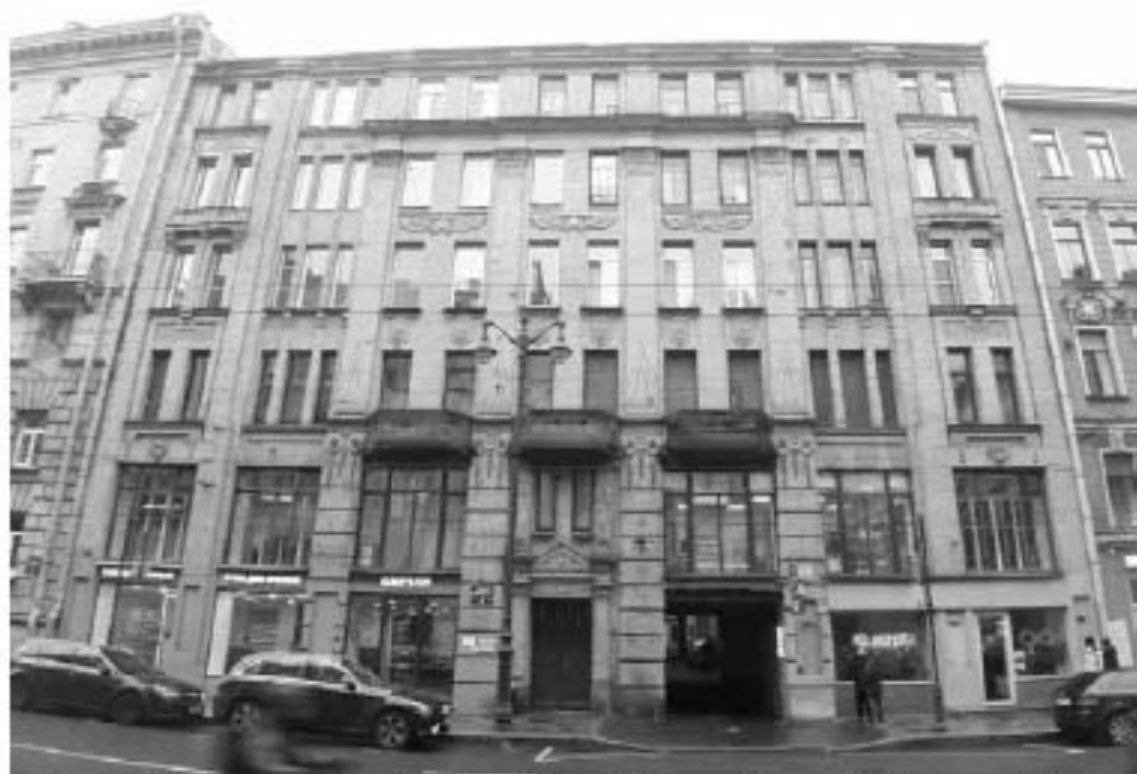
44. «Дом А.В. Виноградова» (Большой пр. П.С., д. 65, лит. А). Лицевой фасад. Штиглиц М.С. 07.11.2024.
