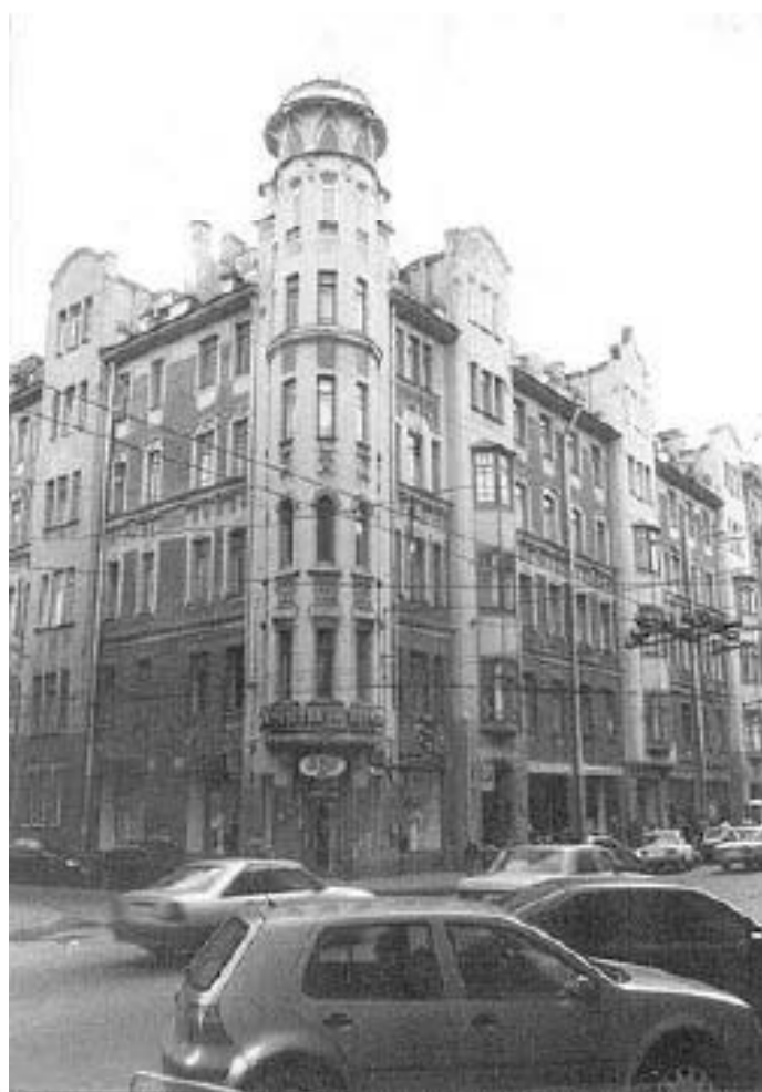
17. «Дом И.Ф. Алюшинского» (Большой пр. П.С., д. 69, лит. А). Фото 1999 (20).
