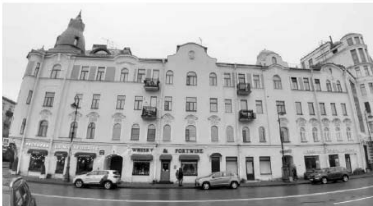
53. «Дом К.Е. Ершова» (наб. Мартынова, д. 16, лит. А). Лицевой фасад по наб. Мартынова. Штиглиц М.С. 07.11.2024.
