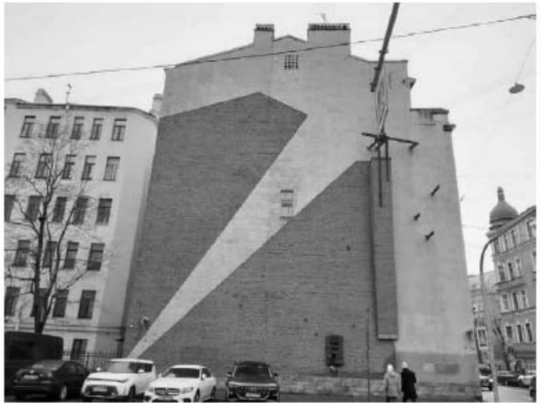
51. «Дом И.Д. Агафонова» (Кронверкская ул., д. 12, лит. А). Боковой фасад. Штиглиц М.С. 07.11.2024.
