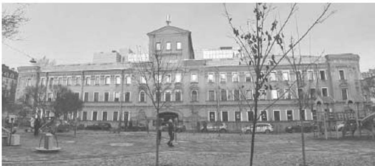
57. «Здание Белозерских бань П.И. Шорохова» (ул. Кропоткина, д. 1, лит. А). Общий вид. Штиглиц М.С. 07.11.2024.
