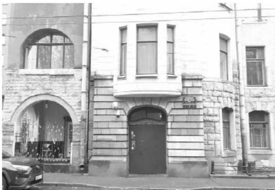
42. «Дом И.Н. Бороздкина» (Большая Монетная ул., д. 3, лит. А). Лицевой фасад с показанием проектируемых мест установки оборудования и кабельных трасс. Штиглиц М.С. 07.11.2024.
