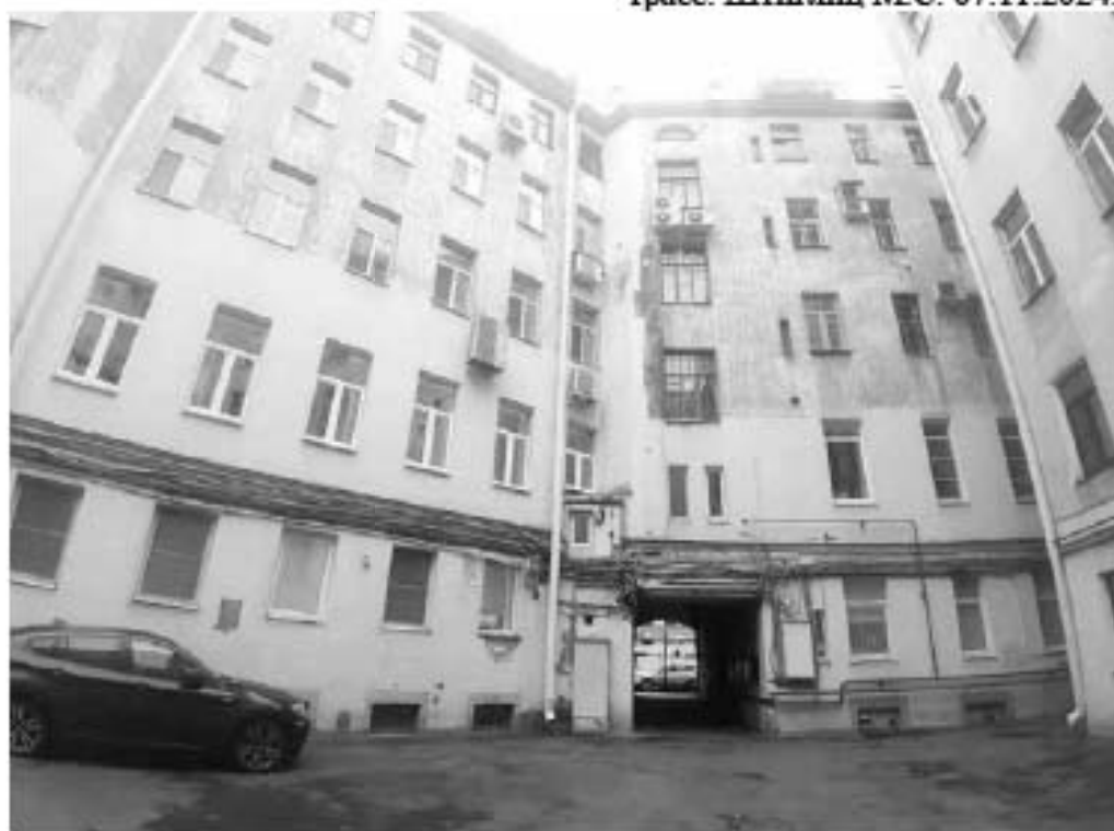
18. «Дом М.М. Горбова» (ул. Мира, д. 10, лит. А). Дворовый фасад. Штиглиц М.С. 07.11.2024.
