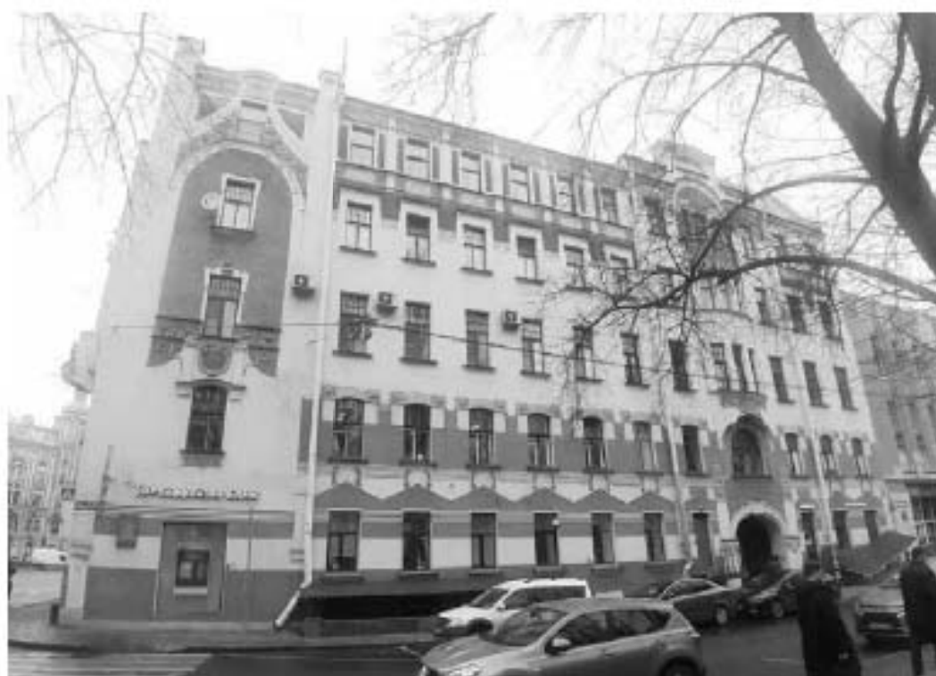
49. «Дом К.Х. Кельдаля» (Каменноостровский пр., д. 13/2, лит. А). Лицевой фасад по Дивенской ул. Штиглиц М.С. 07.11.2024.
