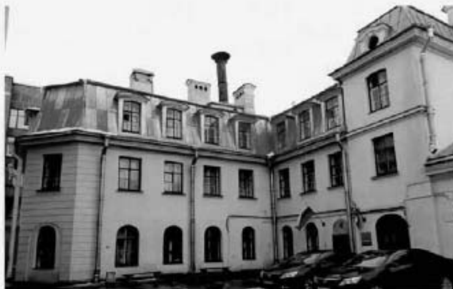
3. Общий вид. Дворовые фасады объекта культурного наследия.
