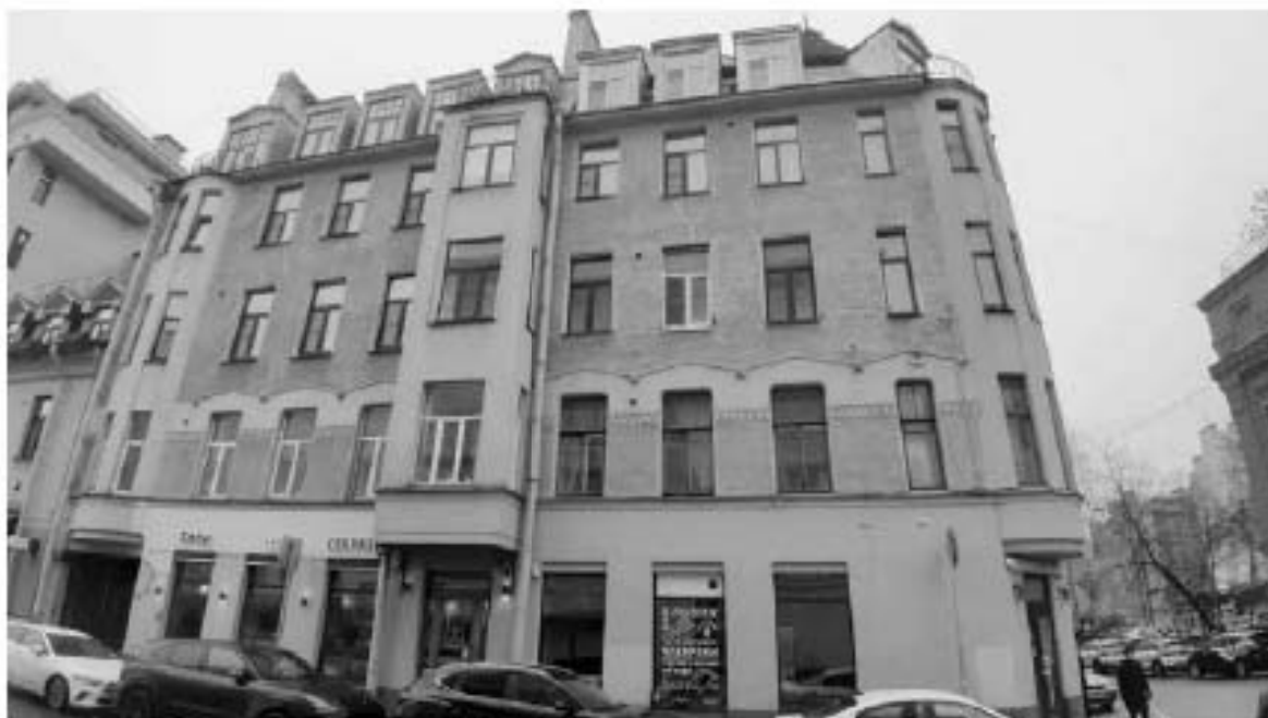
39. «Дом Рыбина Ф.М.» (Пионерская ул., д. 35, лит. А). Лицевой фасад по Малой Разночинной ул. Штиглиц М.С. 07.11.2024.
