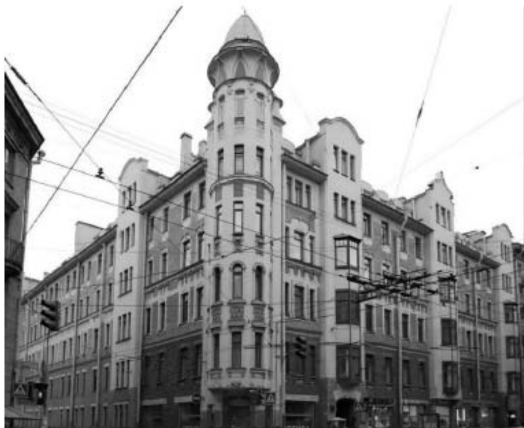
18. «Дом И.Ф. Алюшинского» (Большой пр. П.С., д. 69, лит. А). Фото 2009 (26).
