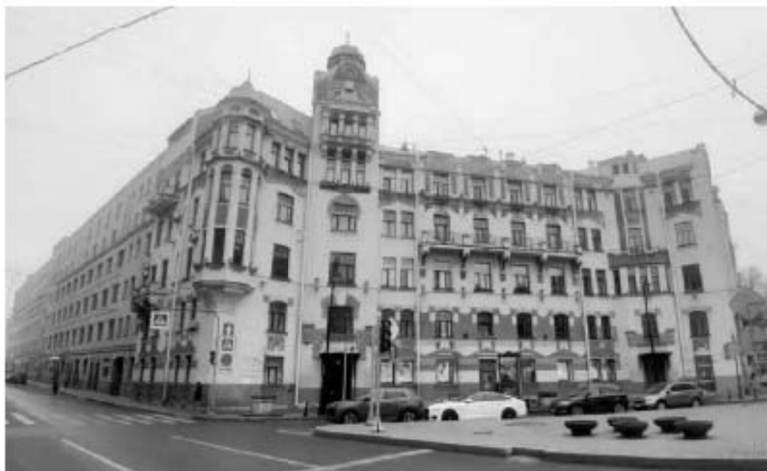
47. «Дом К.Х. Кельдаля» (Каменноостровский пр., д. 13/2, лит. А). Общий вид. Штиглиц М.С. 07.11.2024.
