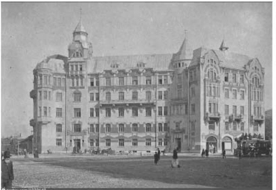
28. «Дом К.Х. Кельдыша» (Каменноостровский пр., д. 13/2, лит. А). 1903-1904. Фото А. П. Ивашенцов. (26).
