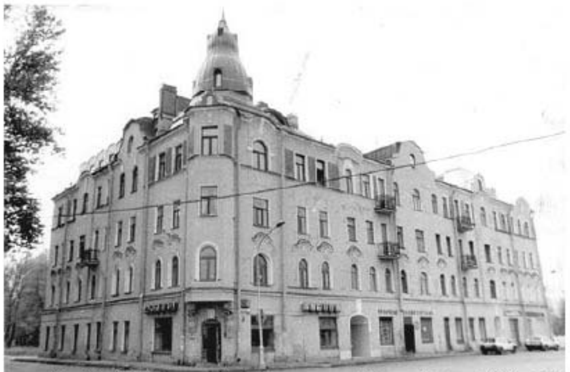
35. «Дом К.Е. Ершова» (наб. Мартынова, д. 16, лит. А). Фото 1999 г. (20).
