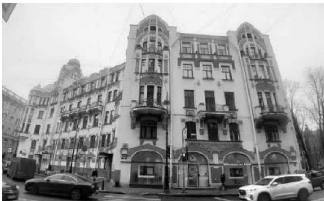
48. «Дом К.Х. Кельдаля» (Каменноостровский пр., д. 13/2, лит. А). Лицевой фасад по Каменноостровскому пр. Штиглиц М.С. 07.11.2024.
