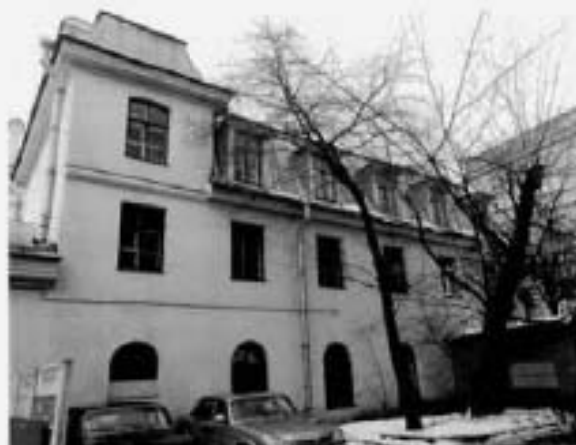
2. Общий вид. Восточный фасад объекта культурного наследия.
