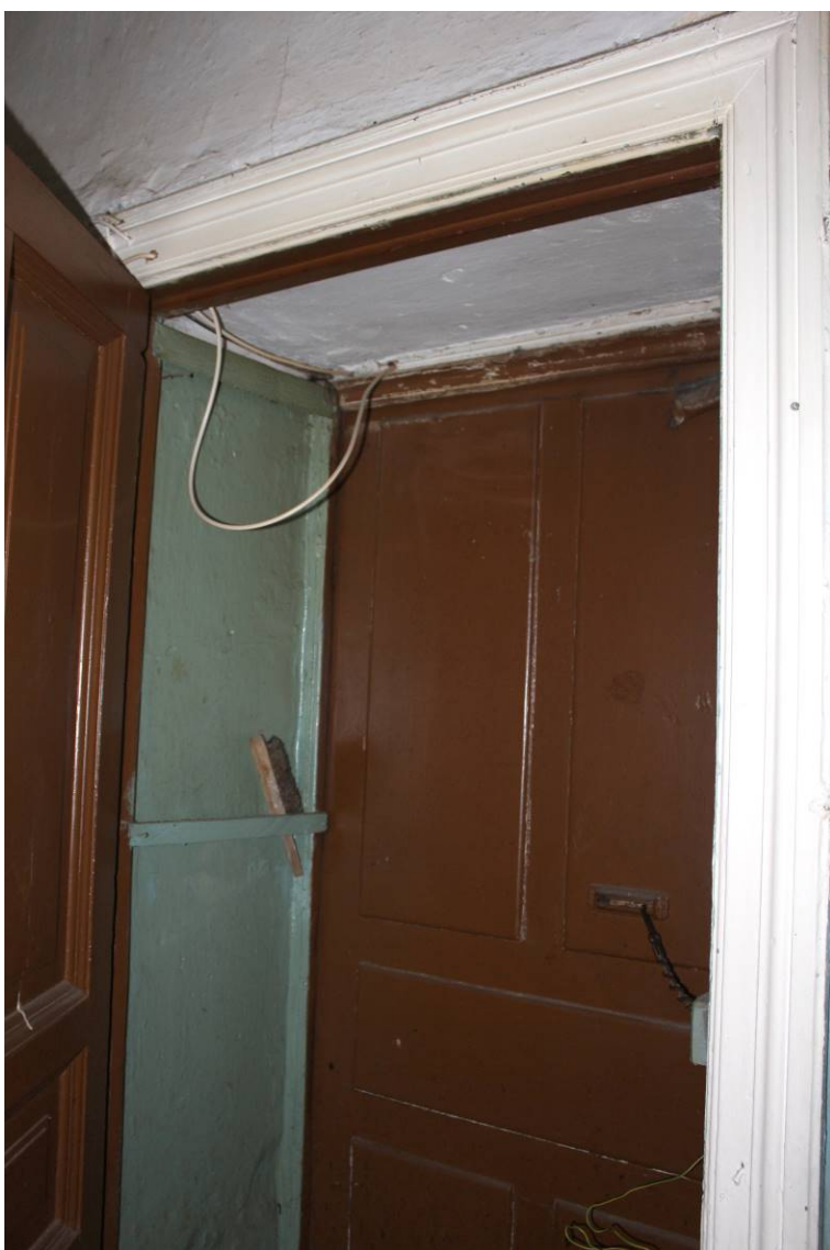
48. Выявленный объект культурного наследия «Дом И.И. Боргмана», по адресу: г. Санкт-Петербург, Съезжинская улица, дом 4, литера А. Квартира №4. Помещение 13. Фрагмент с показом оформления дверного проема входной двери. Дата фотофиксации: 28 августа 2021 г.
