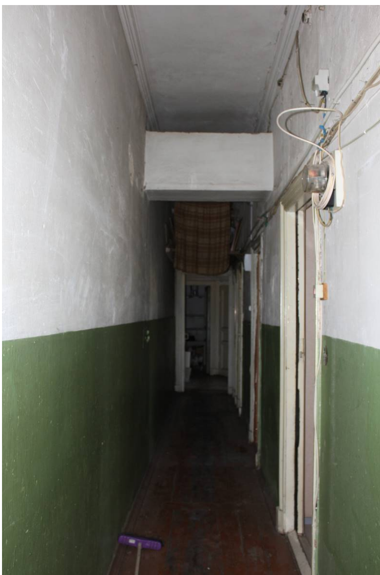
36. Выявленный объект культурного наследия «Дом И.И. Боргмана», по адресу: г. Санкт-Петербург, Съезжинская улица, дом 4, литера А. Квартира №4. Помещение 6. Общий вид помещения. Дата фотофиксации: 28 августа 2021 г.
