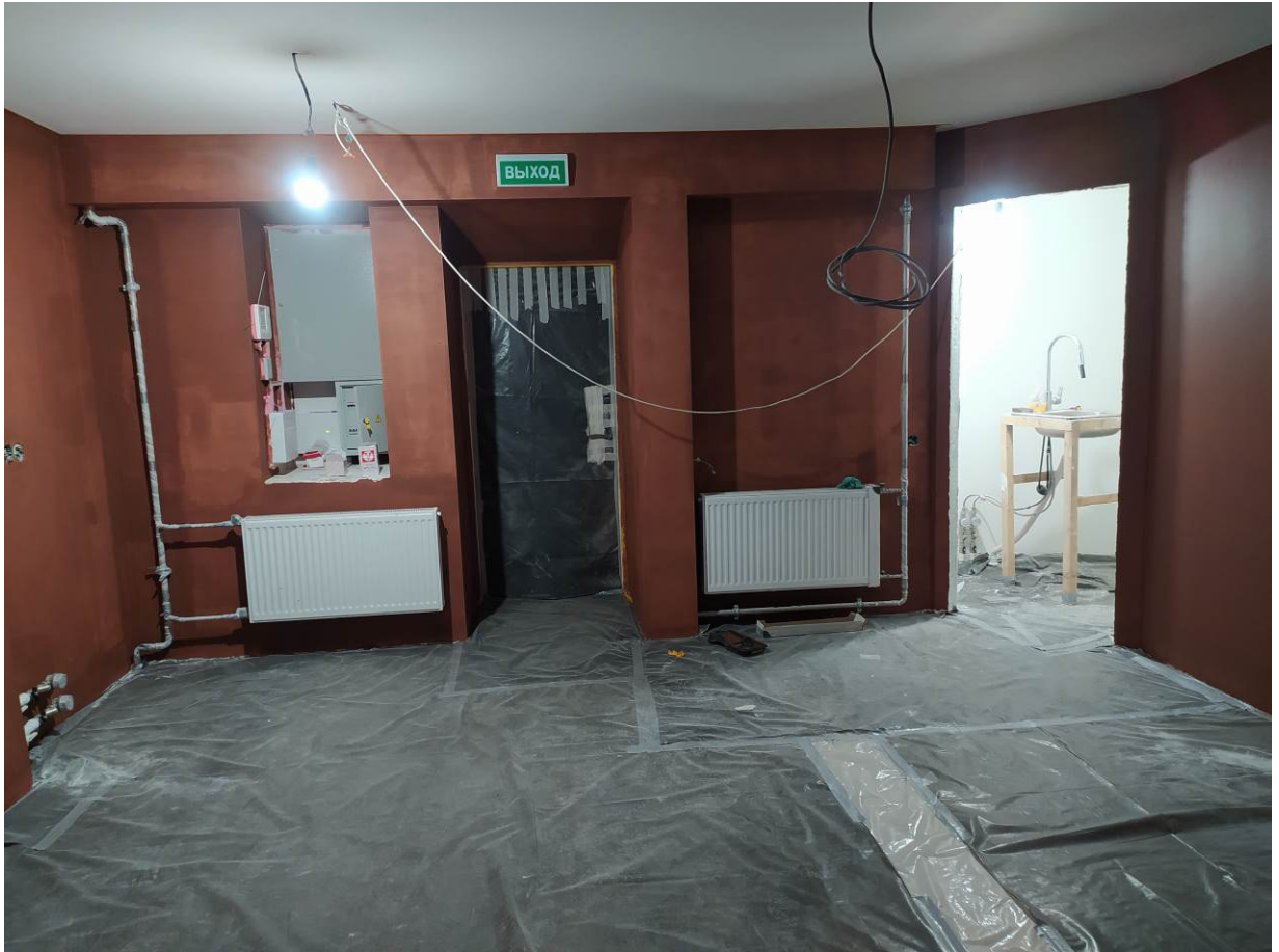
9. Помещение 1-Н. Вид в интерьере. Фотофиксация от 19.06.2024 г.
