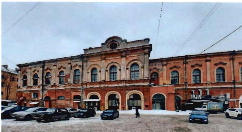
4. Вид на южный фасад объекта культурного наследия. Дата фотофиксации: 12.03.2021
