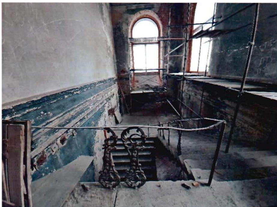
10. Интерьеры. Парадная лестница Л-1. Дата фотофиксации: 19.02.2021
