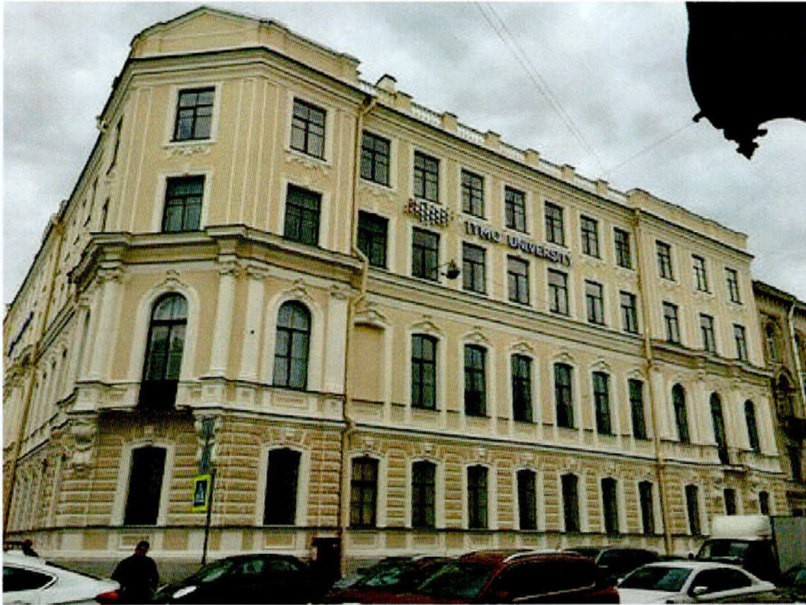
2. Лицевой фасад по Моховой ул.
