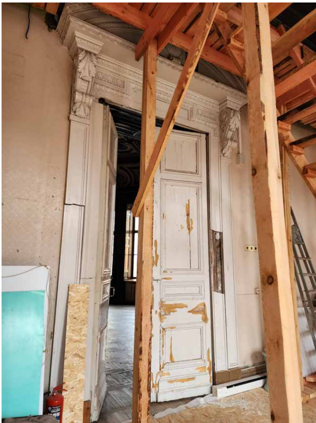
Фото 5. Аванзал. Помещение 24-Н (19). Вид со стороны окон. Дверное заполнение.
