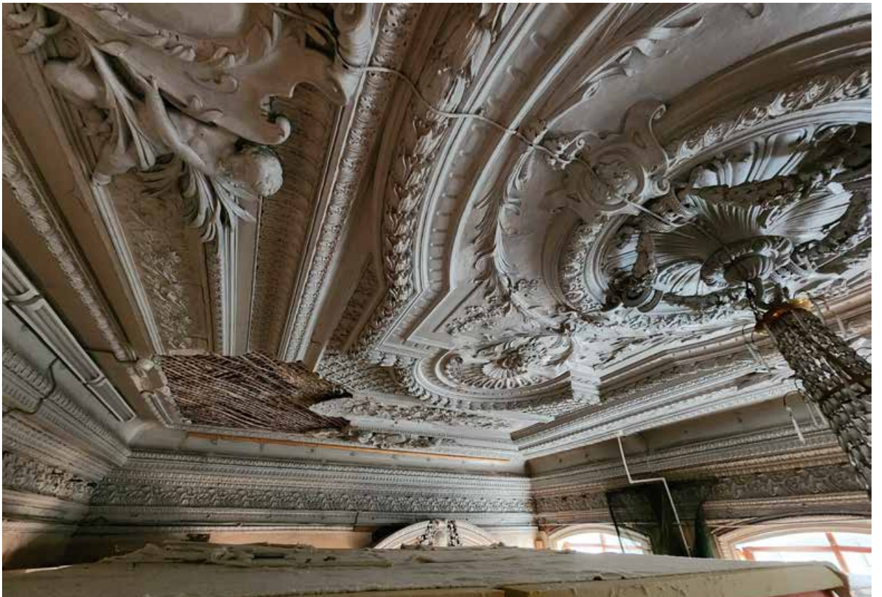
Фото 8. Аванзал. Помещение 24-Н (19). Потолок. Вид в сторону камина.
