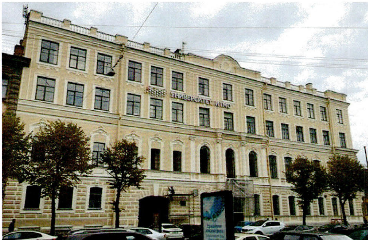
1. Лицевой фасад по ул. Чайковского
