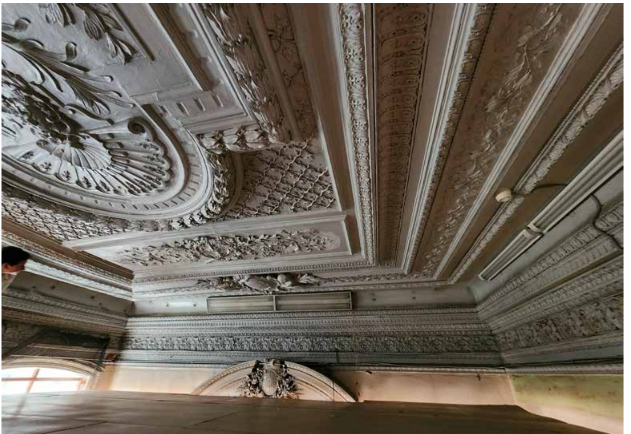
Фото 9. Аванзал. Помещение 24-Н (19). Потолок. Вид со стороны камина.
