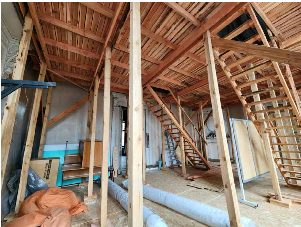
Фото 3. Аванзал. Помещение 24-Н (19). Вид со стороны окон.
