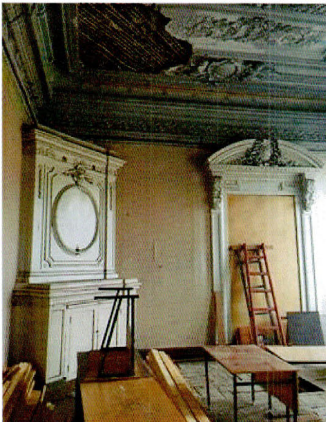
13. Помещение 24-Н (19) - Аванзал
