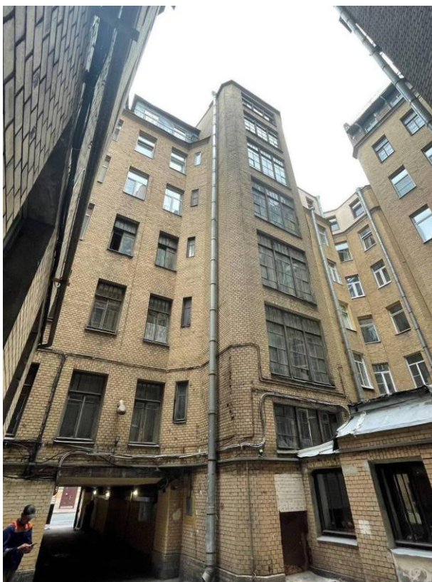
Фото 3. Фрагмент дворового фасада объекта культурного наследия регионального значения «Доходный дом В.И. Денисова, арх. В.В. Шауб»
