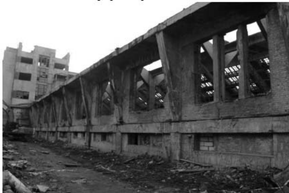
Фото 8. Вид на северо-восточный фасад Красильного цеха объекта культурного наследия регионального значения «Производственные корпуса трикотажной фабрики «Красное знамя».
