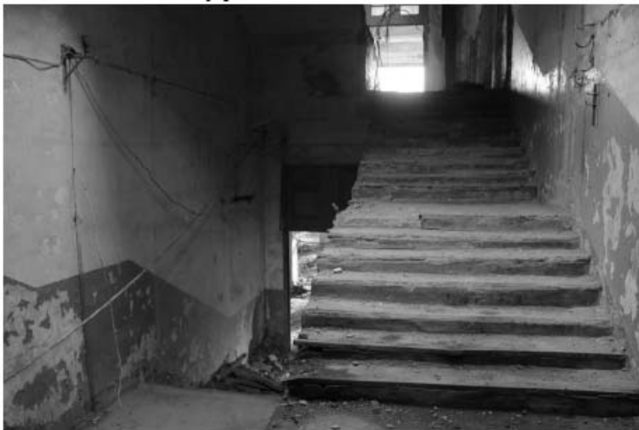
Фото 82. Объект культурного наследия регионального значения «Производственные корпуса трикотажной фабрики «Красное знамя». Лестничная клетка Л-3 в уровне 1-го – 2-го этажей.
