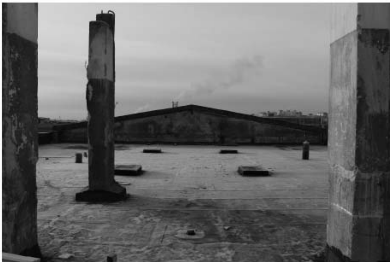
Фото 114. Объект культурного наследия регионального значения «Производственные корпуса трикотажной фабрики «Красное знамя». Крыша.
