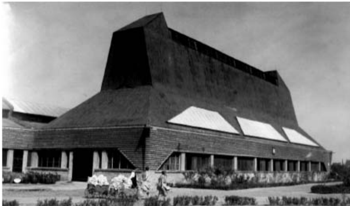
Илл. 10. Шляпная фабрика в Луккенвальде. Арх. Э. Мендельсон (источник: Зеви Б. Эрих Мендельсон. Базель, Бостон, Берлин, 1999. С. 75).
