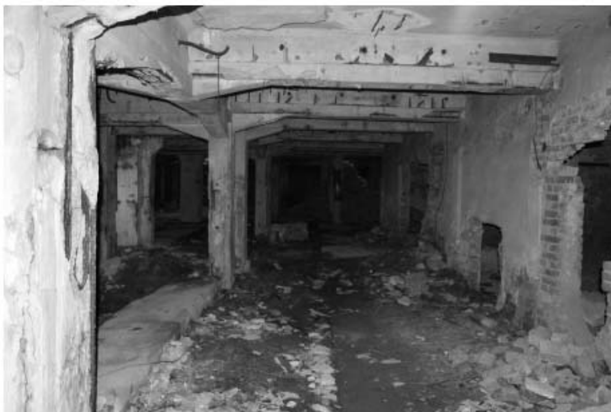
Фото 35. Объект культурного наследия регионального значения «Производственные корпуса трикотажной фабрики «Красное знамя». Внутренние помещения цокольного этажа.
