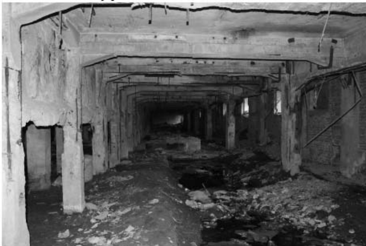
Фото 60. Объект культурного наследия регионального значения «Производственные корпуса трикотажной фабрики «Красное знамя». Внутренние помещения цокольного этажа.
