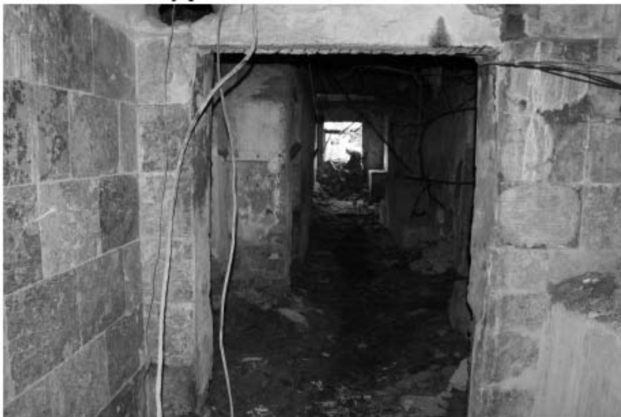
Фото 52. Объект культурного наследия регионального значения «Производственные корпуса трикотажной фабрики «Красное знамя». Внутренние помещения цокольного этажа.
