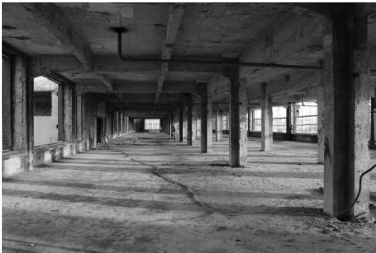
Фото 107. Объект культурного наследия регионального значения «Производственные корпуса трикотажной фабрики «Красное знамя». Внутренние помещения 4-го этажа.
