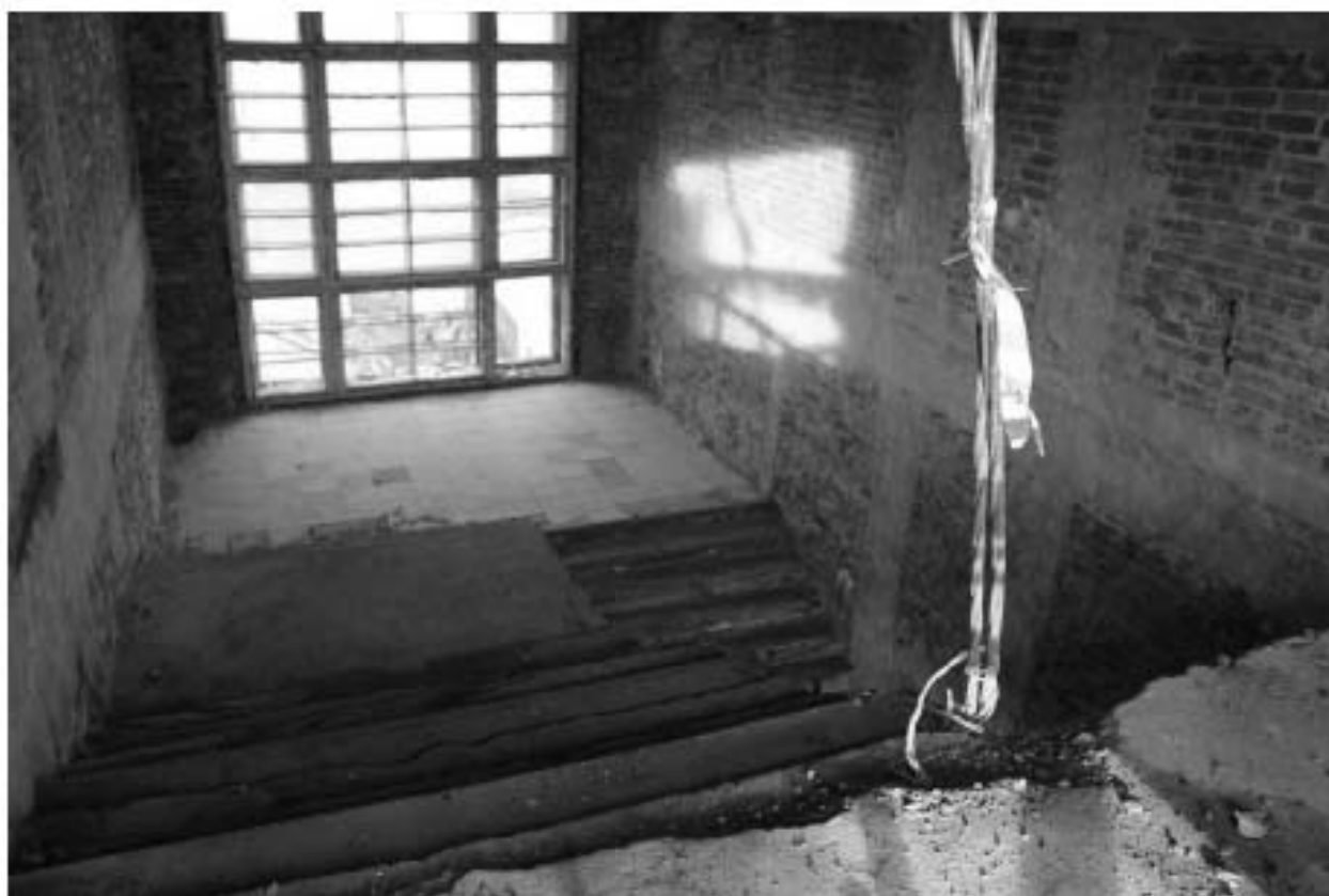
Фото 119. Объект культурного наследия регионального значения «Производственные корпуса трикотажной фабрики «Красное знамя». Лестничная клетка Л-3, вид с 5-го этажа.
