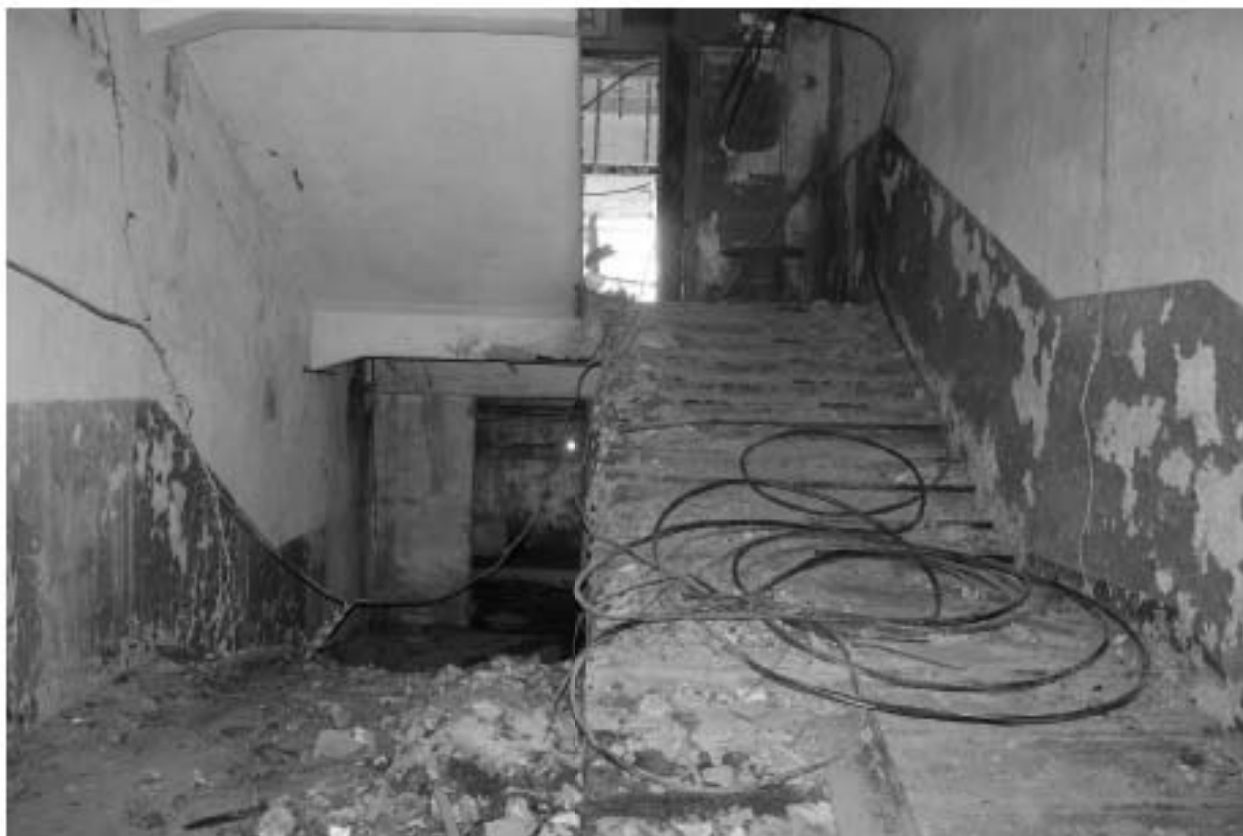
Фото 31. Объект культурного наследия регионального значения «Производственные корпуса трикотажной фабрики «Красное знамя». Лестничная клетка Л-3 в уровне цокольного – 1-го этажей.
