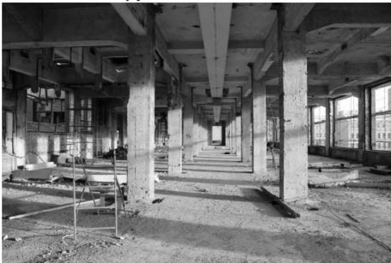
Фото 88. Объект культурного наследия регионального значения «Производственные корпуса трикотажной фабрики «Красное знамя». Внутренние помещения 2-го этажа.
