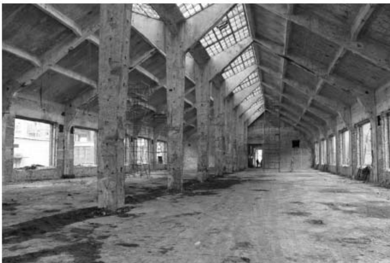
Фото 77. Объект культурного наследия регионального значения «Производственные корпуса трикотажной фабрики «Красное знамя». Внутренние помещения 1-го этажа.
