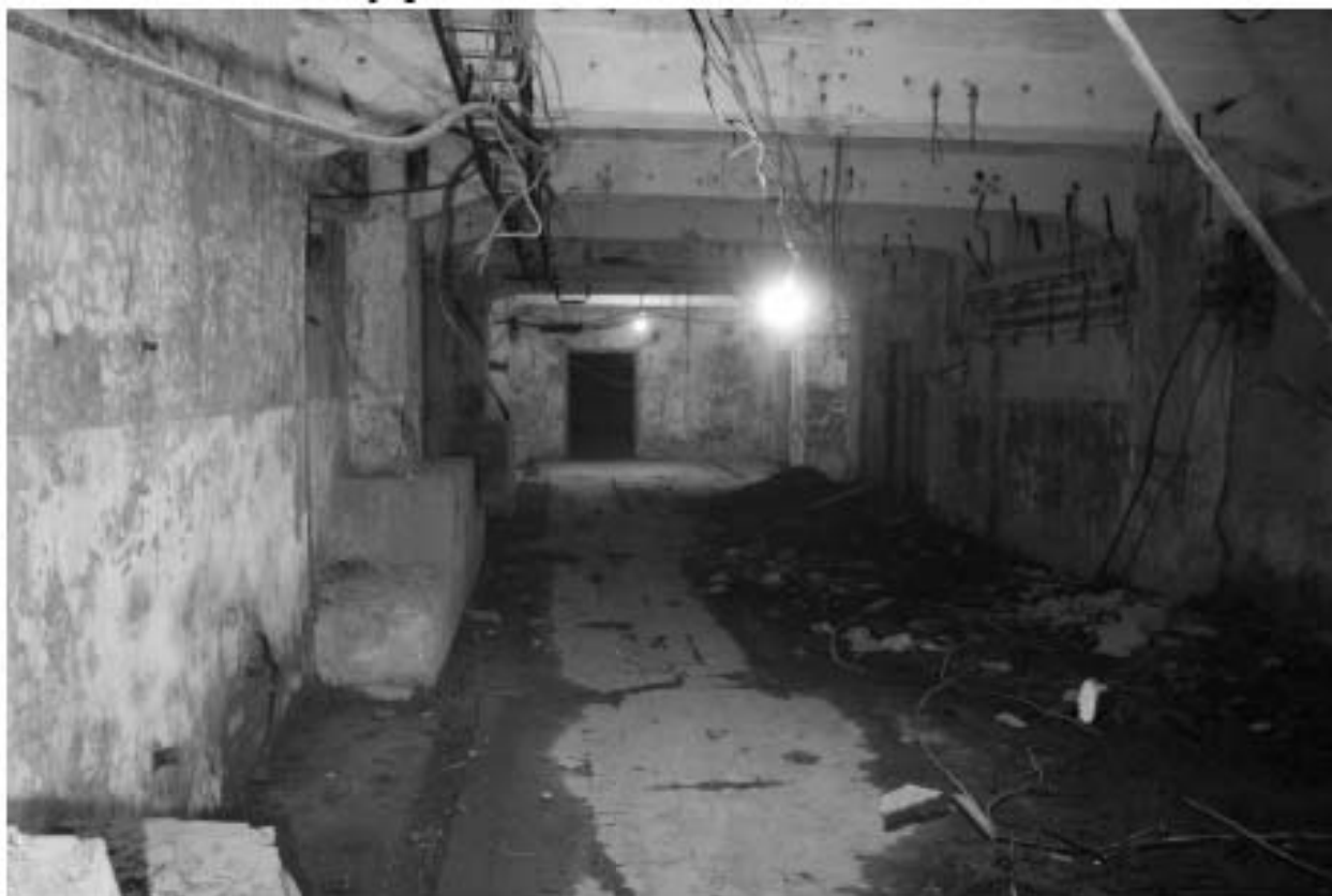
Фото 18. Объект культурного наследия регионального значения «Производственные корпуса трикотажной фабрики «Красное знамя». Внутренние помещения цокольного этажа.
