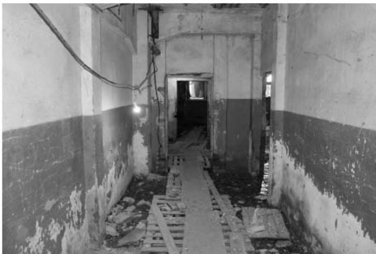
Фото 43. Объект культурного наследия регионального значения «Производственные корпуса трикотажной фабрики «Красное знамя». Внутренние помещения цокольного этажа.
