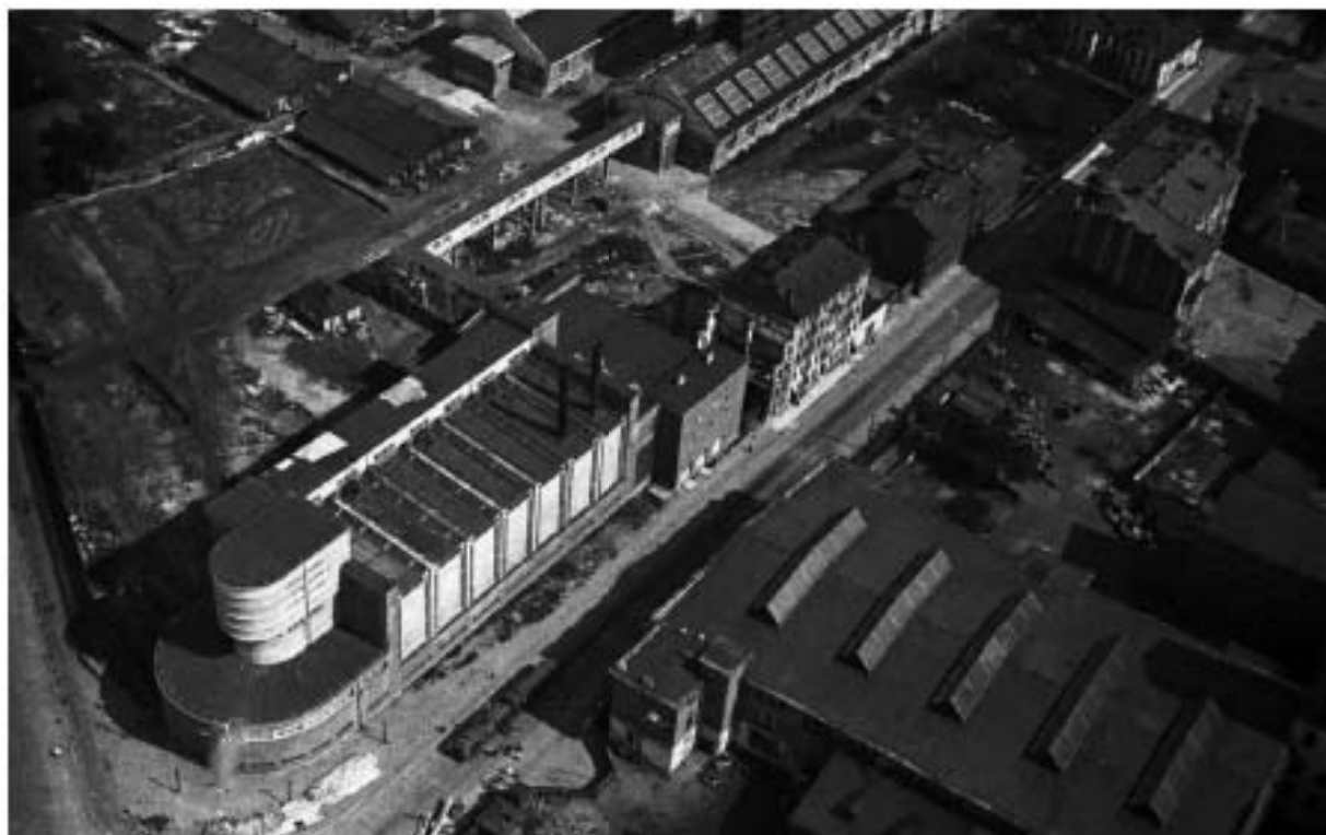
Илл. 36. Новые корпуса и силовая станция чулочно-трикотажной фабрики «Красное Знамя». 1931 г. Серия «Ленинград с аэроплана» для журнала «СССР на стройке» (источник: https://pastvu.com/p/551979 ).
