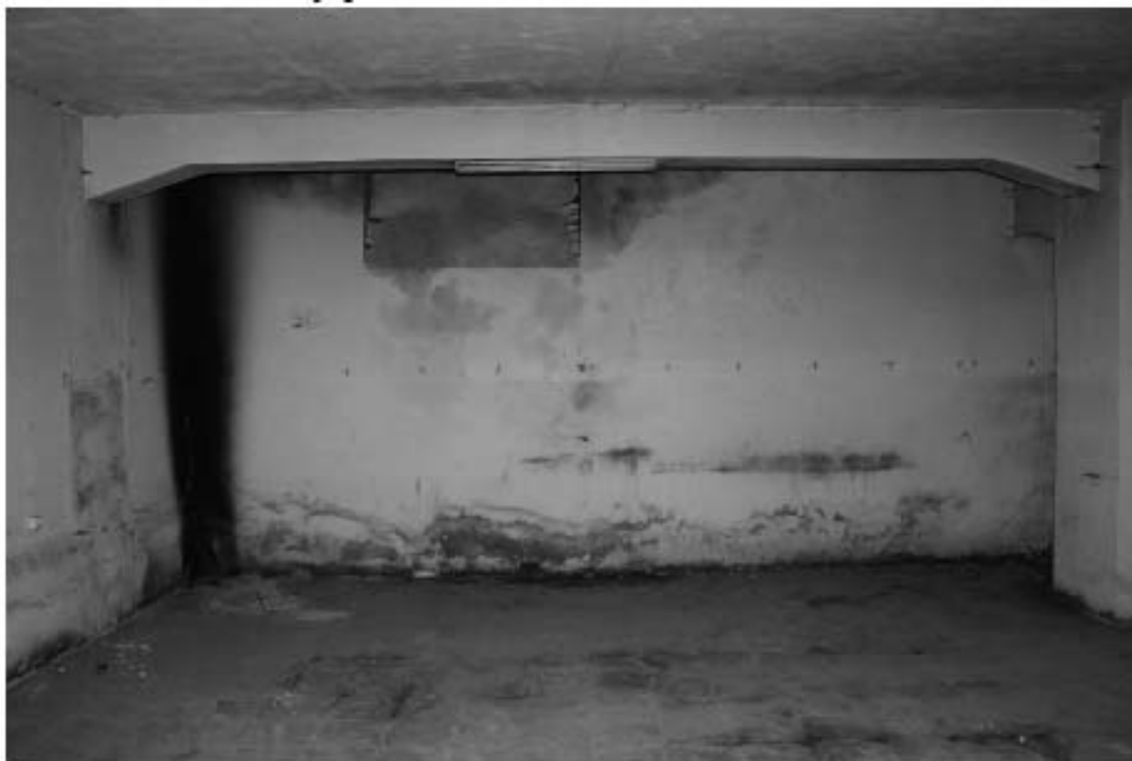
Фото 24. Объект культурного наследия регионального значения «Производственные корпуса трикотажной фабрики «Красное знамя». Внутренние помещения цокольного этажа.
