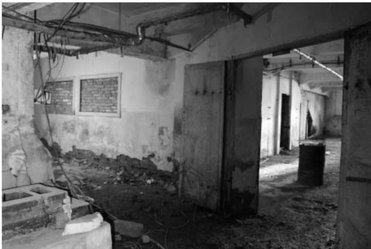
Фото 19. Объект культурного наследия регионального значения «Производственные корпуса трикотажной фабрики «Красное знамя». Внутренние помещения цокольного этажа.
