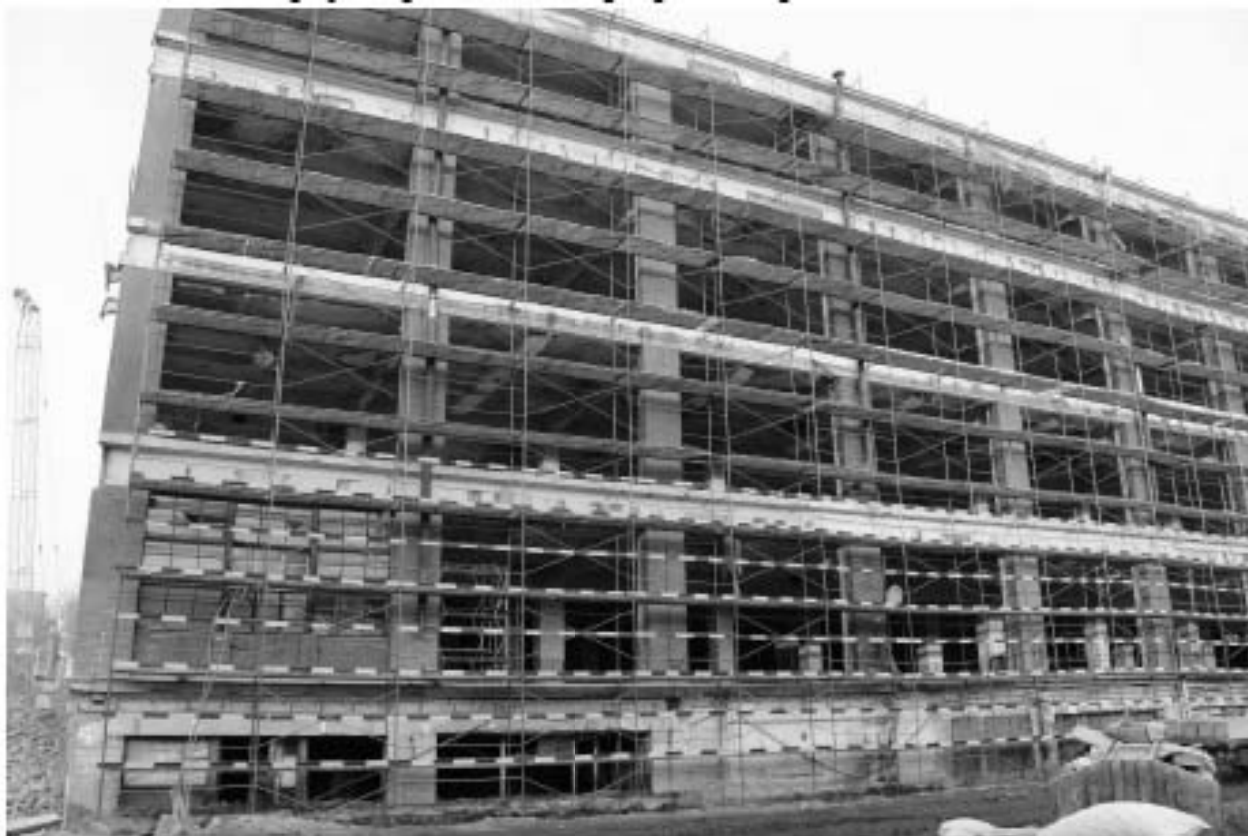
Фото 4. Вид на юго-восточный фасад Главного трикотажного цеха (1 очередь) объекта культурного наследия регионального значения «Производственные корпуса трикотажной фабрики «Красное знамя».
