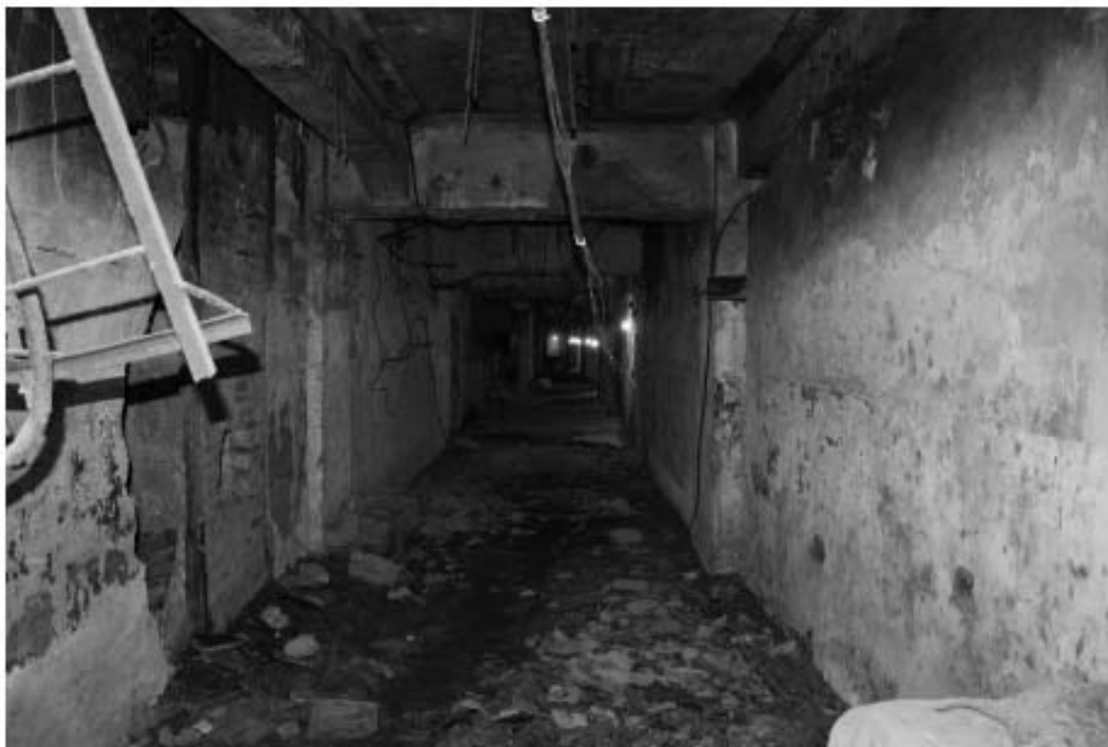
Фото 53. Объект культурного наследия регионального значения «Производственные корпуса трикотажной фабрики «Красное знамя». Внутренние помещения цокольного этажа.
