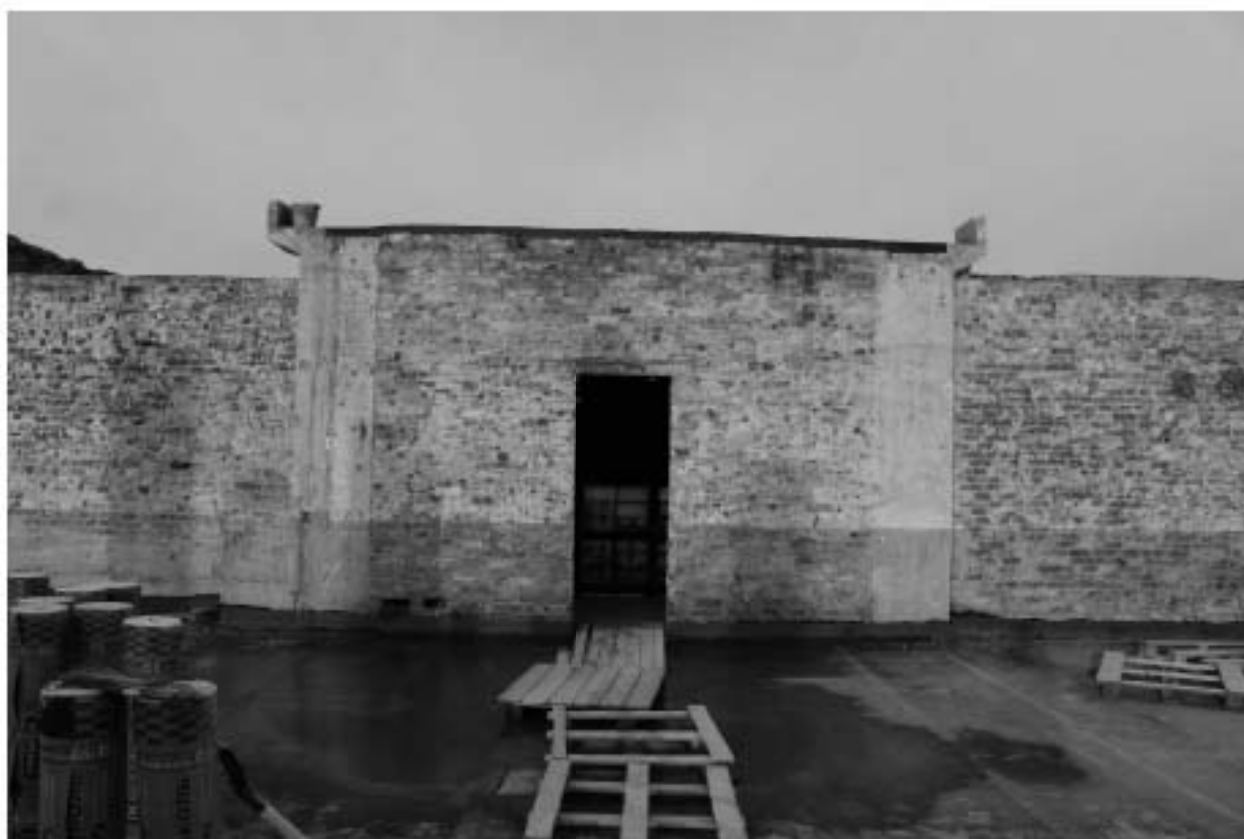
Фото 115. Объект культурного наследия регионального значения «Производственные корпуса трикотажной фабрики «Красное знамя». Крыша.
