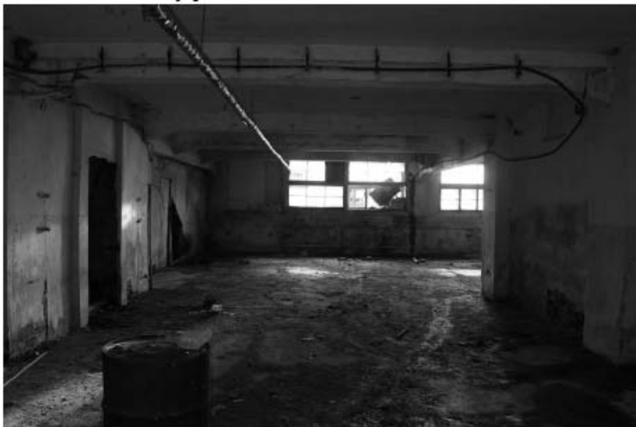
Фото 20. Объект культурного наследия регионального значения «Производственные корпуса трикотажной фабрики «Красное знамя». Внутренние помещения цокольного этажа.
