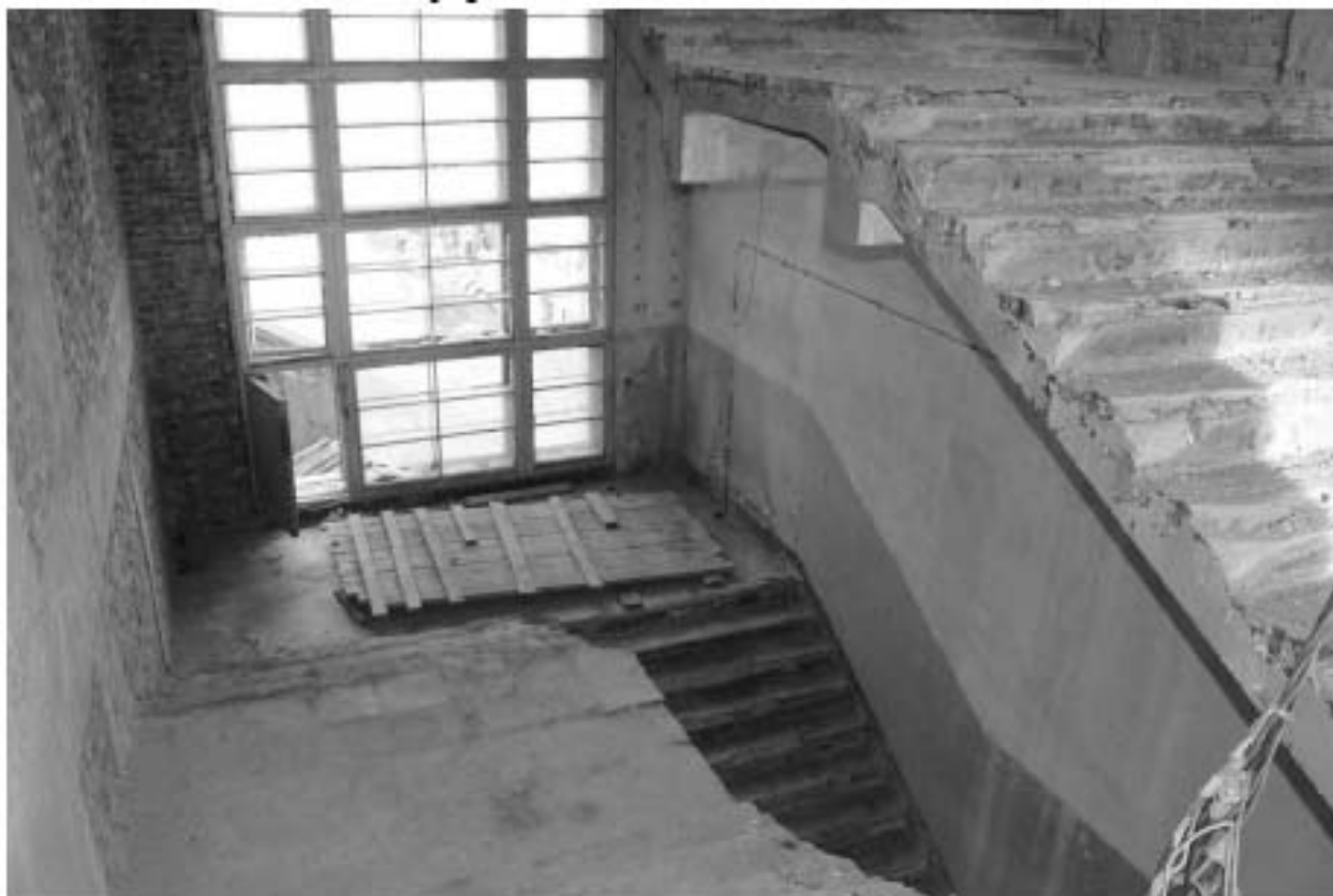
Фото 100. Объект культурного наследия регионального значения «Производственные корпуса трикотажной фабрики «Красное знамя». Лестничная клетка Л-3 в уровне 3-го этажа.
