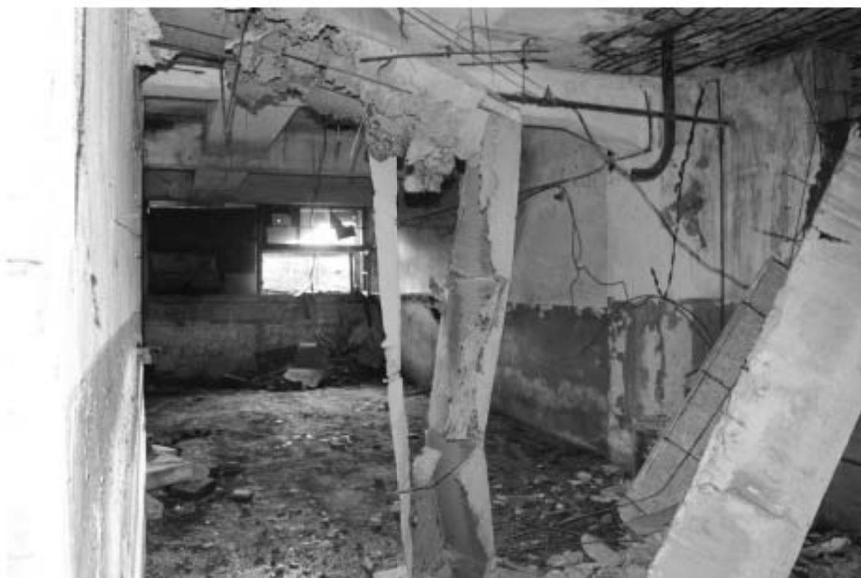
Фото 45. Объект культурного наследия регионального значения «Производственные корпуса трикотажной фабрики «Красное знамя». Внутренние помещения цокольного этажа.
