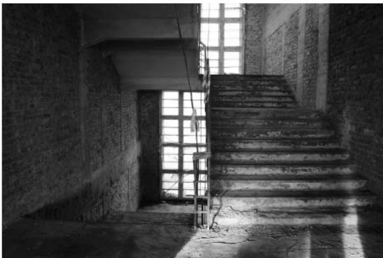
Фото 109. Объект культурного наследия регионального значения «Производственные корпуса трикотажной фабрики «Красное знамя». Лестничная клетка Л-2 в уровне 4-го этажа.
