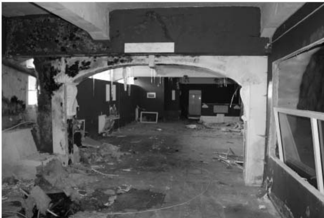
Фото 29. Объект культурного наследия регионального значения «Производственные корпуса трикотажной фабрики «Красное знамя». Внутренние помещения цокольного этажа.
