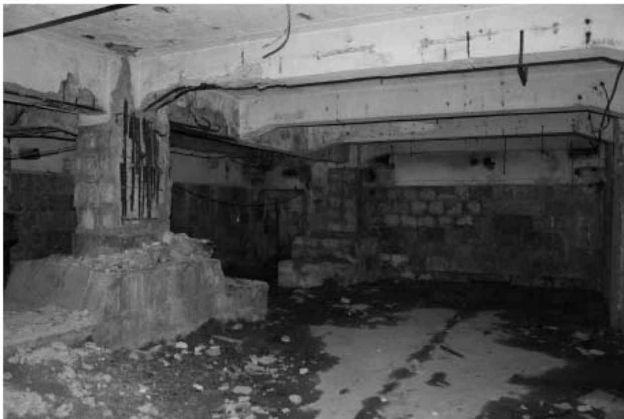
Фото 51. Объект культурного наследия регионального значения «Производственные корпуса трикотажной фабрики «Красное знамя». Внутренние помещения цокольного этажа.
