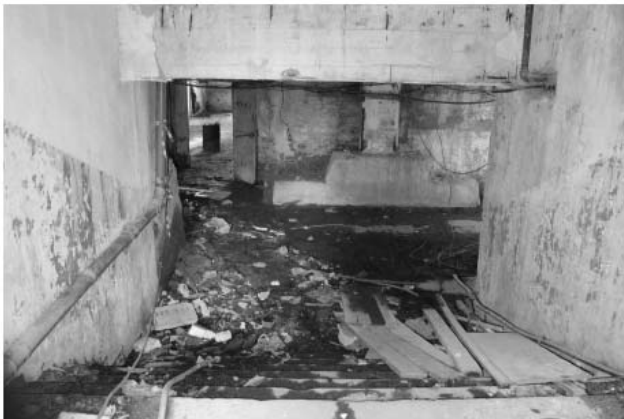
Фото 17. Объект культурного наследия регионального значения «Производственные корпуса трикотажной фабрики «Красное знамя». Внутренние помещения цокольного этажа.
