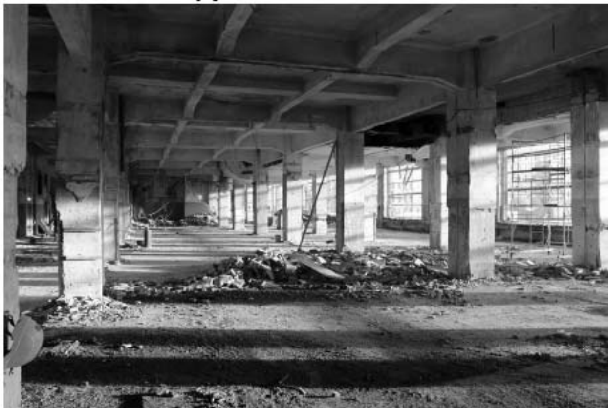
Фото 70. Объект культурного наследия регионального значения «Производственные корпуса трикотажной фабрики «Красное знамя». Внутренние помещения 1-го этажа.
