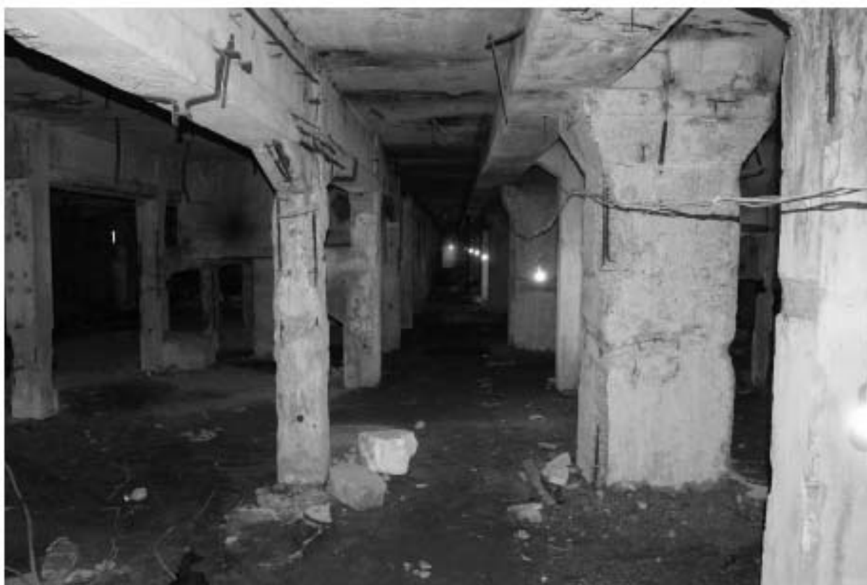
Фото 57. Объект культурного наследия регионального значения «Производственные корпуса трикотажной фабрики «Красное знамя». Внутренние помещения цокольного этажа.
