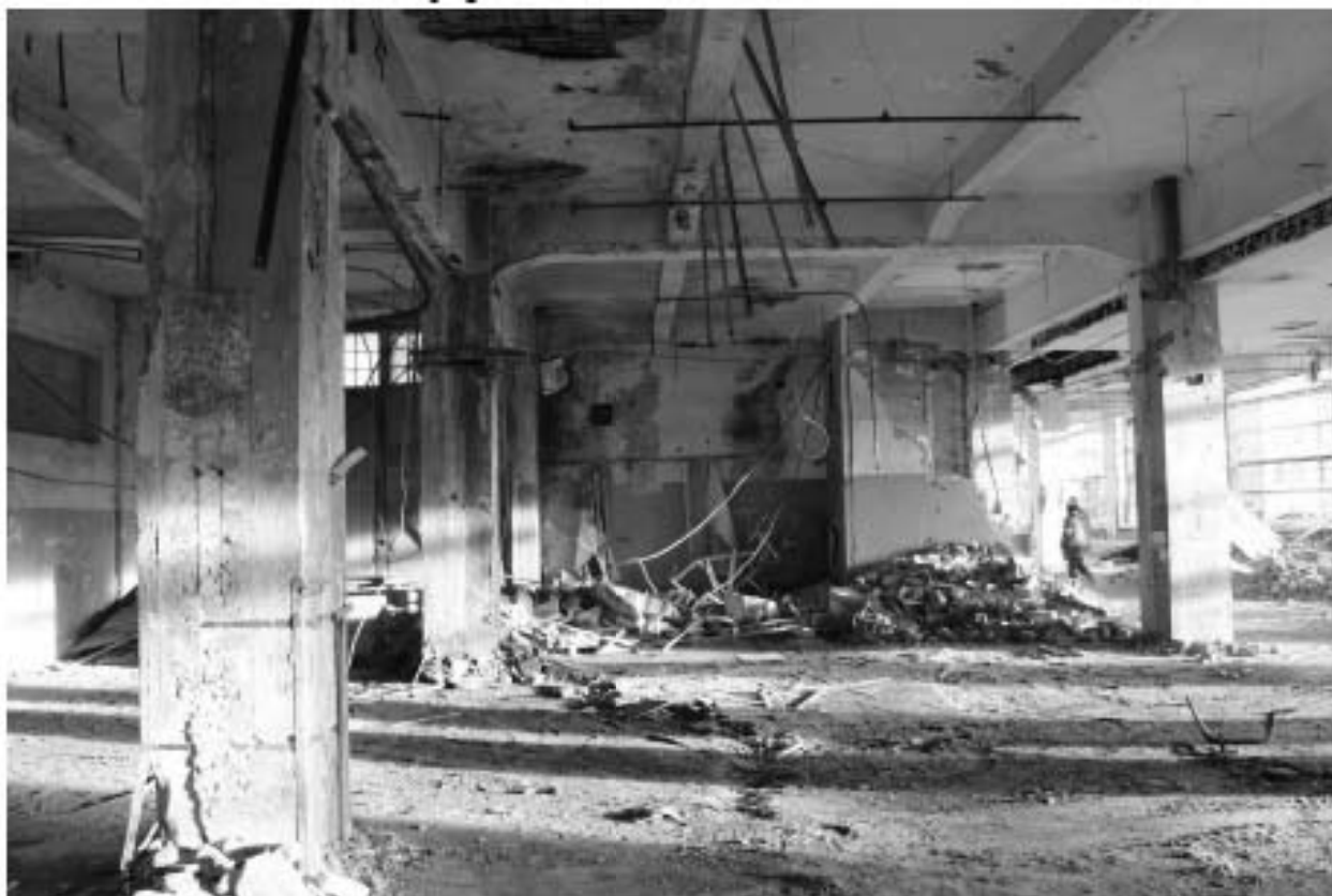
Фото 72. Объект культурного наследия регионального значения «Производственные корпуса трикотажной фабрики «Красное знамя». Внутренние помещения 1-го этажа.
