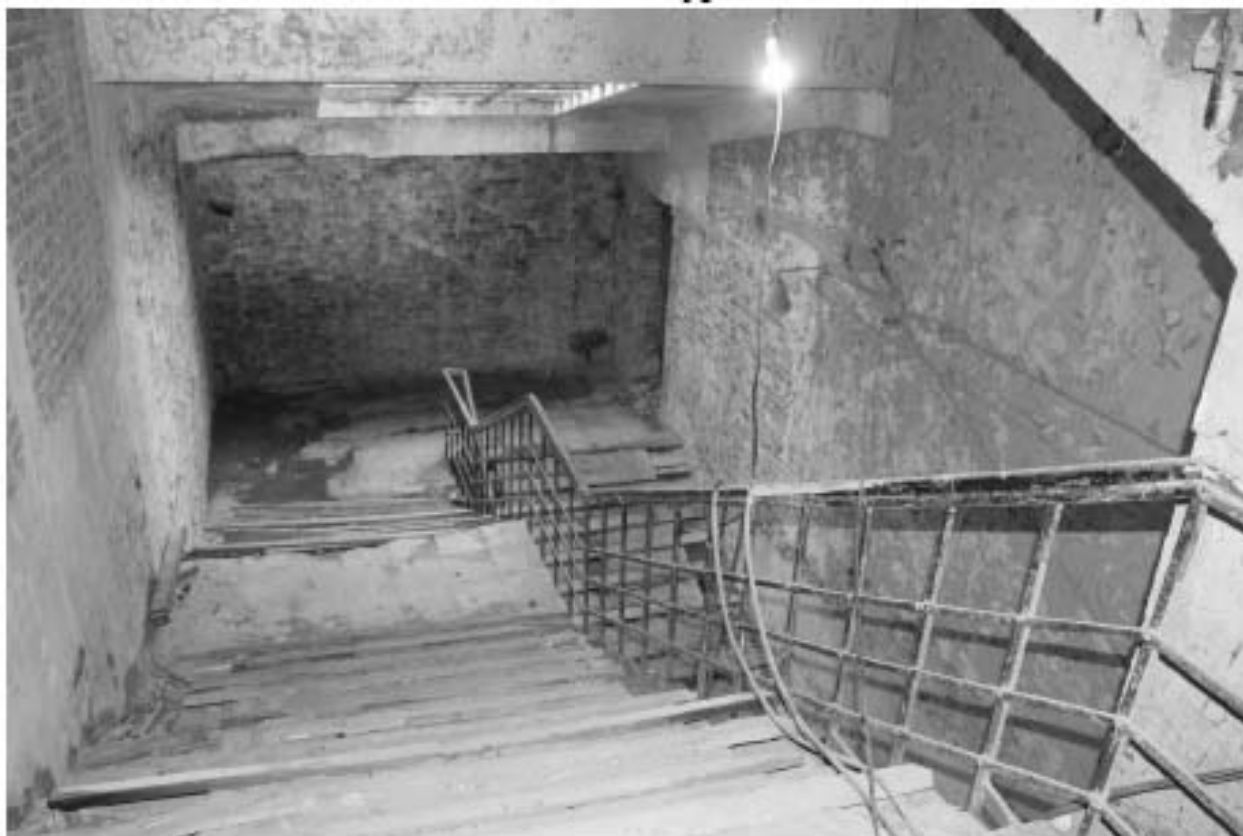
Фото 90. Объект культурного наследия регионального значения «Производственные корпуса трикотажной фабрики «Красное знамя». Лестничная клетка Л-2 вид с 2-го этажа.
