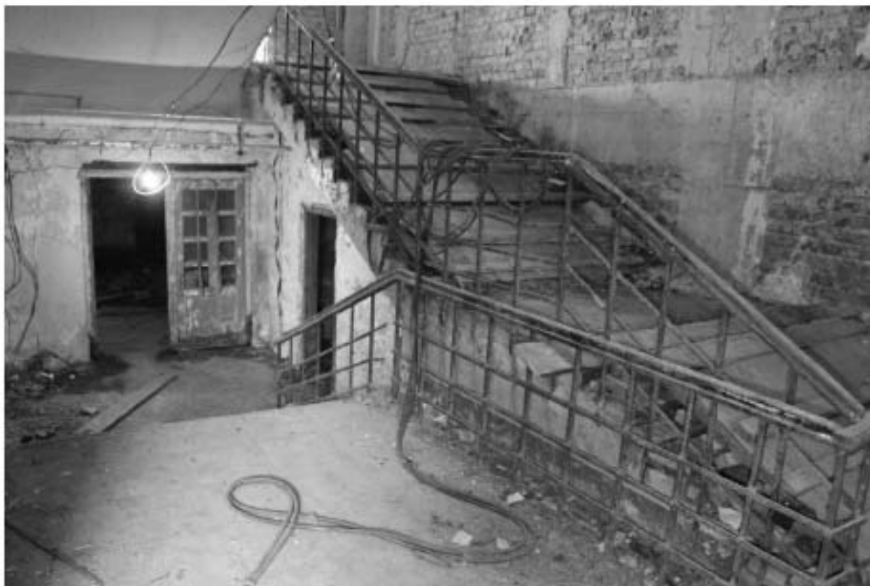
Фото 49. Объект культурного наследия регионального значения «Производственные корпуса трикотажной фабрики «Красное знамя». Лестничная клетка Л-2 в уровне цокольного этажа.
