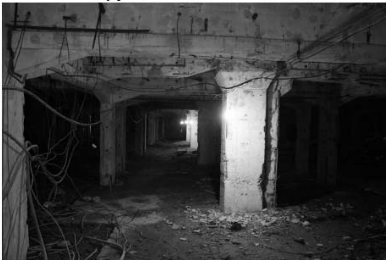
Фото 34. Объект культурного наследия регионального значения «Производственные корпуса трикотажной фабрики «Красное знамя». Внутренние помещения цокольного этажа.
