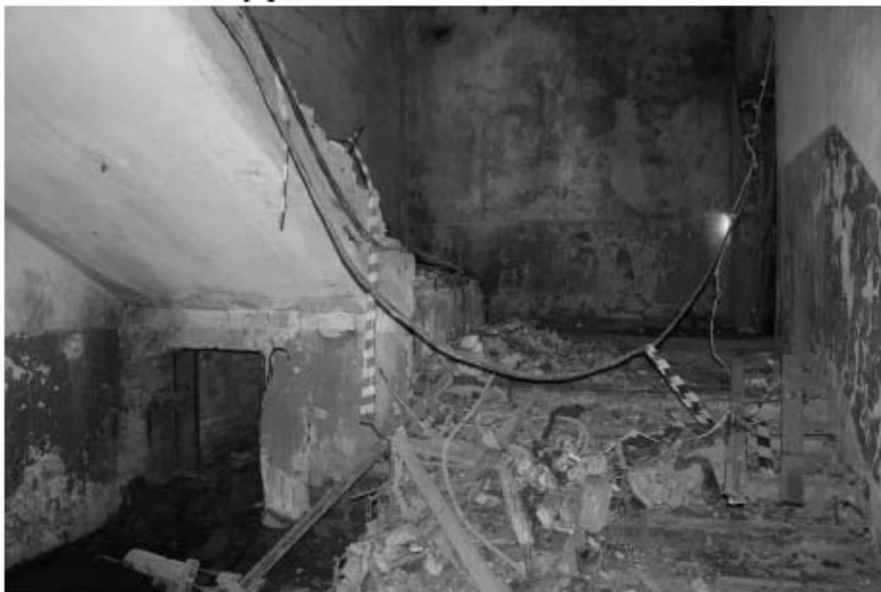
Фото 30. Объект культурного наследия регионального значения «Производственные корпуса трикотажной фабрики «Красное знамя». Лестничная клетка Л-3 в уровне цокольного этажа.
