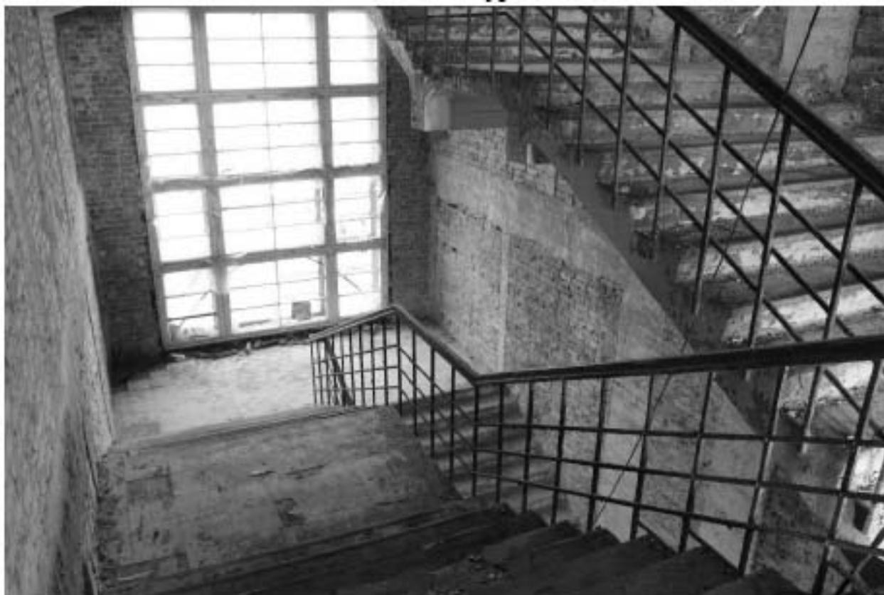
Фото 110. Объект культурного наследия регионального значения «Производственные корпуса трикотажной фабрики «Красное знамя». Лестничная клетка Л-2, вид с 4-го этажа.
