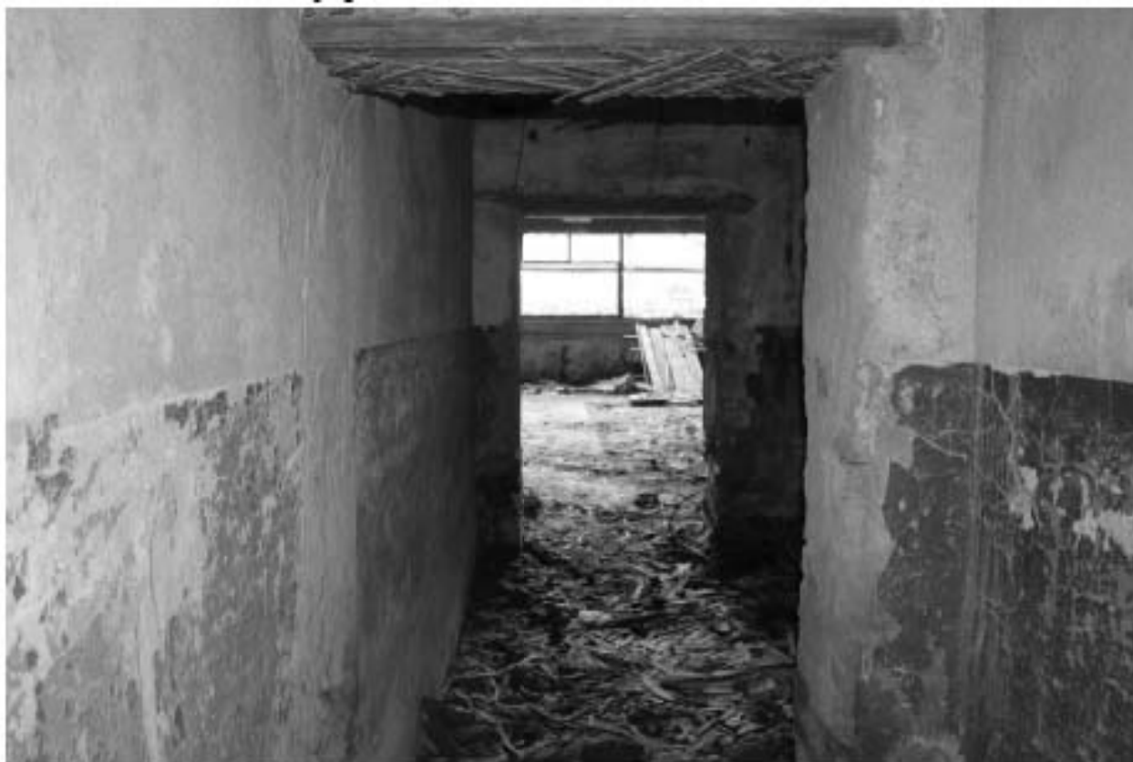
Фото 54. Объект культурного наследия регионального значения «Производственные корпуса трикотажной фабрики «Красное знамя». Внутренние помещения цокольного этажа.
