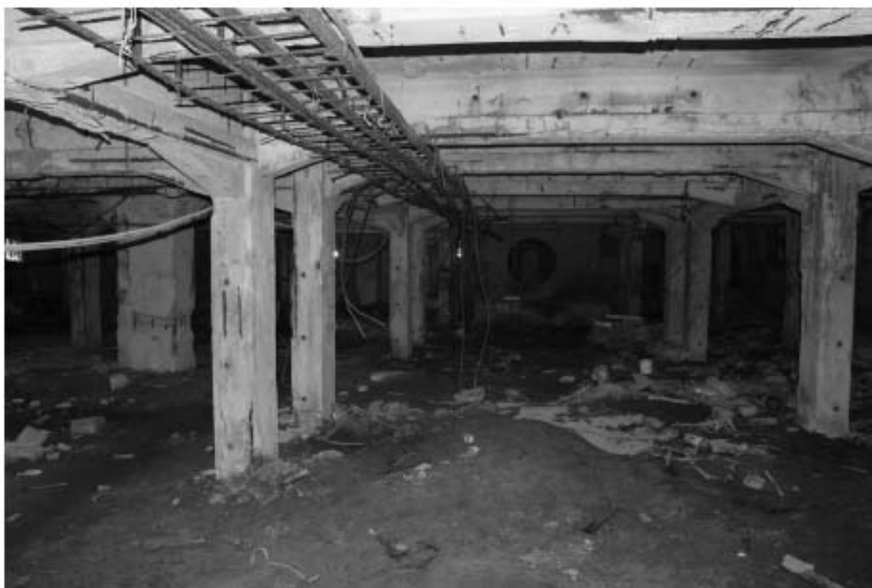
Фото 39. Объект культурного наследия регионального значения «Производственные корпуса трикотажной фабрики «Красное знамя». Внутренние помещения цокольного этажа.
