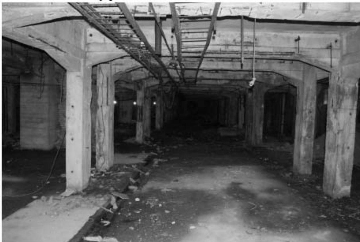
Фото 38. Объект культурного наследия регионального значения «Производственные корпуса трикотажной фабрики «Красное знамя». Внутренние помещения цокольного этажа.
