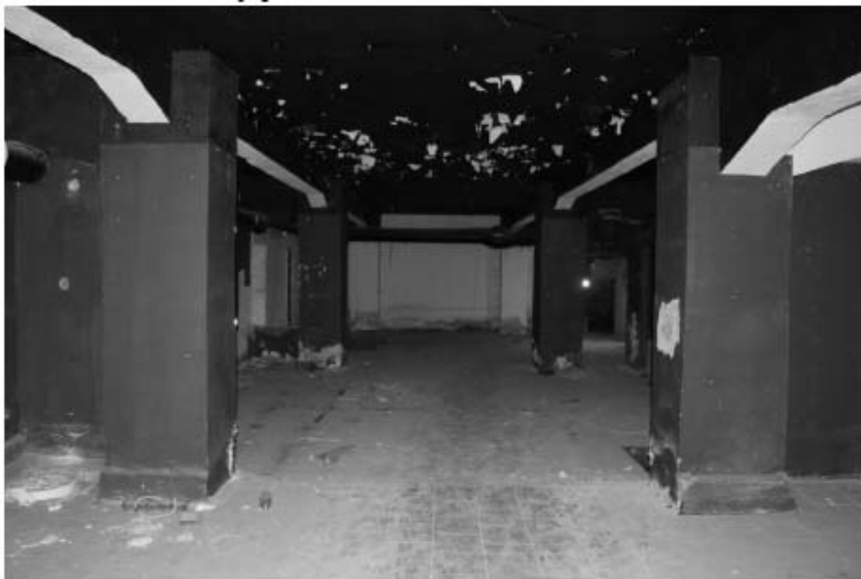
Фото 26. Объект культурного наследия регионального значения «Производственные корпуса трикотажной фабрики «Красное знамя». Внутренние помещения цокольного этажа.
