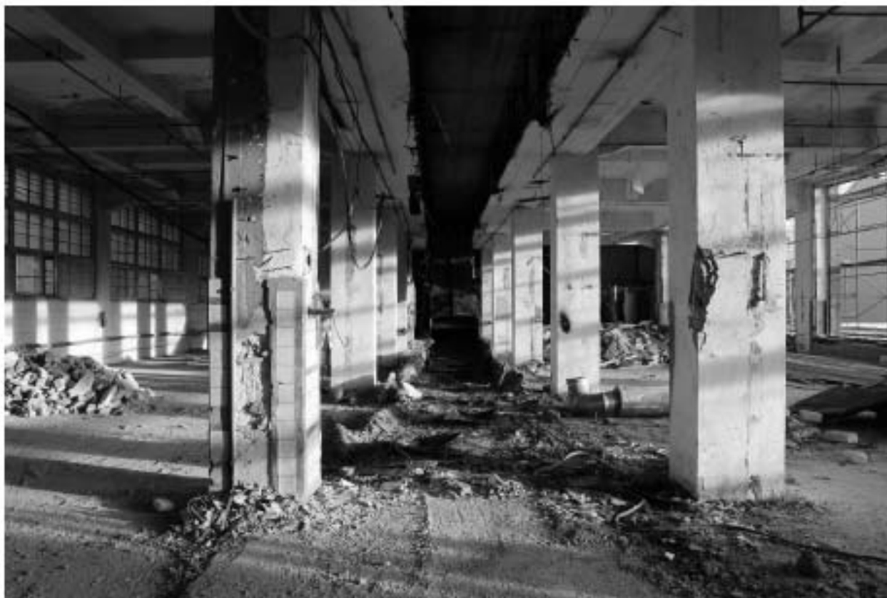
Фото 79. Объект культурного наследия регионального значения «Производственные корпуса трикотажной фабрики «Красное знамя». Внутренние помещения 1-го этажа.
