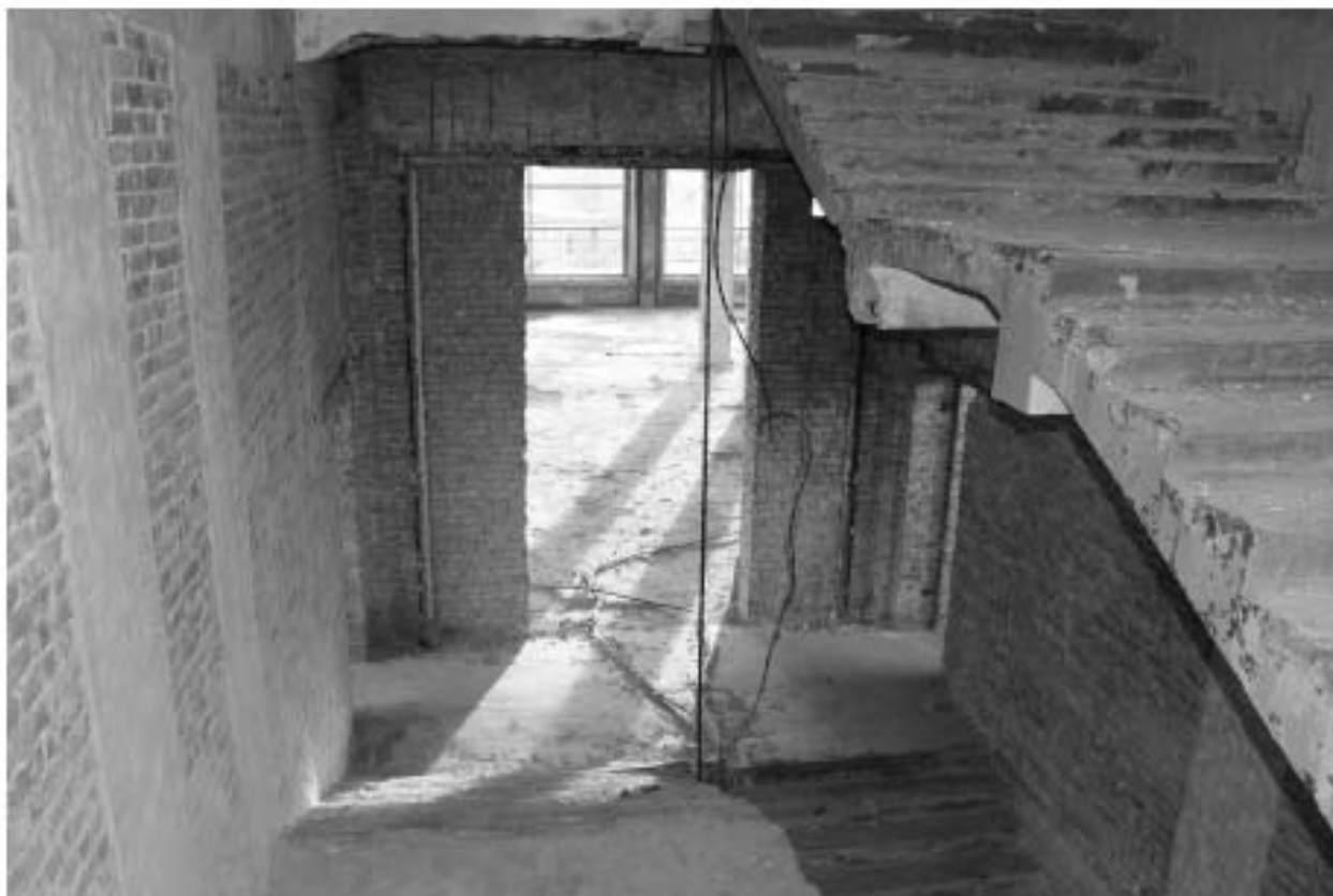
Фото 101. Объект культурного наследия регионального значения «Производственные корпуса трикотажной фабрики «Красное знамя». Лестничная клетка Л-3 в уровне 3-го этажа.
