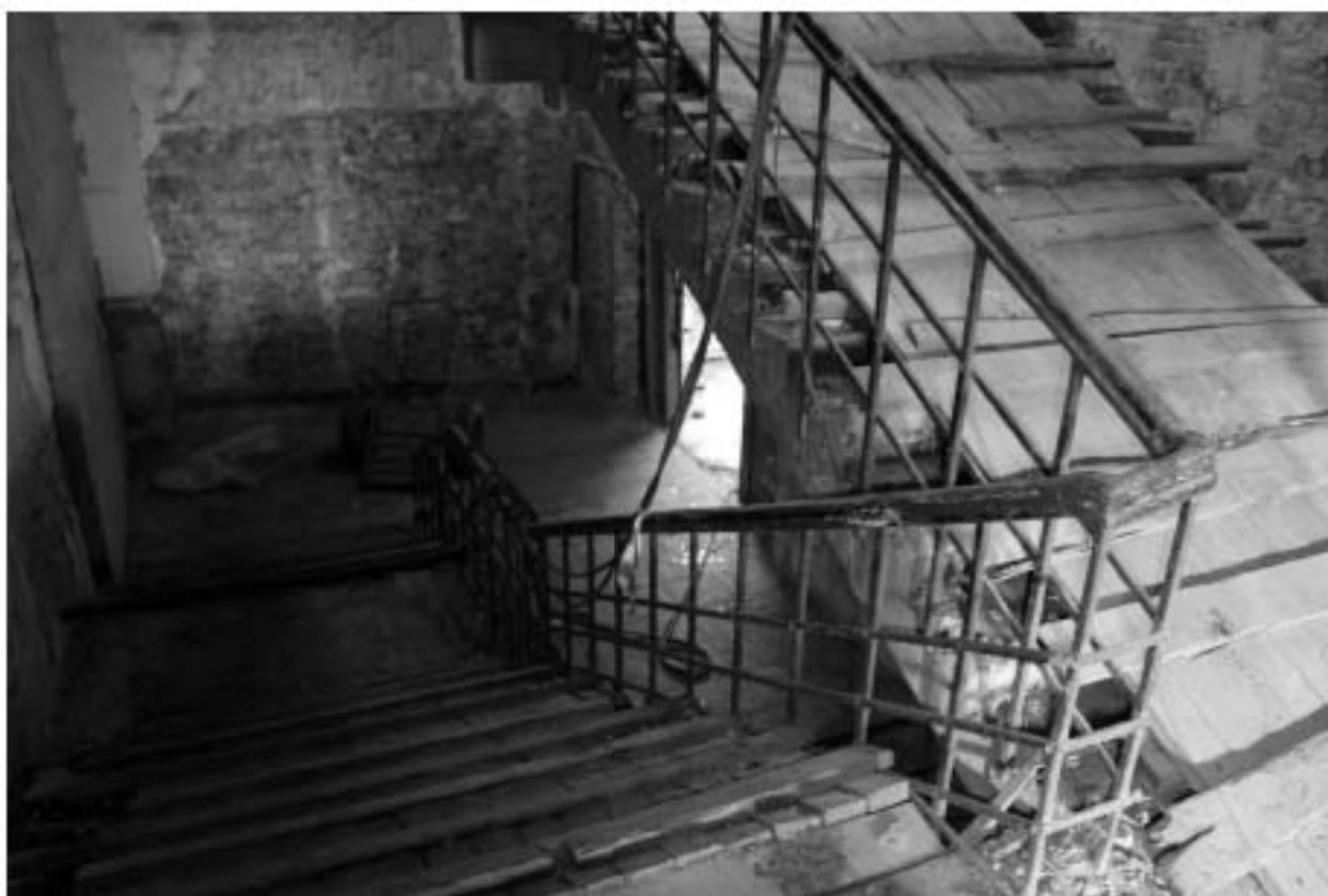
Фото 63. Объект культурного наследия регионального значения «Производственные корпуса трикотажной фабрики «Красное знамя». Лестничная клетка Л-2 в уровне цокольного – 1-го этажей.
