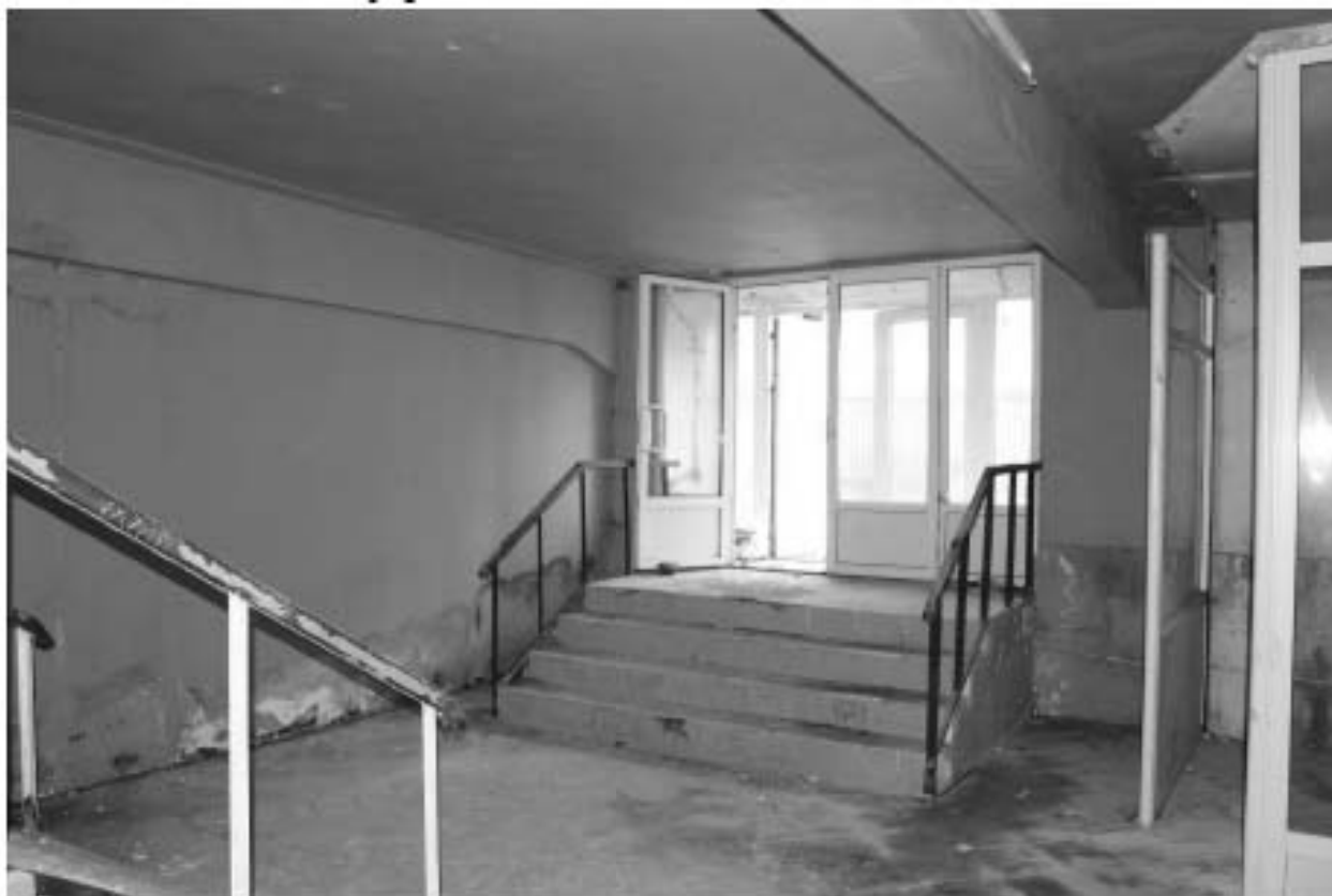
Фото 28. Объект культурного наследия регионального значения «Производственные корпуса трикотажной фабрики «Красное знамя». Внутренние помещения цокольного этажа.
