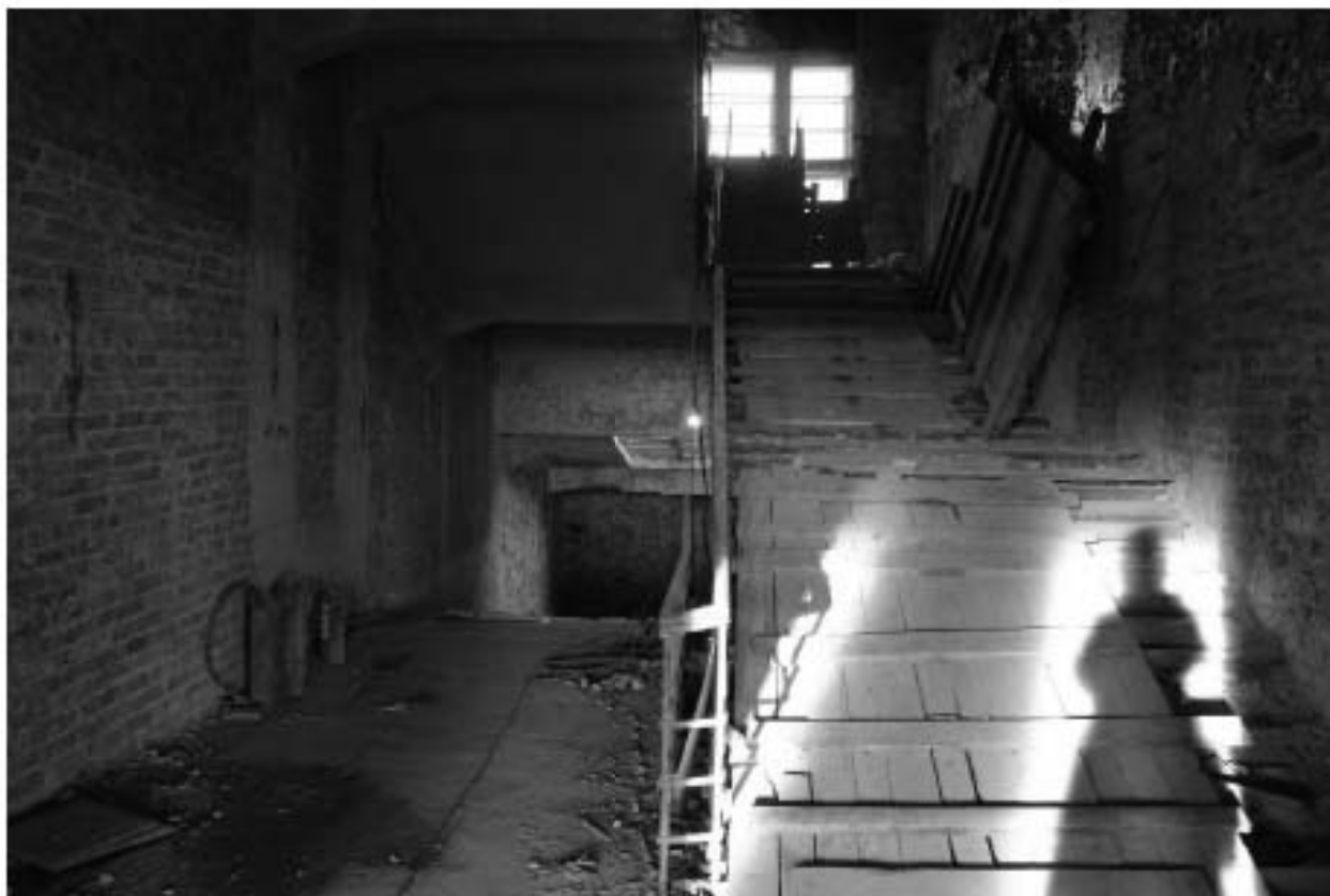
Фото 89. Объект культурного наследия регионального значения «Производственные корпуса трикотажной фабрики «Красное знамя». Лестничная клетка Л-2 в уровне 2-го этажа.
