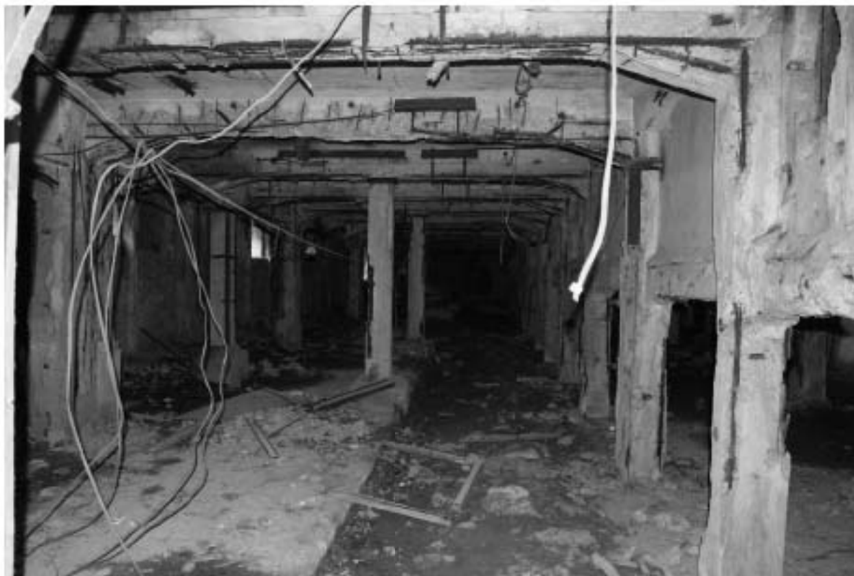
Фото 59. Объект культурного наследия регионального значения «Производственные корпуса трикотажной фабрики «Красное знамя». Внутренние помещения цокольного этажа.
