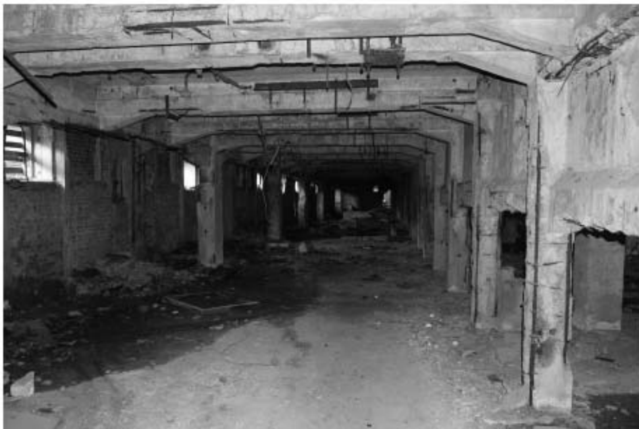
Фото 61. Объект культурного наследия регионального значения «Производственные корпуса трикотажной фабрики «Красное знамя». Внутренние помещения цокольного этажа.
