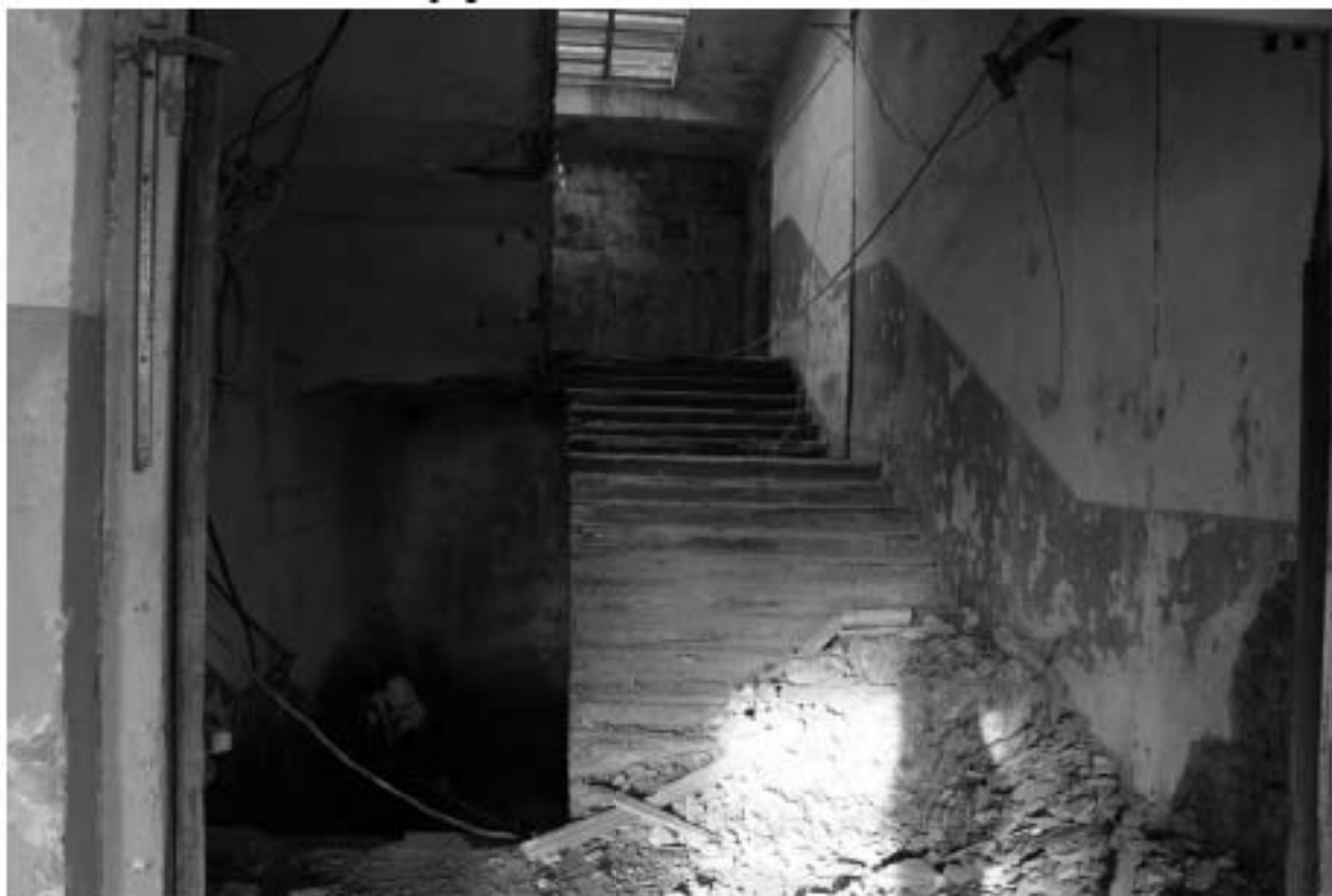
Фото 78. Объект культурного наследия регионального значения «Производственные корпуса трикотажной фабрики «Красное знамя». Лестничная клетка Л-3 в уровне 1-го этажа.
