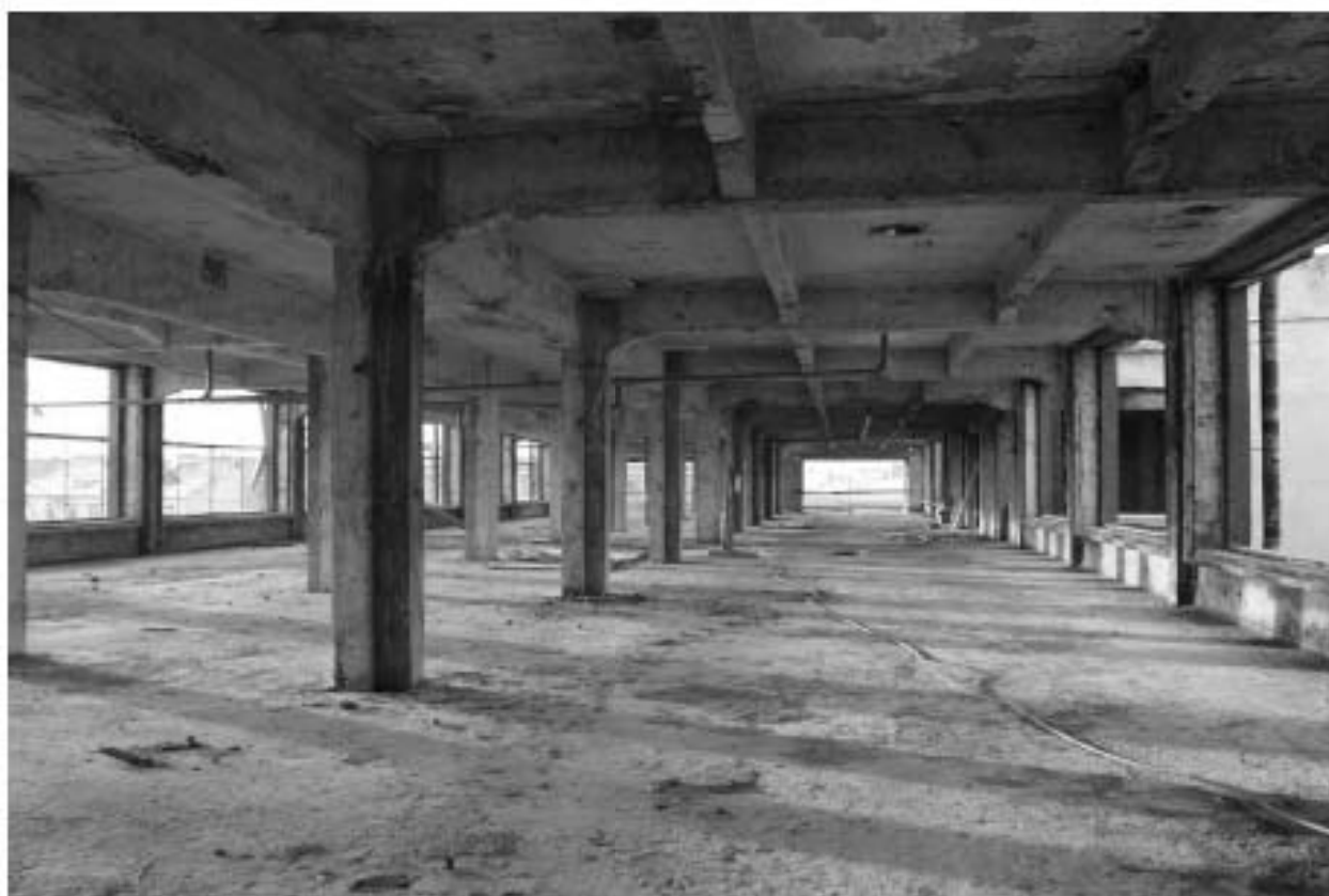
Фото 103. Объект культурного наследия регионального значения «Производственные корпуса трикотажной фабрики «Красное знамя». Внутренние помещения 4-го этажа.
