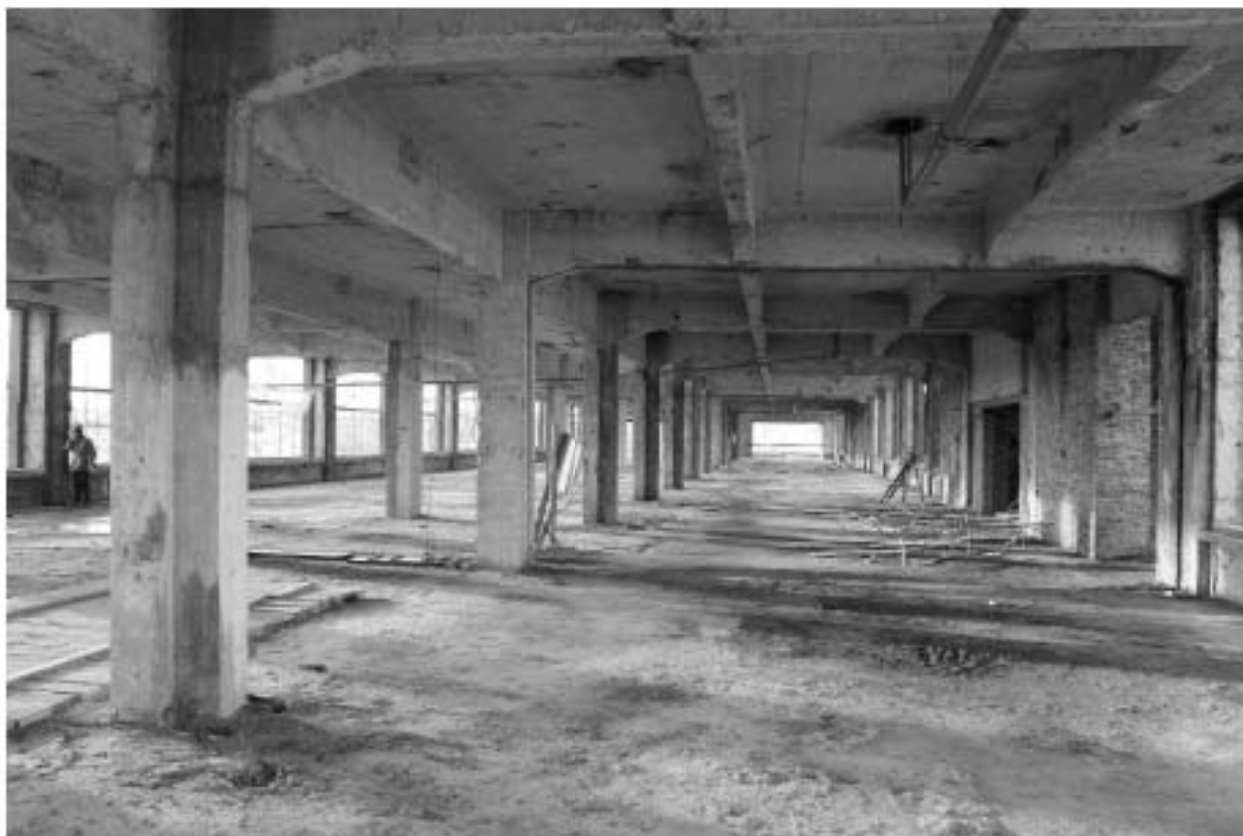
Фото 105. Объект культурного наследия регионального значения «Производственные корпуса трикотажной фабрики «Красное знамя». Внутренние помещения 4-го этажа.
