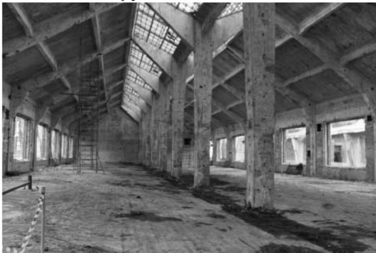
Фото 76. Объект культурного наследия регионального значения «Производственные корпуса трикотажной фабрики «Красное знамя». Внутренние помещения 1-го этажа.
