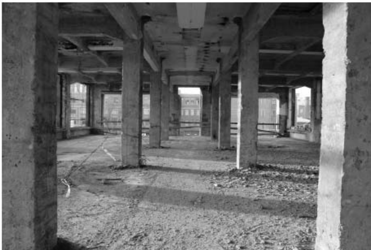
Фото 87. Объект культурного наследия регионального значения «Производственные корпуса трикотажной фабрики «Красное знамя». Внутренние помещения 2-го этажа.
