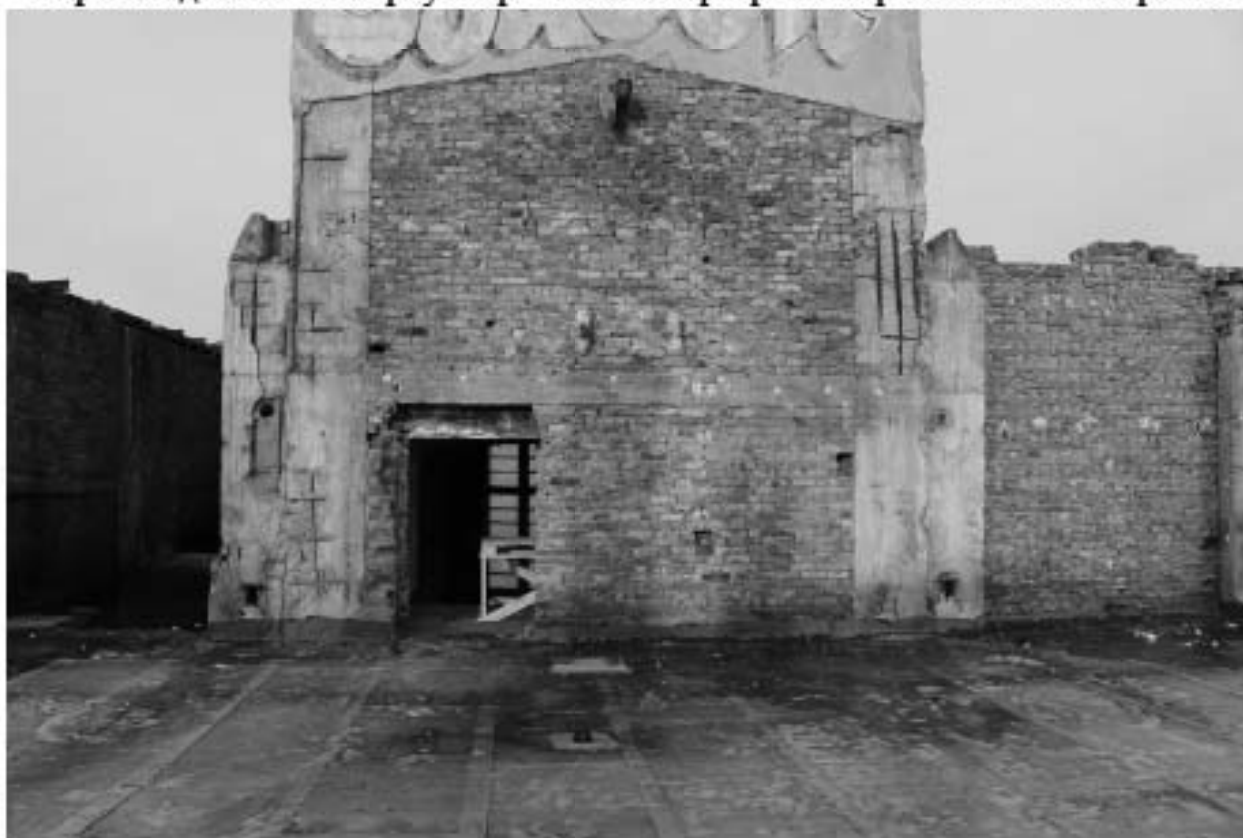
Фото 118. Объект культурного наследия регионального значения «Производственные корпуса трикотажной фабрики «Красное знамя». Крыша.
