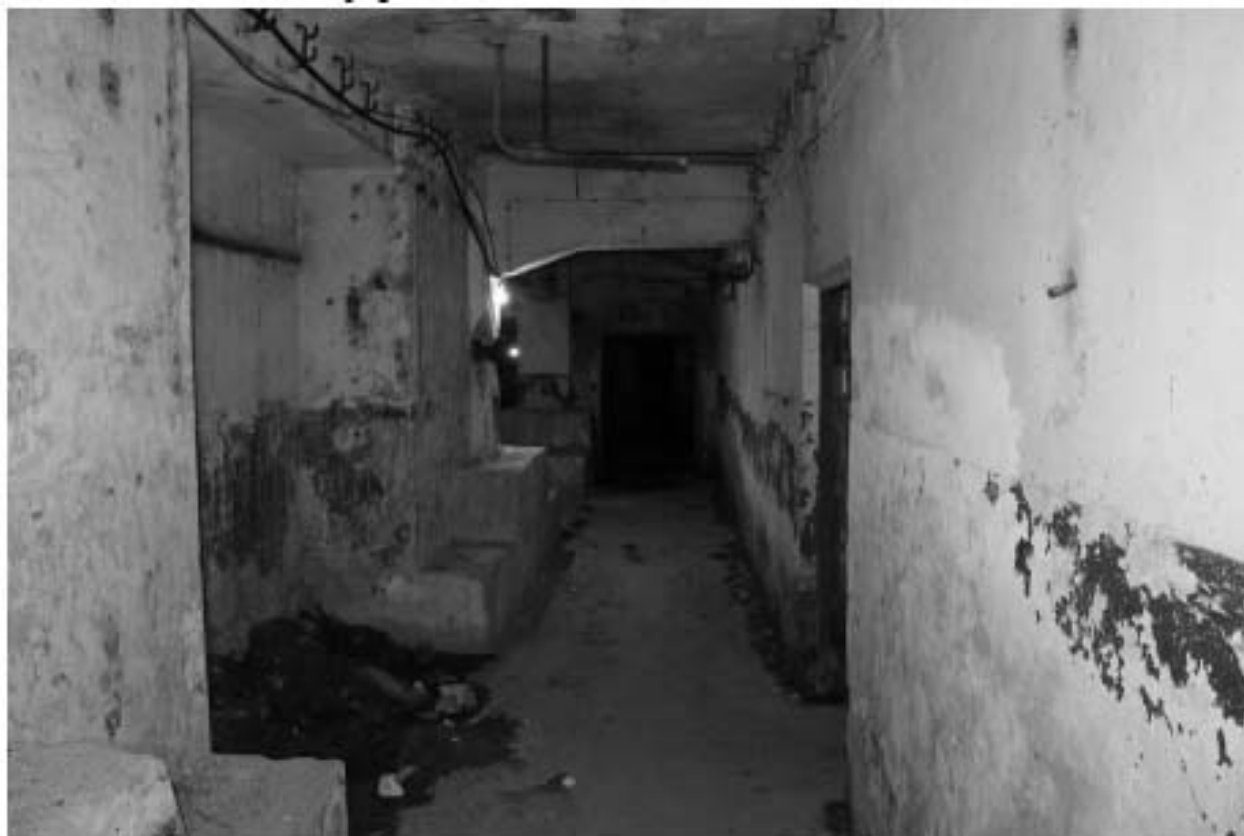
Фото 44. Объект культурного наследия регионального значения «Производственные корпуса трикотажной фабрики «Красное знамя». Внутренние помещения цокольного этажа.
