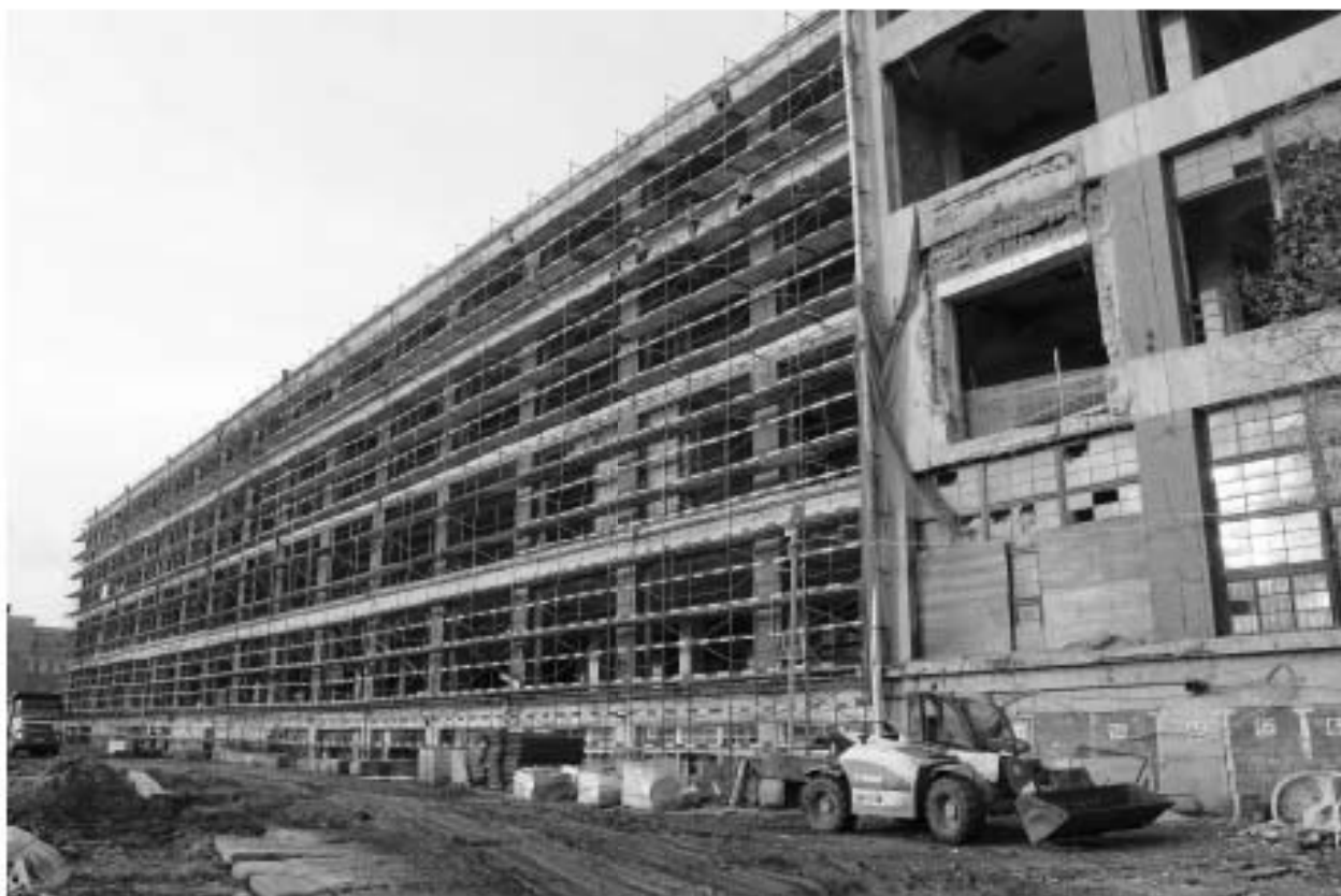
Фото 1. Вид на юго-восточный фасад Главного трикотажного цеха (1 очередь) объекта культурного наследия регионального значения «Производственные корпуса трикотажной фабрики «Красное знамя».
