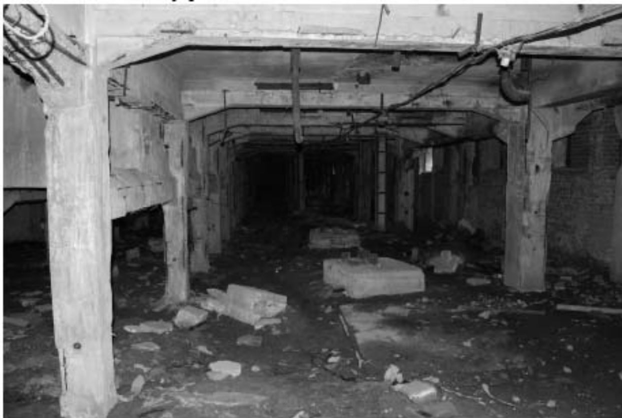
Фото 58. Объект культурного наследия регионального значения «Производственные корпуса трикотажной фабрики «Красное знамя». Внутренние помещения цокольного этажа.
