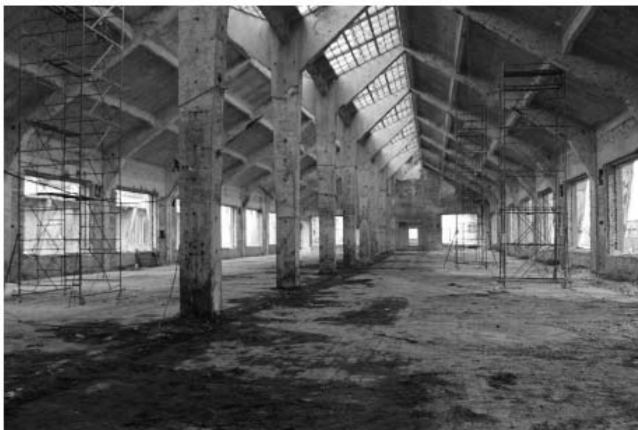
Фото 75. Объект культурного наследия регионального значения «Производственные корпуса трикотажной фабрики «Красное знамя». Внутренние помещения 1-го этажа.
