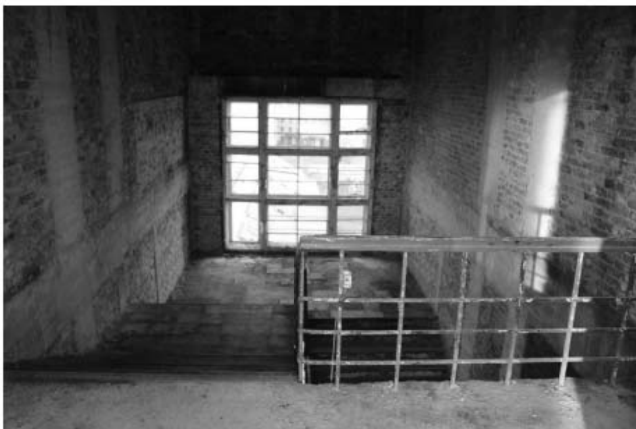
Фото 113. Объект культурного наследия регионального значения «Производственные корпуса трикотажной фабрики «Красное знамя». Лестничная клетка Л-2, вид с 5-го этажа.
