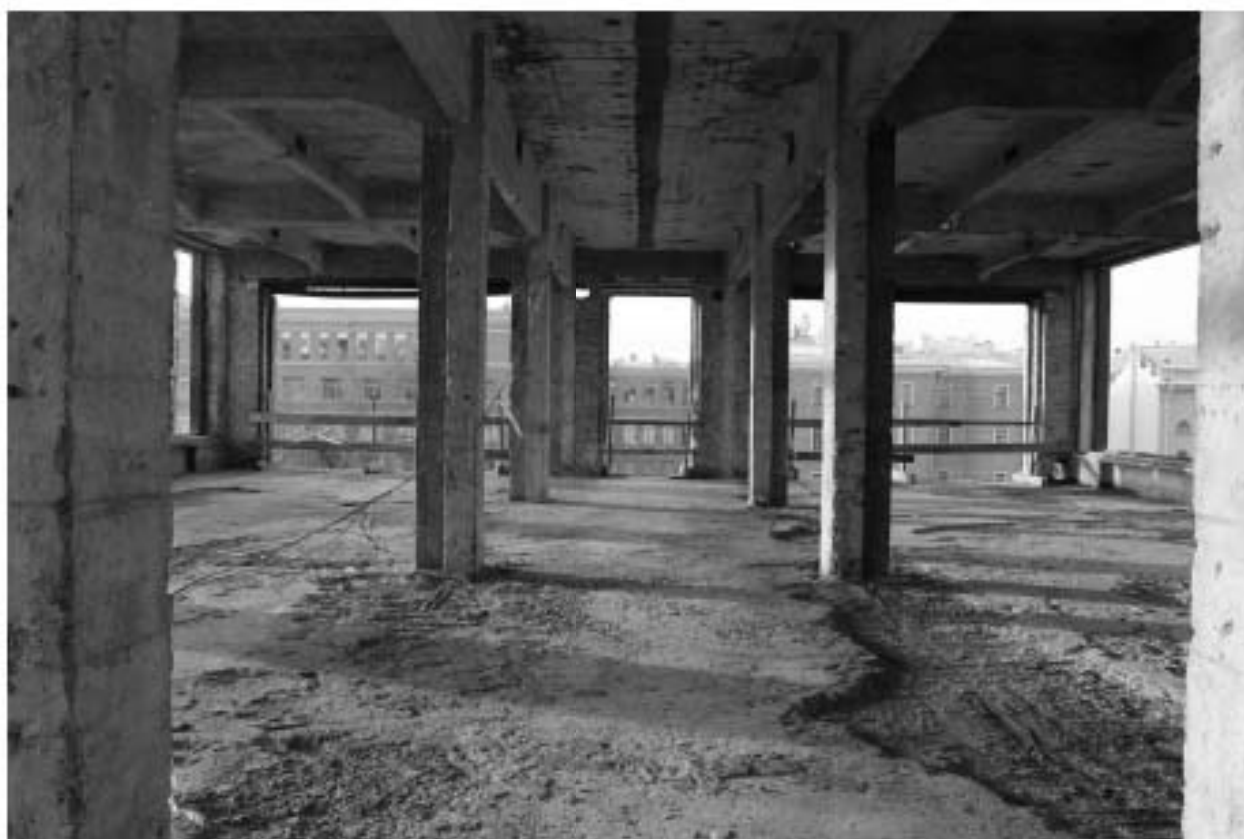
Фото 93. Объект культурного наследия регионального значения «Производственные корпуса трикотажной фабрики «Красное знамя». Внутренние помещения 3-го этажа.
