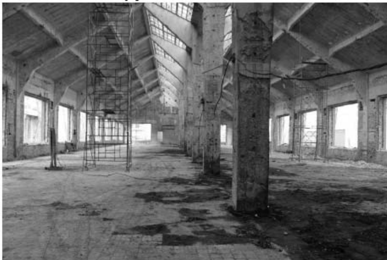
Фото 74. Объект культурного наследия регионального значения «Производственные корпуса трикотажной фабрики «Красное знамя». Внутренние помещения 1-го этажа.
