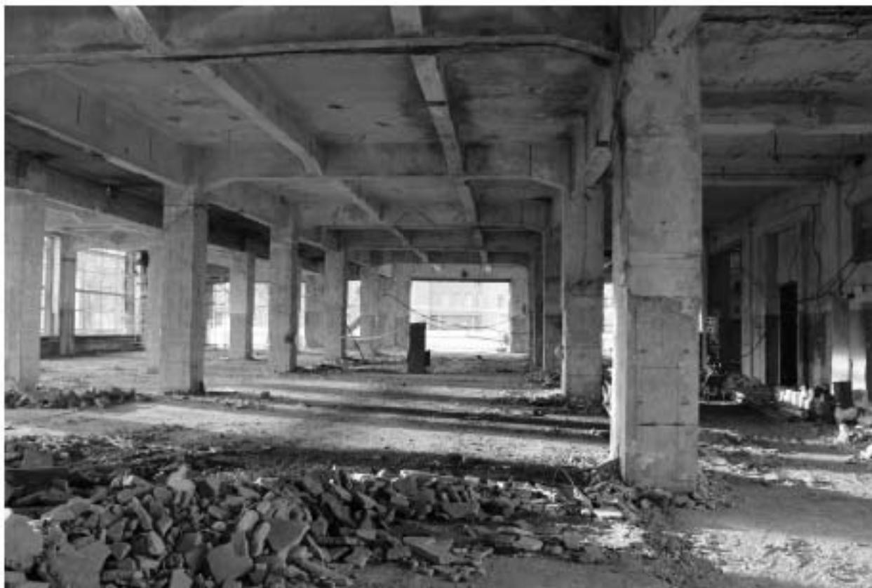
Фото 71. Объект культурного наследия регионального значения «Производственные корпуса трикотажной фабрики «Красное знамя». Внутренние помещения 1-го этажа.
