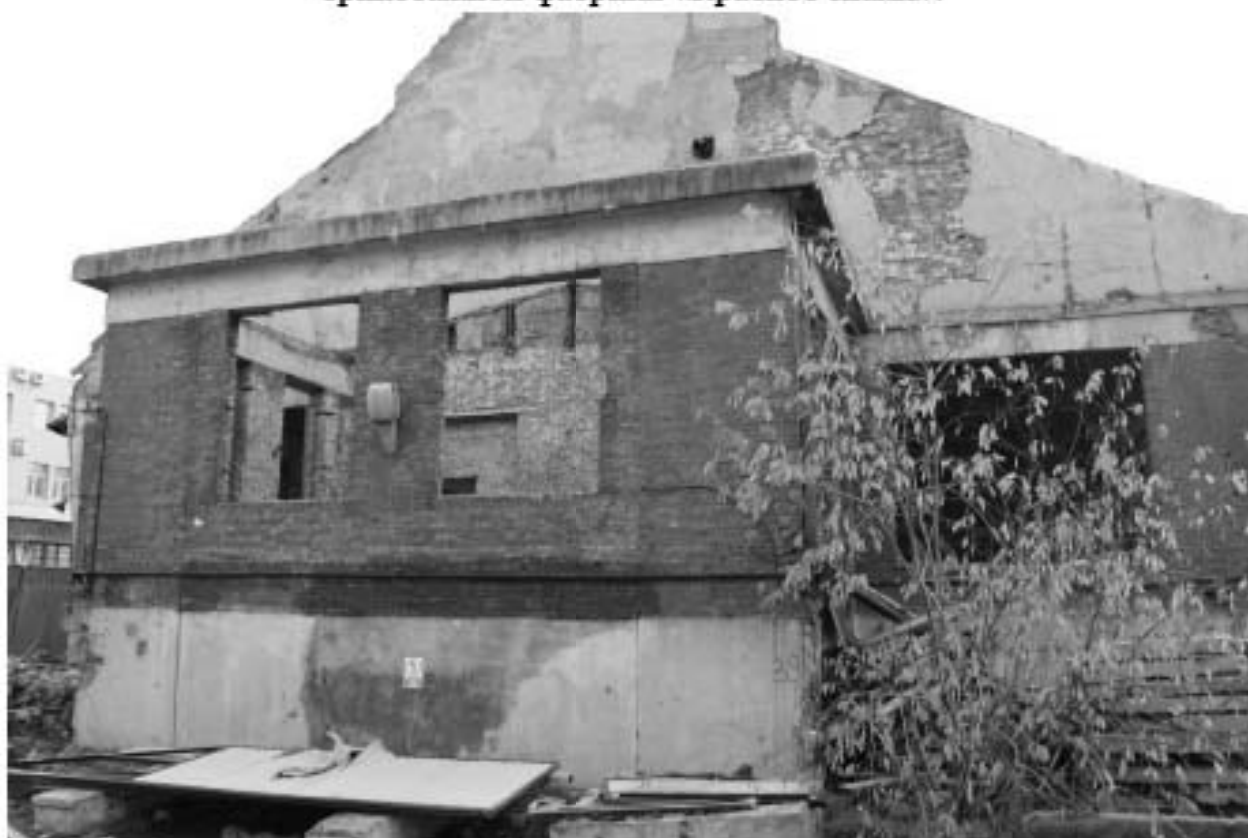
Фото 12. Вид на северо-западный фасад Отбельного цеха объекта культурного наследия регионального значения «Производственные корпуса трикотажной фабрики «Красное знамя».
