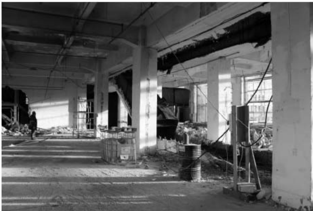
Фото 81. Объект культурного наследия регионального значения «Производственные корпуса трикотажной фабрики «Красное знамя». Внутренние помещения 1-го этажа.
