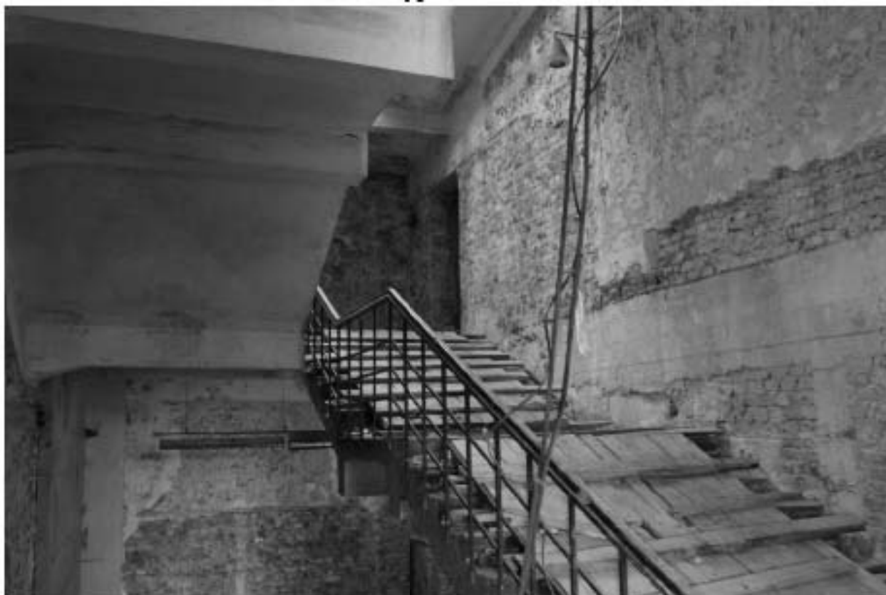
Фото 64. Объект культурного наследия регионального значения «Производственные корпуса трикотажной фабрики «Красное знамя». Лестничная клетка Л-2, вид с 1-го этажа.
