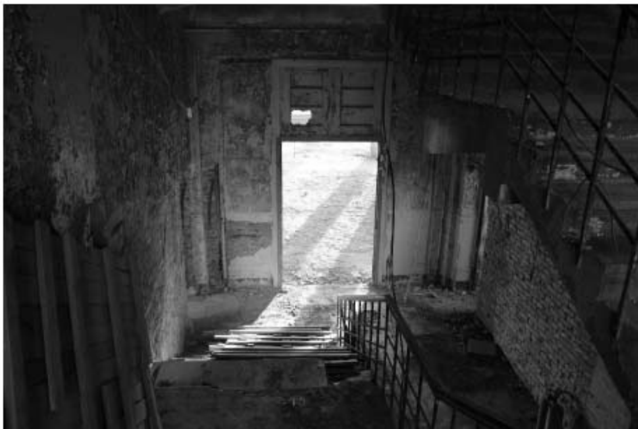
Фото 91. Объект культурного наследия регионального значения «Производственные корпуса трикотажной фабрики «Красное знамя». Лестничная клетка Л-2 в уровне 2-го – 3-го этажей.
