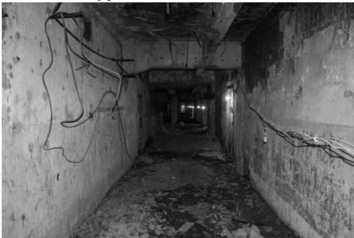
Фото 56. Объект культурного наследия регионального значения «Производственные корпуса трикотажной фабрики «Красное знамя». Внутренние помещения цокольного этажа.
