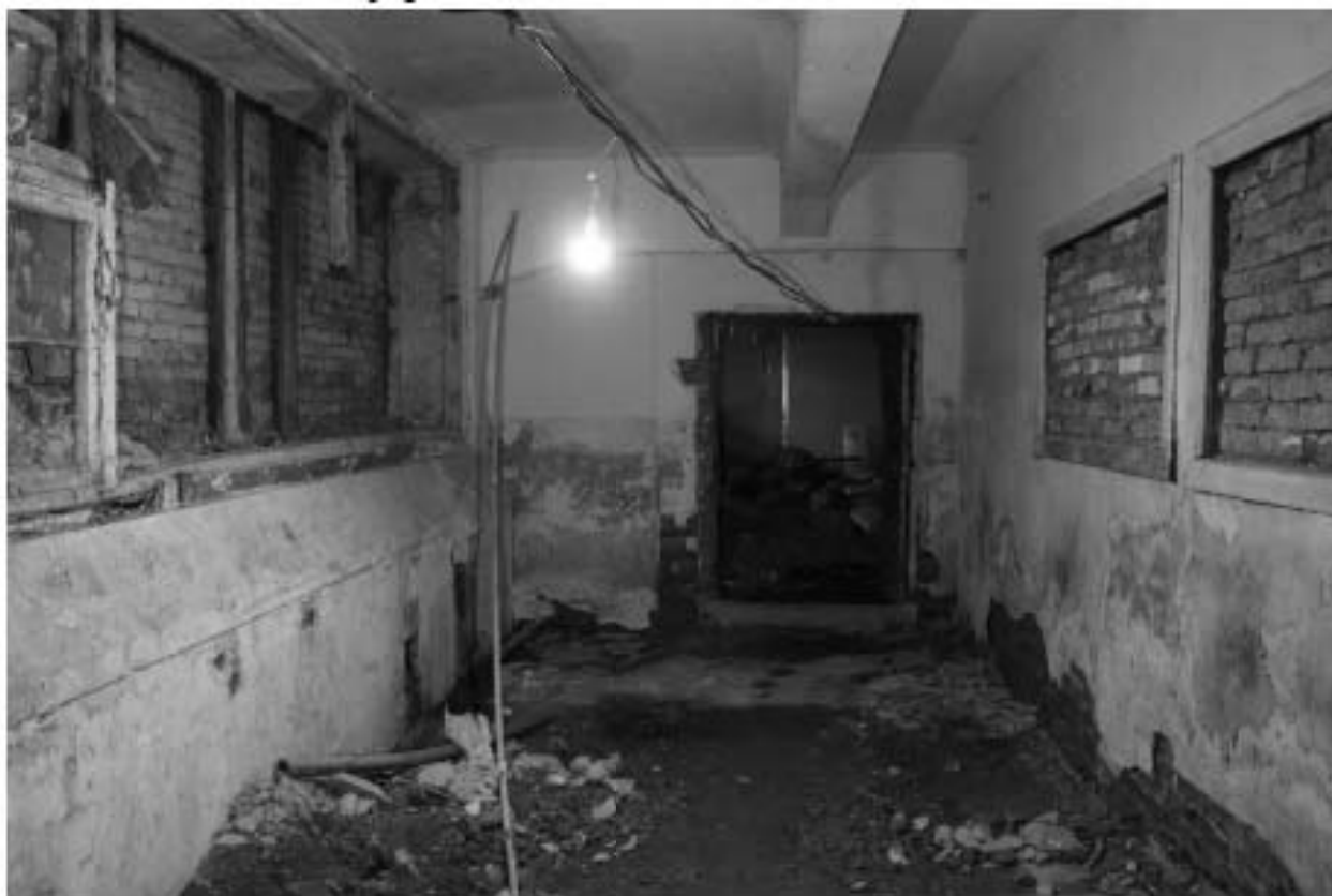
Фото 22. Объект культурного наследия регионального значения «Производственные корпуса трикотажной фабрики «Красное знамя». Внутренние помещения цокольного этажа.
