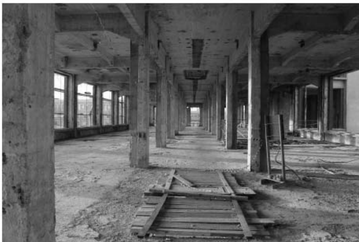
Фото 95. Объект культурного наследия регионального значения «Производственные корпуса трикотажной фабрики «Красное знамя». Внутренние помещения 3-го этажа.
