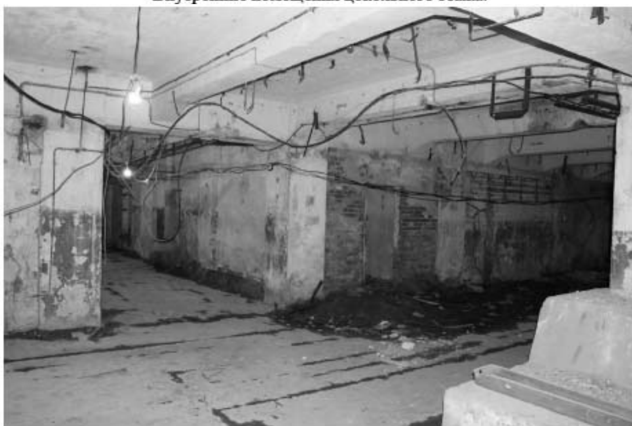
Фото 42. Объект культурного наследия регионального значения «Производственные корпуса трикотажной фабрики «Красное знамя». Внутренние помещения цокольного этажа.
