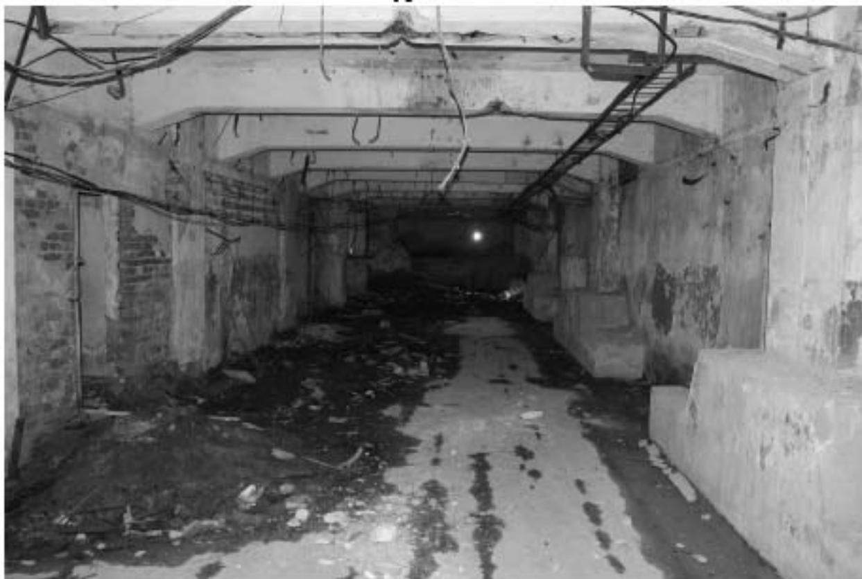
Фото 32. Объект культурного наследия регионального значения «Производственные корпуса трикотажной фабрики «Красное знамя». Внутренние помещения цокольного этажа.
