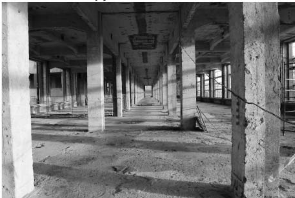
Фото 94. Объект культурного наследия регионального значения «Производственные корпуса трикотажной фабрики «Красное знамя». Внутренние помещения 3-го этажа.
