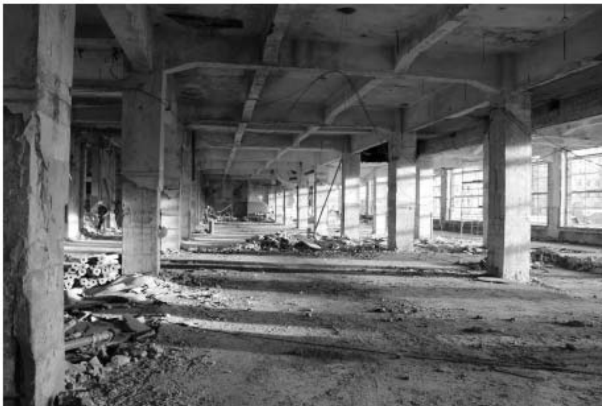
Фото 67. Объект культурного наследия регионального значения «Производственные корпуса трикотажной фабрики «Красное знамя». Внутренние помещения 1-го этажа.
