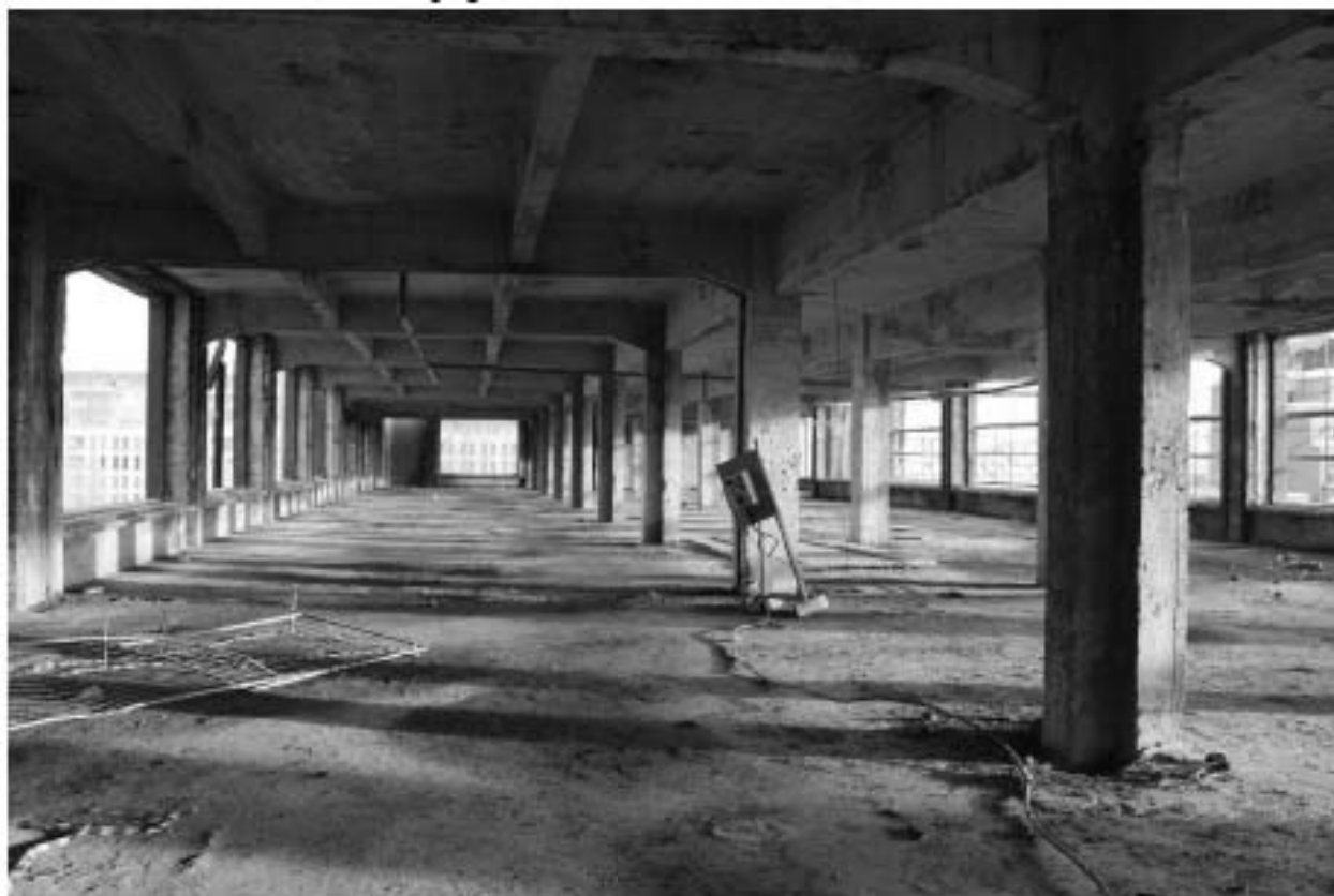
Фото 104. Объект культурного наследия регионального значения «Производственные корпуса трикотажной фабрики «Красное знамя». Внутренние помещения 4-го этажа.
