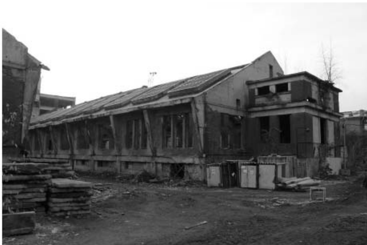
Фото 11. Вид на северо-восточный фасад Красильного цеха объекта культурного наследия регионального значения «Производственные корпуса трикотажной фабрики «Красное знамя».
