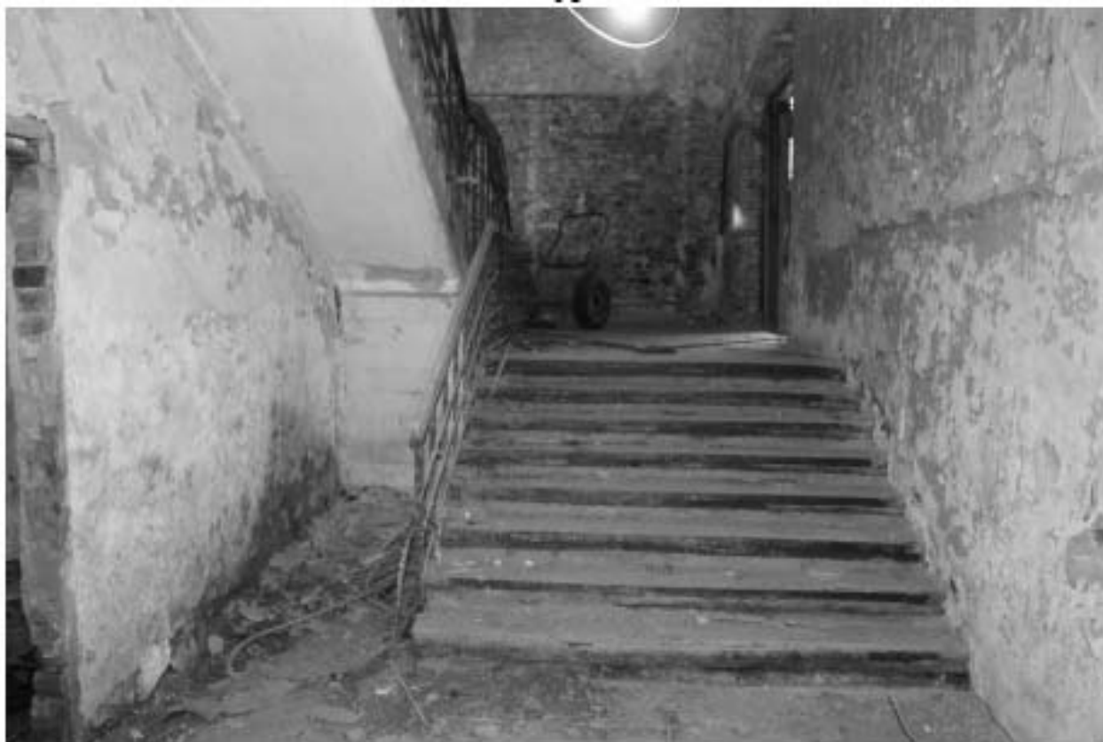
Фото 50. Объект культурного наследия регионального значения «Производственные корпуса трикотажной фабрики «Красное знамя». Лестничная клетка Л-2 в уровне цокольного этажа.
