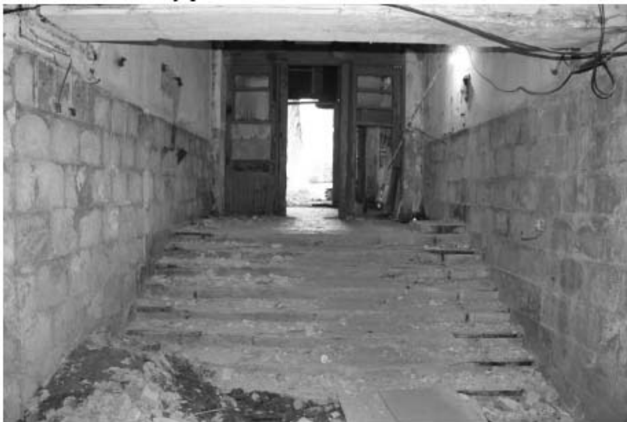
Фото 48. Объект культурного наследия регионального значения «Производственные корпуса трикотажной фабрики «Красное знамя». Внутренние помещения цокольного этажа.
