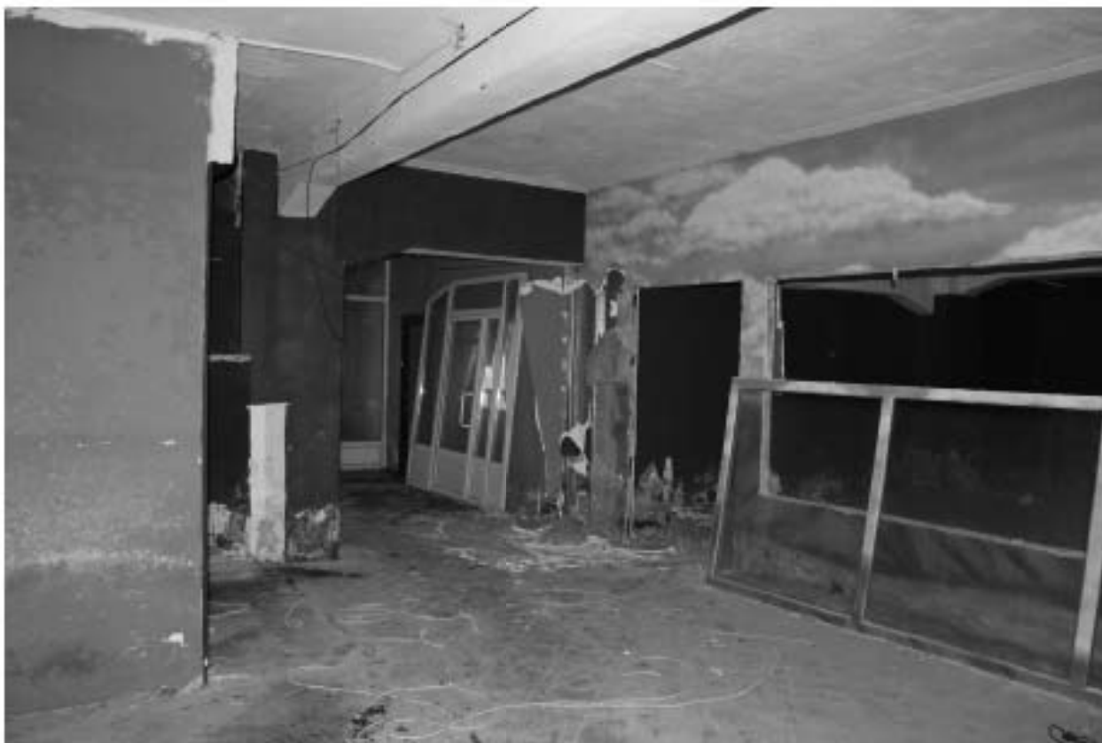
Фото 27. Объект культурного наследия регионального значения «Производственные корпуса трикотажной фабрики «Красное знамя». Внутренние помещения цокольного этажа.
