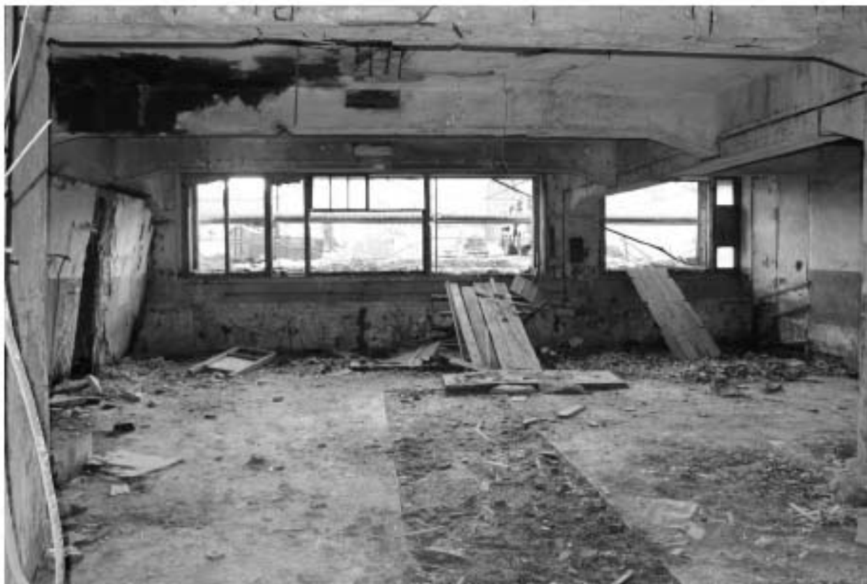
Фото 55. Объект культурного наследия регионального значения «Производственные корпуса трикотажной фабрики «Красное знамя». Внутренние помещения цокольного этажа.
