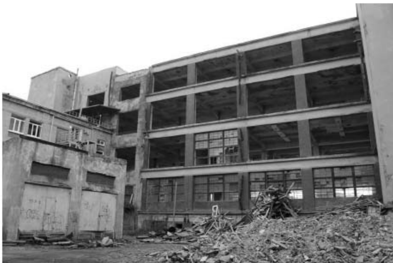
Фото 15. Вид на северо-западный фасад Главного трикотажного цеха (1 очередь) объекта культурного наследия регионального значения «Производственные корпуса трикотажной фабрики «Красное знамя».
