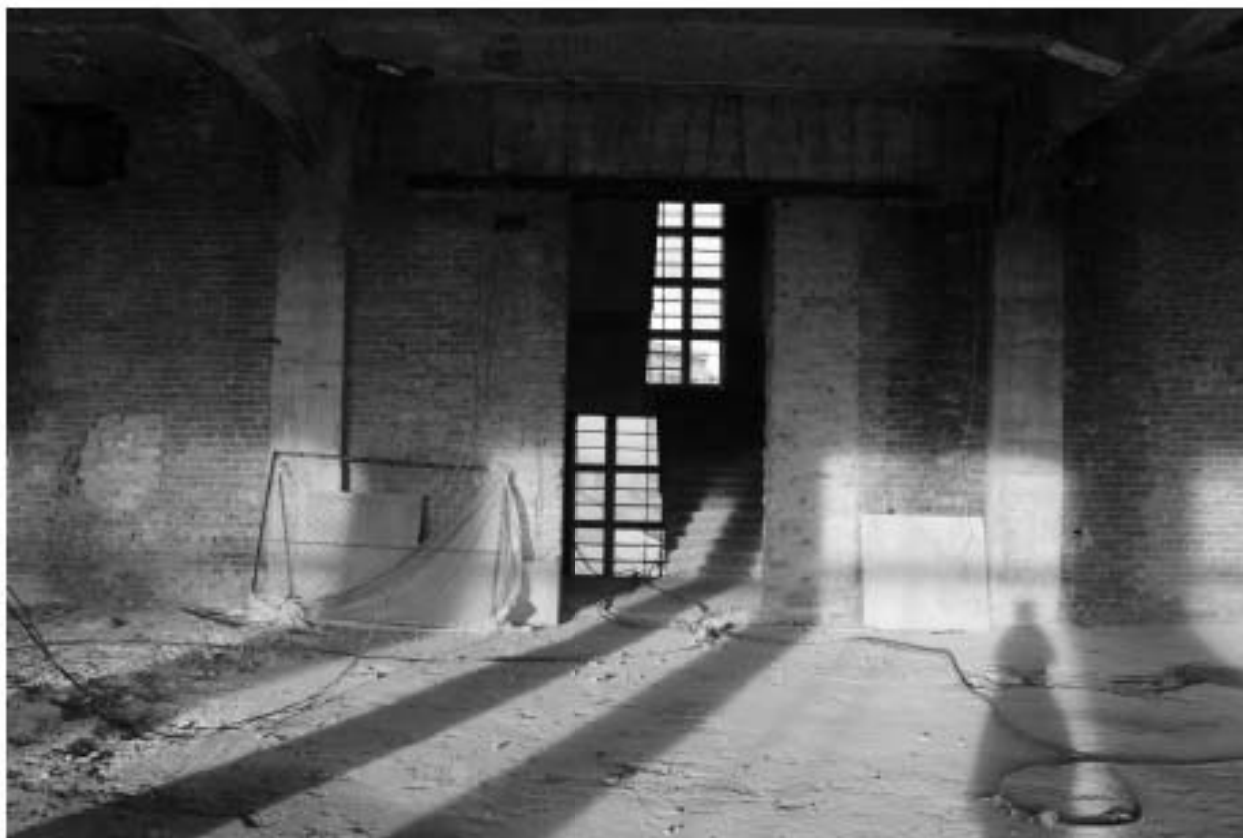
Фото 97. Объект культурного наследия регионального значения «Производственные корпуса трикотажной фабрики «Красное знамя». Внутренние помещения 3-го этажа.
