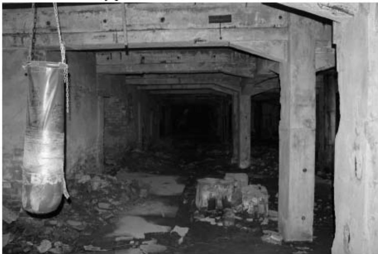
Фото 36. Объект культурного наследия регионального значения «Производственные корпуса трикотажной фабрики «Красное знамя». Внутренние помещения цокольного этажа.
