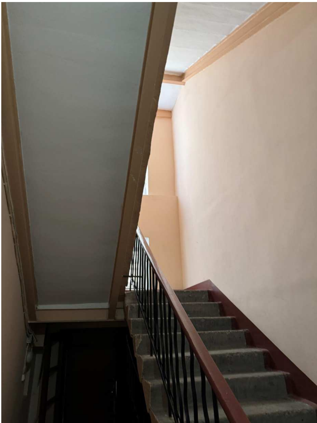
Фото 42. Интерьер лестницы смежной с помещением 9-Н объекта культурного наследия.
