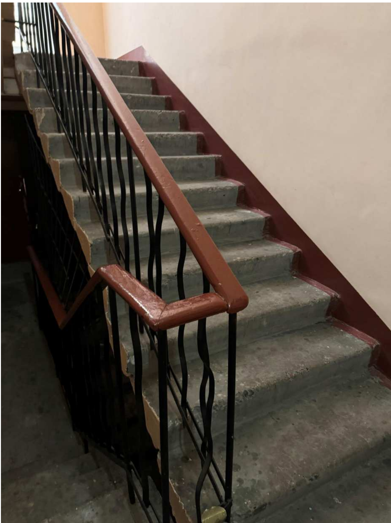
Фото 41. Интерьер лестницы смежной с помещением 9-Н объекта культурного наследия.
