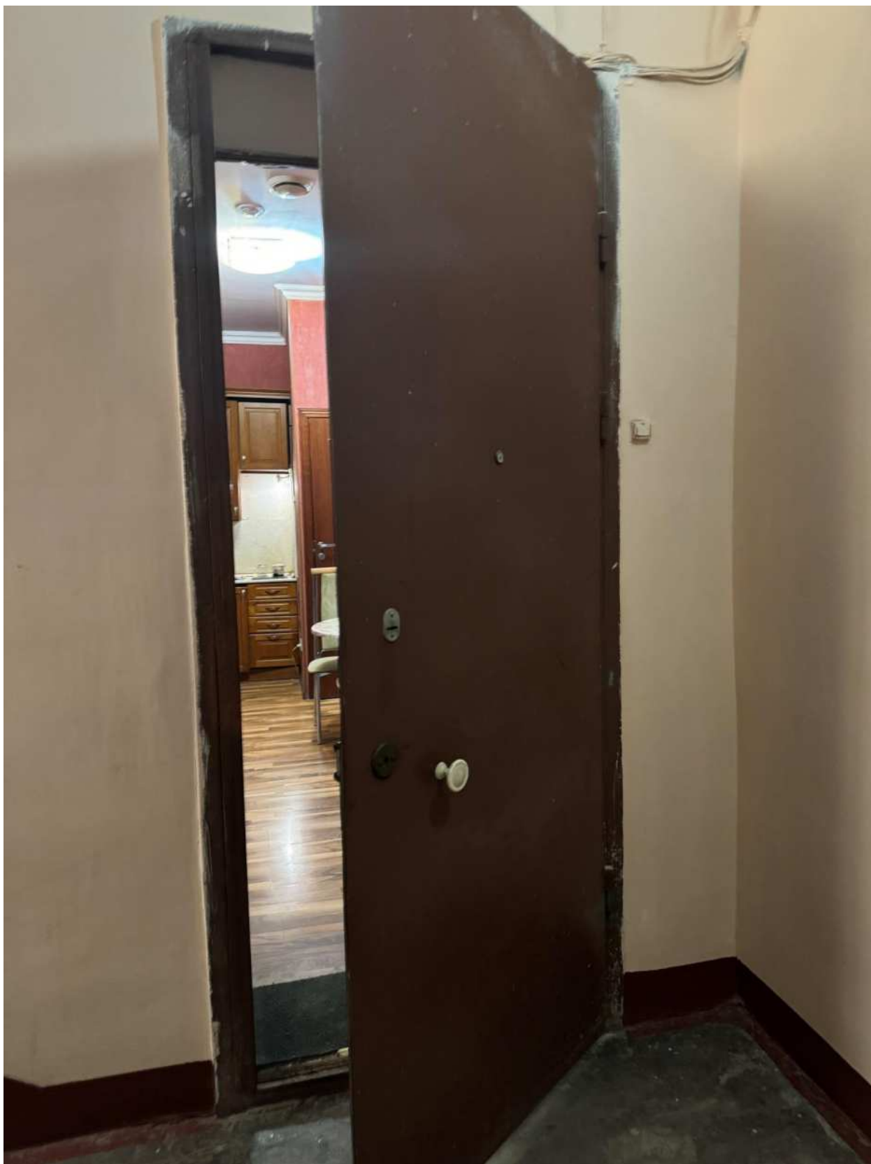
Фото 43. Дверное заполнение с лестницы смежной с помещением 9-Н объекта культурного наследия.
