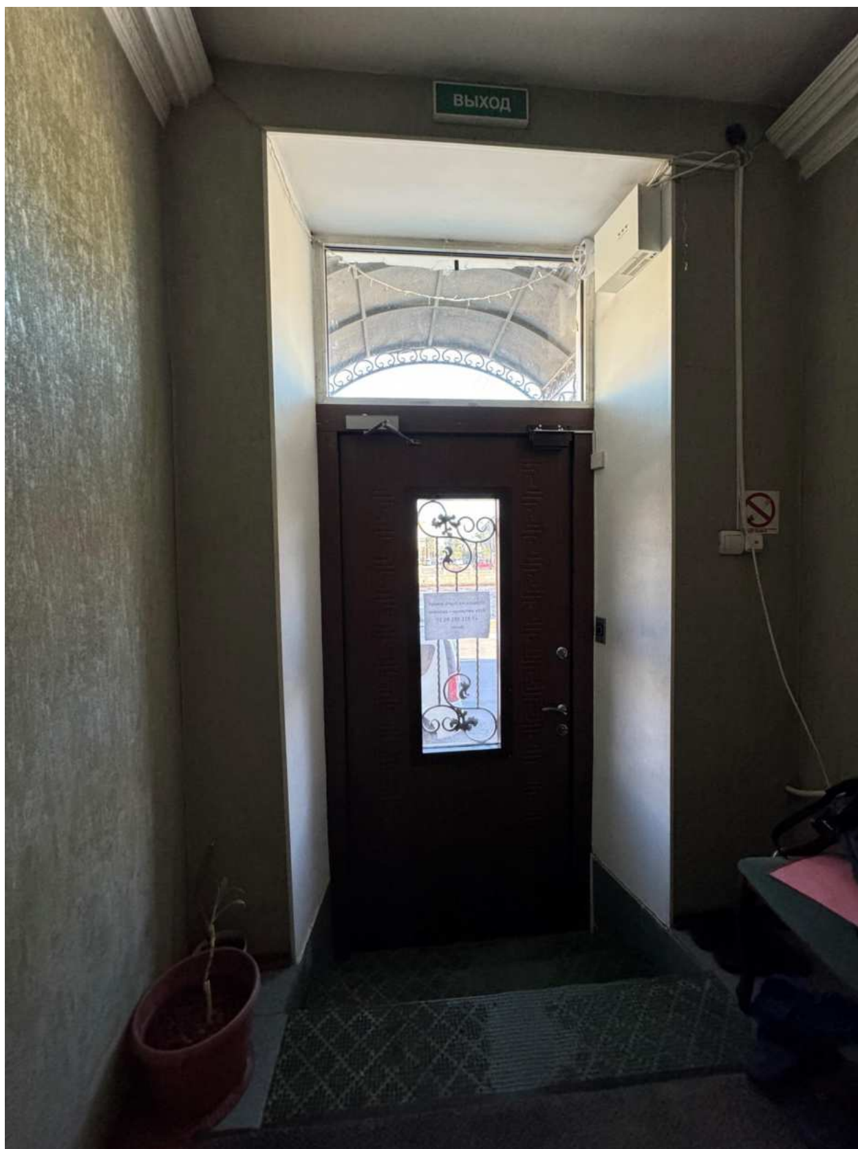
Фото 14. Интерьер помещения 9-Н объекта культурного наследия.
