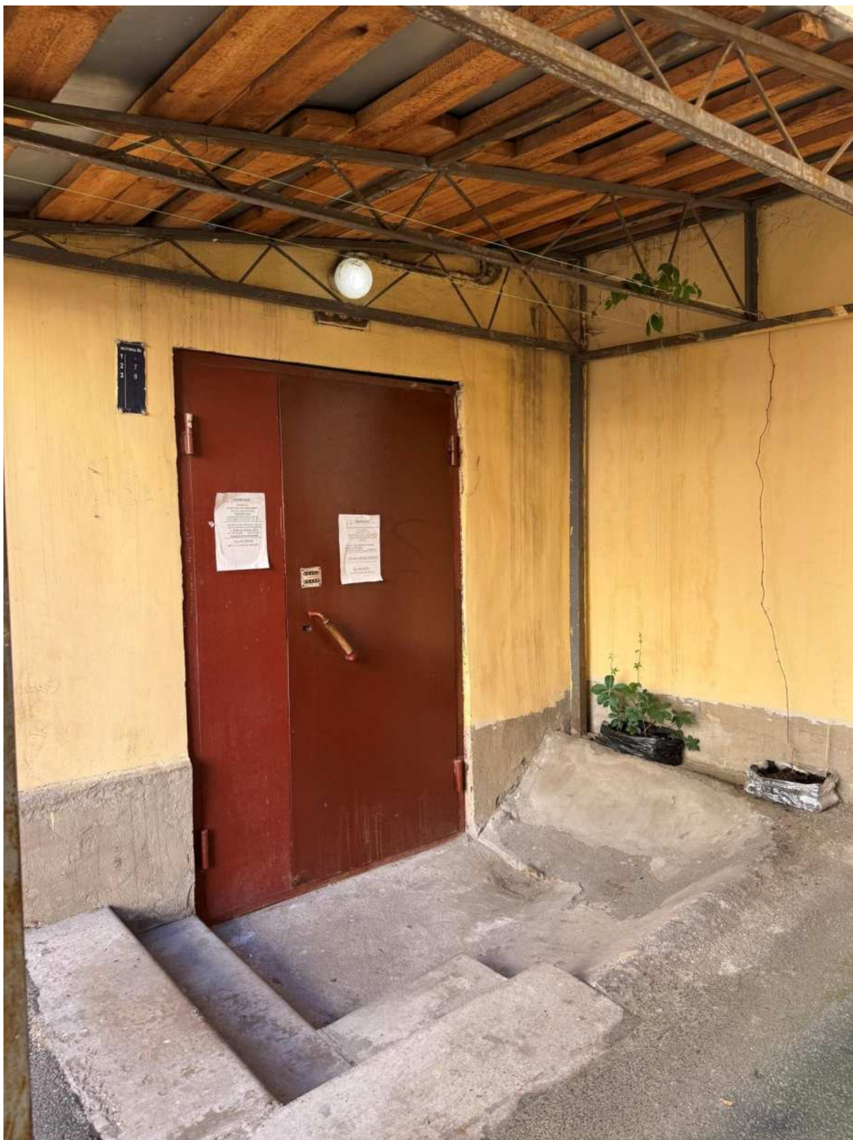
Фото 12. Вид на дверное заполнение, через которое осуществляется вход на лестницу объекта культурного наследия.
