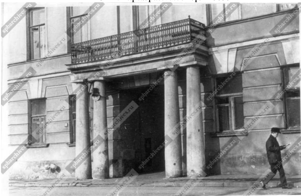
48. Вход во внутренний двор дома № 99 на набережной реки Фонтанки, 1970-е гг. – ЦГАКФФД СПб – Фотодокументы. Опись 1АР-110. Ед.хр.152424
