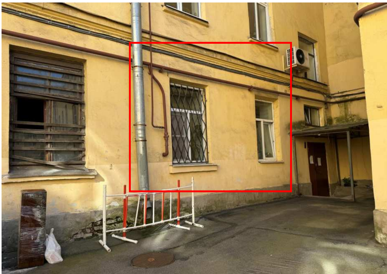
Фото 11. Фрагмент дворового фасада объекта культурного наследия.
