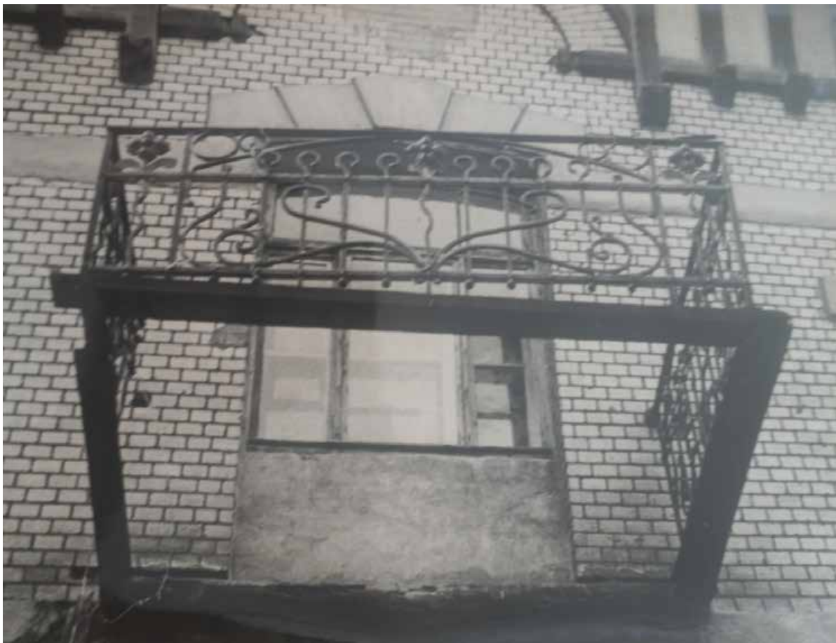
16.10 Решетка балкона Северного фасада.
