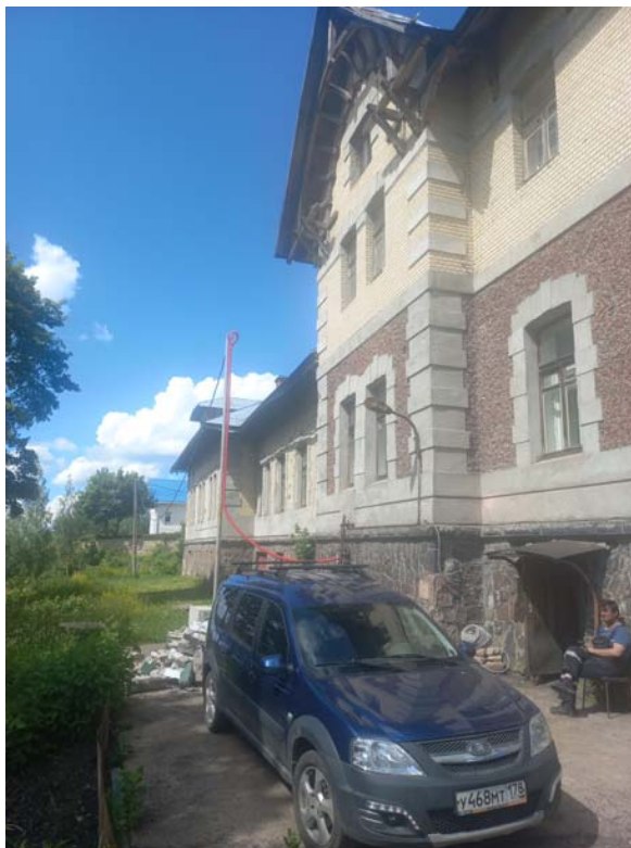
Фото 13. ОКН «Больница общины Святого Георгия» по адресу: г. Санкт-Петербург, г. Красное Село, пр. Двадцать Пятого Октября, д. 105, лит.А, Южный фасад. Дата съемки 10.09.2024
