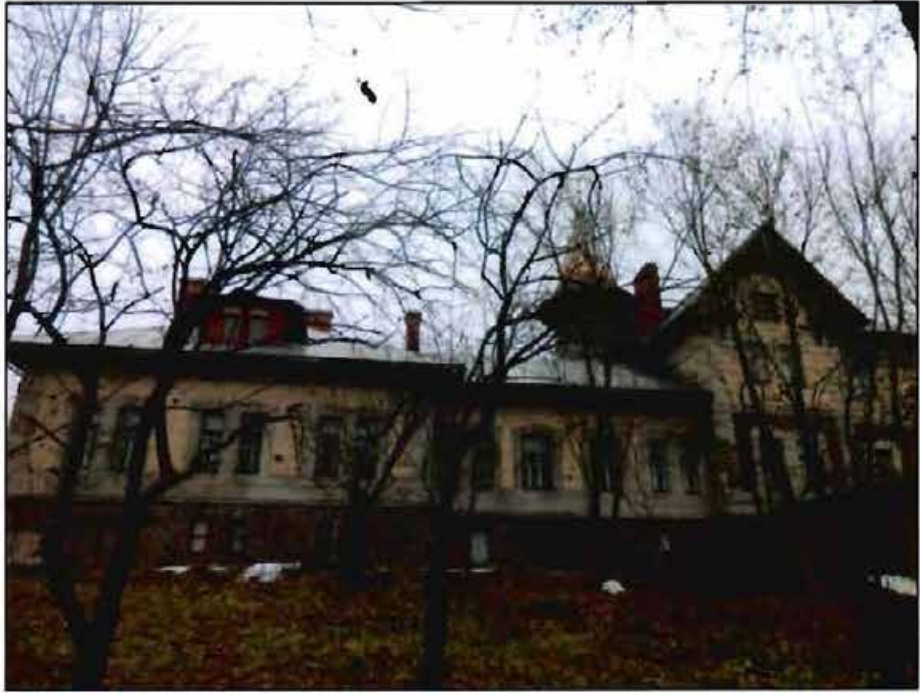
3. «Больница общины Святого Георгия». Южный фасад. Общий вид.
