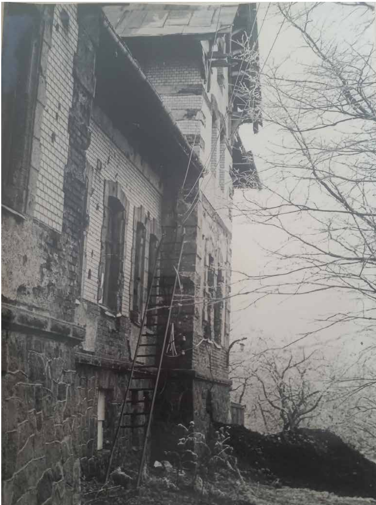
16.5 Южный фасад. Общий вид.
