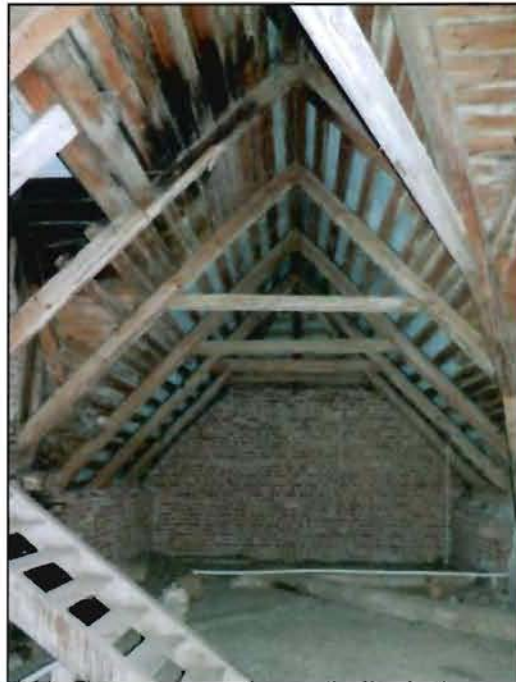
8. Стропильная система. Фрагмент.
