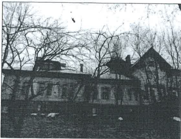
3. «Больница общины Святого Георгия». Южный фасад. Общий вид.
