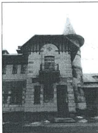
5. «Больница общины Святого Георгия». Северный фасад. Фрагмент.
