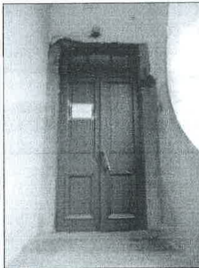
7. «Больница общины Святого Георгия». Северный фасад. Фрагмент. Дверное заложение.
