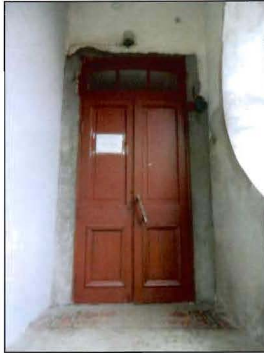
7. «Больница общины Святого Георгия». Северный фасад. Фрагмент. Дверное заполнение.
