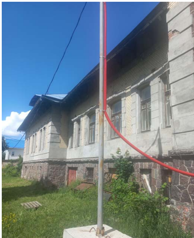
Фото 7. ОКН «Больница общины Святого Георгия» по адресу: г. Санкт-Петербург, г. Красное Село, пр. Двадцать Пятого Октября, д. 105, лит.А, Южный фасад. Дата съемки 10.09.2024
