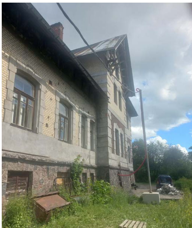
Фото 6. ОКН «Больница общины Святого Георгия» по адресу: г. Санкт-Петербург, г. Красное Село, пр. Двадцать Пятого Октября, д. 105, лит.А, Южный фасад. Дата съемки 10.09.2024
