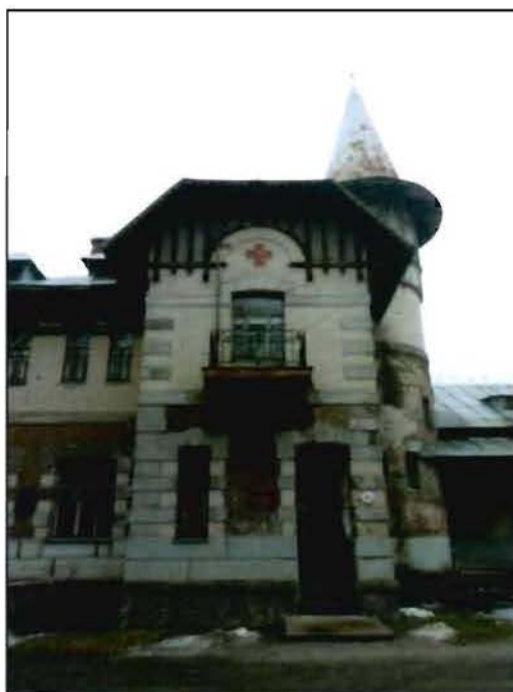
5. «Больница общины Святого Георгия». Северный фасад. Фрагмент.
