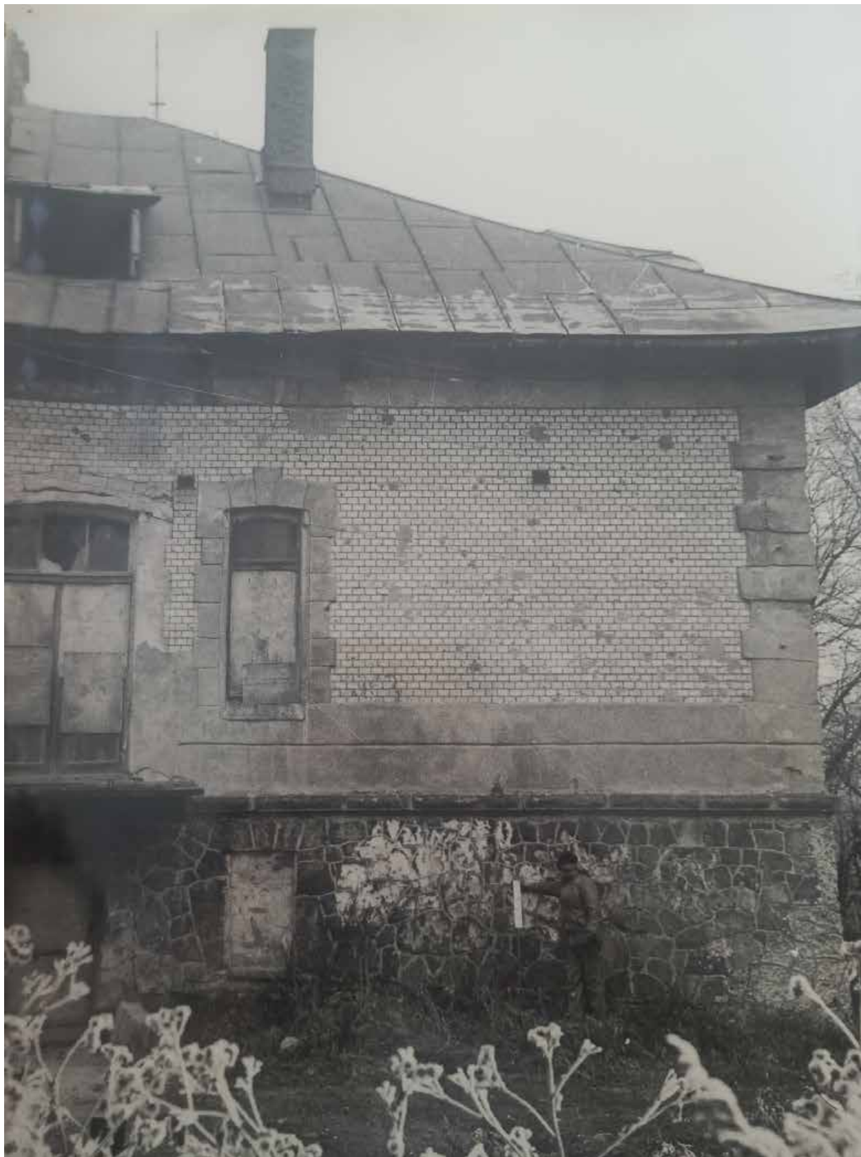
16.8 Западный фасад. Фрагмент.
