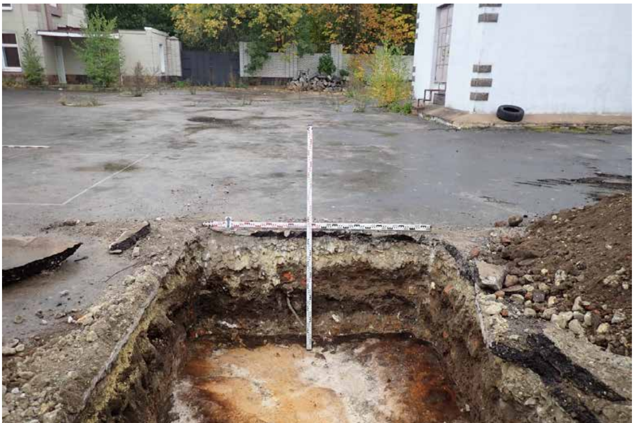
Рис. 42. Санкт-Петербург, Калининский район, муниципальный округ Пискарёвка проспект Мечникова, дом 40, литера А, участок к/н 78:10:0005142:1456. Шурф 3. Выкопанный шурф с включением окружающего пейзажа. Вид с Ю.
