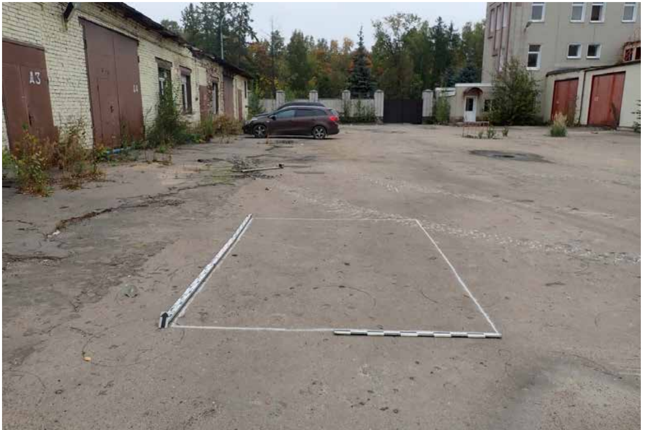
Рис. 24. Санкт-Петербург, Калининский район, муниципальный округ Пискаревка проспект Мечникова, дом 40, литера А, участок к/н 78:10:0005142:1456. Шурф 1 до начала работ. Вид с Ю.
