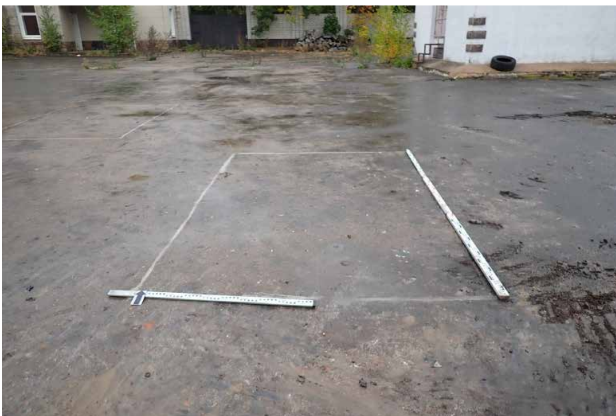
Рис. 38. Санкт-Петербург, Калининский район, муниципальный округ Пискаревка проспект Мечникова, дом 40, литера А, участок к/н 78:10:0005142:1456. Шурф 3 до начала работ. Вид с Ю.
