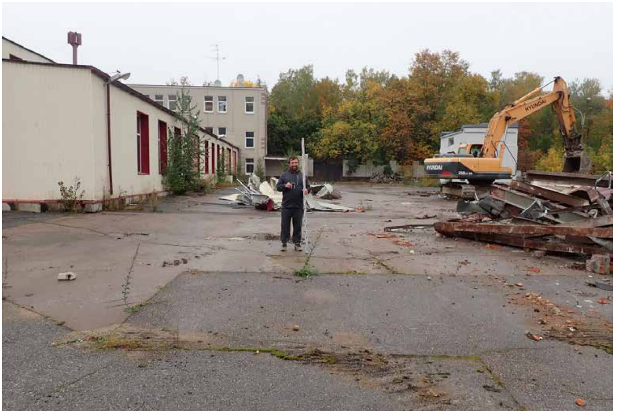
Рис. 18. Санкт-Петербург, Калининский район, муниципальный округ Пискаревка проспект Мечникова, дом 40, литера А, участок к/н 78:10:0005142:1456. Точка фотофиксации 2. Общий вид северо-восточной части участка. Вид с Ю.
