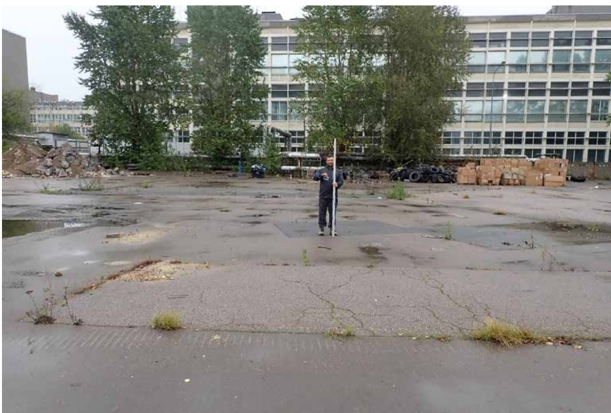
Рис. 21. Санкт-Петербург, Калининский район, муниципальный округ Пискаревка проспект Мечникова, дом 40, литера А, участок к/н 78:10:0005142:1456. Точка фотофиксации 3. Общий вид юго-восточной части участка. Вид с З.
