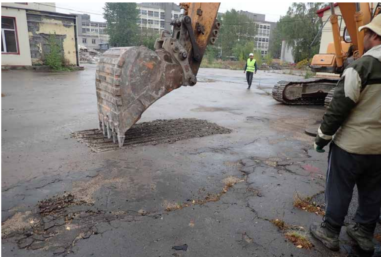
Рис. 14. Санкт-Петербург, Калининский район, муниципальный округ Пискаревка проспект Мечникова, дом 40, литера А, участок к/н 78:10:0005142:1456. Шурф 1. Снятие асфальтового покрытия строительной техникой. Общий вид юго-восточной части участка. Вид с СЗ.
