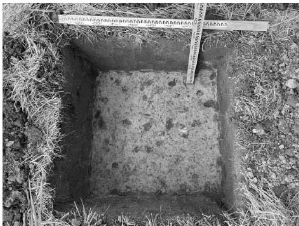
Илл. 44. Санкт-Петербург, г. Пушкин, территория Гуммолосары. Шурф 3, вскрытый до уровня материка. Общий вид с Ю.
