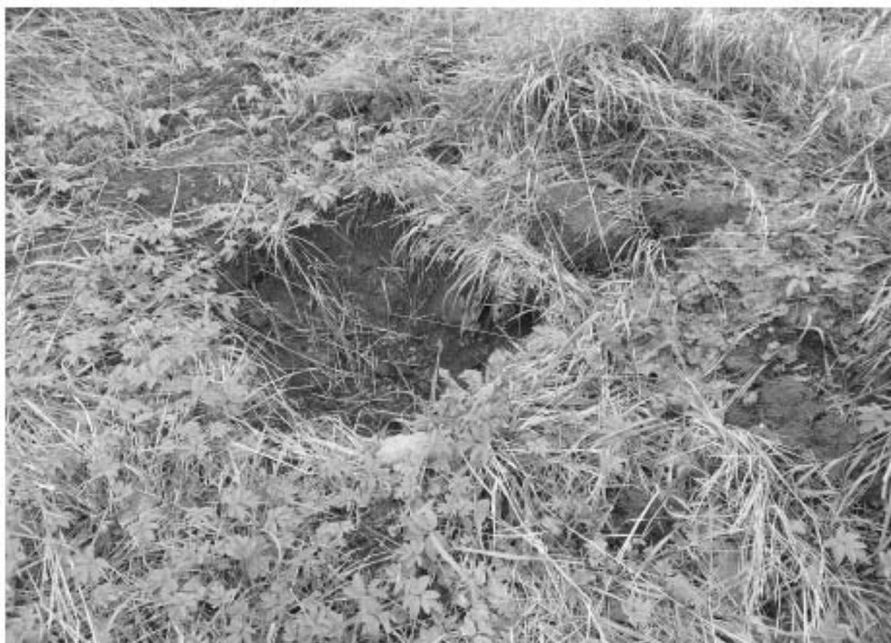
Илл. 18. Объект «Продолжение Державинской ул.». Разрытие в районе точки фотофиксации 2. Вид с юга.
