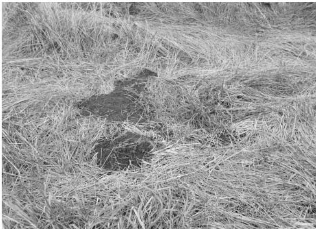
Илл. 20. Объект «Продолжение Державинской ул.». Разрытие в районе точки фотофиксации 3. Вид с юга.
