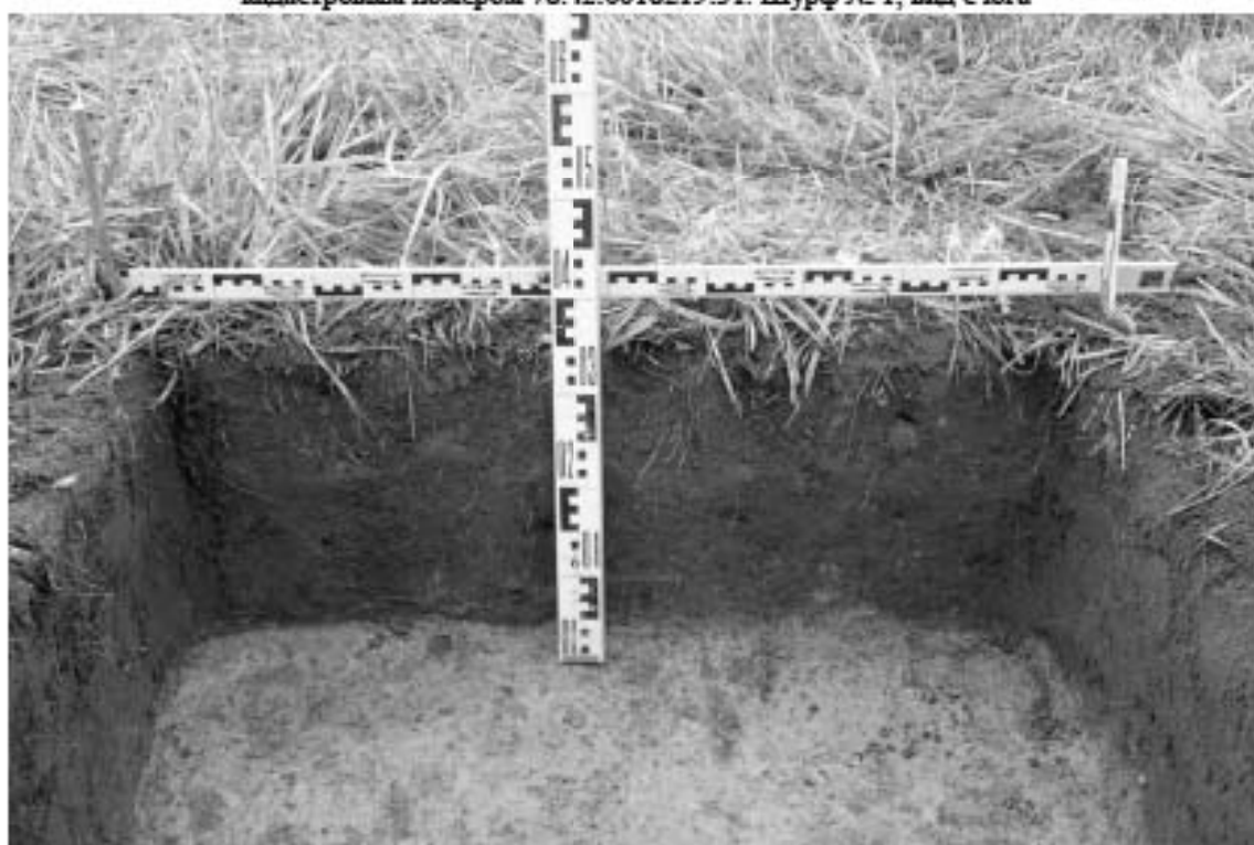
Рис. 32. Земельные участки 31,32,34,42 по адресу: г. Санкт-Петербург, г. Пушкин, Гуммолосары. Участок с кадастровым номером 78:42:0018219:31. Северная стенка шурфа № 1, вид с юга
