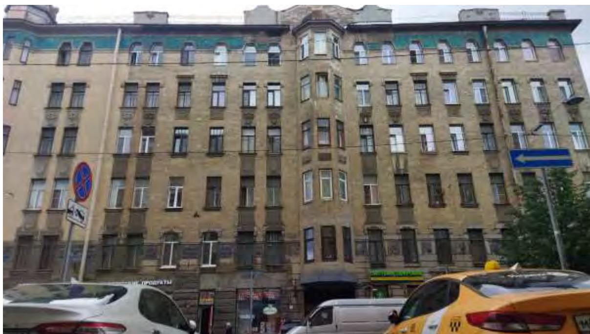
Фото 18. Объект культурного наследия регионального значения «Доходный дом А.А. и А.С. Заварзиных» (Санкт-Петербург, 11-я линия В.О., дом 34/47, литера А). Общий вид с восточной стороны.
