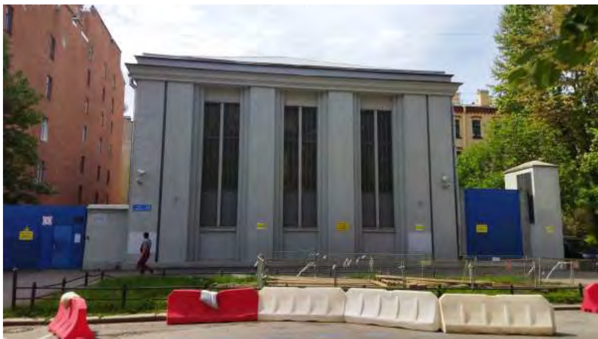
Фото 1. Выявленный объект культурного наследия «Вторичная понижающая подстанция Волховской ГЭС» (Санкт-Петербург, 13-я линия В.О., 34). Общий вид с восточной стороны.
