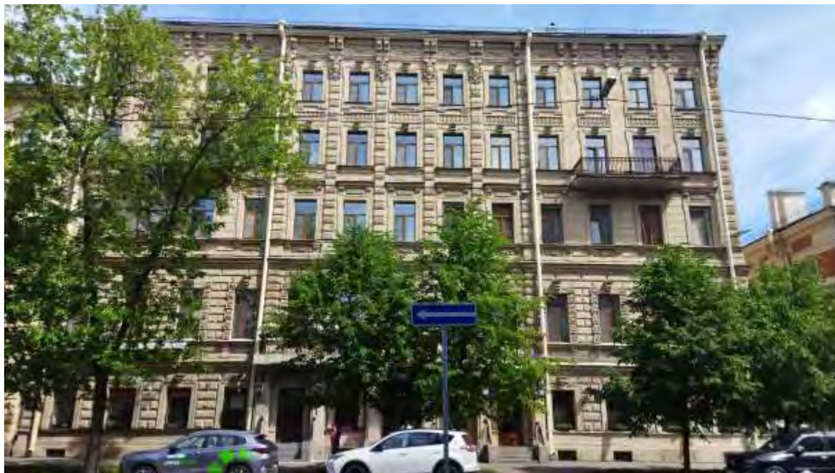
Фото 5. Объект культурного наследия регионального значения «Дом, в котором в 1902-1915 гг. жил академик А.М. Ляпунов» (Санкт-Петербург, 12-я линия В.О., 27). Общий вид с западной стороны.
