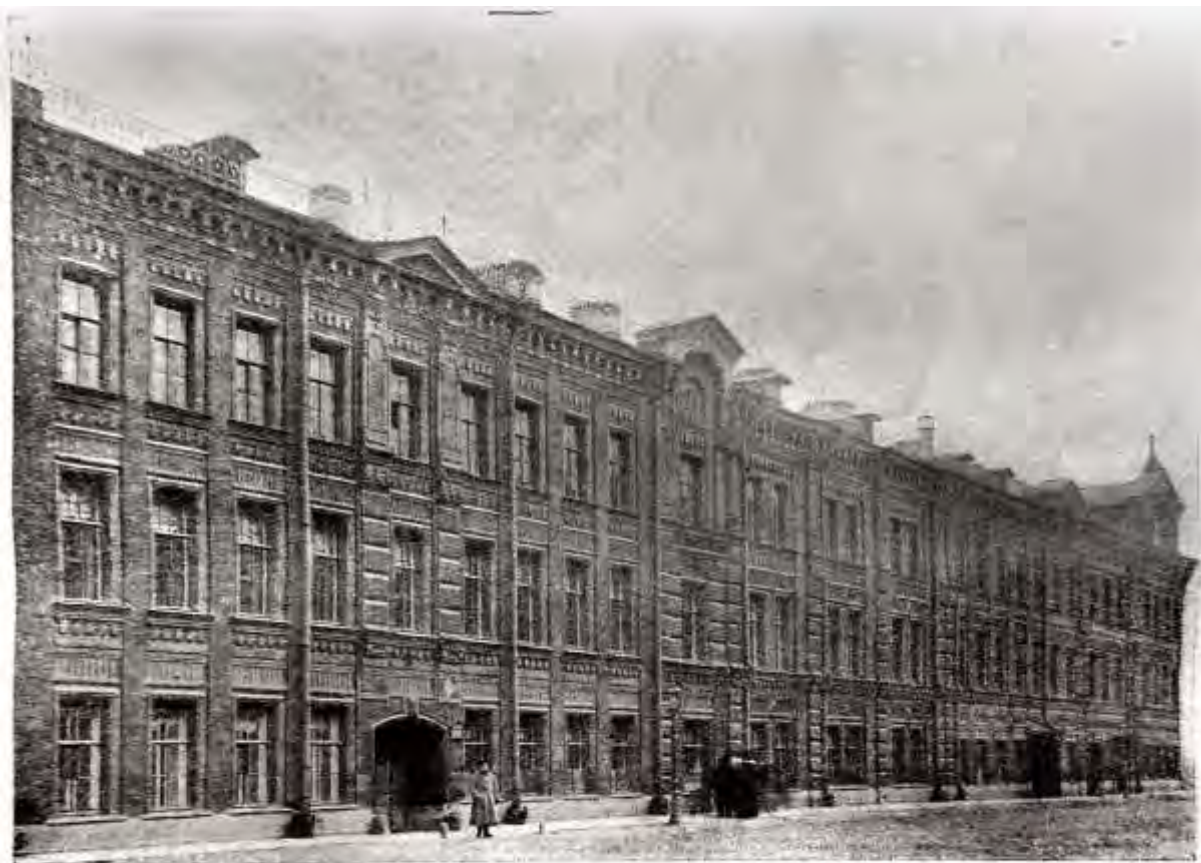
ЕЛИСЬЕВСКАЯ БОГАДѢЛЬНЯ НА ВАСИЛЬЕВСКОМЪ ОСТРОВѢ. Къ 100-лѣтїю существованїя торговаго товарищества «Братья Елисеѣвы». (См. «Петербургскій Листокъ» № 288).
