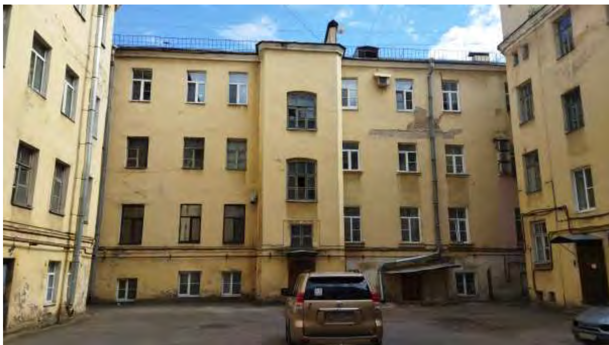
Фото 47. Объект культурного наследия регионального значения «Дом с флигелями семьи Брюлловых» (Санкт-Петербург, Средний пр. В.О., 17). Общий вид с северной стороны.
