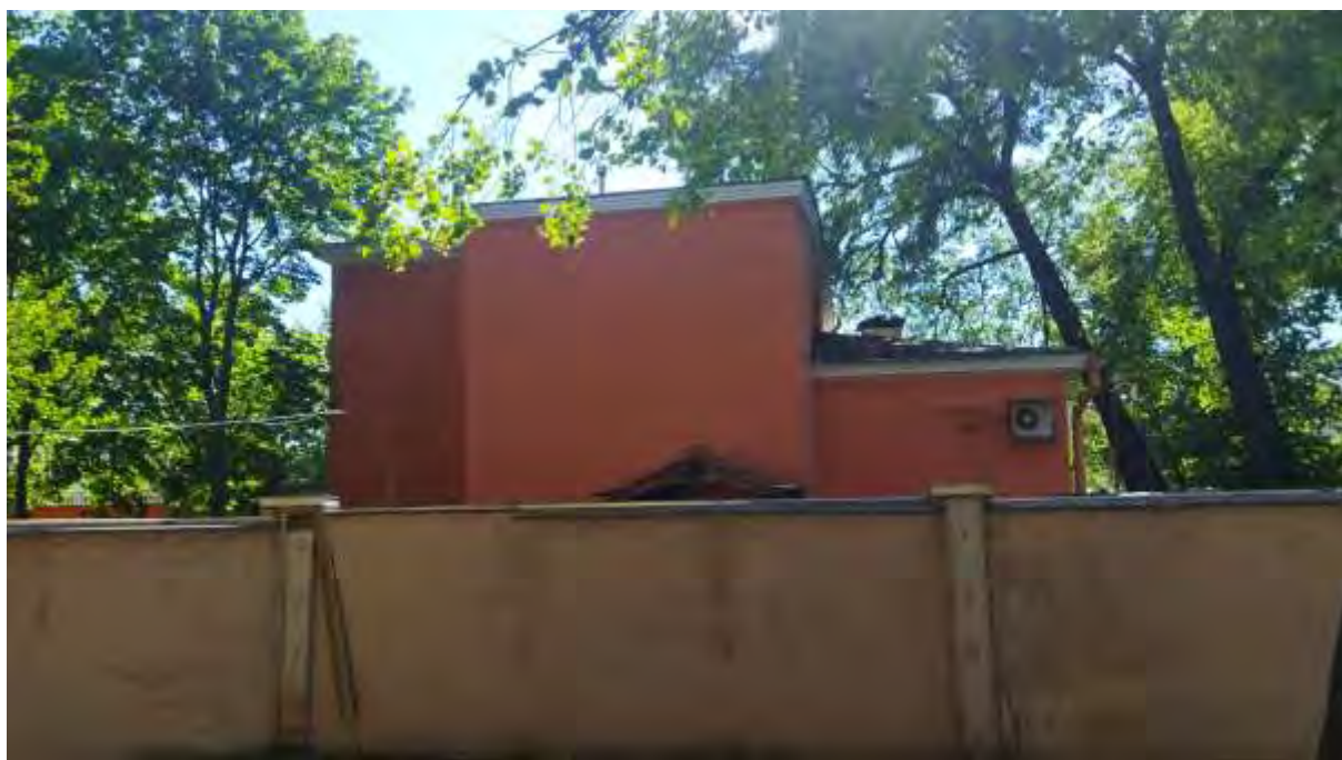
Фото 73. Объект культурного наследия федерального значения «Усадьба Меншикова А.Д. (Первый кадетский корпус)» (Санкт-Петербург, Университетская наб., 13, 15; Съездовская линия, 1, 3, 5; Филологический пер., 2, 4). Объект культурного наследия федерального значения «Дом жилой Первого кадетского корпуса». Общий вид с восточной стороны.
