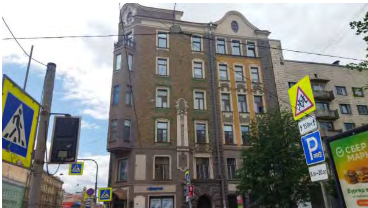
Фото 39. Выявленный объект культурного наследия «Дом П.А. Разживина» (Санкт-Петербург, Средний пр. В.О., 23; 5-я линия В.О., 44 (угловой дом)). Общий вид с восточной стороны.
