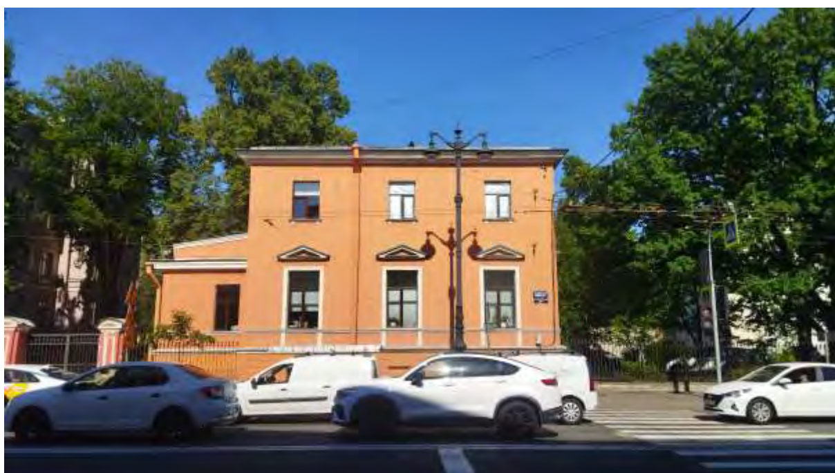
Фото 74. Объект культурного наследия федерального значения «Усадьба Меншикова А.Д. (Первый кадетский корпус)» (Санкт-Петербург, Университетская наб., 13, 15; Съездовская линия, 1, 3, 5; Филологический пер., 2, 4). Объект культурного наследия федерального значения «Дом жилой Первого кадетского корпуса». Общий вид с западной стороны.
