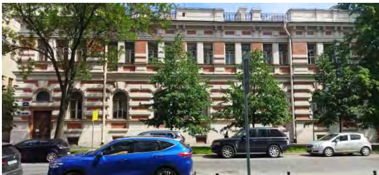
Фото 3. Выявленный объект культурного наследия «Дома В.Н. фон Дервиз» (Санкт-Петербург, Средний пр. В.О., 48; 12-я линия В.О., 25-27). Выявленный объект культурного наследия «Здание общественной столовой». Общий вид с западной стороны.
