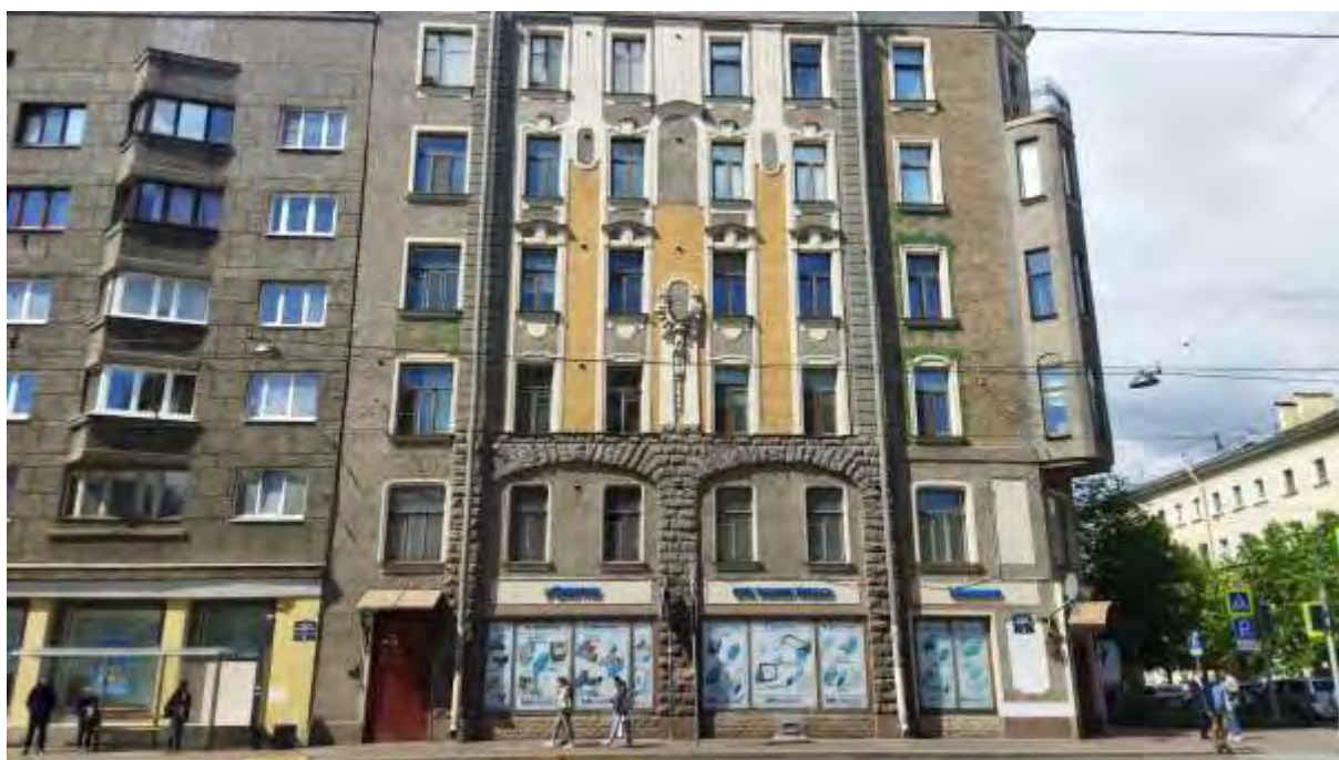
Фото 38. Выявленный объект культурного наследия «Дом П.А. Разживина» (Санкт-Петербург, Средний пр. В.О., 23; 5-я линия В.О., 44 (угловой дом)). Общий вид с южной стороны.
