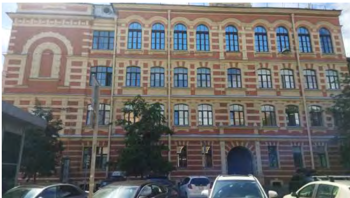
Фото 33. Объект культурного наследия «Городской дом 1-го Василеостровского начального народного училища» (Санкт-Петербург, Средний пр. В.О., 31; 7-я линия В.О., 52). Общий вид с восточной стороны.
