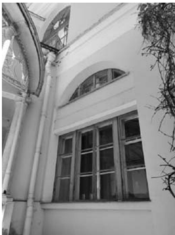
66 Юго-западный полуциркульный корпус. Фасад со стороны Собственного сада.
