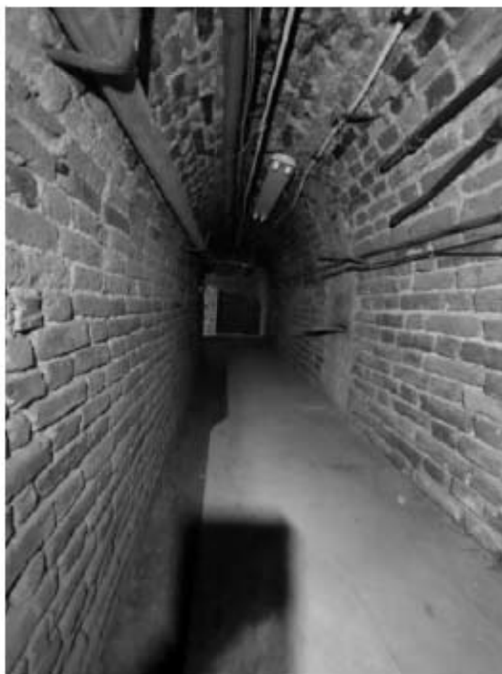
104. Центральный корпус. Подвал
