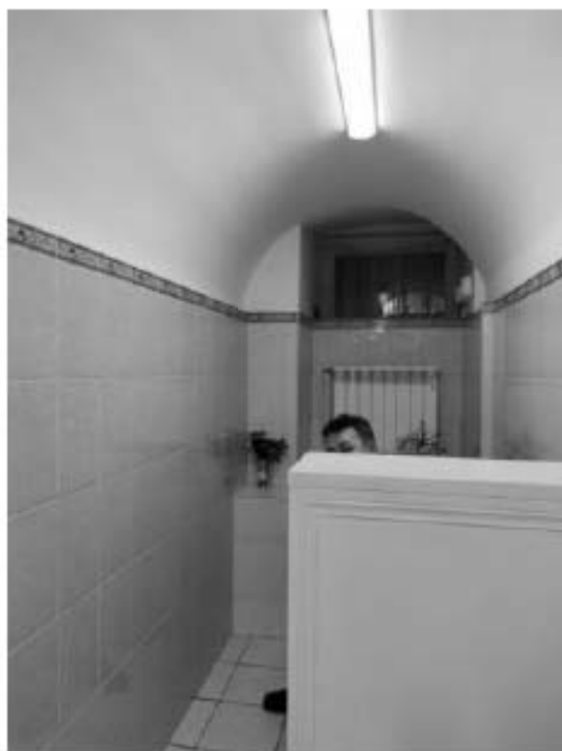
89. Центральный корпус. Подвал
