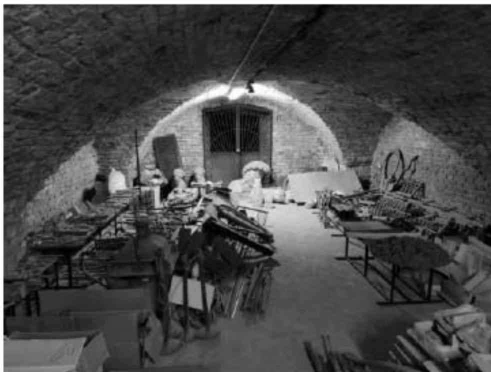
95. Центральный корпус. Подвал
