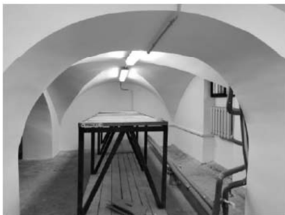
114. Северный прямоугольный корпус. Подвал
