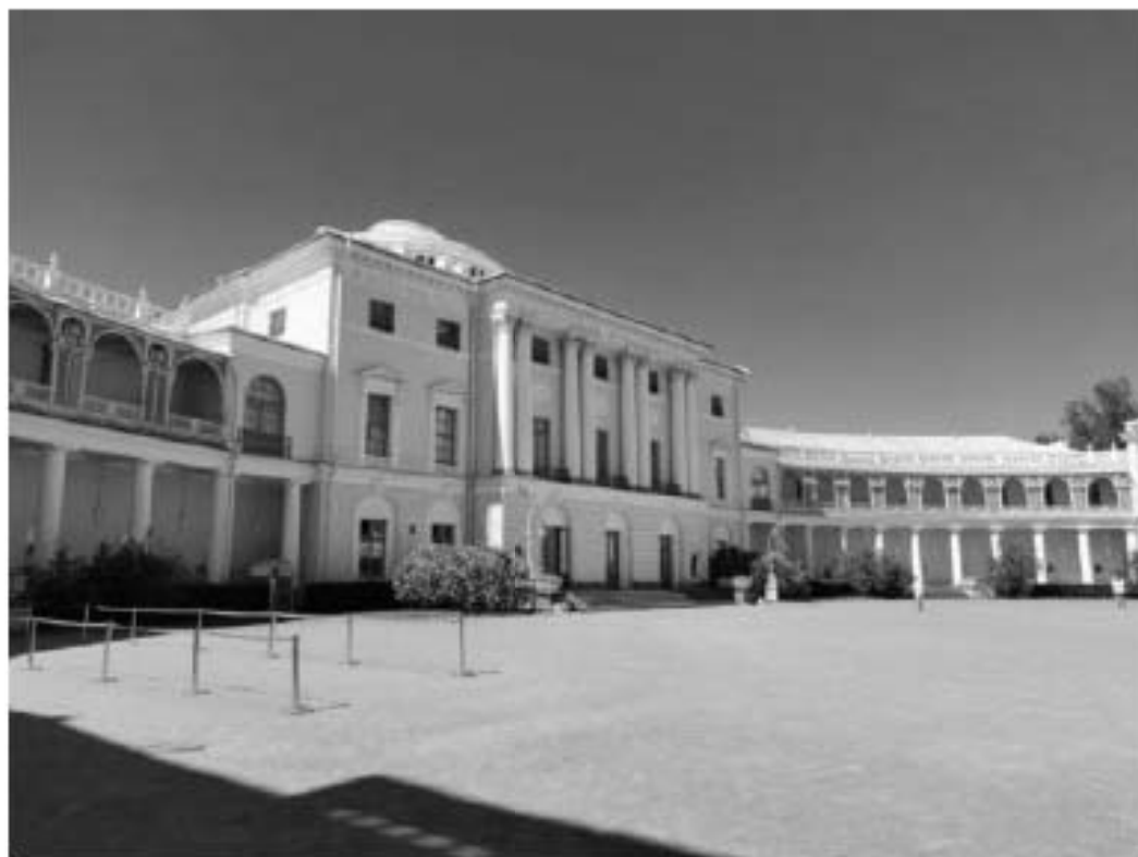
29. Центральный корпус. Главный фасад.
