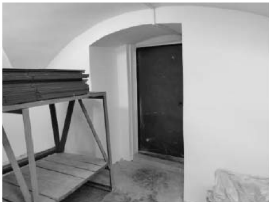
113. Северный прямоугольный корпус. Подвал
