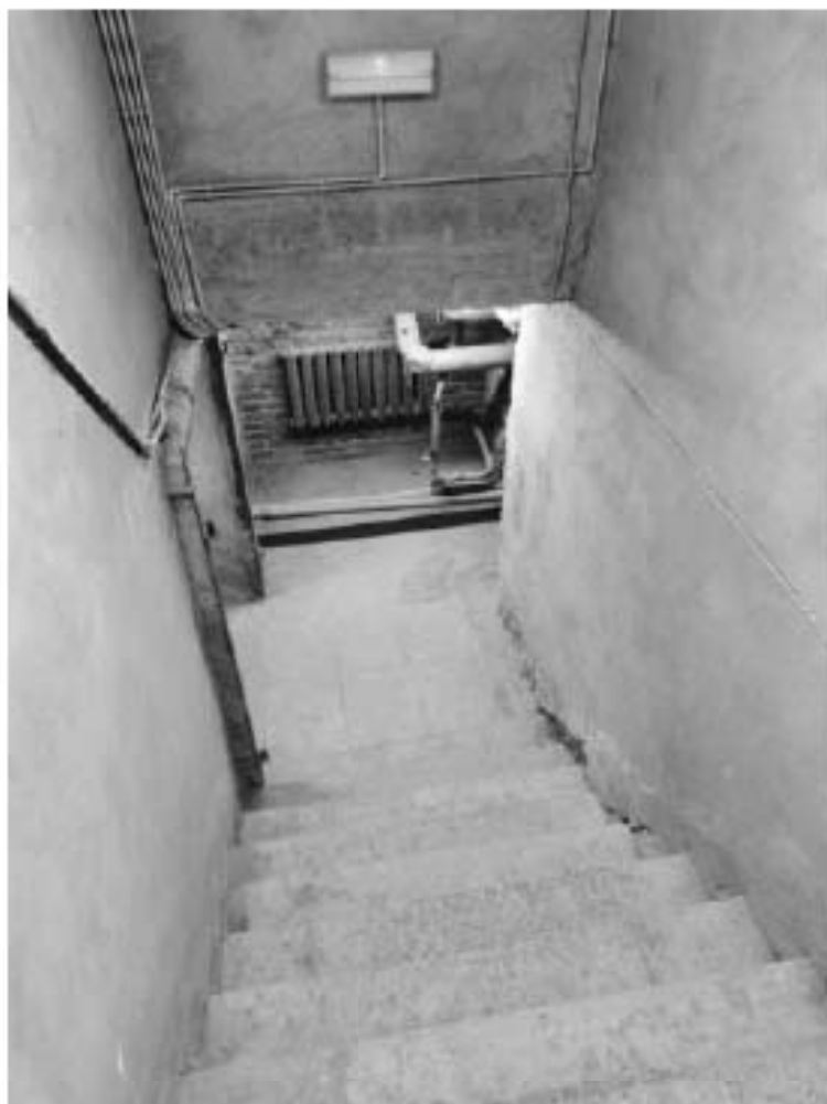
107. Северный прямоугольный корпус. Подвал
