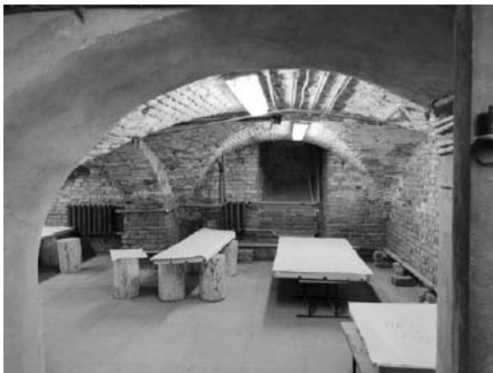
108. Северный прямоугольный корпус. Подвал
