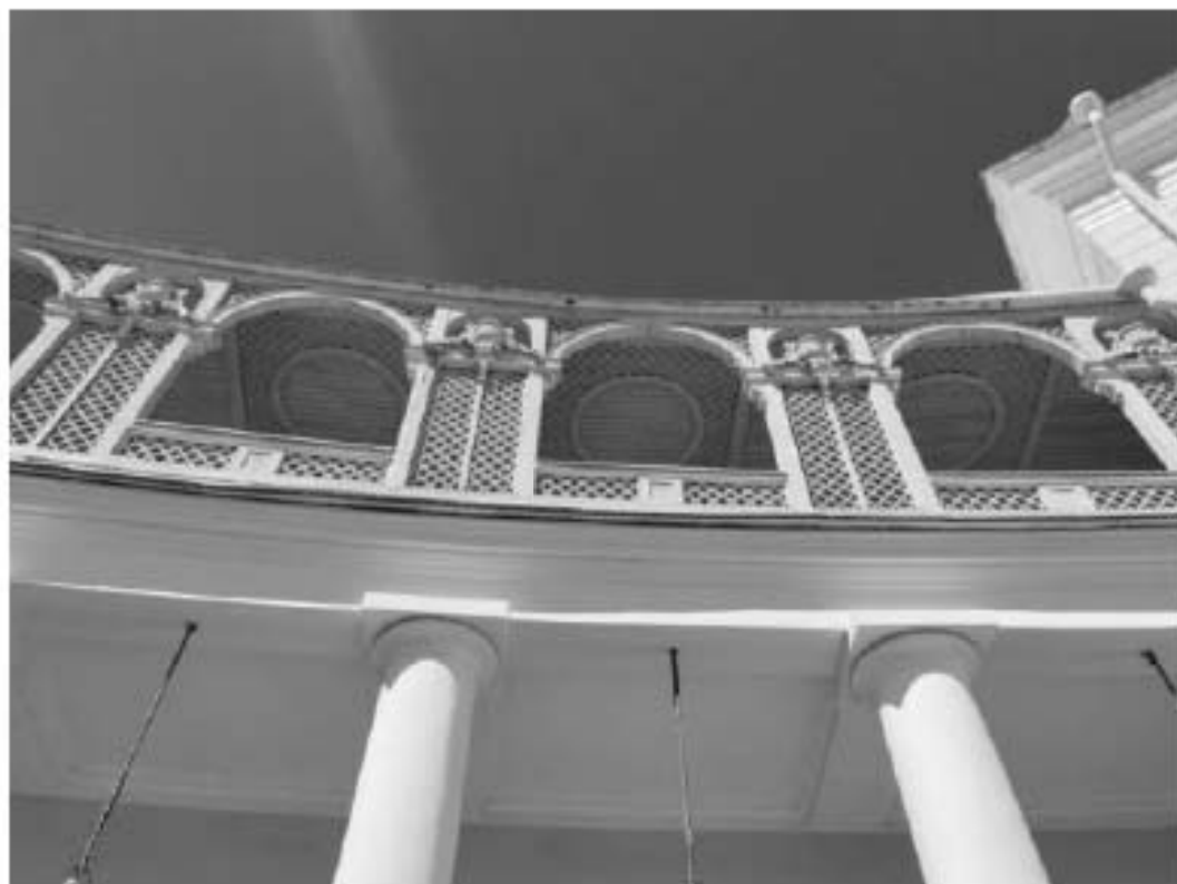
35. Северо-западный полуциркульный корпус. Фасад со стороны плаца.
