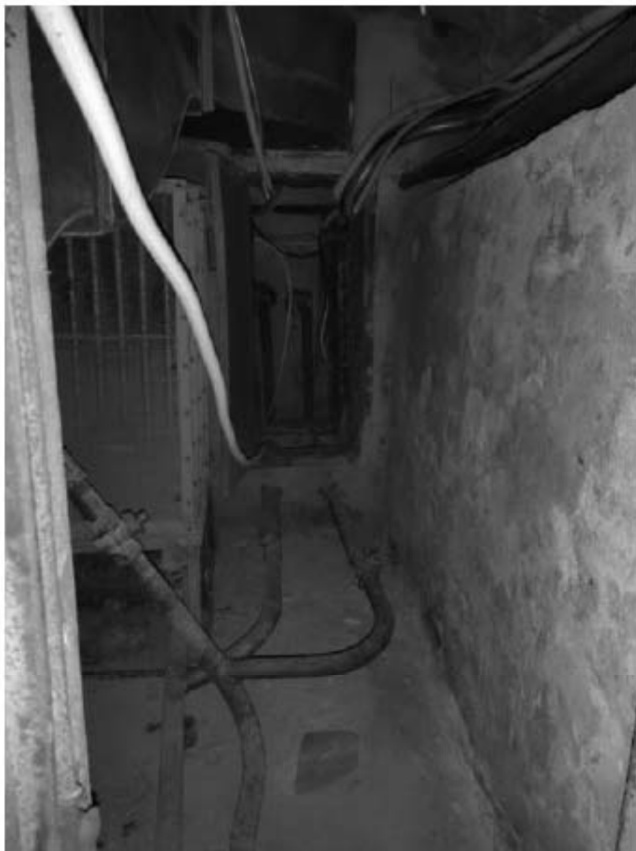
123. Северный-прямоугольный корпус. Подвал
