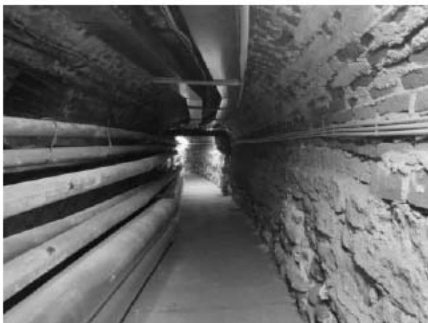
122. Северный прямоугольный корпус. Подвал
