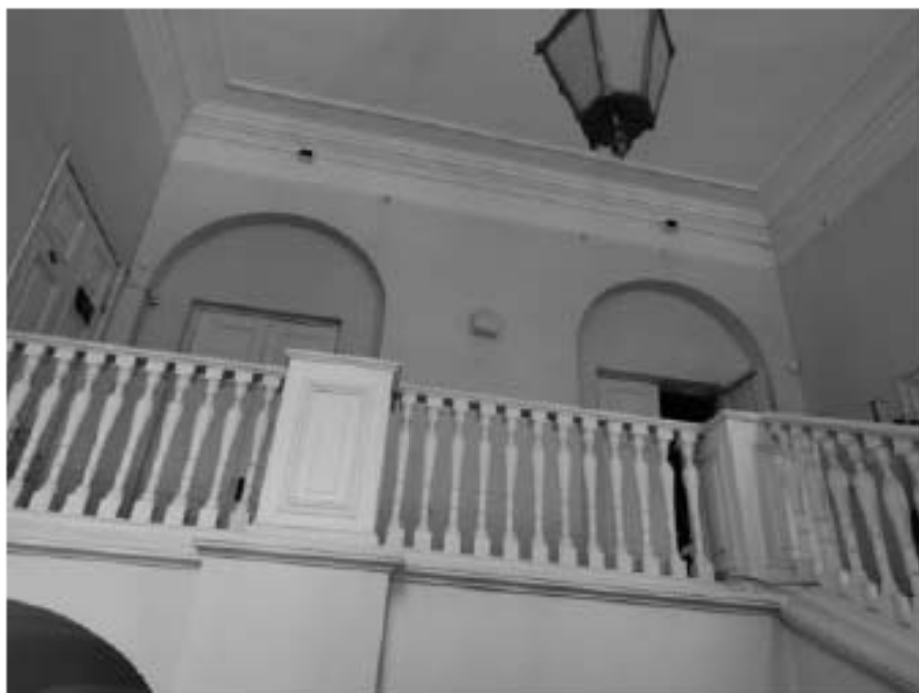
222. Юго-восточный полуциркульный корпус. Второй этаж.
