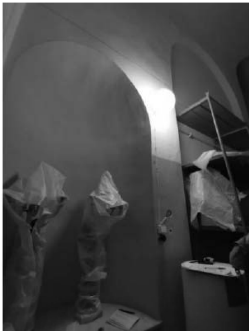
261. Центральный корпус. Второй этаж.
