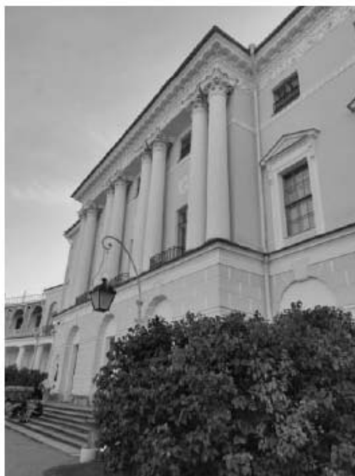
32. Центральный корпус. Главный фасад.
