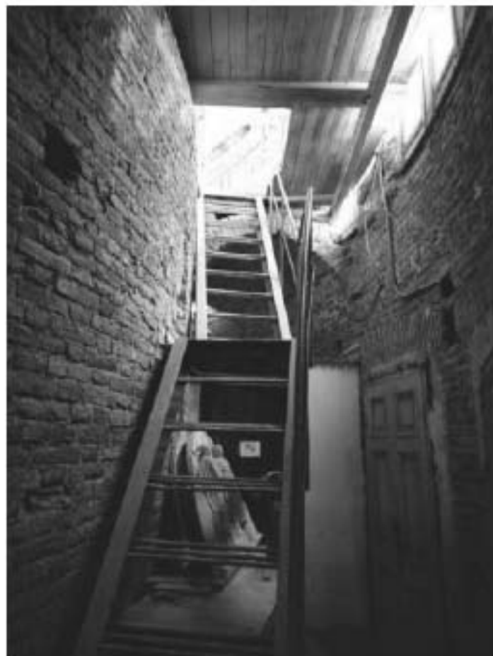
290. Центральный корпус. Чердак
