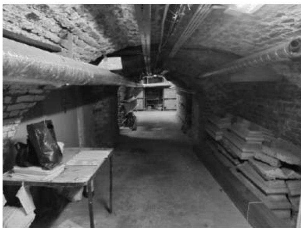
90. Центральный корпус. Подвал
