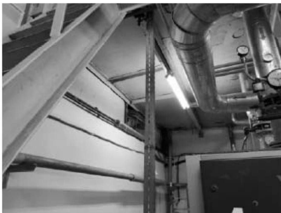
116. Северный прямоугольный корпус. Подвал
