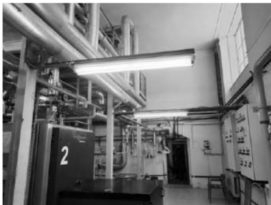
117. Северный прямоугольный корпус. Подвал
