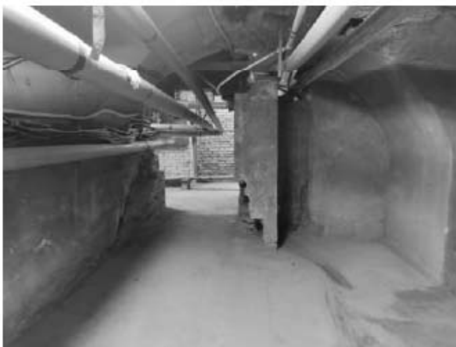
112. Северный прямоугольный корпус. Подвал
