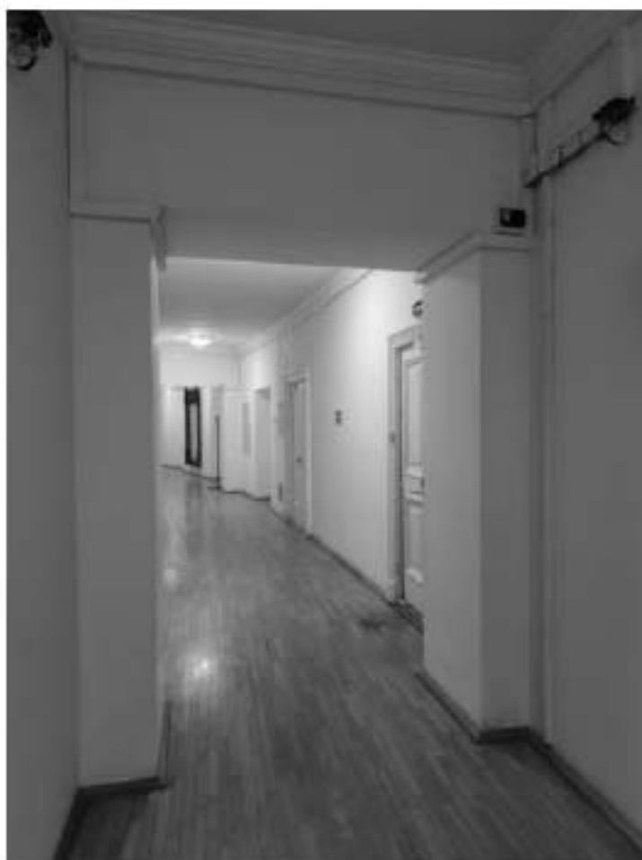
175 Северо-восточный полуциркульный корпус. Первый этаж.
