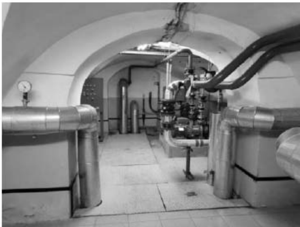
121. Северный прямоугольный корпус. Подвал
