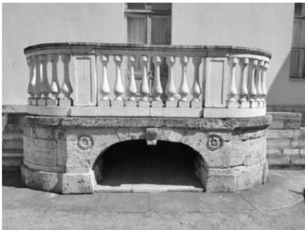
65 Юго-западный полуциркульный корпус. Фасад со стороны Собственного сада.
