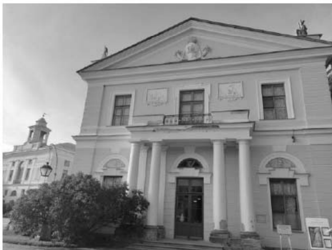
40. Северо-восточный полуциркульный корпус. Фасад со стороны плаца
