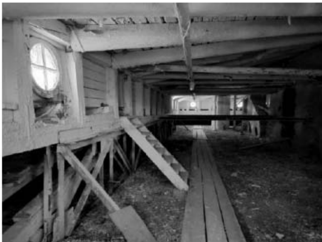
292. Центральный корпус. Чердак.
