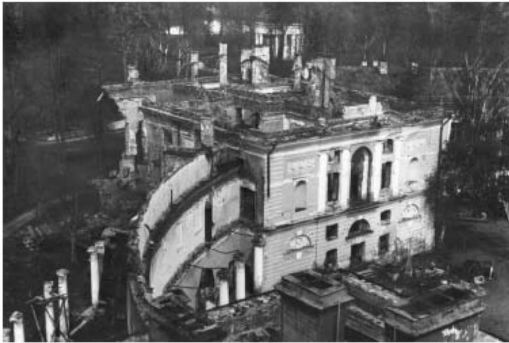
20. Разрушенный северный корпус и галерея. 1944г. https://pastvu.com/ .
