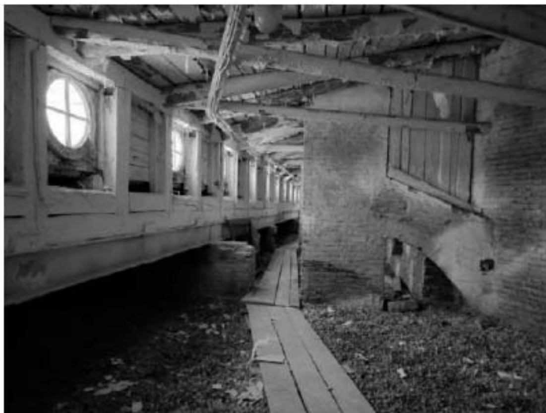
291. Центральный корпус. Чердак
