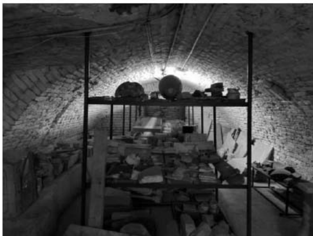
86. Центральный корпус. Подвал
