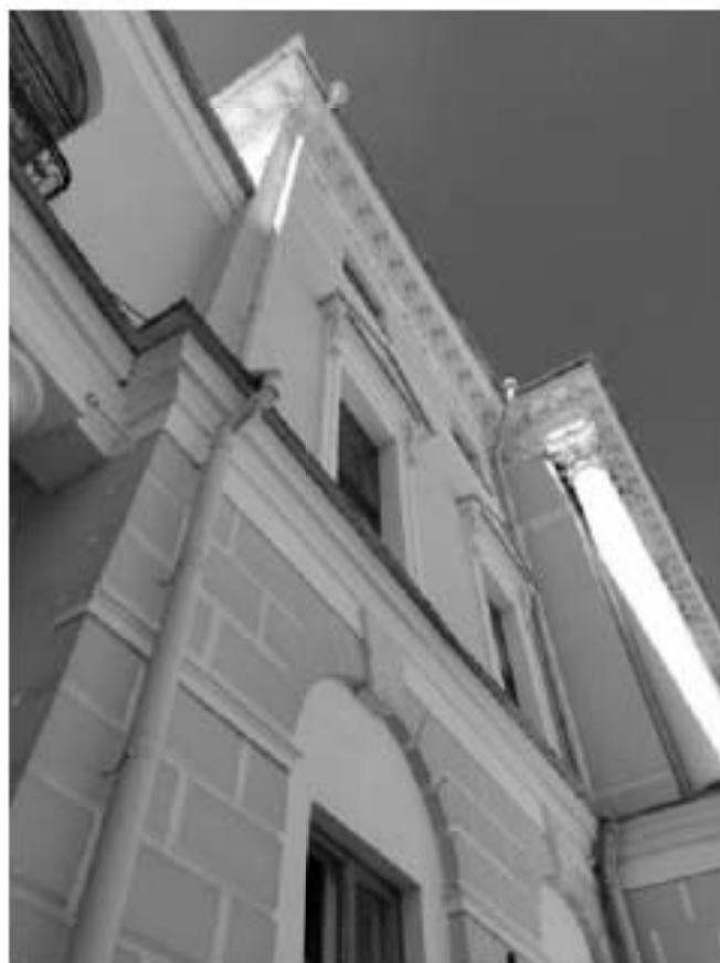
30. Центральный корпус. Главный фасад.
