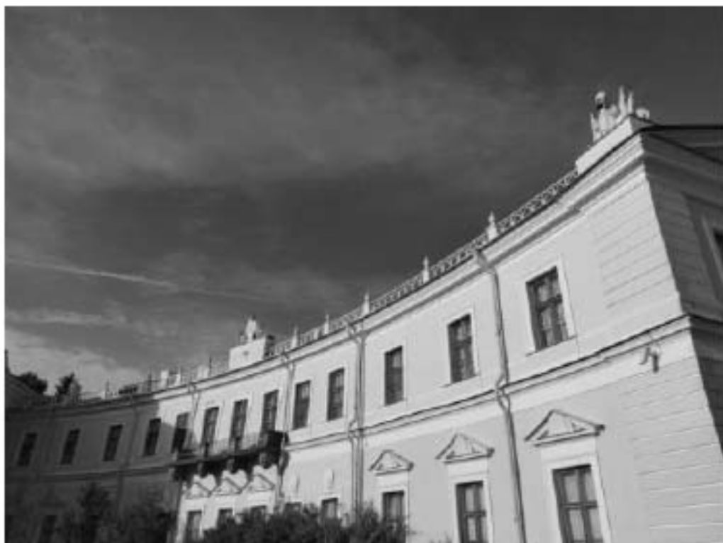
39. Северо-восточный полуциркульный корпус. Фасад со стороны плаца
