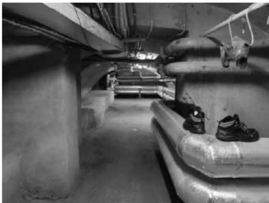
100. Центральный корпус. Подвал
