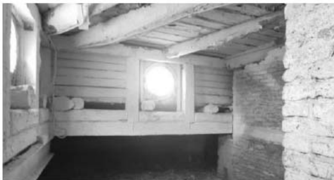
293. Центральный корпус. Чердак.
