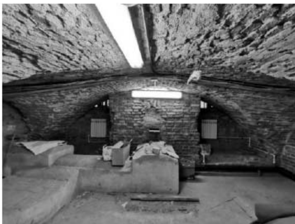
98. Центральный корпус. Подвал
