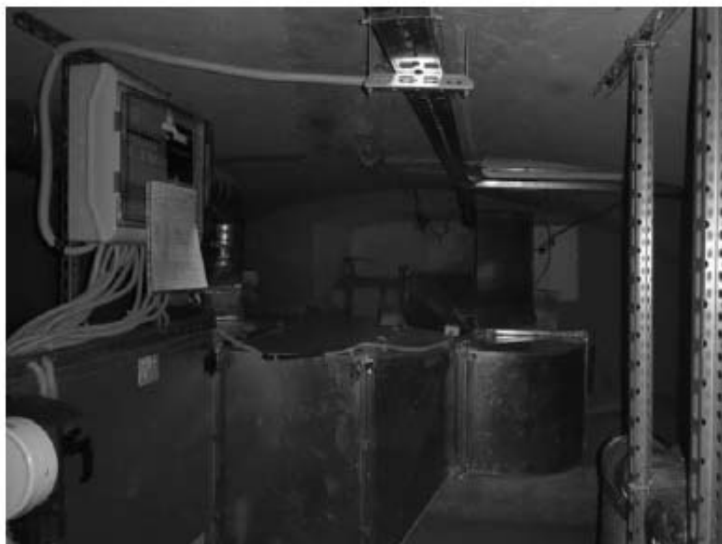
96. Центральный корпус. Подвал
