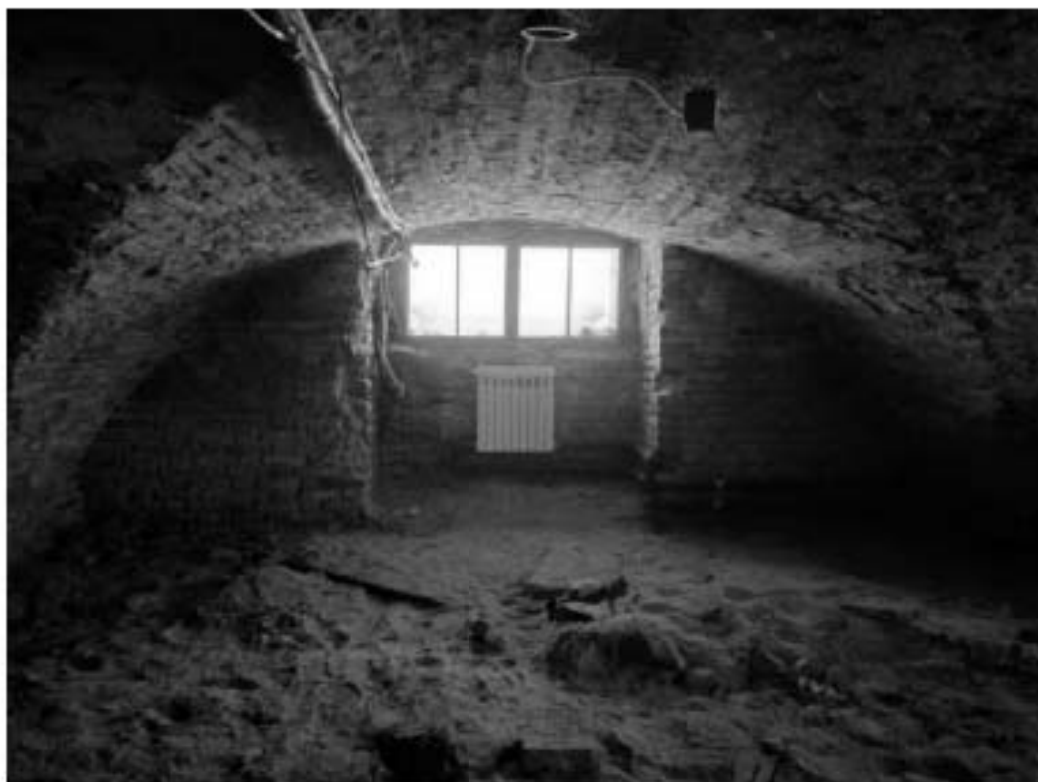
91. Центральный корпус. Подвал
