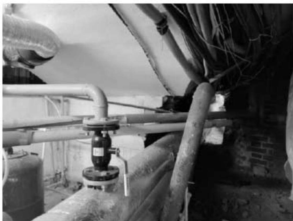
88. Центральный корпус. Подвал
