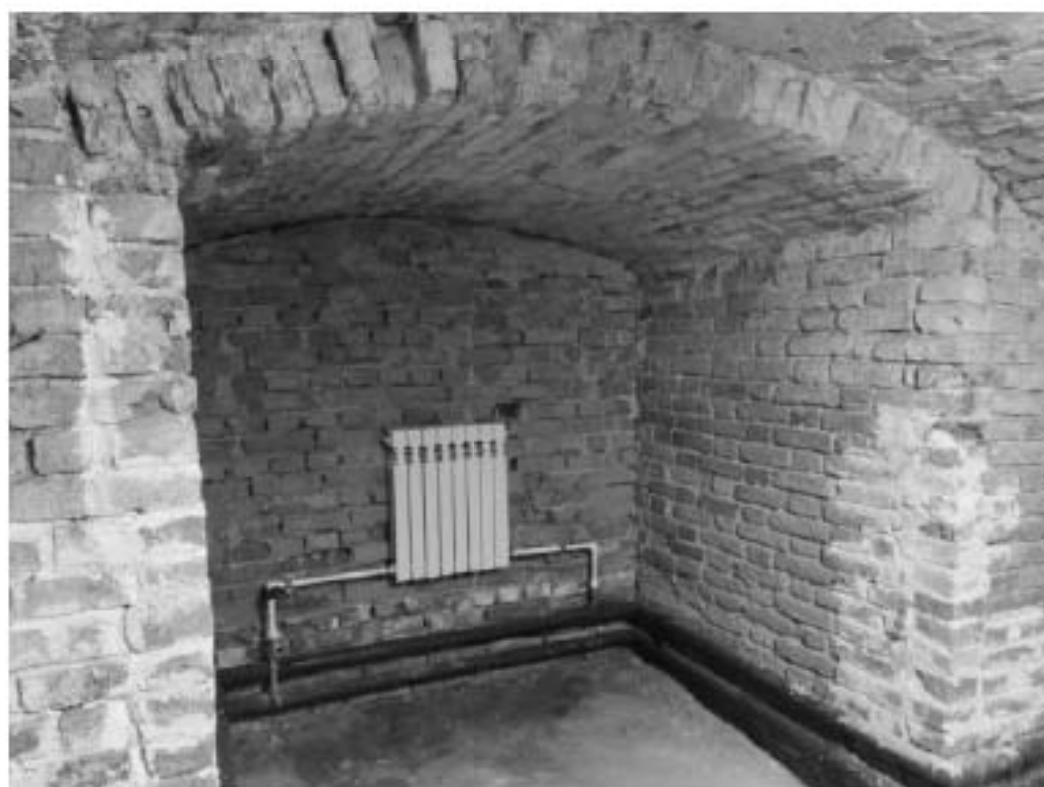
94. Центральный корпус. Подвал
