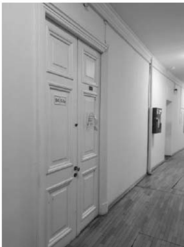
177 Северо-восточный полуциркульный корпус. Первый этаж.
