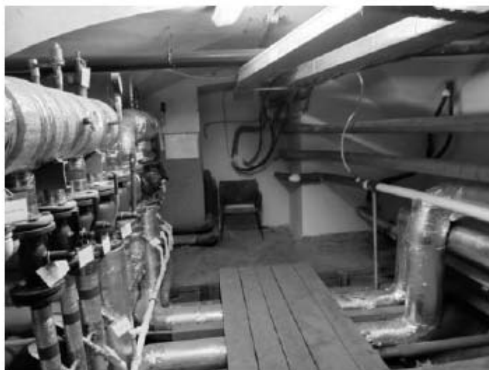
120. Северный прямоугольный корпус. Подвал
