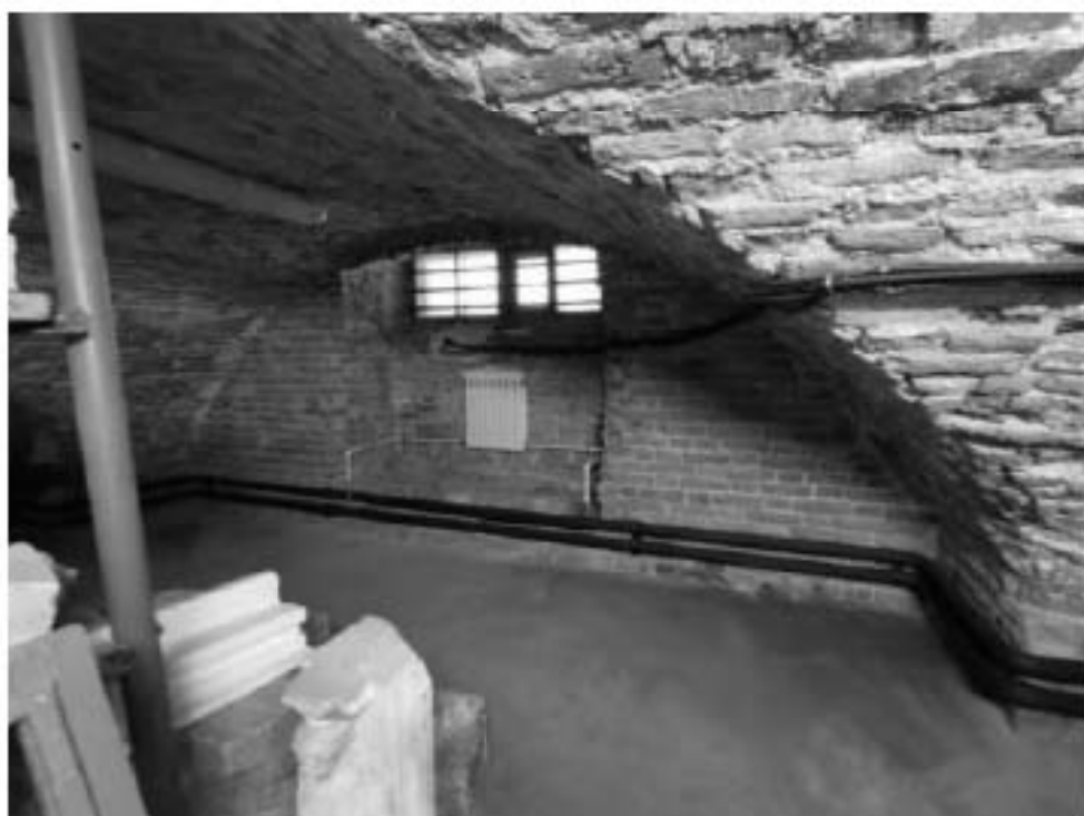
106. Центральный корпус. Подвал
