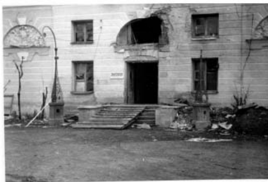
17. Поврежденный фасад Северного корпуса 1944г. https://pastvu.com/
