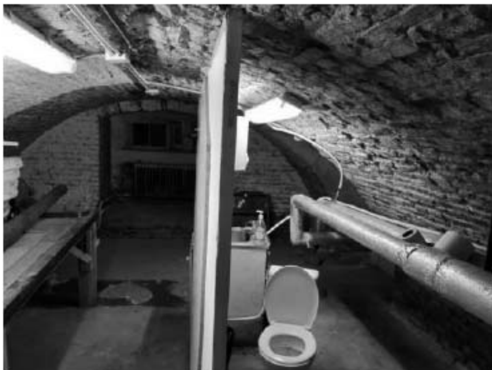
97. Центральный корпус. Подвал
