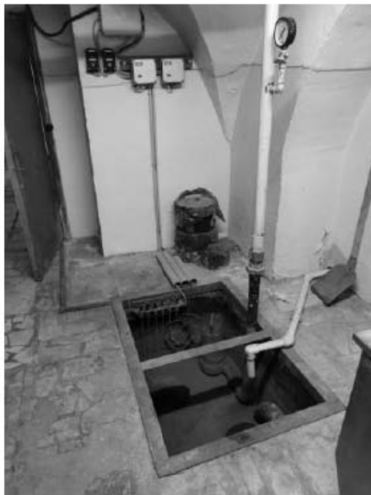
119. Северный прямоугольный корпус. Подвал
