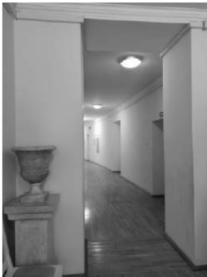
173 Северо-восточный полуциркульный корпус. Первый этаж.
