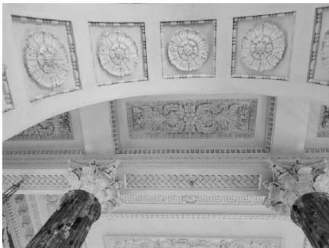
257. Центральный корпус. Второй этаж.
