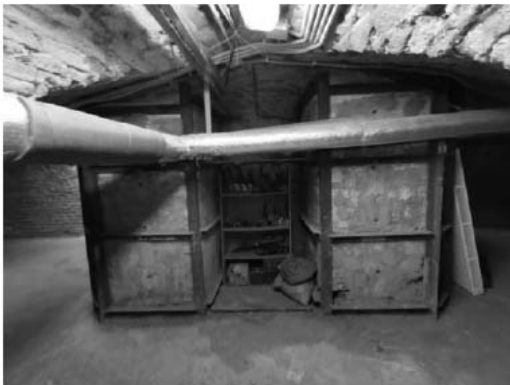
103. Центральный корпус. Подвал
