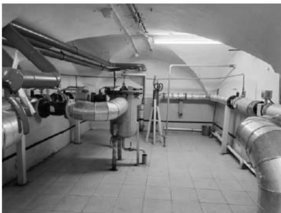
118. Северный прямоугольный корпус. Подвал
