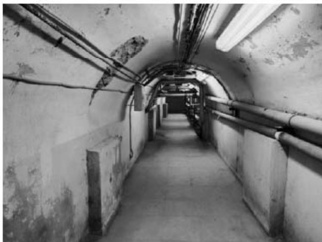
110. Северный прямоугольный корпус. Подвал
