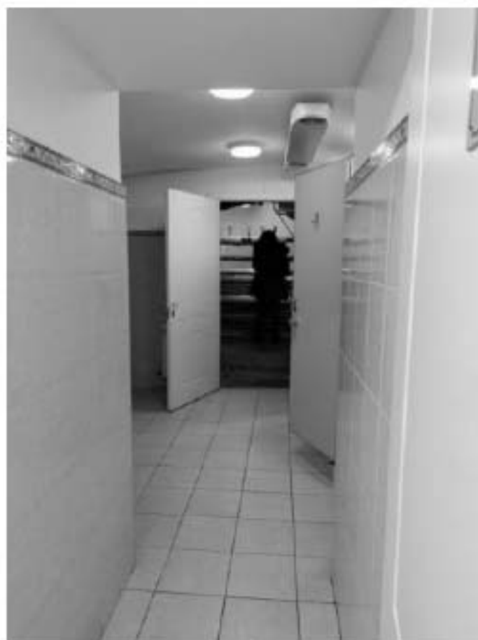
87. Центральный корпус. Подвал
