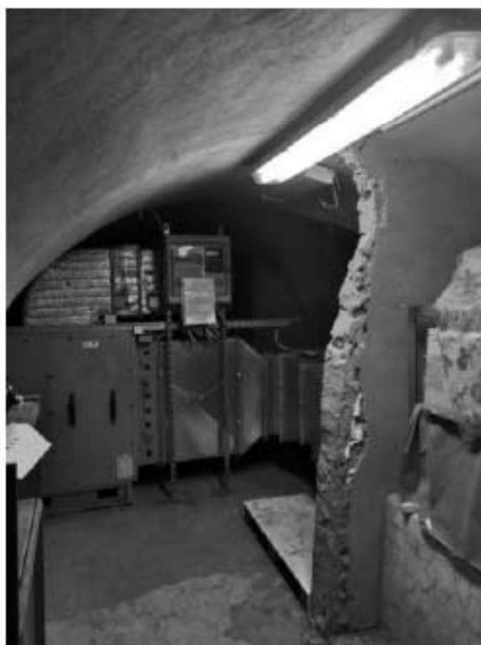
102. Центральный корпус. Подвал
