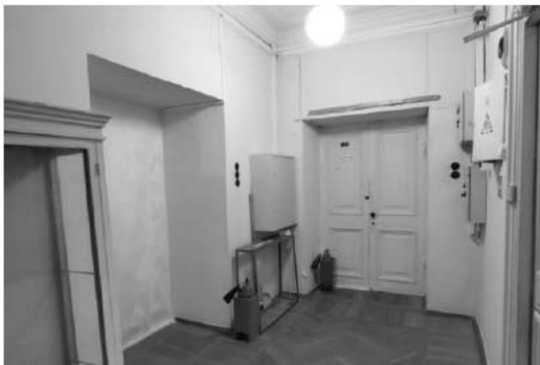
287. Северный прямоугольный корпус. Третий этаж
