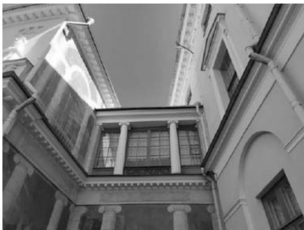
52. Северо-западный полуциркульный корпус. Фасад со стороны парка.
