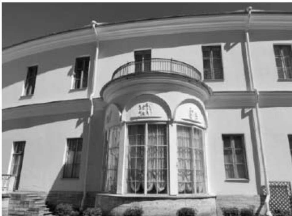
67. Юго-западный полуциркульный корпус. Фасад со стороны Собственного сада.
