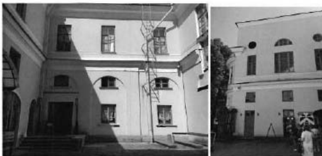
16, 17. Общий вид фасадов со стороны внутреннего двора.
