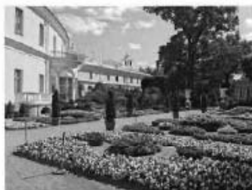
12. Западный фасад южной галереи.
