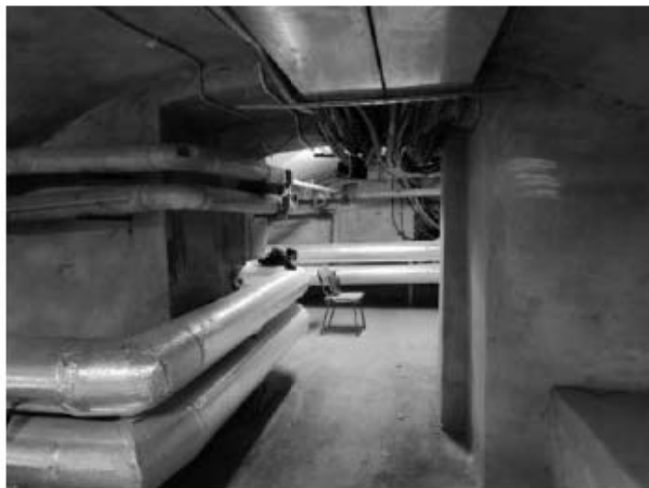
101. Центральный корпус. Подвал
