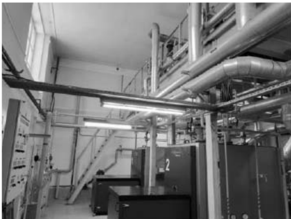
115. Северный прямоугольный корпус. Подвал
