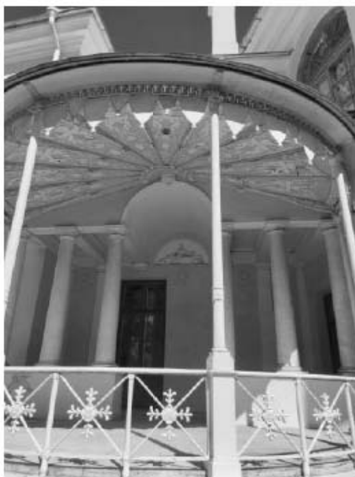
68. Юго-западный полуциркульный корпус. Фасад со стороны Собственного сада.
