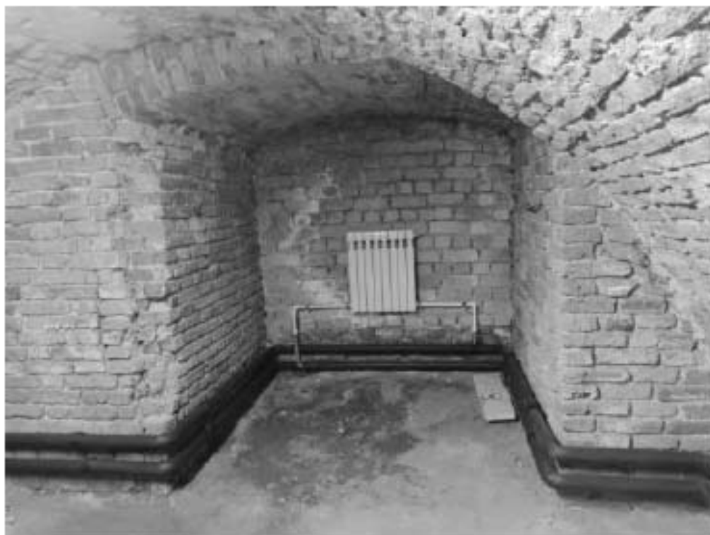
93 Центральный корпус. Подвал
