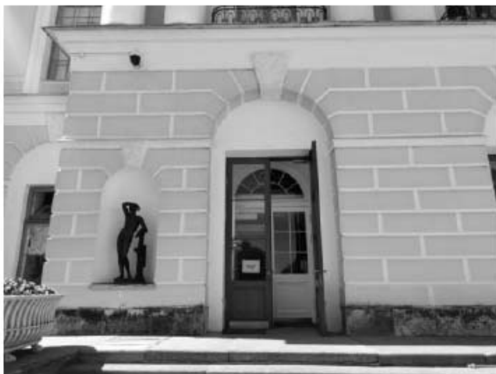
31. Центральный корпус. Главный фасад.
