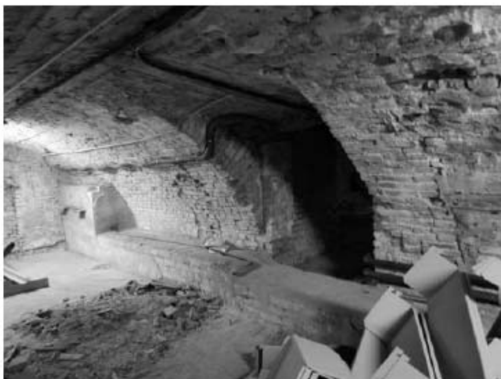
92. Центральный корпус. Подвал
