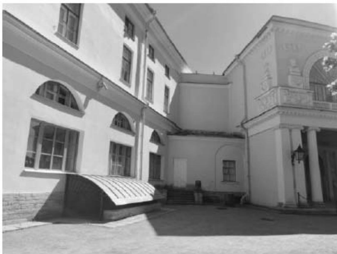
48. Северный прямоугольный корпус и северо-западный полукруглый. Фасад со стороны парка.
