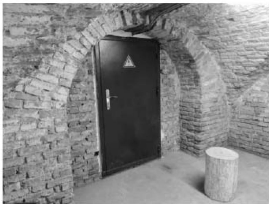
109. Северный прямоугольный корпус. Подвал
