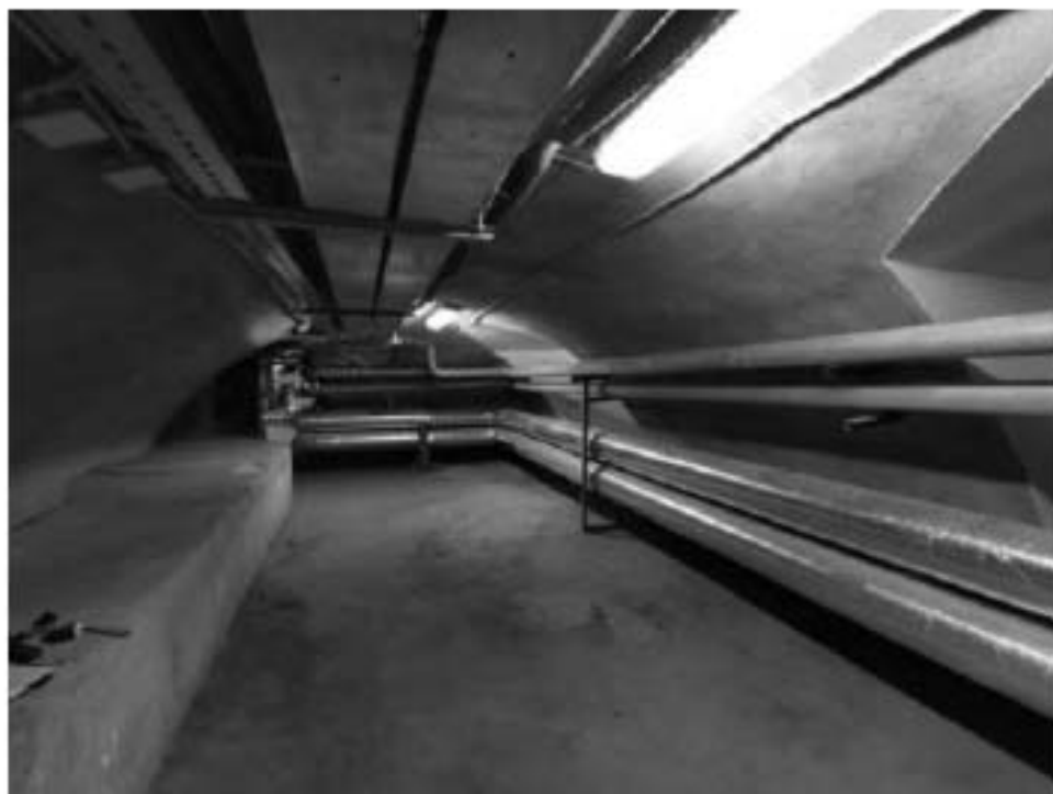
99. Центральный корпус. Подвал
