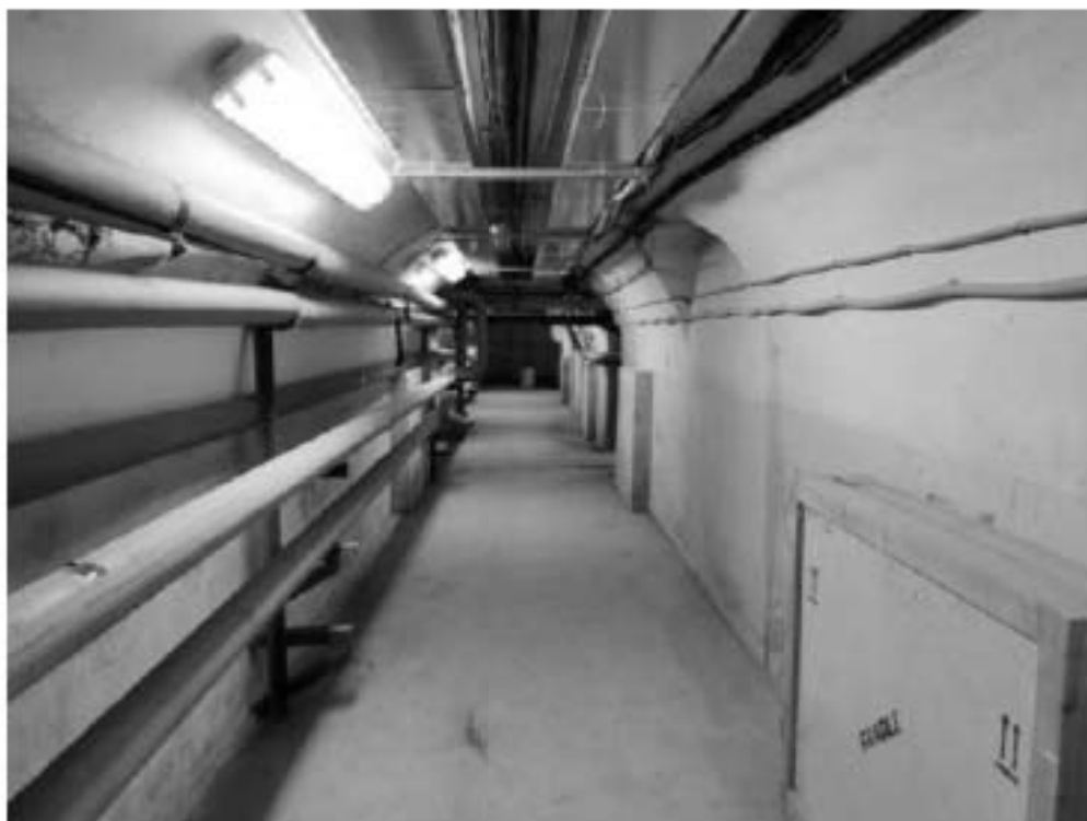
111. Северный прямоугольный корпус. Подвал
