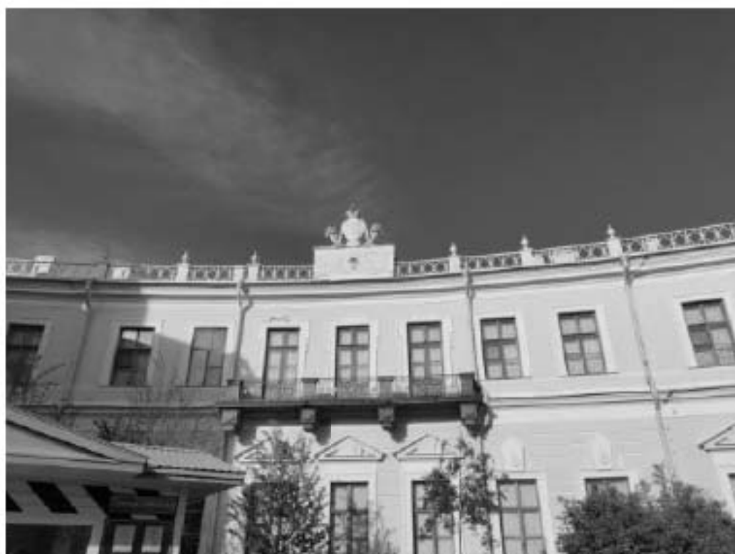
38. Северо-восточный полуциркульный корпус. Фасад со стороны плаца.
