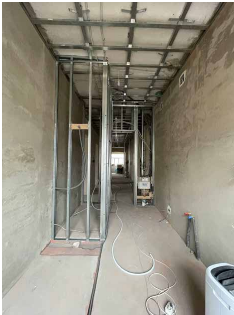
Фото 25. Интерьер 3-го этажа выявленного объекта культурного наследия «Богдельня для мужчин», входящего в состав выявленного объекта культурного наследия «Дома Общества вспомоществования приходским бедным при Благовещенской церкви»
