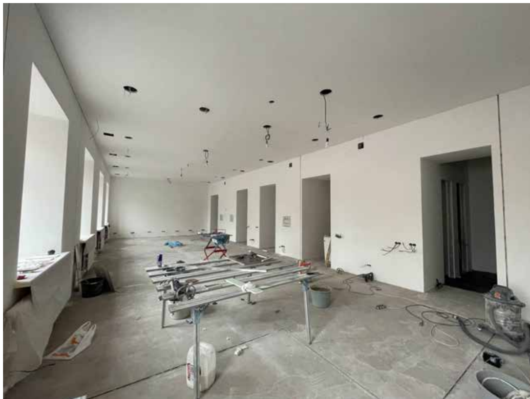
Фото 8. Интерьер 1-го этажа выявленного объекта культурного наследия «Богадельня для мужчин», входящего в состав выявленного объекта культурного наследия «Дома Общества вспомоществования приходским бедным при Благовещенской церкви»
