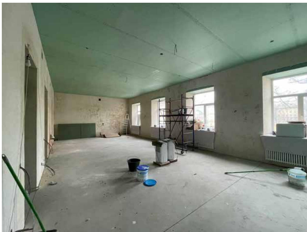
Фото 14. Интерьер 2-го этажа выявленного объекта культурного наследия «Богадельня для мужчин», входящего в состав выявленного объекта культурного наследия «Дома Общества вспомоществования приходским бедным при Благовещенской церкви»
