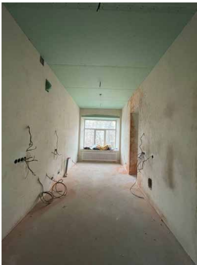
Фото 17. Интерьер 2-го этажа выявленного объекта культурного наследия «Богадельня для мужчин», входящего в состав выявленного объекта культурного наследия «Дома Общества вспомоществования приходским бедным при Благовещенской церкви»
