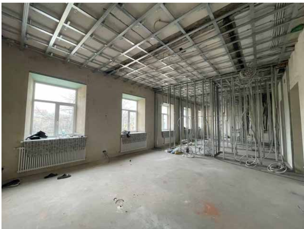
Фото 23. Интерьер 3-го этажа выявленного объекта культурного наследия «Богадельня для мужчин», входящего в состав выявленного объекта культурного наследия «Дома Общества вспомоществования приходским бедным при Благовещенской церкви»
