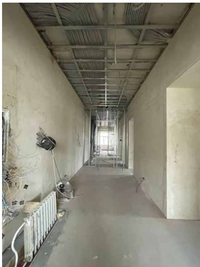
Фото 21. Интерьер 3-го этажа выявленного объекта культурного наследия «Богадельня для мужчин», входящего в состав выявленного объекта культурного наследия «Дома Общества вспомоществования приходским бедным при Благовещенской церкви»
