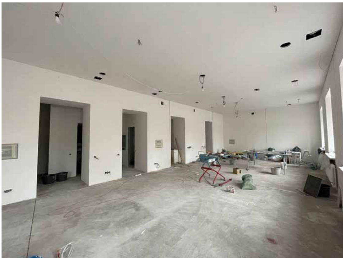
Фото 7. Интерьер 1-го этажа выявленного объекта культурного наследия «Богадельня для мужчин», входящего в состав выявленного объекта культурного наследия «Дома Общества вспомоществования приходским бедным при Благовещенской церкви»
