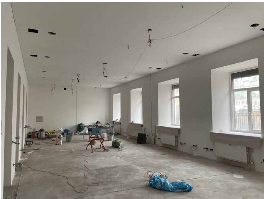
Фото 6. Интерьер 1-го этажа выявленного объекта культурного наследия «Богадельня для мужчин», входящего в состав выявленного объекта культурного наследия «Дома Общества вспомоществования приходским бедным при Благовещенской церкви»
