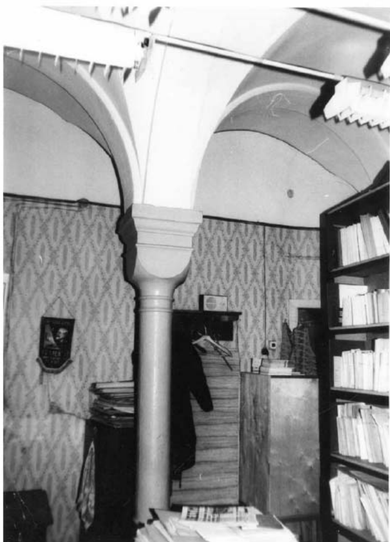
Ил. 45. Литейный пр., д. 62. Рабочий кабинет на втором этаже. 1997 г. Архив КГИОП
