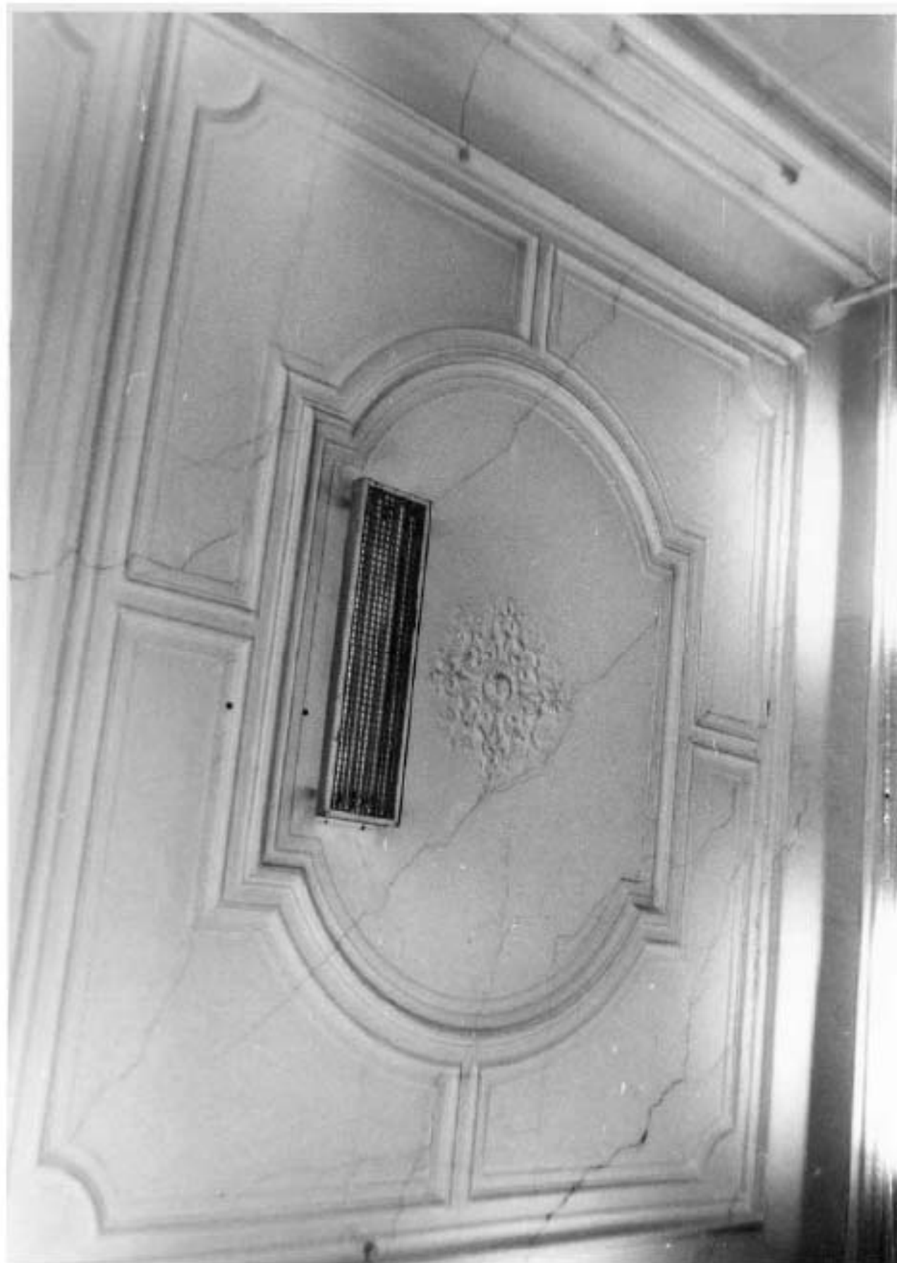
Ил. 46. Литейный пр., д. 62. Потолок в кабинете на втором этаже. 1997 г. Архив КГИОП
