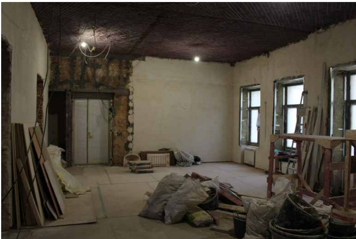
Фото 9. Выявленный объект культурного наследия «Дом, в котором в 1892-1913 годах жил ученый-баллист Н.А. Забудский». Квартира № 8. Помещения №№ 1, 7, 8, 9.
