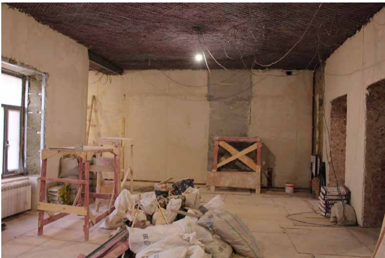
Фото 8. Выявленный объект культурного наследия «Дом, в котором в 1892-1913 годах жил ученый-баллист Н.А. Забудский». Квартира № 8. Помещения №№ 1, 7, 8, 9.
