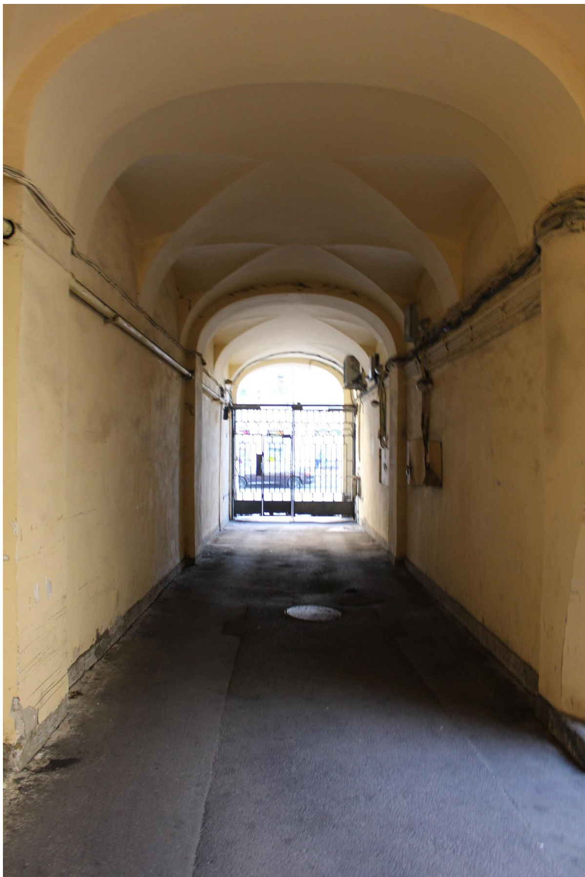
Фото 4. Вид на арку воротного проезда выявленного объекта культурного наследия регионального значения «Дом, в котором в 1892-1913 годах жил ученый-баллист Н.А. Забудский» с запада.
