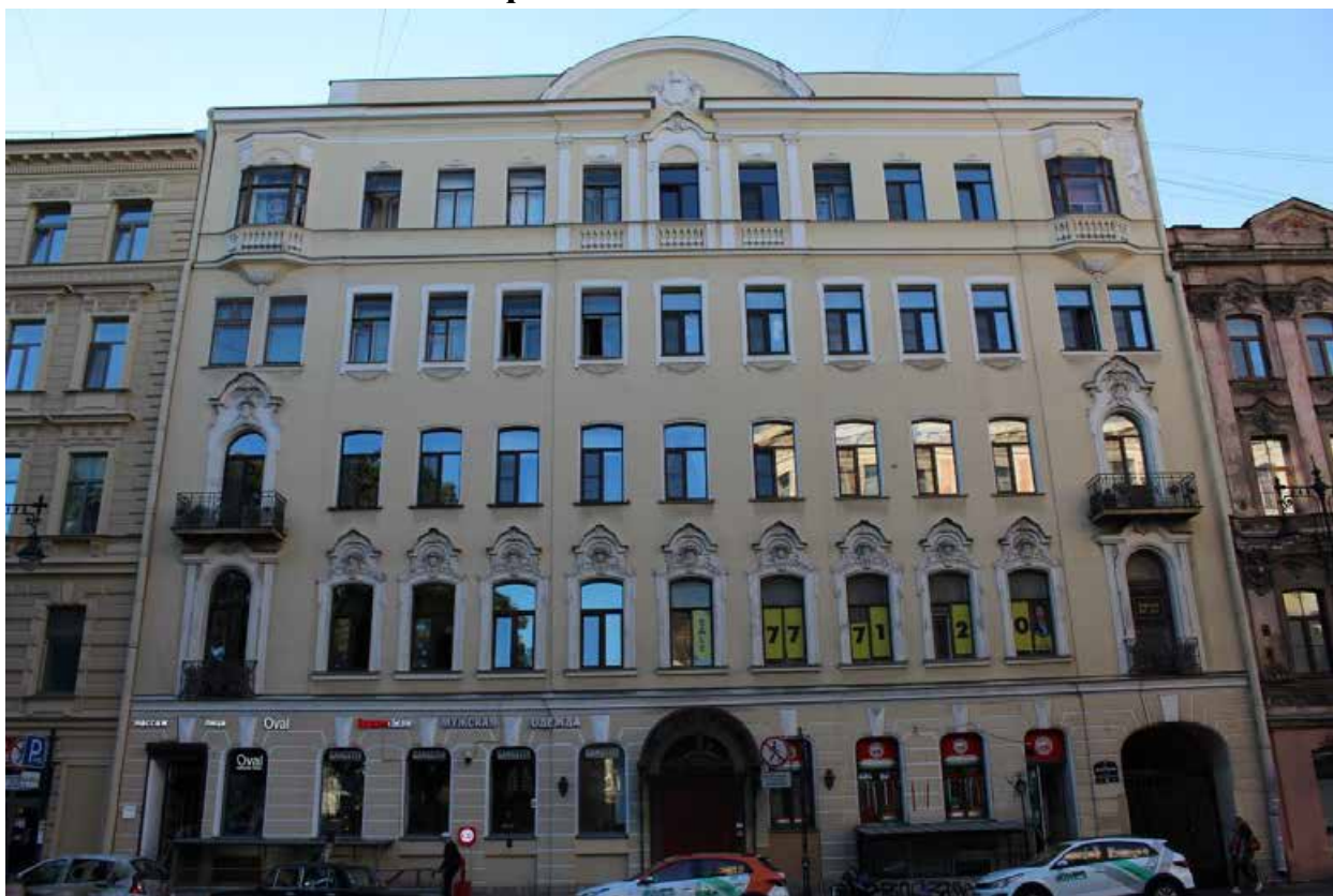
Фото 1. Вид на лицевой выявленного объекта культурного наследия регионального значения «Дом, в котором в 1892-1913 годах жил ученый-баллист Н.А. Забудский».
