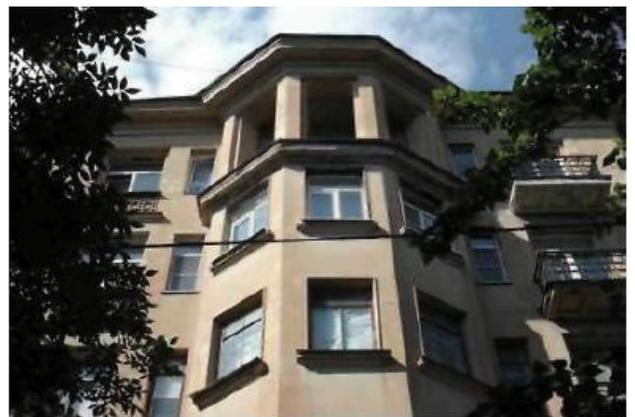
балконы — тип (прямоугольные), местоположение (со второго по шестой этажи дворовых фасадов), ограждения — материал (металл), техника исполнения (сварка), рисунок (простой геометрический с кольцами);
