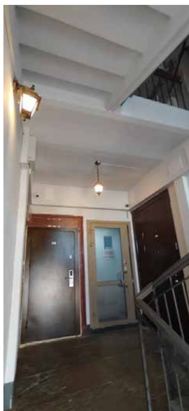
Фото 16. Интерьер квартиры № 57 объекта культурного наследия федерального значения «Корпус квартирный с флигелями, входящего в состав объекта культурного наследия федерального значения «Капелла Придворная певческая»
