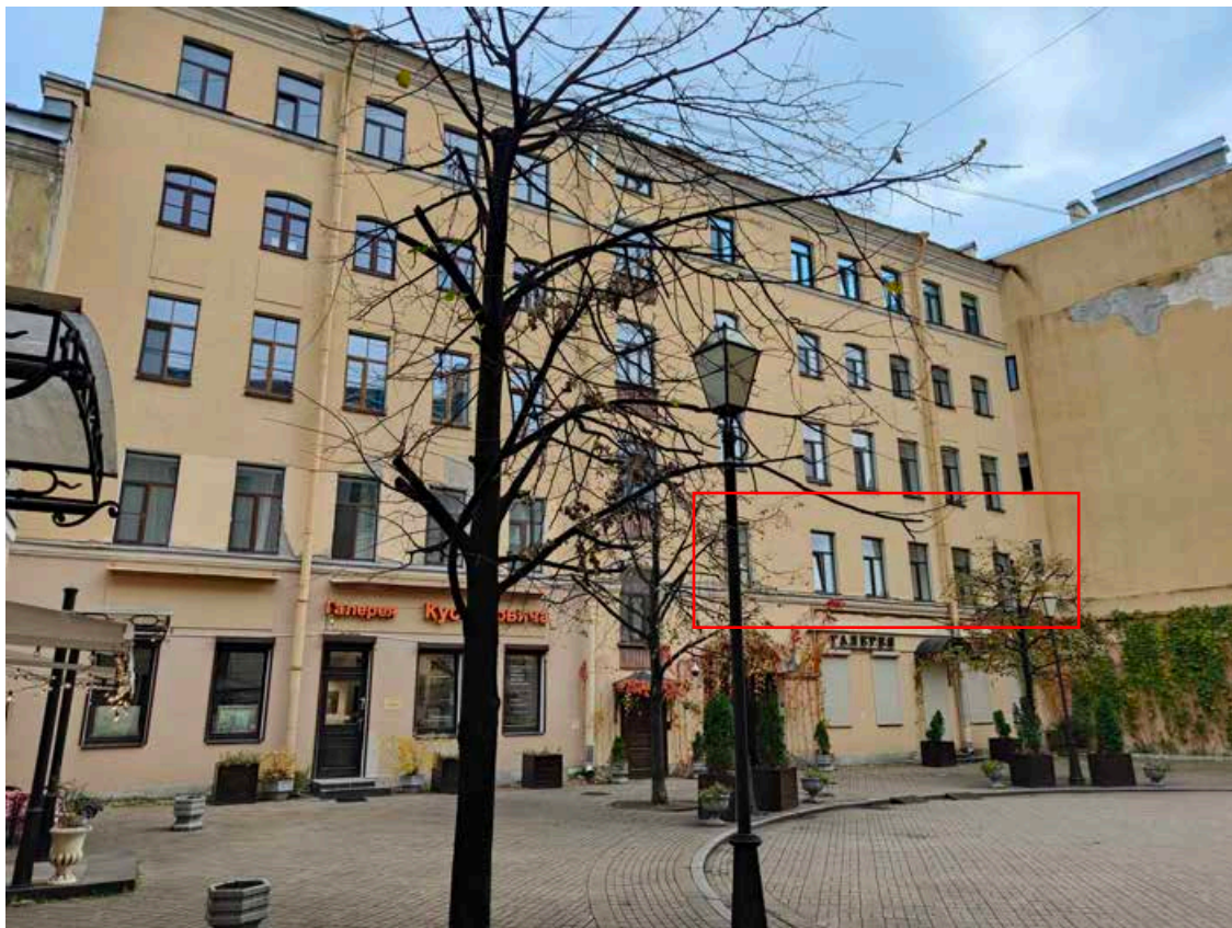
Фото 3. Фрагмент дворового фасада объекта культурного наследия федерального значения «Корпус квартирный с флигелями, входящего в состав объекта культурного наследия федерального значения «Капелла Придворная певческая»
