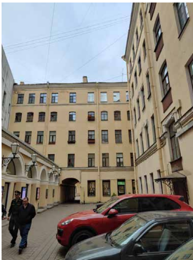
Фото 2. Фрагмент дворового фасада объекта культурного наследия федерального значения «Корпус квартирный с флигелями, входящего в состав объекта культурного наследия федерального значения «Капелла Придворная певческая»
