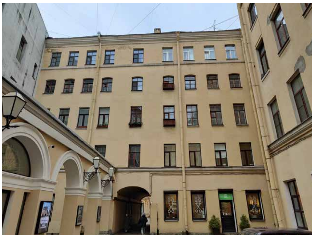
Фото 2. Фрагмент дворового фасада объекта культурного наследия федерального значения «Корпус квартирный с флигелями, входящего в состав объекта культурного наследия федерального значения «Капелла Придворная певческая»
