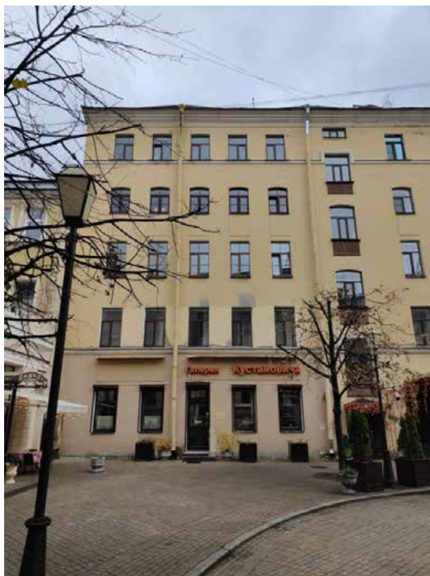
Фото 3. Фрагмент дворового фасада объекта культурного наследия федерального значения «Корпус квартирный с флигелями, входящего в состав объекта культурного наследия федерального значения «Капелла Придворная певческая»
