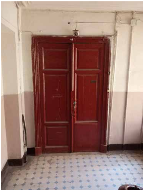
Фото 9. Интерьер квартиры № 49 объекта культурного наследия регионального значения «Дом В.Т. Тимофеева», вход с парадной лестницы
