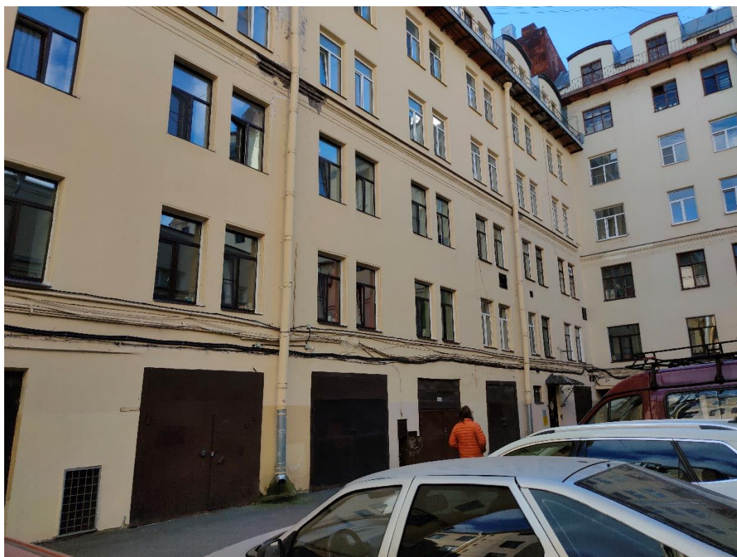
Фото 27. Фрагмент юго-западного дворового фасада
