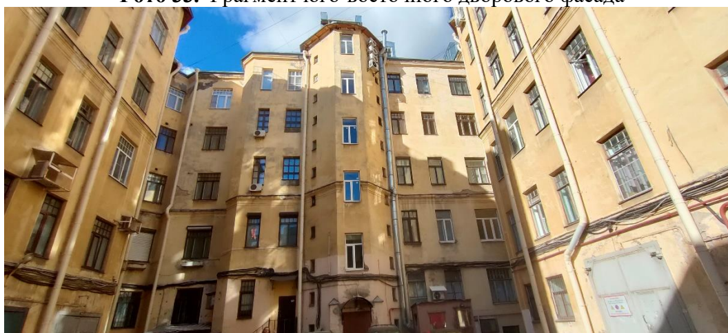
Фото 34. Фрагмент юго-восточного дворового фасада
