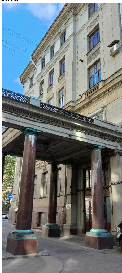
Фото 8. Фрагмент входной группы дворового фасада
