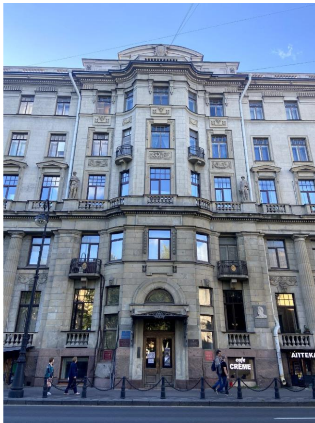
Фото 2. Фрагмент фасада со стороны Каменноостровского проспекта
