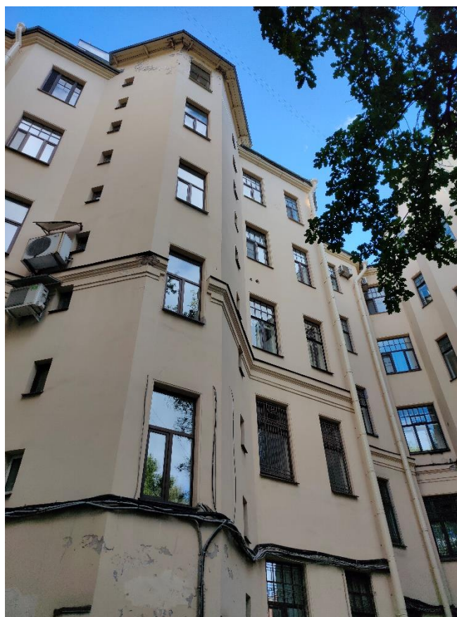
Фото 20. Фрагмент северо-западного фасада
