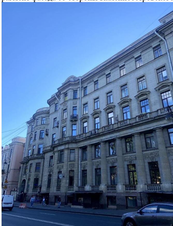
Фото 3. Фрагмент лицевого фасада со стороны Каменноостровского проспекта
