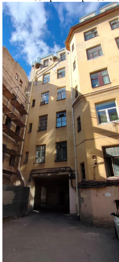
Фото 41. Фрагмент юго-восточного дворового фасада
