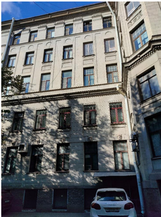
Фото 9. Фрагмент дворового фасада
