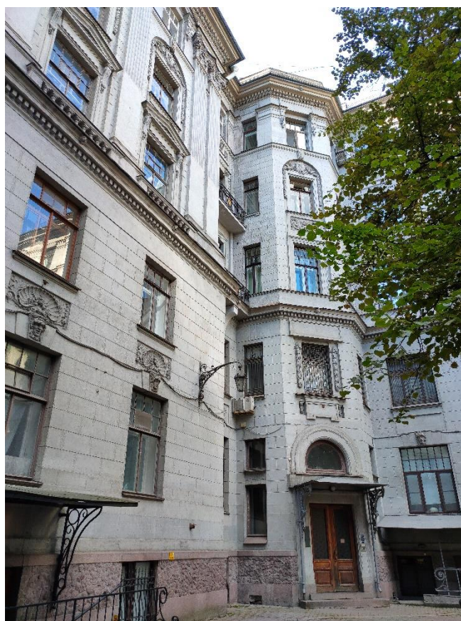
Фото 12. Фрагмент дворового фасада
