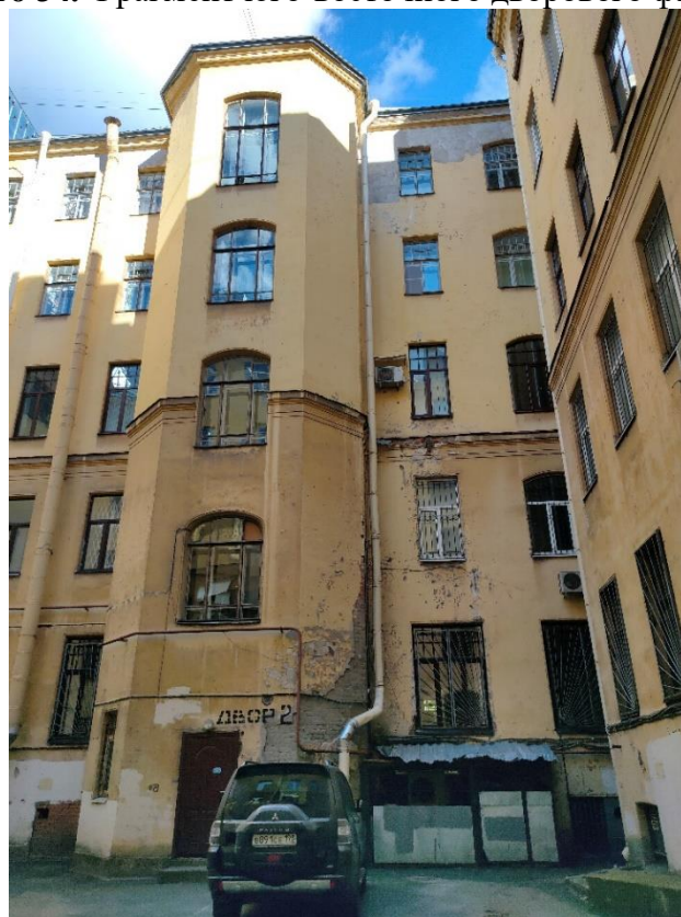
Фото 35. Фрагмент юго-восточного дворового фасада
