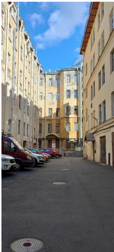
Фото 28. Фрагмент юго-западного дворового фасада
