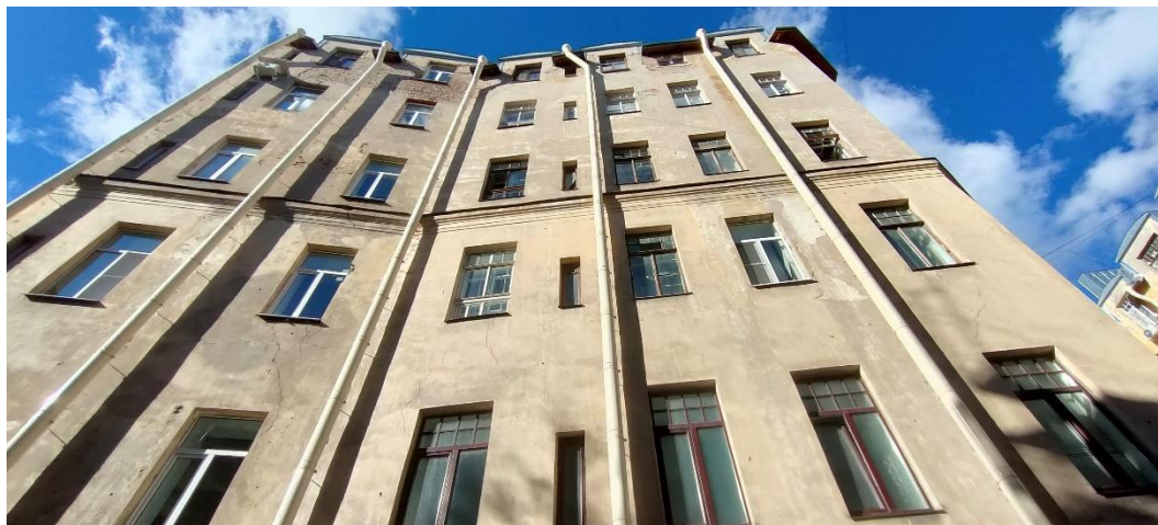
Фото 33. Фрагмент юго-восточного дворового фасада
