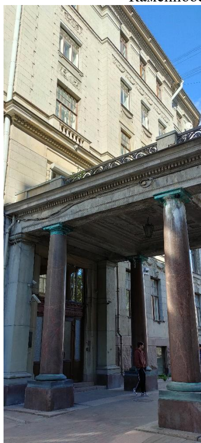
Фото 7. Фрагмент входной группы дворового фасада
