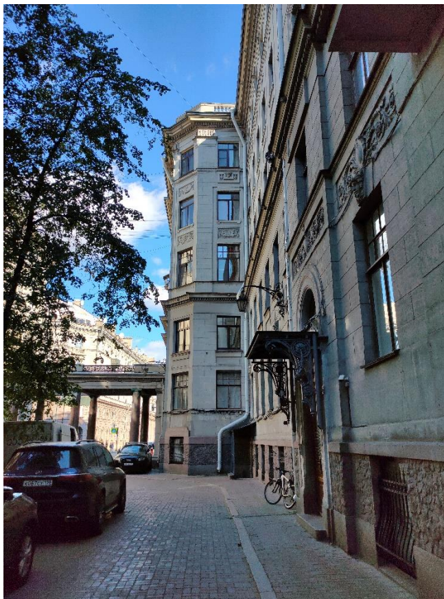
Фото 13. Фрагмент дворового фасада
