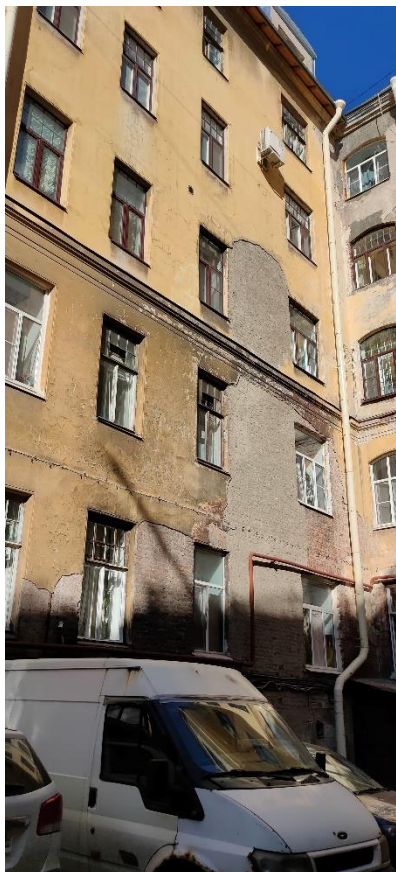
Фото 38. Фрагмент юго-восточного дворового фасада
