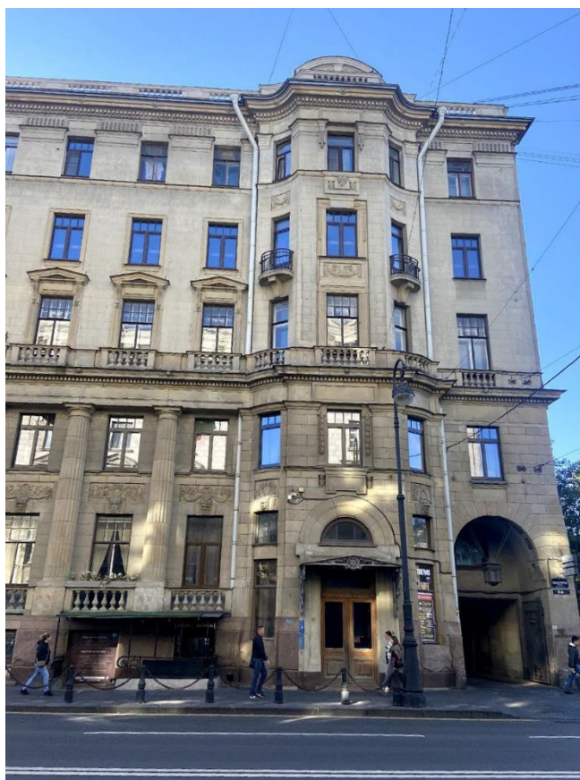
Фото 5. Фрагмент лицевого фасада со стороны Каменноостровского проспекта
