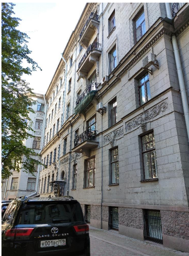
Фото 10. Фрагмент дворового фасада
