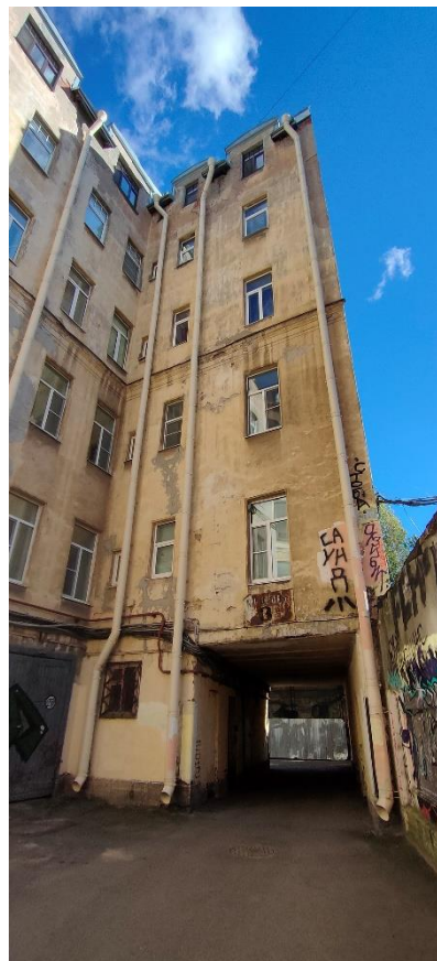
Фото 29. Фрагмент юго-западного дворового фасада
