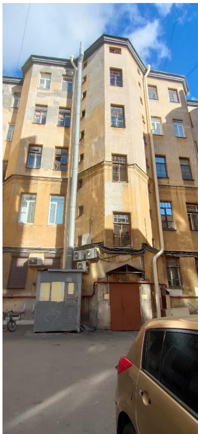
Фото 25. Фрагмент юго-западного дворового фасада
