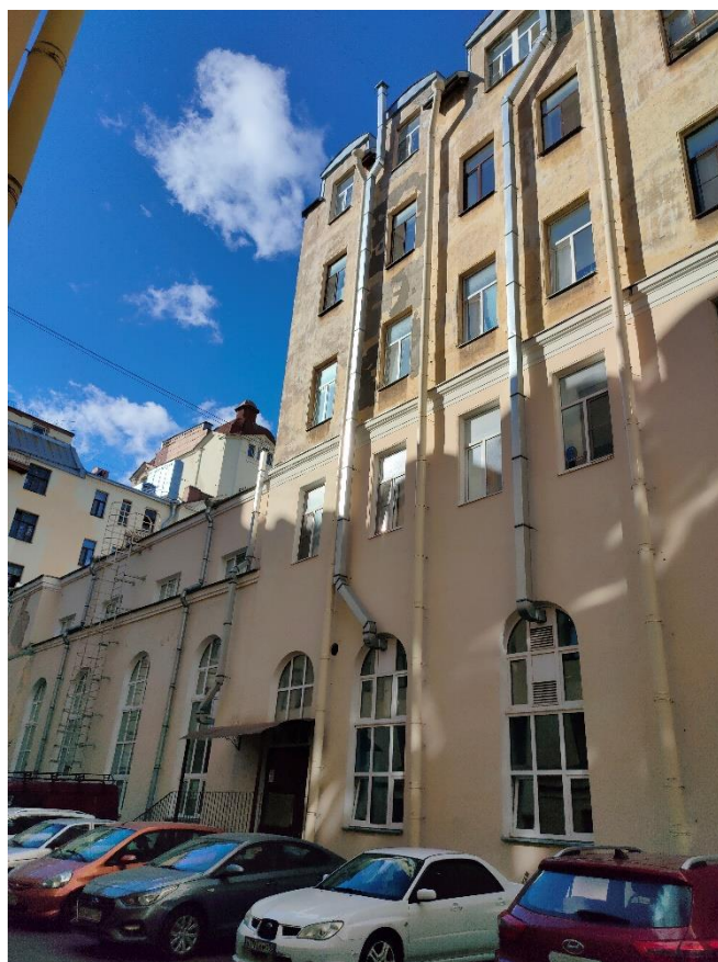
Фото 24. Фрагмент юго-западного дворового фасада
