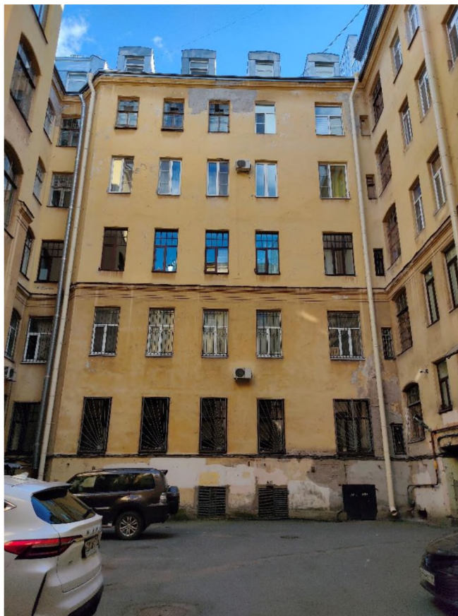
Фото 42. Фрагмент юго-восточного дворового фасада
