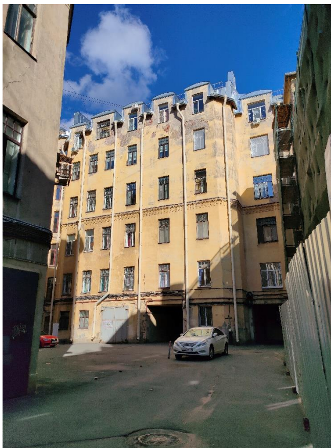
Фото 32. Фрагмент юго-восточного дворового фасада
