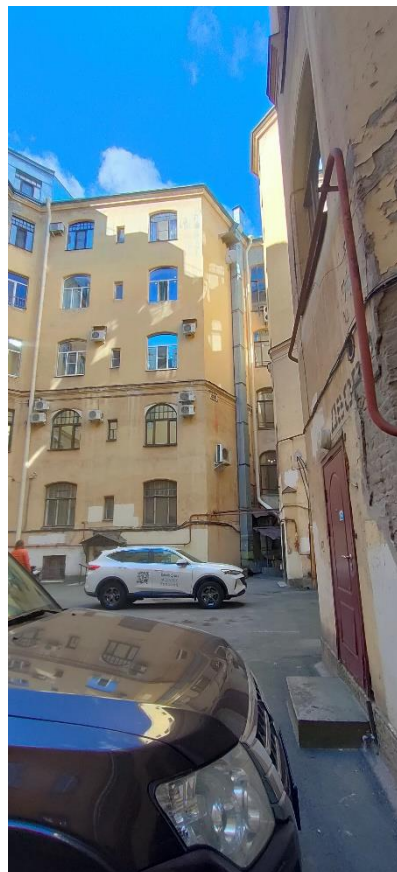
Фото 39. Фрагмент юго-восточного дворового фасада
