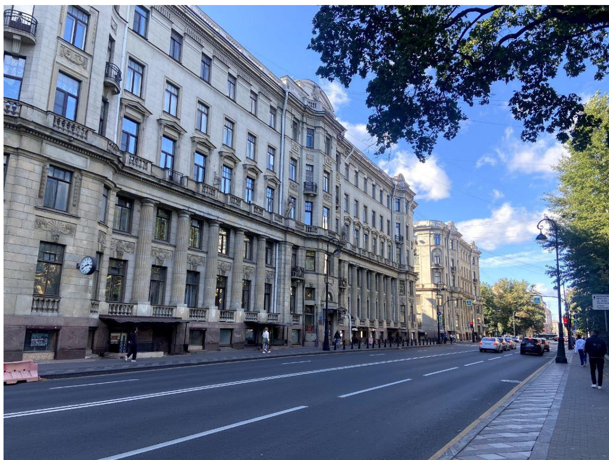
Фото 1. Фасад со стороны Каменноостровского проспекта
