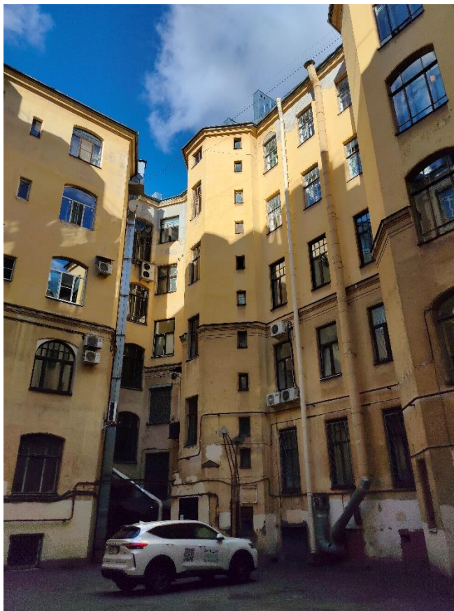
Фото 36. Фрагмент юго-восточного дворового фасада
