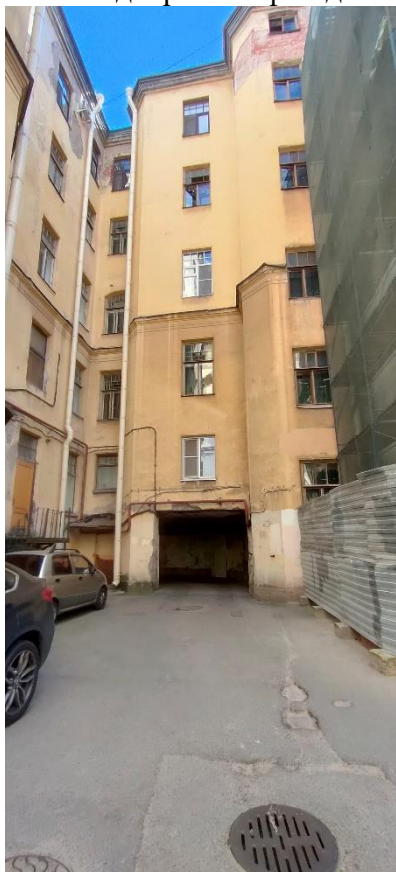
Фото 40. Фрагмент юго-восточного дворового фасада
