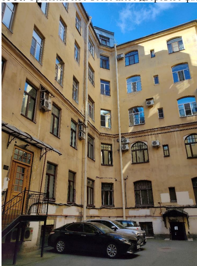
Фото 37. Фрагмент юго-восточного дворового фасада
