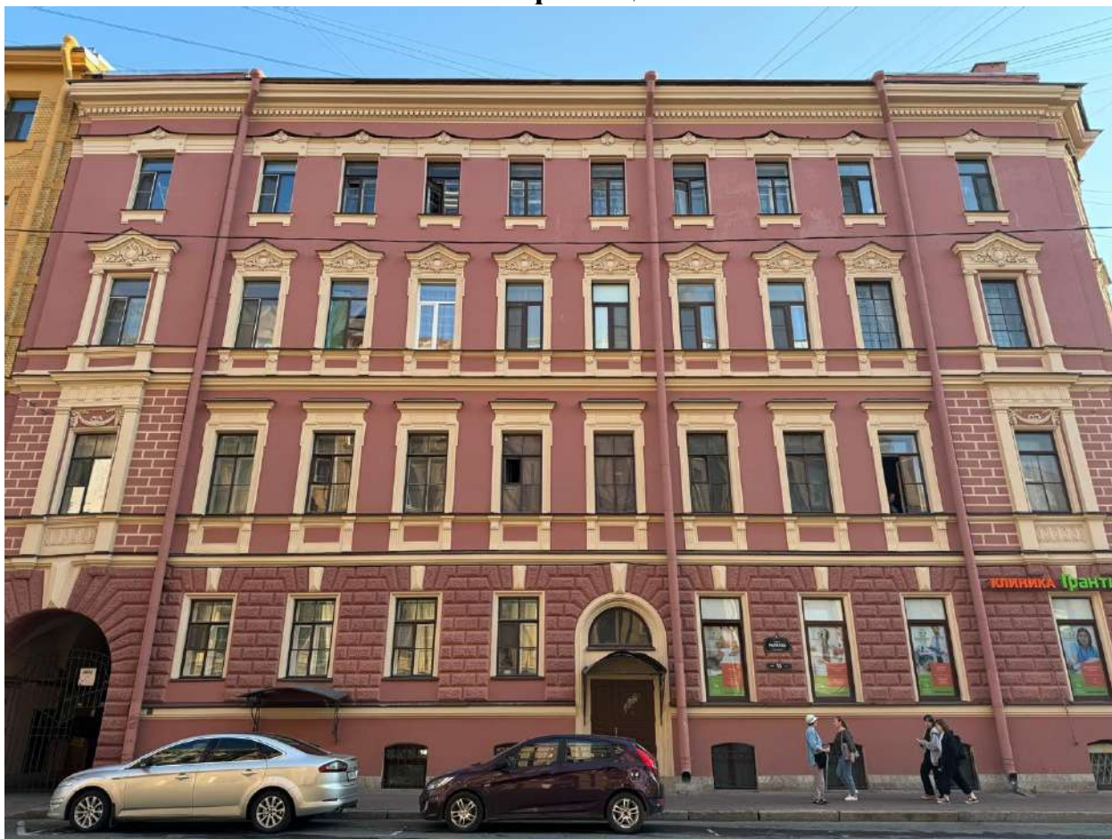
Фото 1. Общий вид фасада объекта культурного наследия по улице Рылеева.
