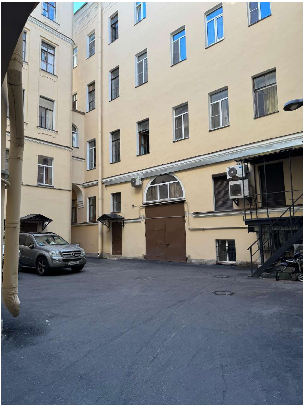
Фото 6. Дворовой фасад объекта культурного наследия.
