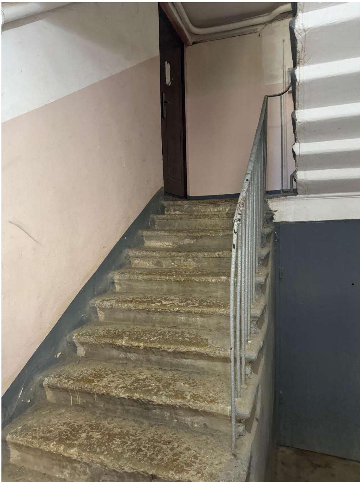
Фото 8. Общий вид лестницы, ведущей в квартиру № 14, объекта культурного наследия.
