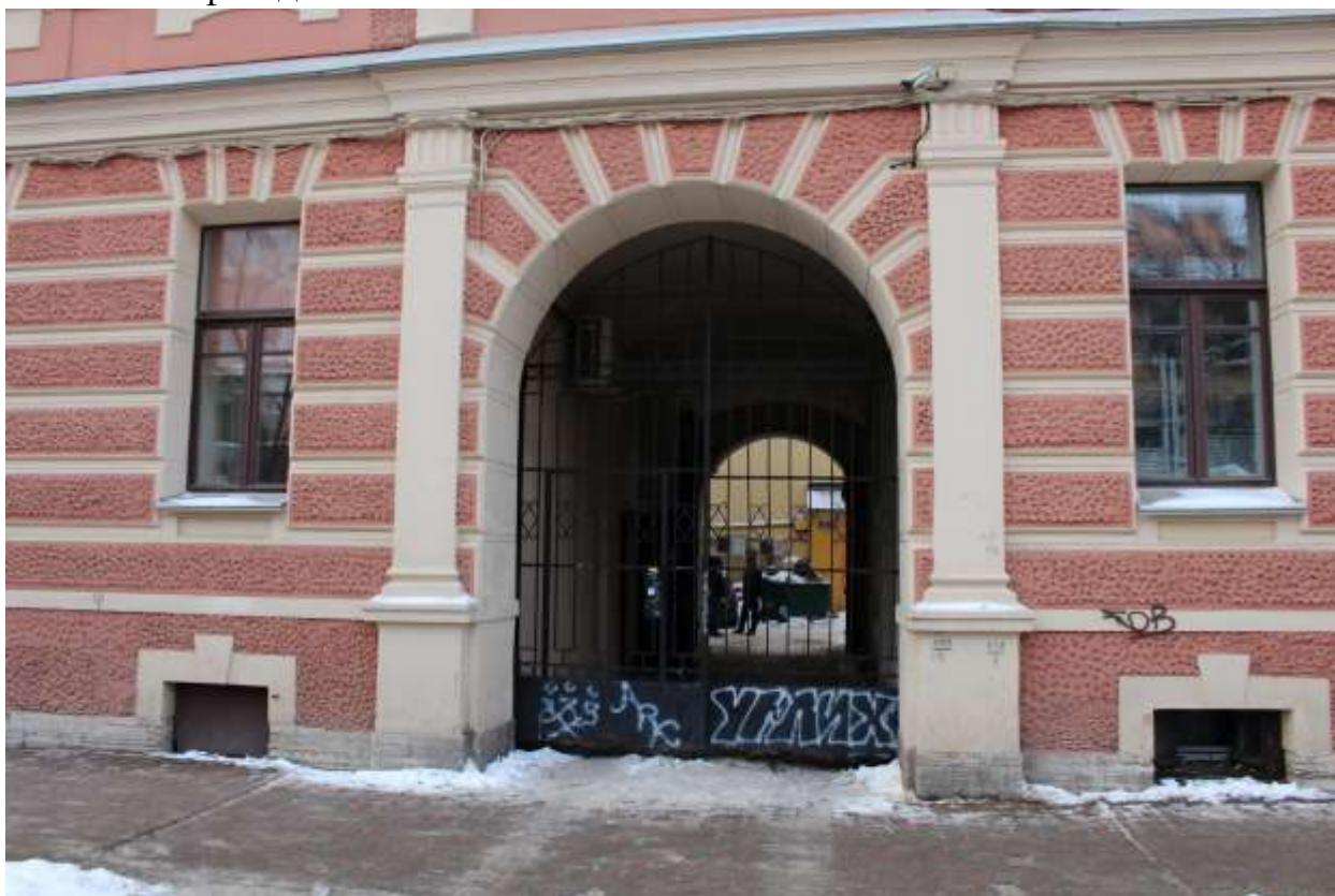
42. Выявленный объект культурного наследия «Городской дом 1-го Василеостровского начального народного училища». Вид на арку воротного проезда.
