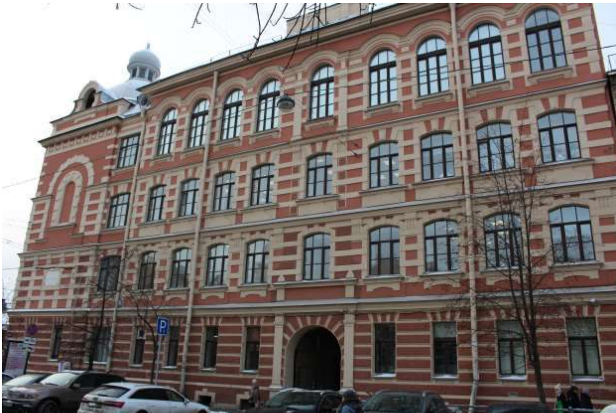
41. Выявленный объект культурного наследия «Городской дом 1-го Василеостровского начального народного училища». Вид на северо-восточный фасад.
