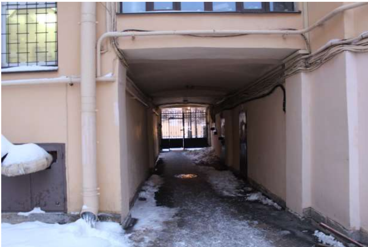
31. Выявленный объект культурного наследия «Дом В.А. Квасникова». Вид на арку воротного проезда.
