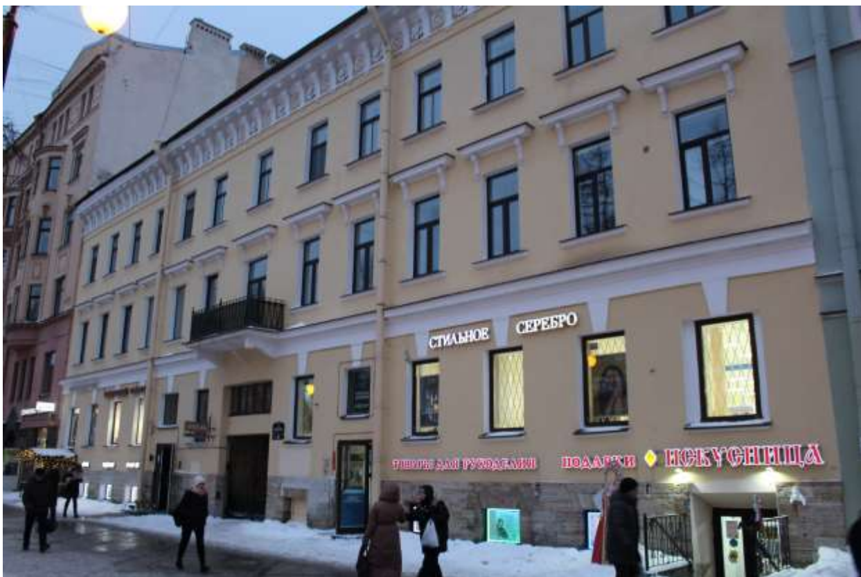
29. Выявленный объект культурного наследия «Дом В.А. Квасникова». Вид на северо-восточный фасад.
