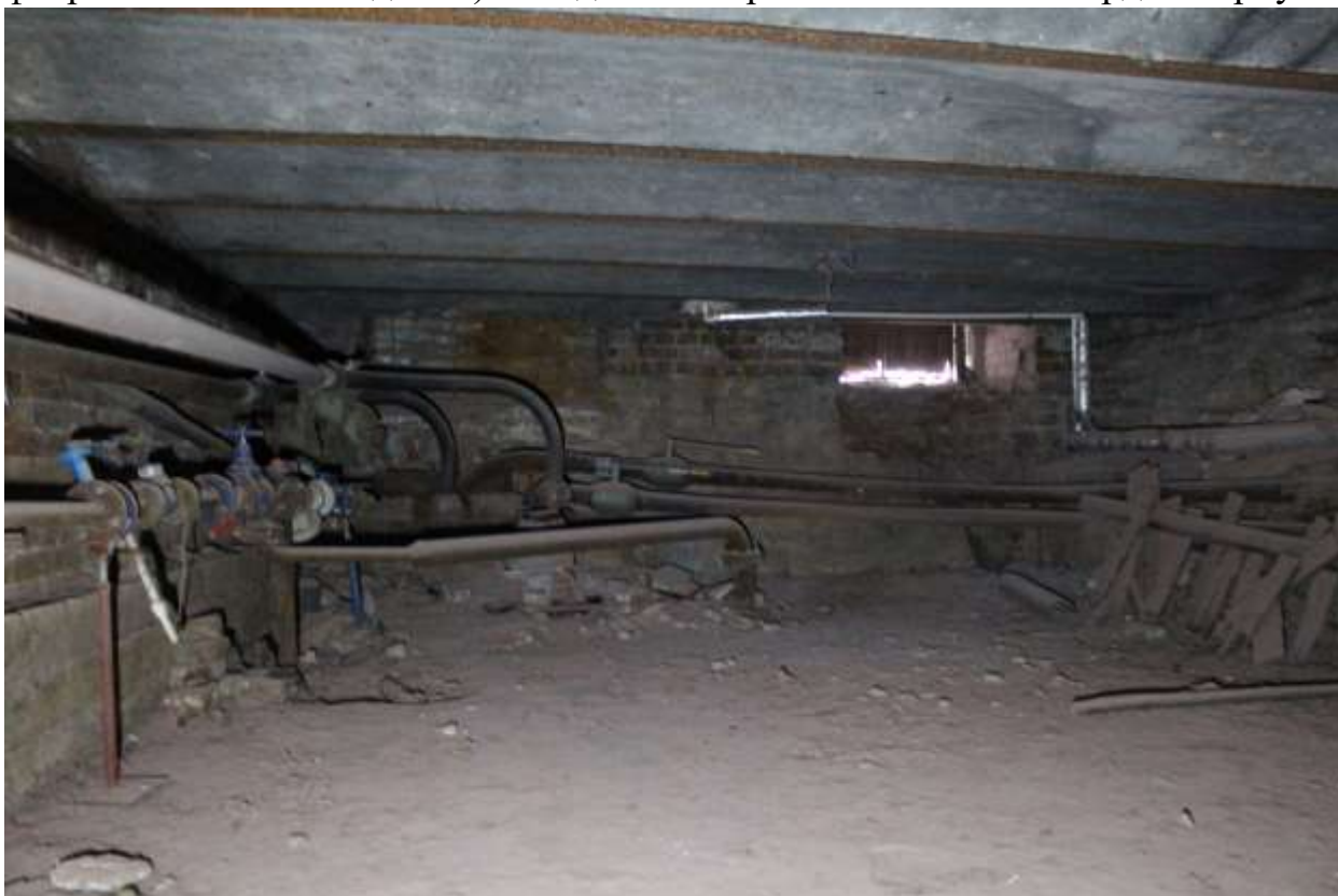
68. Выявленный объект культурного наследия «Дом Г.А. Хаймовича (при фабрике жестяных изделий)». Подвал четырехэтажного с мансардой корпуса.
