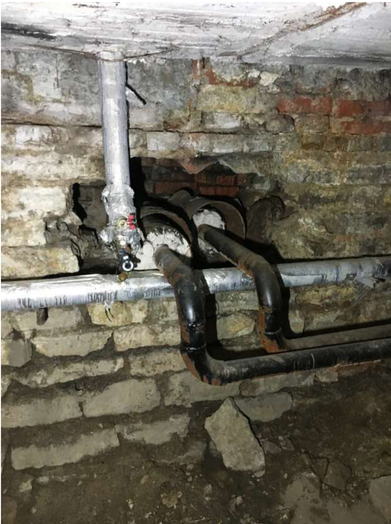
78. Выявленный объект культурного наследия «Богадельня для женщин». Вид на ввод теплосети в подвальном помещении.
