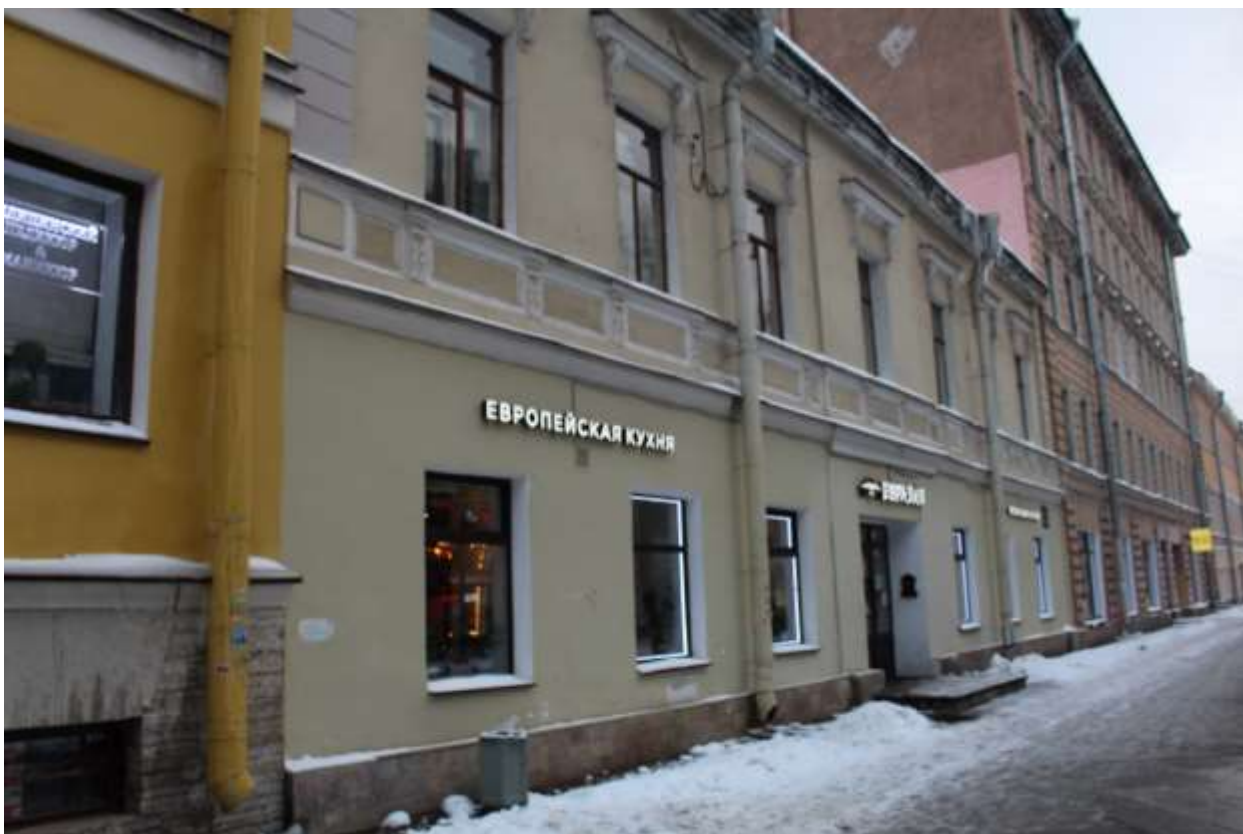
3. Выявленный объект культурного наследия «Дом В.И. Миллера». Вид на юго-западный фасад
