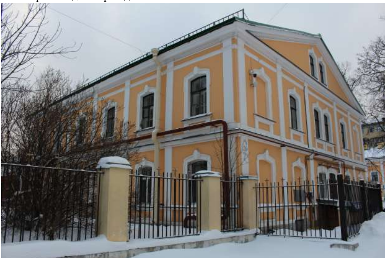
74. Выявленный объект культурного наследия «Богдельня для женщин». Вид на северо-западный и северо-восточный фасады.
