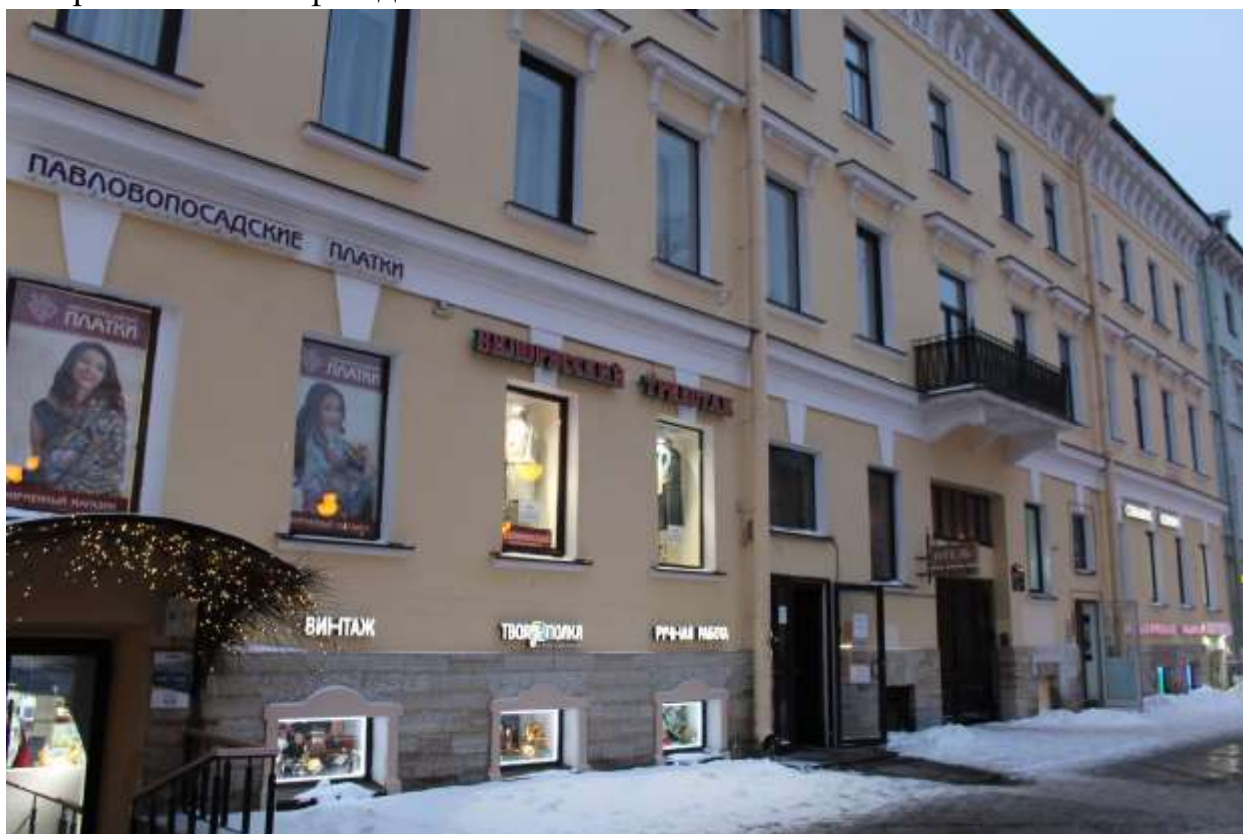
30. Выявленный объект культурного наследия «Дом В.А. Квасникова». Вид на северо-восточный фасад.
