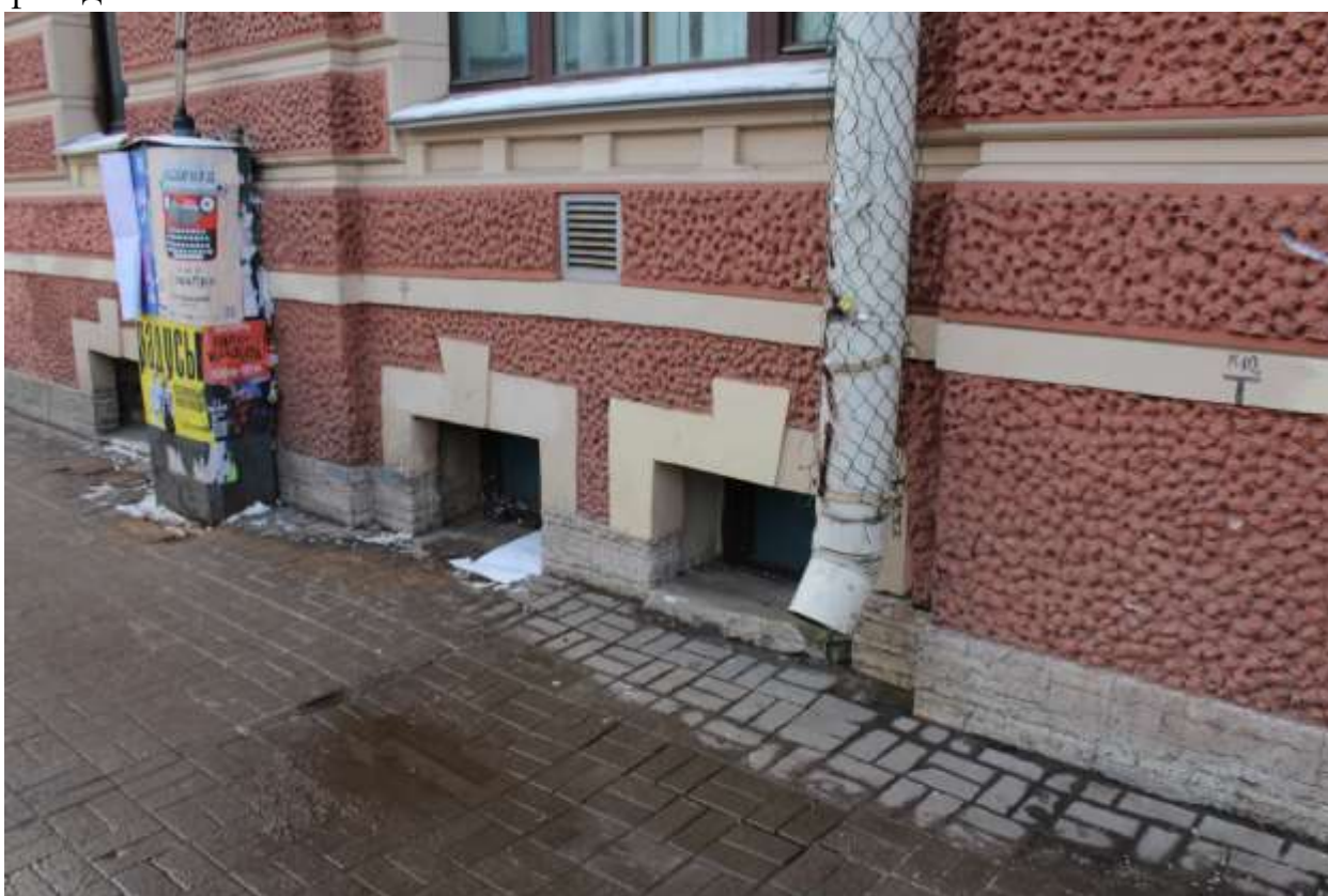
44. Выявленный объект культурного наследия «Городской дом 1-го Василеостровского начального народного училища». Вид на ввод теплосети со стороны 7-й линии В.О.
