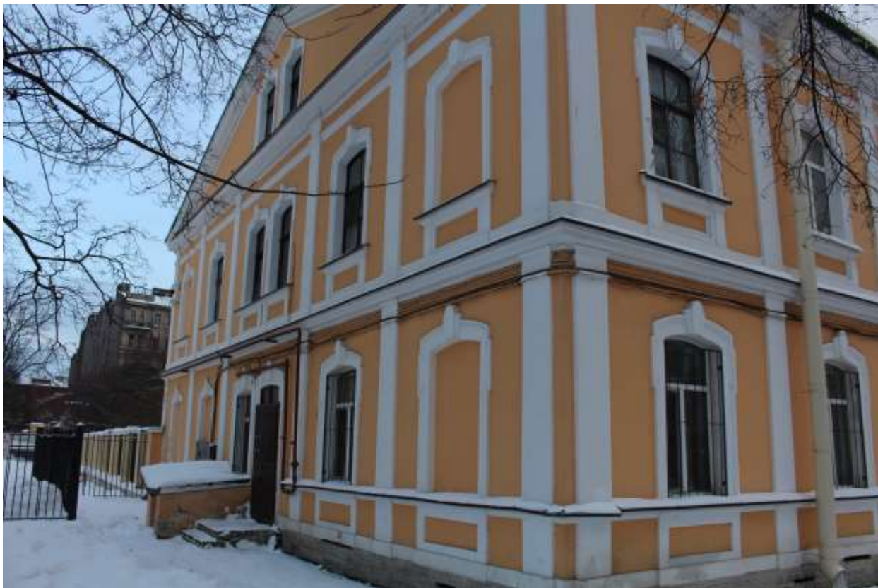
73. Выявленный объект культурного наследия «Богдельня для женщин». Вид на северо-западный фасад.
